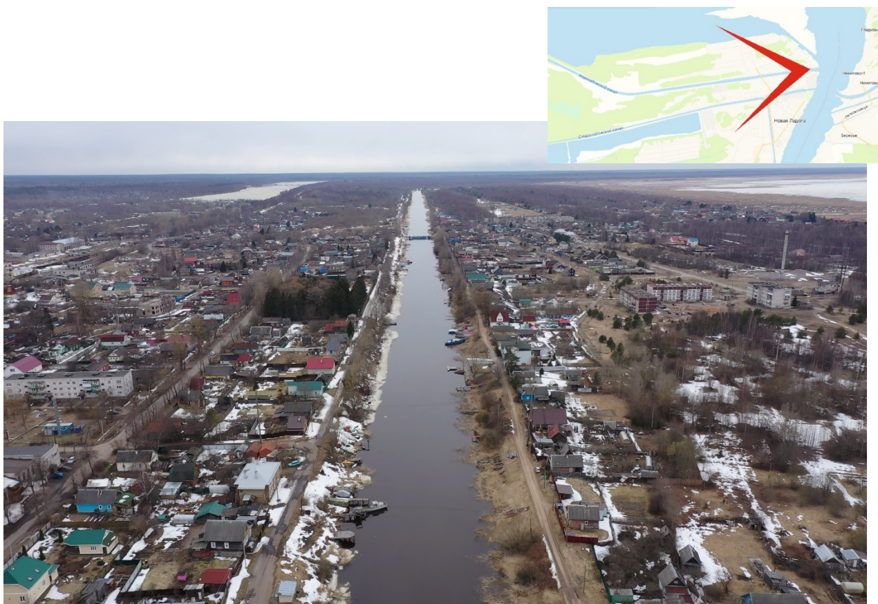
Фото 32. (аэрофотосъемка) Вид по оси Новоладожского канала со стороны р. Волохов.
