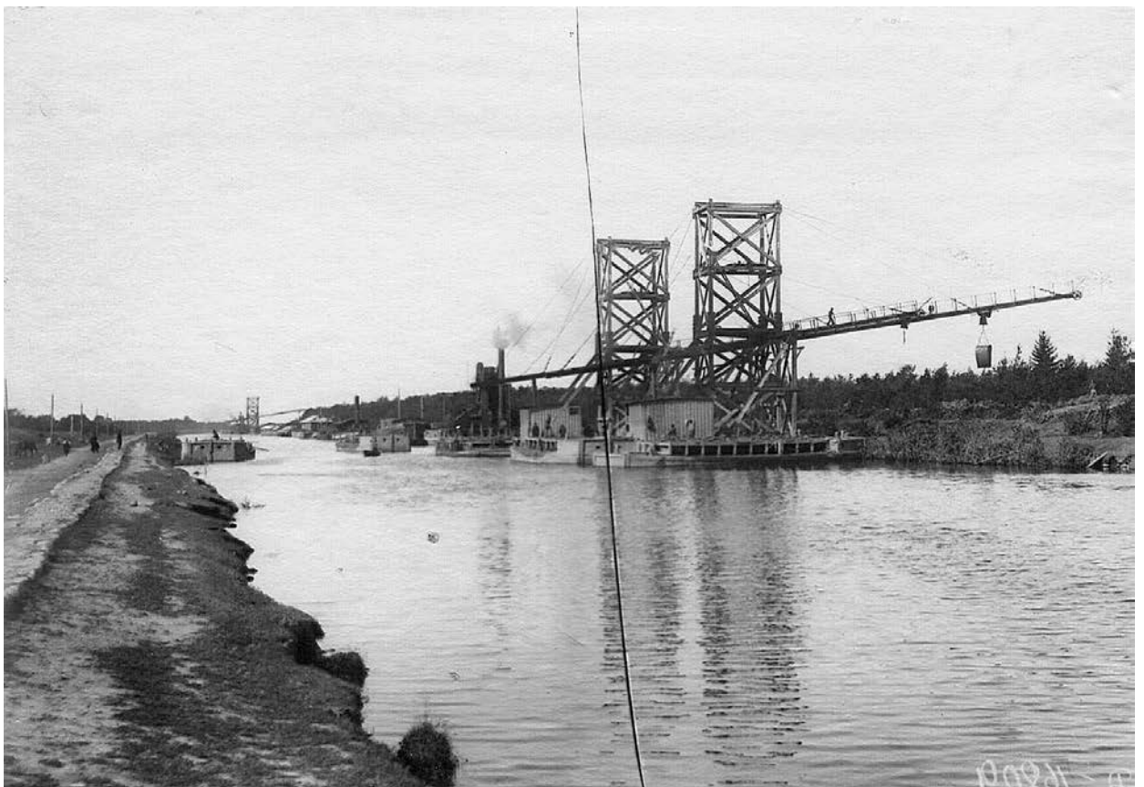
Илл. 54. Вид Новоладожского канала. 1908 г. – ЦГАКФФД. Техническое состояние канала (различные участки)
