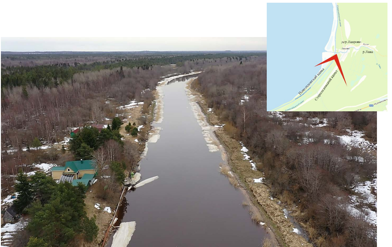
Фото 24. (аэрофотосъемка) Вид на Новолодожский канал со стороны пересечения с р. Лавой в сторону г. Шлиссельбурга.
