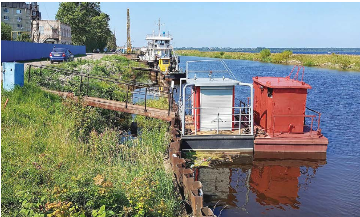
Илл. 42. Новолодожский канал. Спуск к переправе близ Шлиссельбурга. 2018 г.
