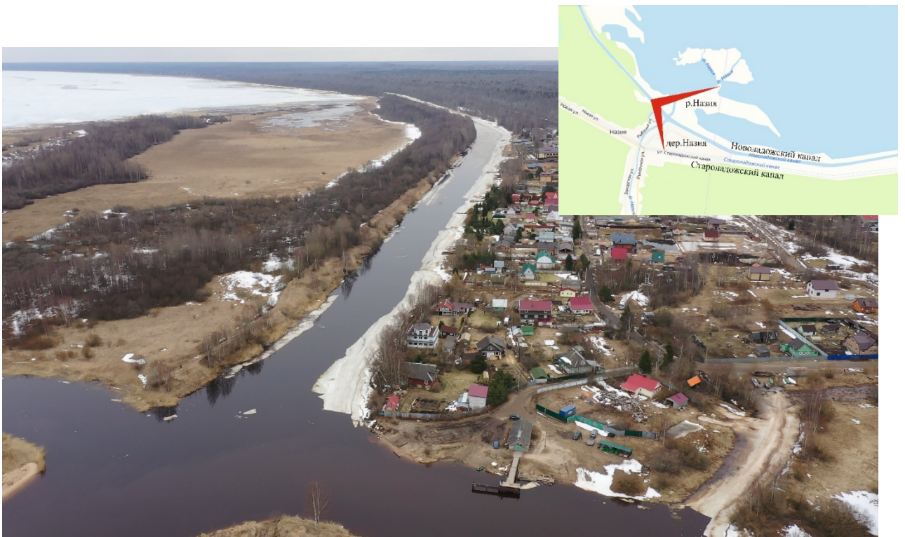
Фото 18. (аэрофотосъемка) Вид на Новолодожский канал в восточном направлении (в сторону Новой Ладogi).
