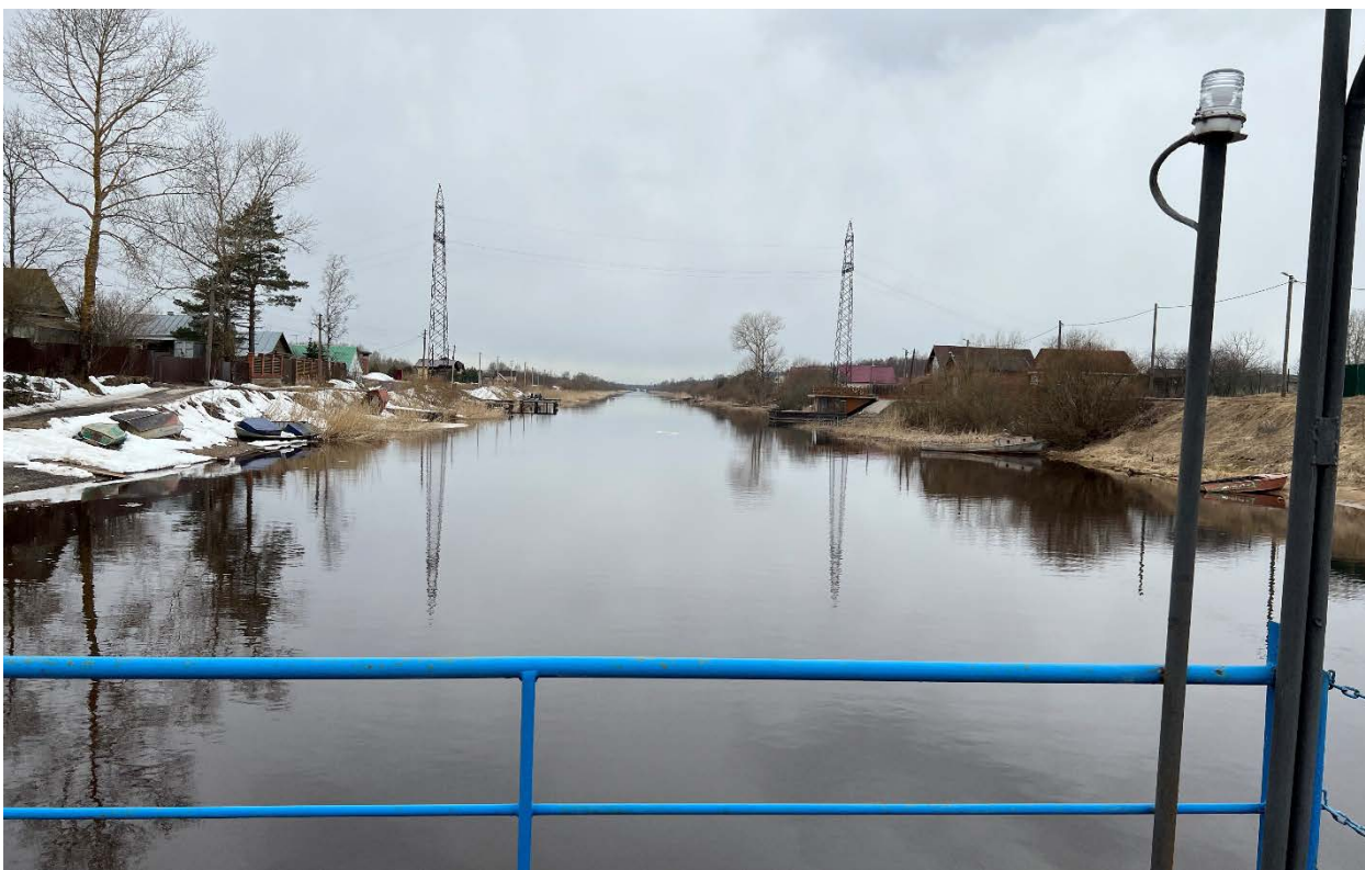
Фото 6. Вид по оси Новолодожского канала в западном направлении с моста через канал в г. Новой Ладге.
