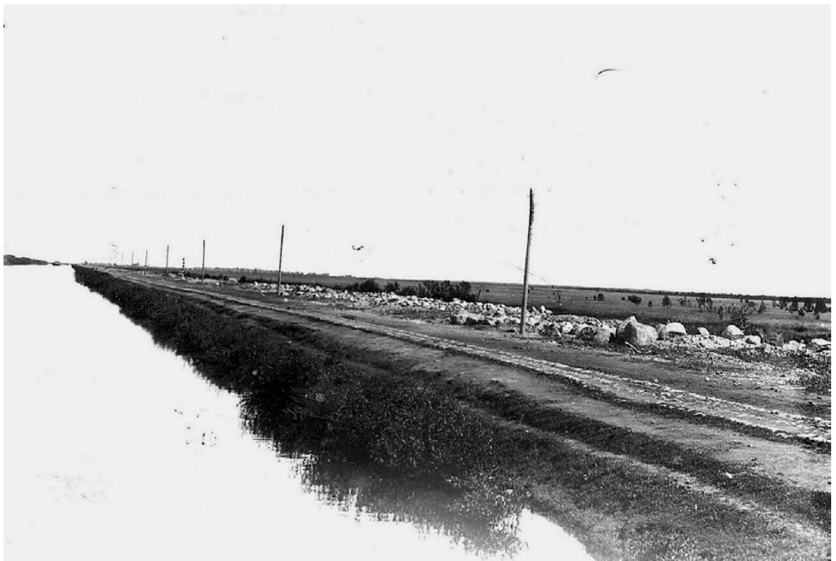
Илл. 52. Вид Ладожского канала. [Бечевник.] Фотография 1908 г. – ЦГАКФФД. Техническое состояние канала (различные участки)
