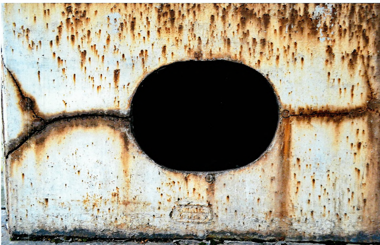
Фото 6. Обелиск, сооруженный в честь строительства Ладожского канала. Отверстие в цоколе на северном фасаде. Вид с юго-востока.
