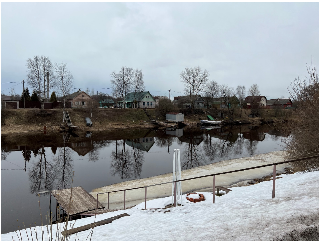
Фото 9. Вид на берег Новолодожского канала, по верху расположена жилая застройка г. Новой Ладogi.
