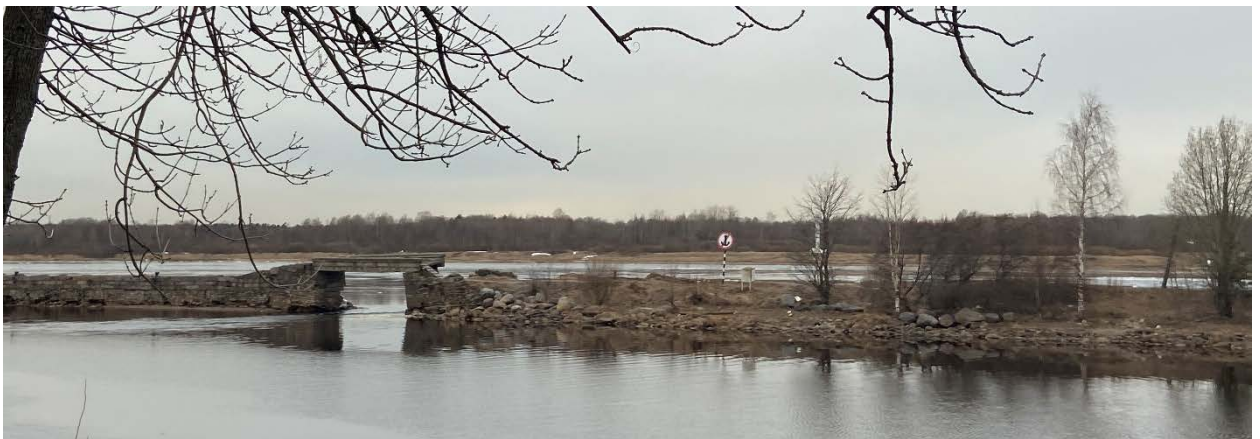
Фото 2. Вид на сопряжения участка первоначальной дамбы, устроенной со стороны Ладожского озера и участка мола, устроенного позже в 1906 г.
