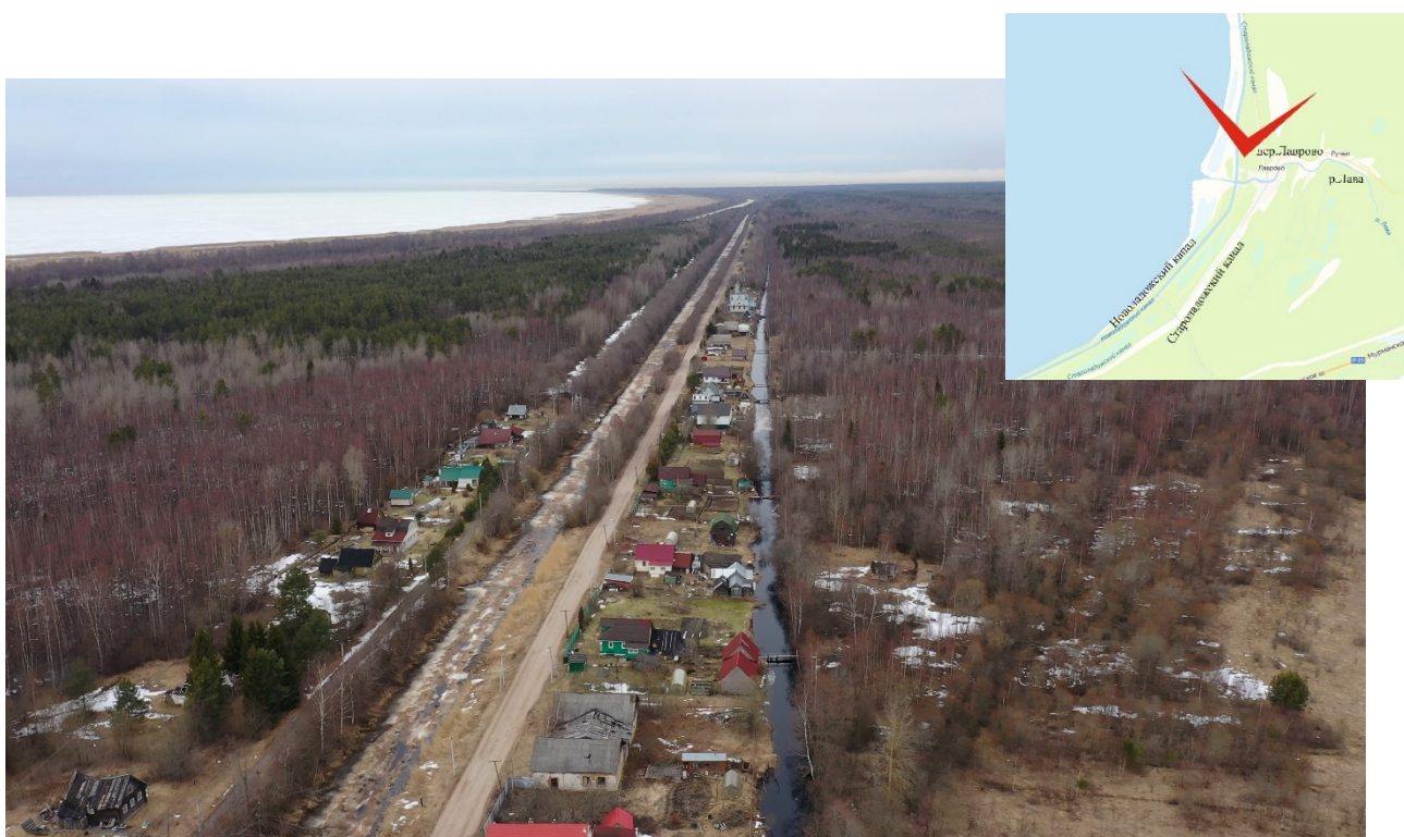
Фото 28. (аэрофотосъемка) Вид по оси Старородожского канала в сторону г. Шлиссербурга.
