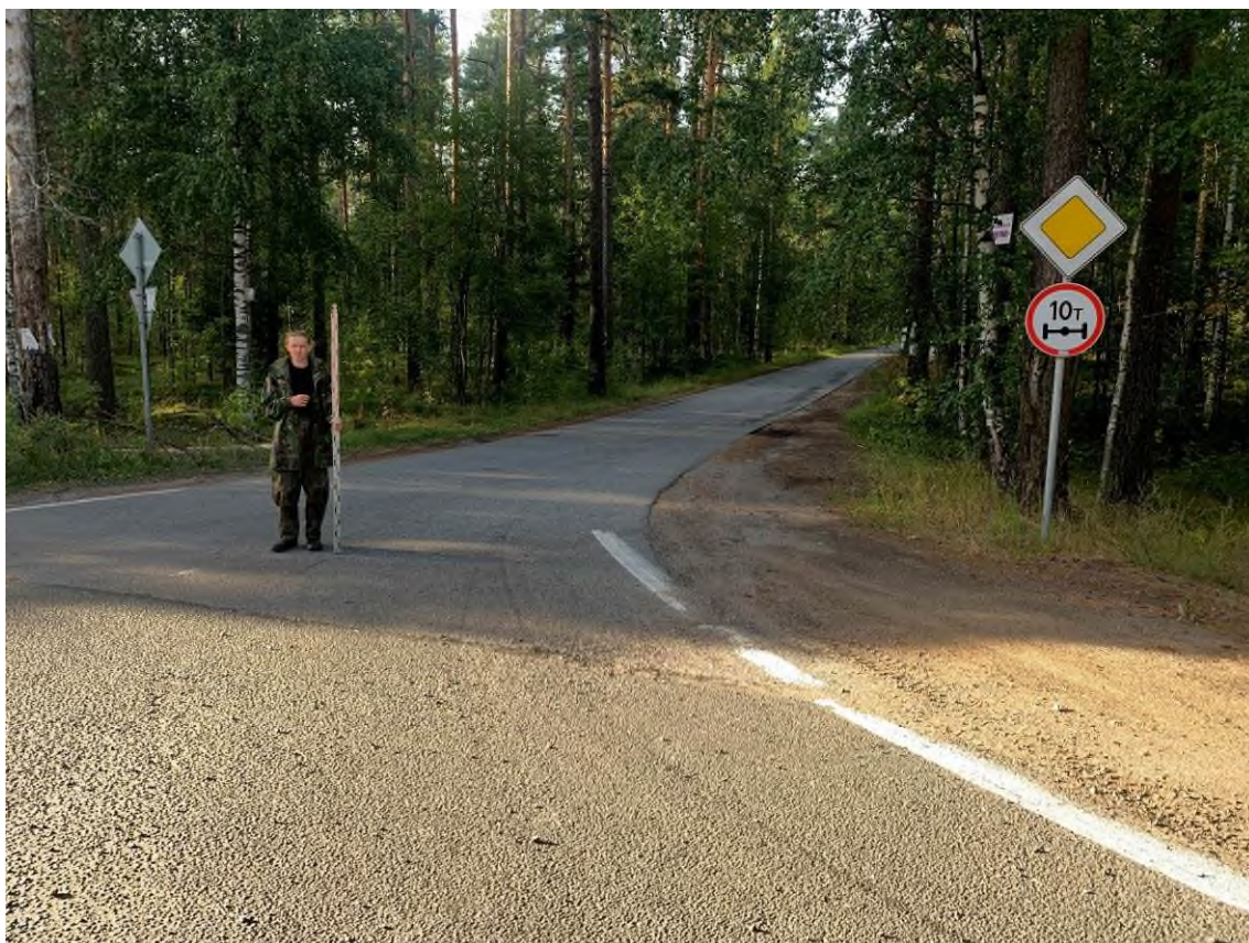
Илл. 37. Ленинградская область, Приозерский район. Общий вид участка обследования. Точка съемки 16. Вид с северо-запада. Для масштаба использована рейка длиной 2 м. 01.08.2022 г.
