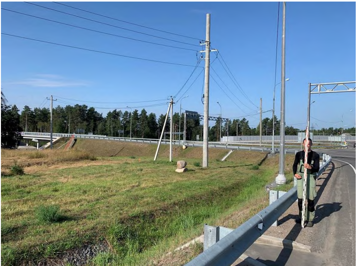
Илл. 6. Ленинградская область, Приозерский район. Общий вид участка обследования. Точка съемки 1. Вид с северо-востока. Для масштаба использована рейка длиной 2 м. 01.08.2022 г.
