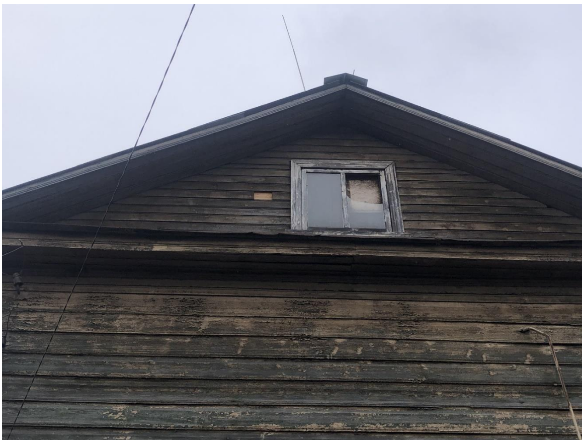
Фото 4. ОКН регионального значения «Жилой дом – бывший дом купцов Ковригиных, впоследствии В.К. Коротнева, сер. XIX в.». Восточный фасад. Фрагмент. Съёмка 21.11.2022 г.
