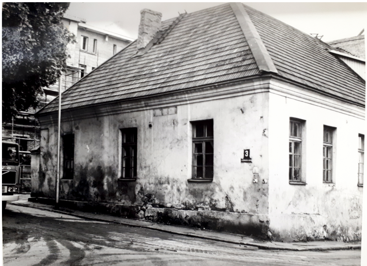
Илл. 17, 18. Фасад со стороны Подгорной ул. и ул. Сторожевой башни. Фото 1982 г. «г. Выборг. Жилой дом по ул. Сторожевой башни, дом 3. Предварительные работы. Схематический обмер. Фотофиксация. Р. I, д.1. НИ и ПИ «Спецпроектреставрация» //Архив ККЛЮ. № 1127-1
