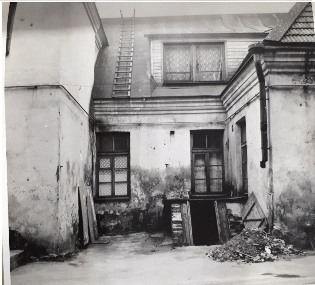
Илл. 19, 20. Дворовый фасад. Фото 1982 г. «г. Выборг. Жилой дом по ул. Сторожевой башни, дом 3. Предварительные работы. Схематический обмер. Фотофиксация. Р. I, д.1. НИ и ПИ «Спецпроектреставрация» //Архив ККЛО. № 1127-1
