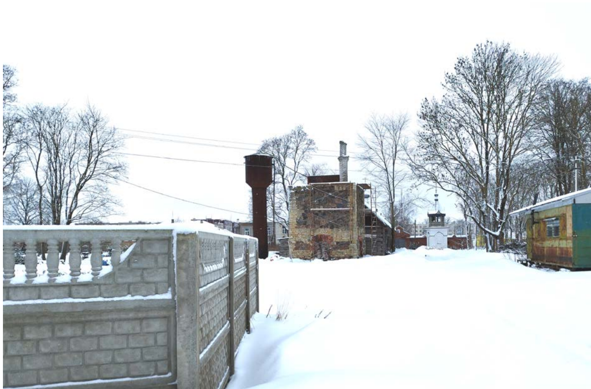
Фото 3. Водонапорная башня (XIX в.)
