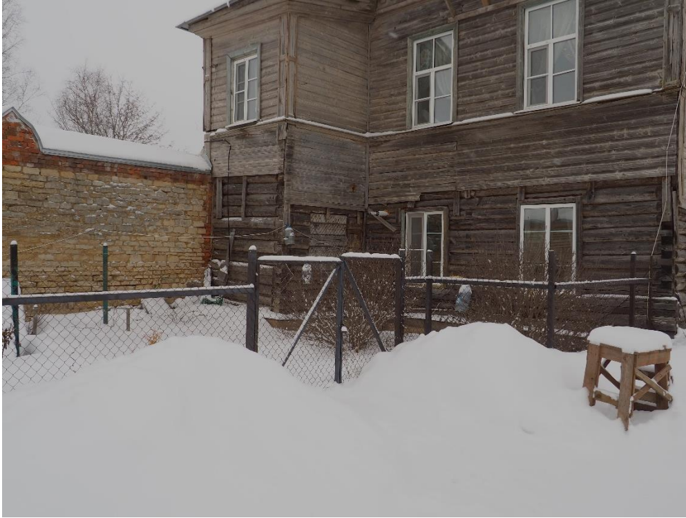
3. Монастырская больница с домово́й церковью Св. Велико́мученика Пантеле́ймона. Место расположения кухни. Точка проектируемого подключения внутреннего газопровода. Общий вид с юга. 03.02.2023 г.
