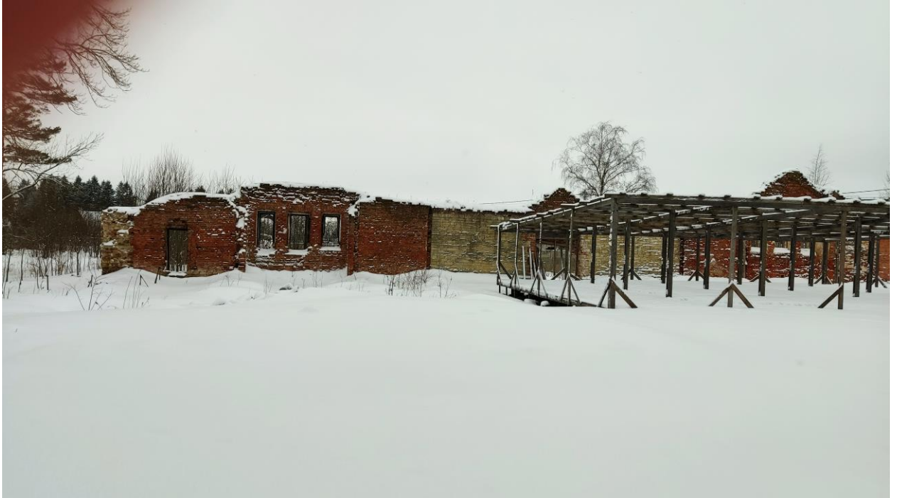
7. Место утраченной малой колокольни (южной часовни) от трассы проектируемого газопровода. Общий вид с юго-востока. 03.02.2023 г.
