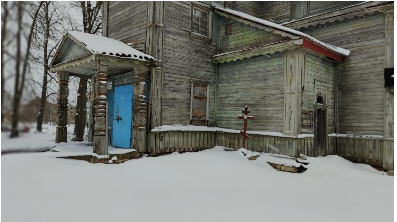
9. Крыльцо церкви Тихвинской иконы Божией Матери. Общий вид с юго-запада. 03.02.2023 г.
