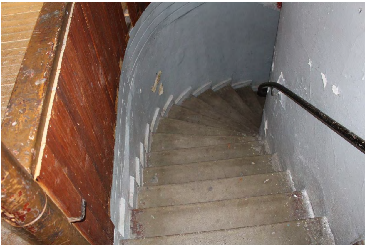
Фото 75. Внутренние помещения объекта культурного наследия регионального значения «Кирха». 2-й этаж, помещение № 1, вид на лестницу со 2-го этажа.
