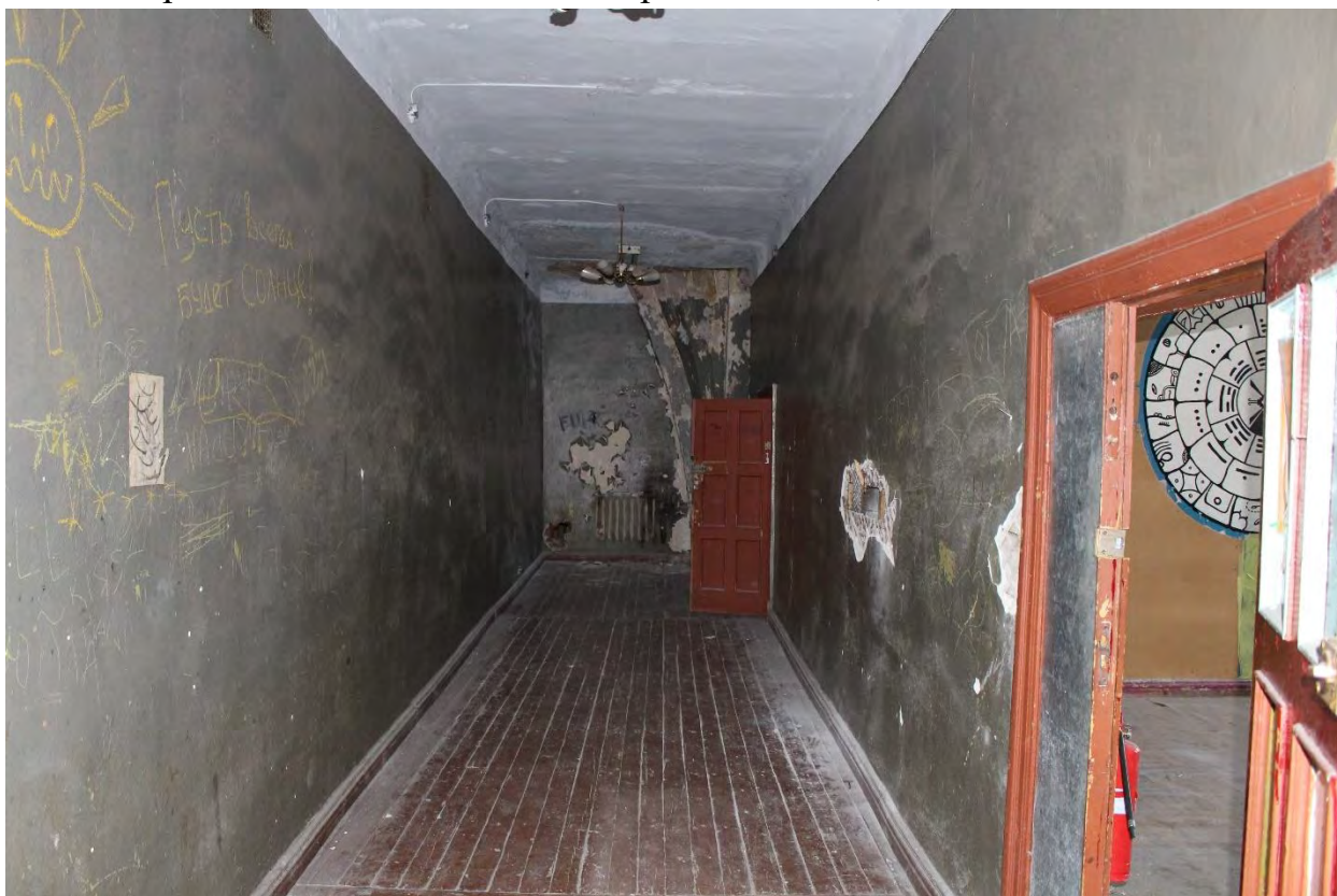
Фото 82. Внутренние помещения объекта культурного наследия регионального значения «Кирха». 2-й этаж, помещение № 6.
