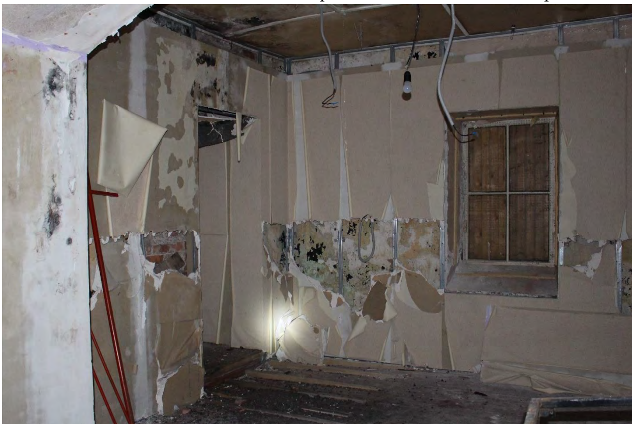
Фото 58. Внутренние помещения объекта культурного наследия регионального значения «Кирха». 1-й этаж, помещение № 13.
