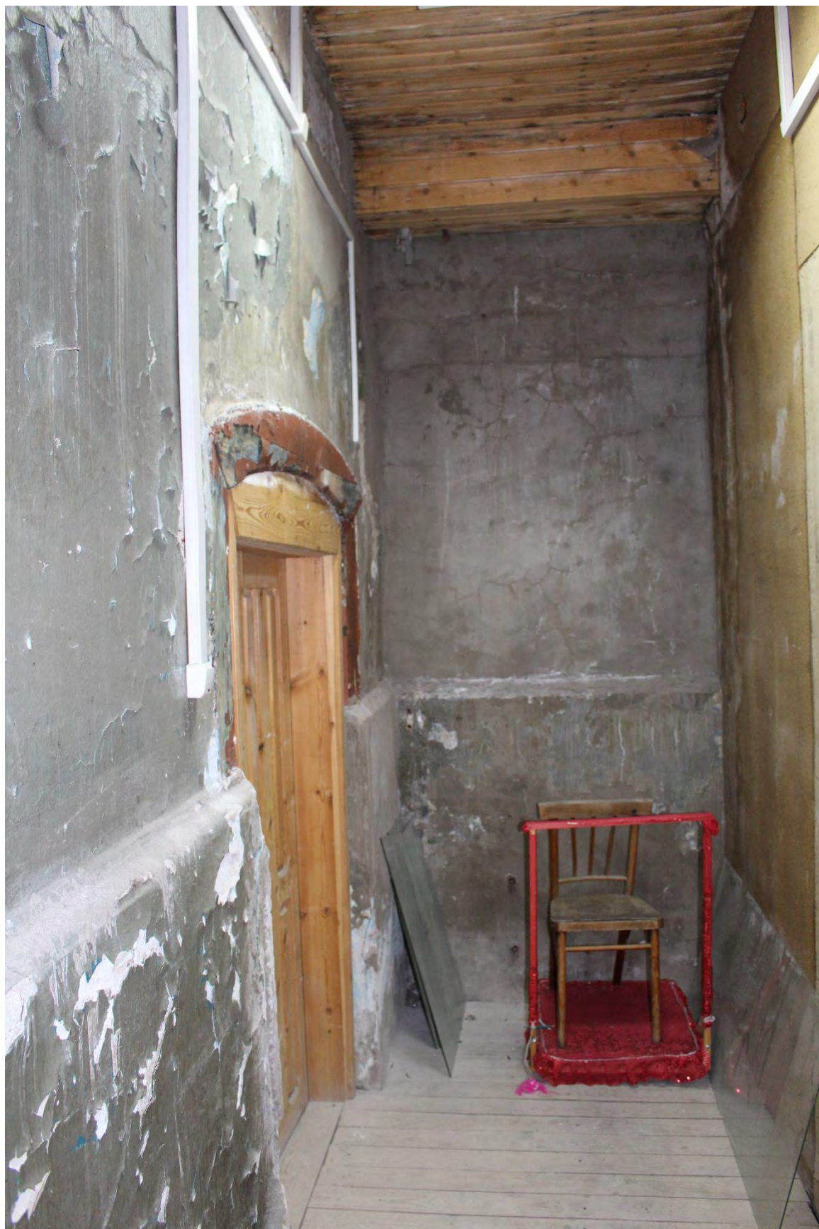
Фото 43. Внутренние помещения объекта культурного наследия регионального значения «Кирха». 1-й этаж, помещение № 16.
