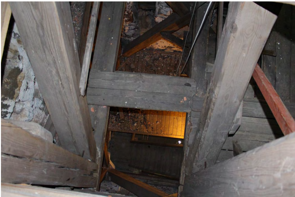
Фото 53. Вид на деревянные конструкции подъема шпиля башни в северо-западной части здания кирхи.
