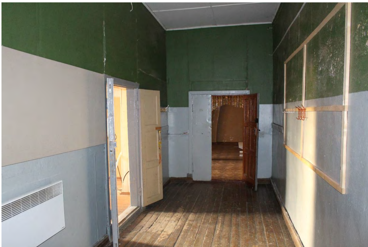
Фото 88. Внутренние помещения объекта культурного наследия регионального значения «Кирха». 2-й этаж, помещение № 2.
