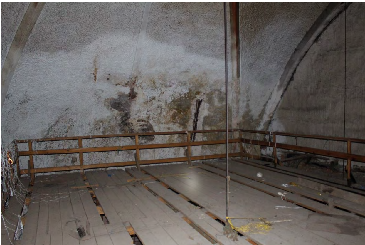
Фото 63. Внутренние помещения объекта культурного наследия регионального значения «Кирха». Технический этаж над сценой.
