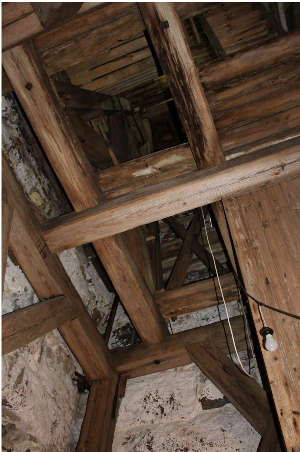
Фото 52. Вид на деревянные конструкции подъема шпиля башни в северо-западной части здания кирхи.
