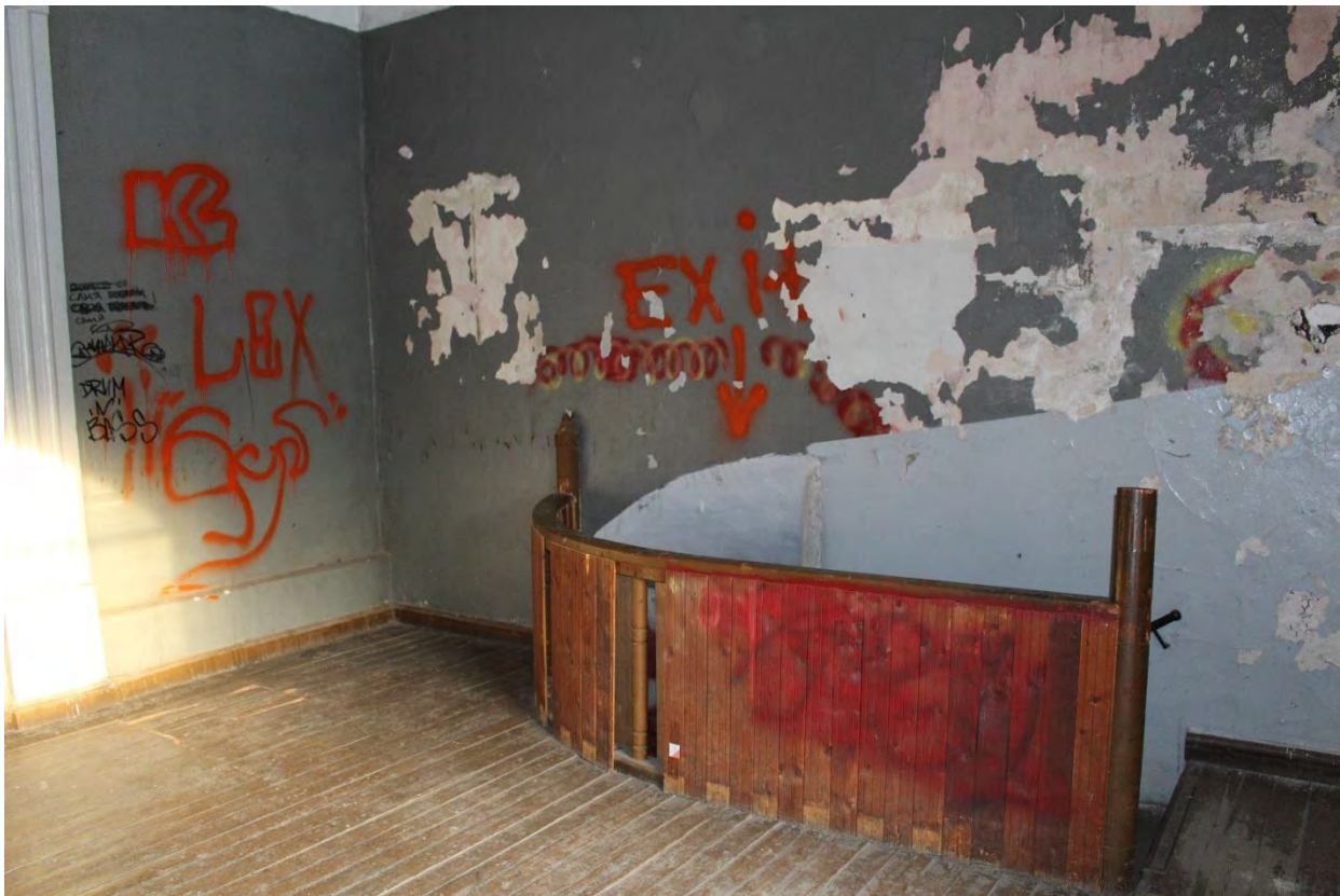
Фото 76. Внутренние помещения объекта культурного наследия регионального значения «Кирха». 2-й этаж, помещение № 1.
