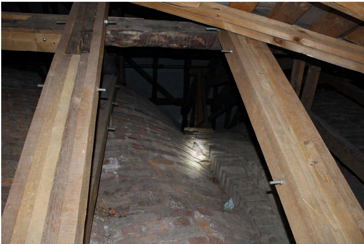
Фото 50. Внутренние помещения объекта культурного наследия регионального значения «Кирха». Технический этаж, чердачное помещение.
