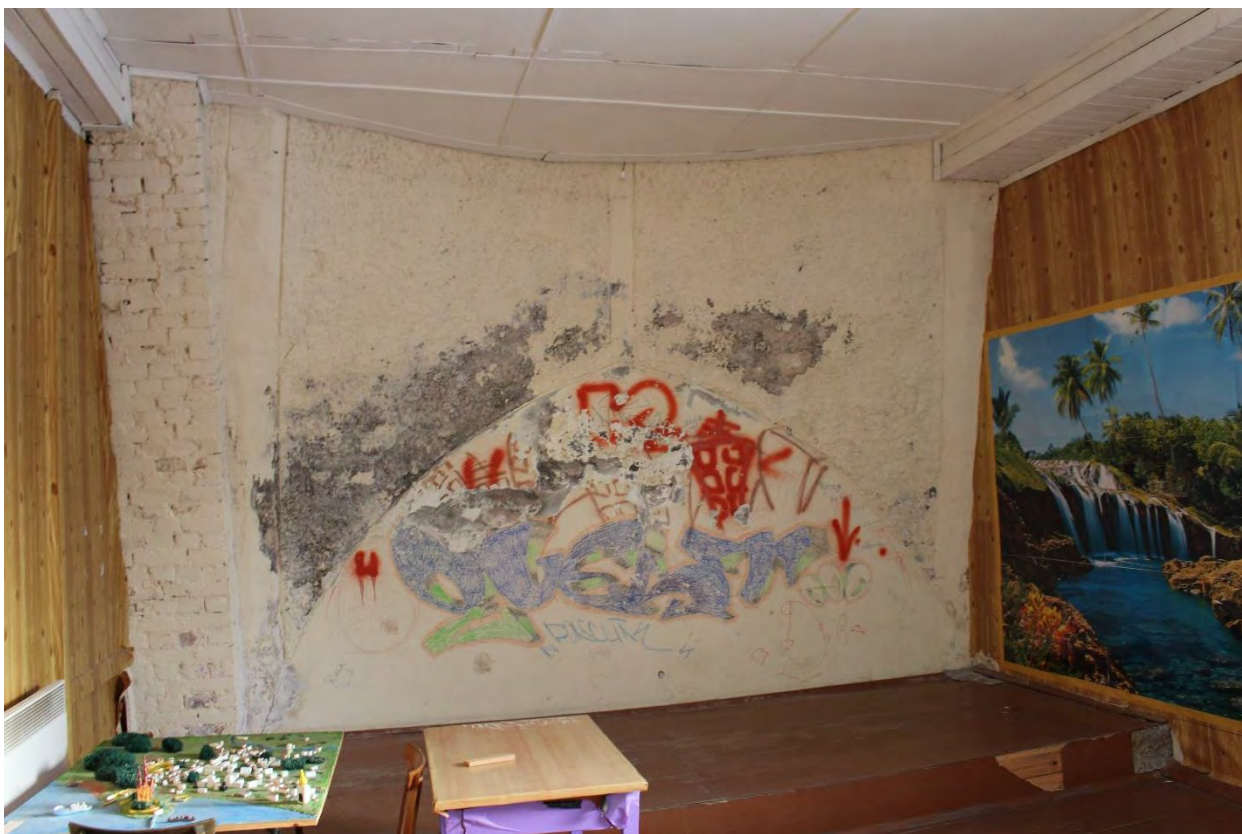
Фото 90. Внутренние помещения объекта культурного наследия регионального значения «Кирха». 2-й этаж, помещение № 3.
