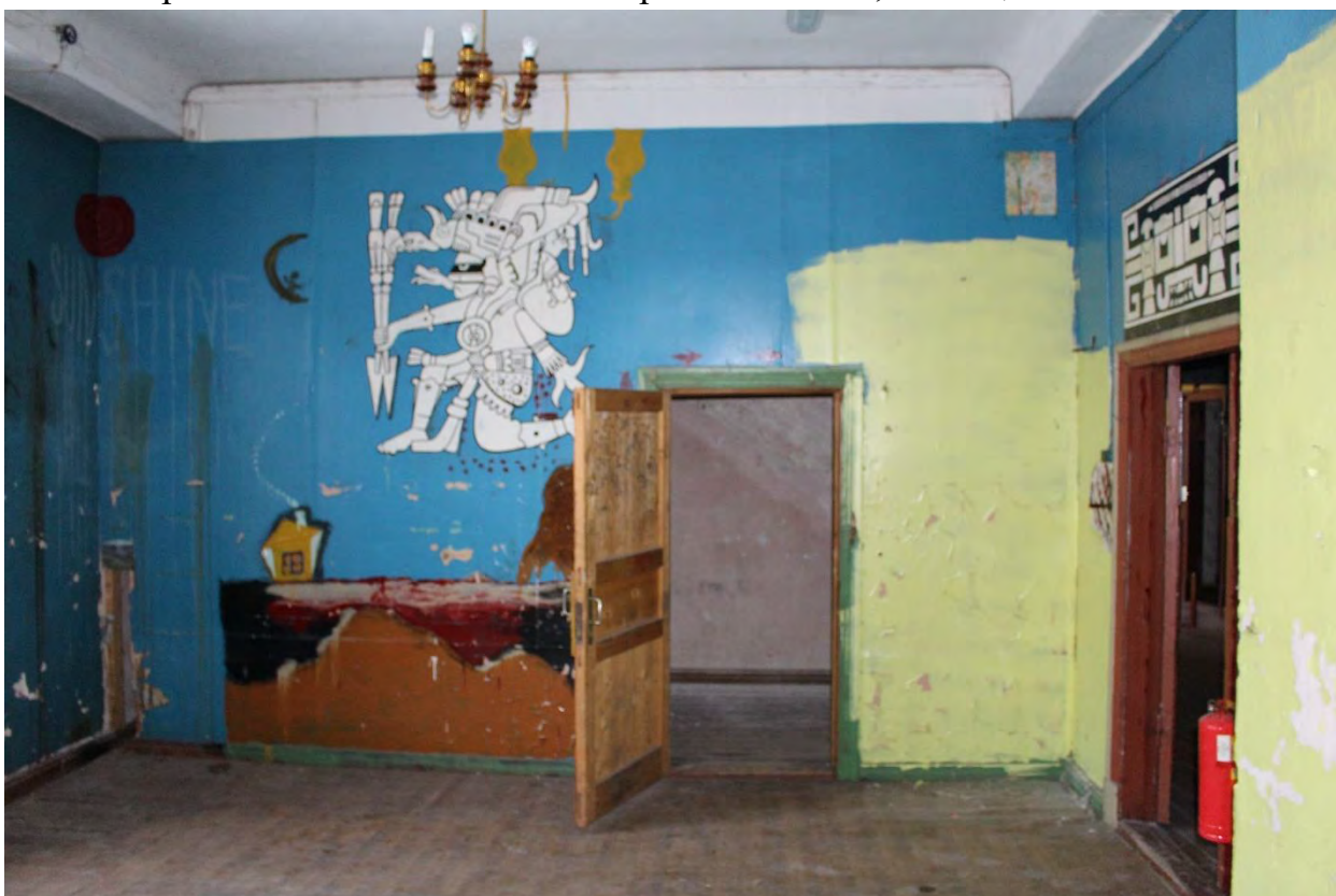
Фото 84. Внутренние помещения объекта культурного наследия регионального значения «Кирха». 2-й этаж, помещение № 11.
