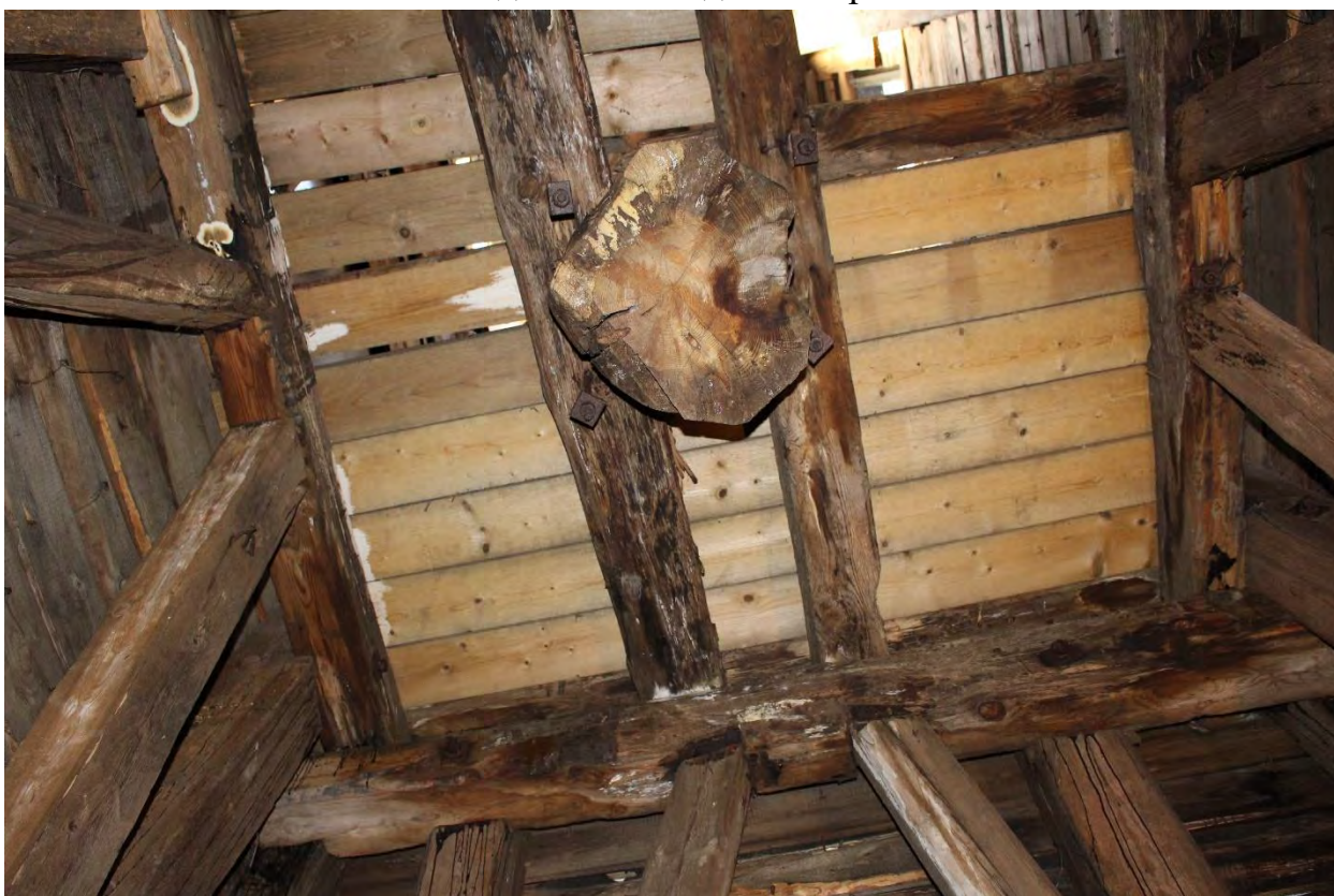
Фото 56. Вид на деревянные конструкции подъема шпиля башни в северо-западной части здания кирхи.
