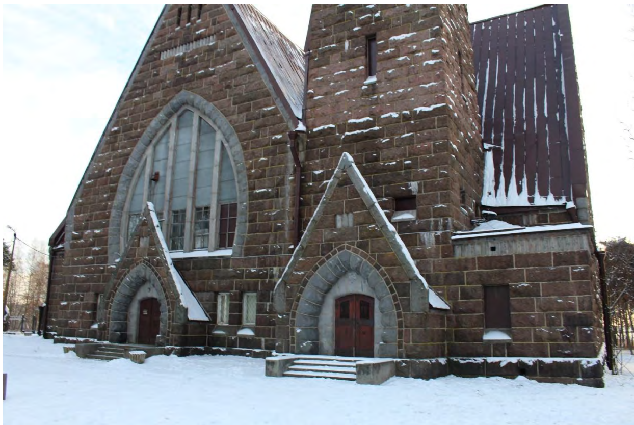
Фото 9. Вид на северный фасад объекта культурного наследия регионального значения «Кирха».
