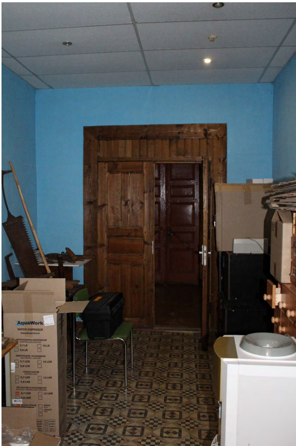
Фото 41. Внутренние помещения объекта культурного наследия регионального значения «Кирха». 1-й этаж, помещение № 18.
