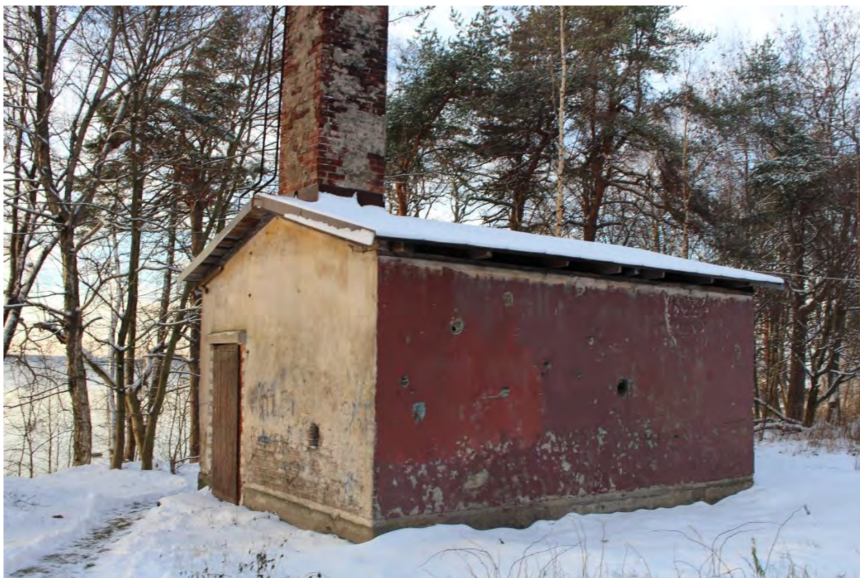
Фото 22. Вид на здание бывшей котельной, расположенное к западу от здания – объекта культурного наследия регионального значения «Кирха».
