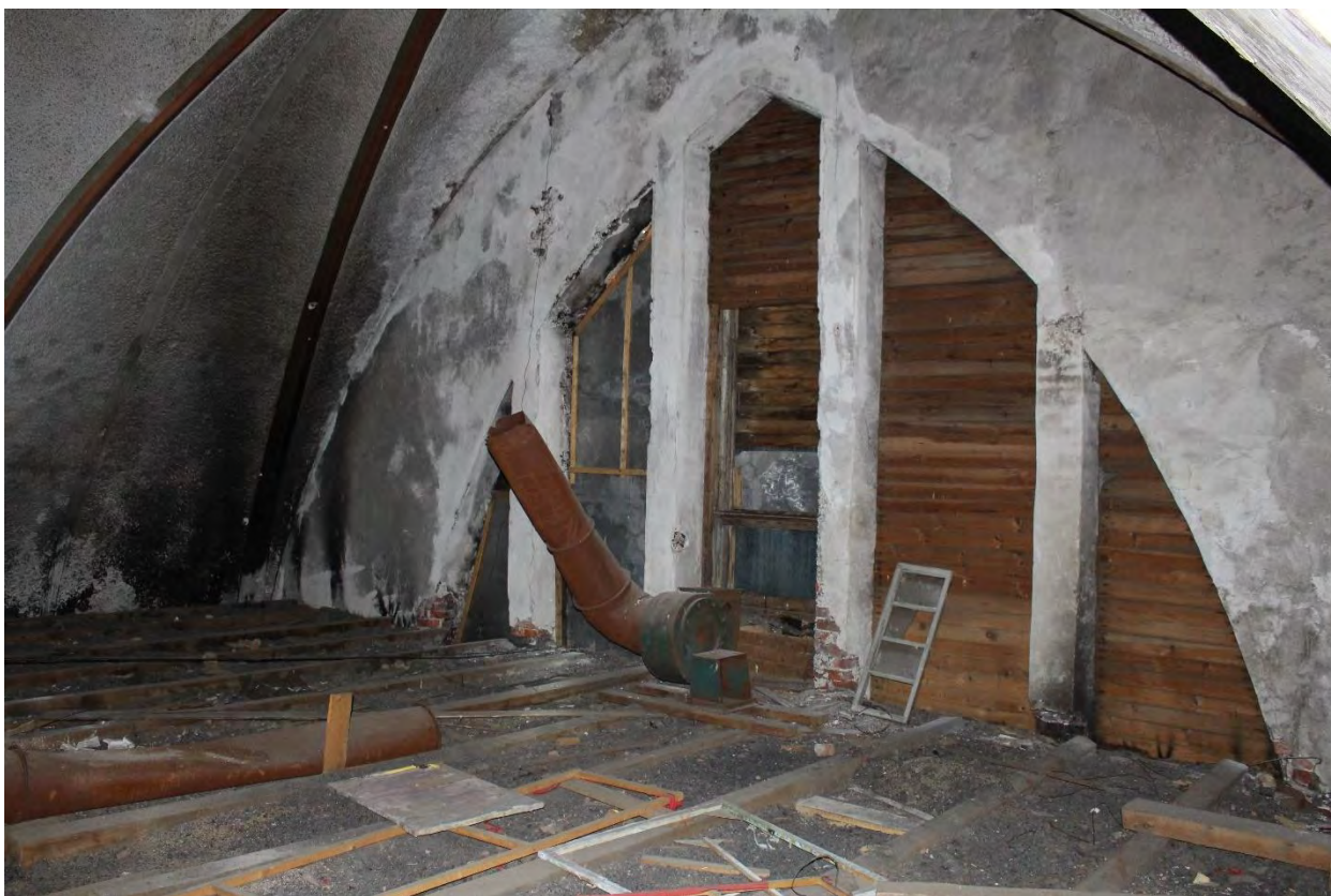
Фото 67. Внутренние помещения объекта культурного наследия регионального значения «Кирха». Технический этаж над зрительным залом.
