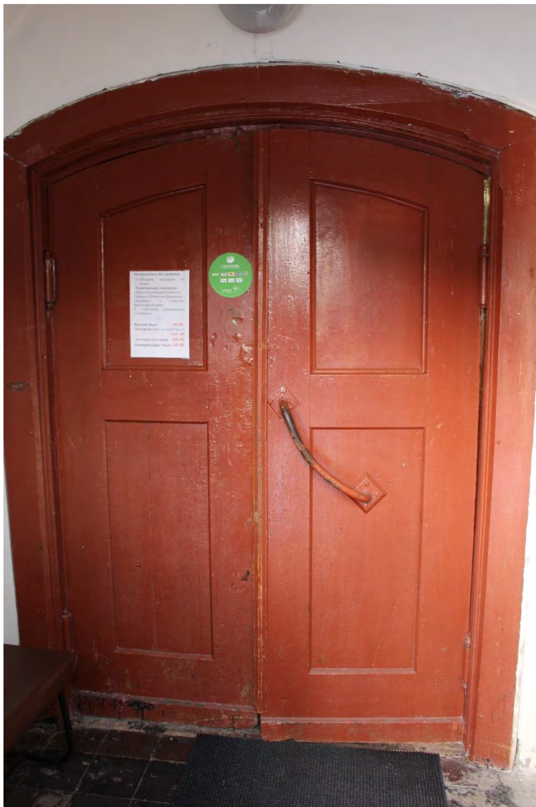
Фото 27. Внутренние помещения объекта культурного наследия регионального значения «Кирха». 1-й этаж, помещение № 6.
