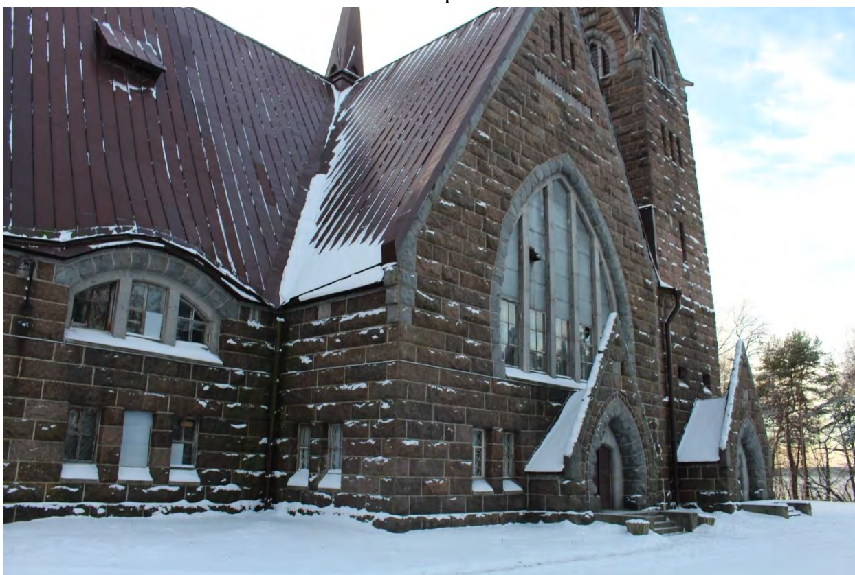
Фото 10. Вид на северный фасад объекта культурного наследия регионального значения «Кирха».
