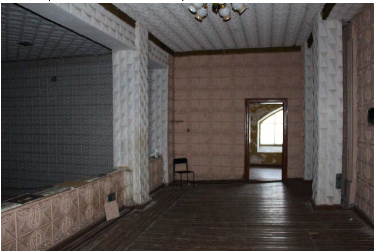
Фото 78. Внутренние помещения объекта культурного наследия регионального значения «Кирха». 2-й этаж, помещение № 17.
