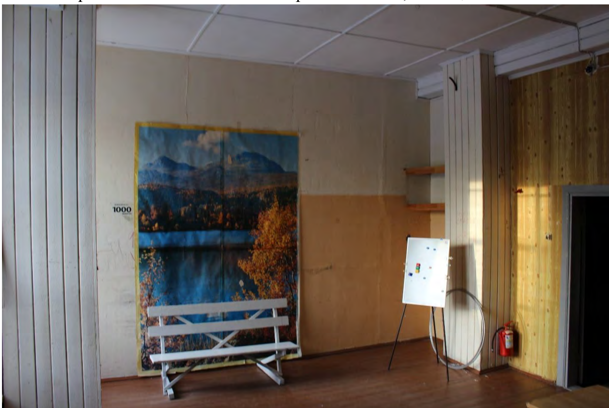
Фото 91. Внутренние помещения объекта культурного наследия регионального значения «Кирха». 2-й этаж, помещение № 3.
