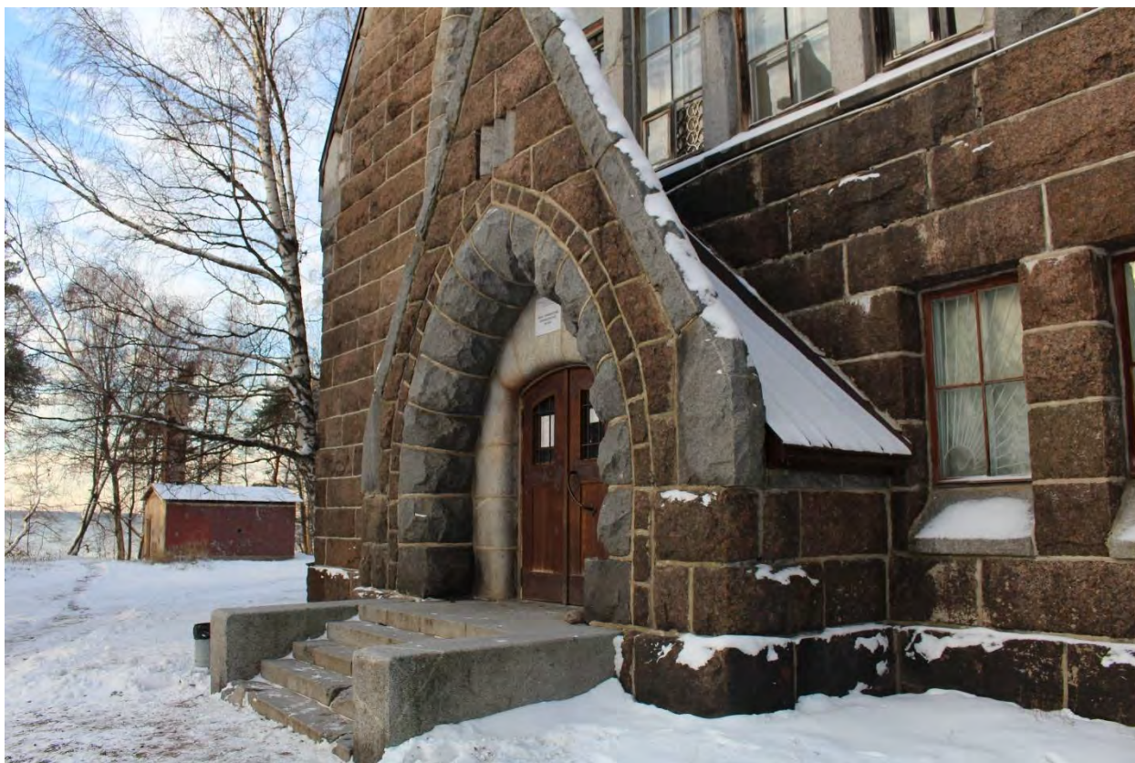
Фото 4. Вид на вход с южного фасада в здание – объект культурного наследия регионального значения «Кирха».
