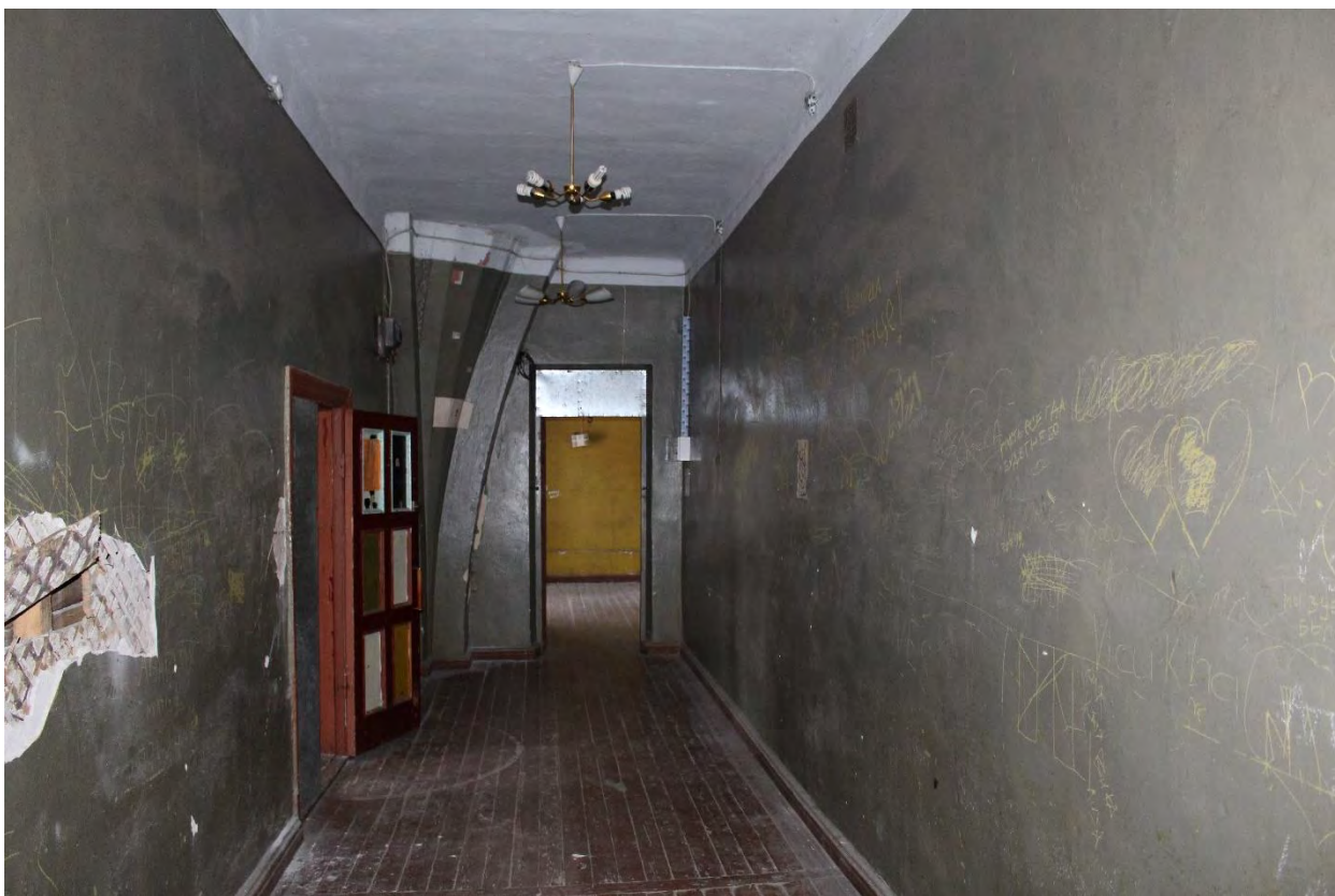
Фото 85. Внутренние помещения объекта культурного наследия регионального значения «Кирха». 2-й этаж, помещение № 6.
