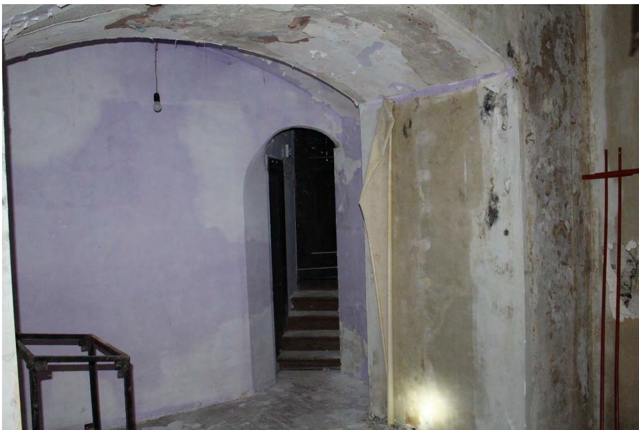
Фото 59. Внутренние помещения объекта культурного наследия регионального значения «Кирха». 1-й этаж, помещение № 13.
