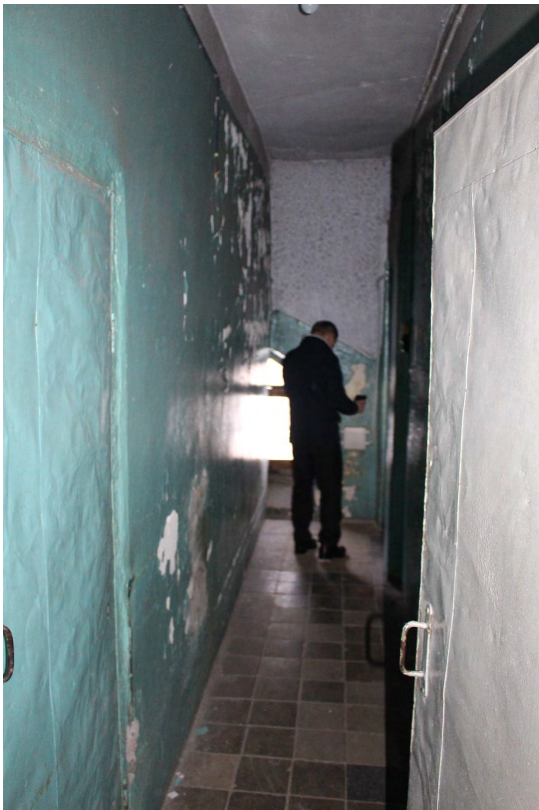
Фото 72. Внутренние помещения объекта культурного наследия регионального значения «Кирха». 2-й этаж, помещение № 13.
