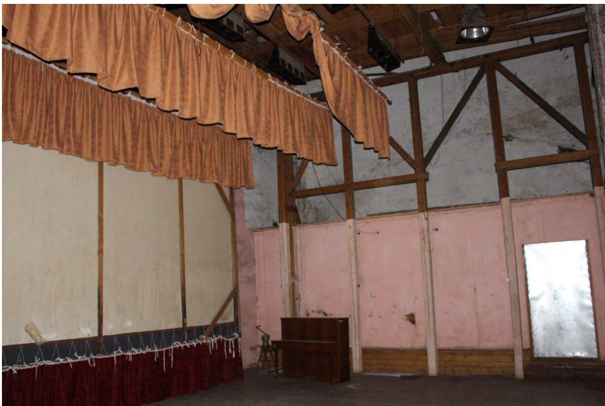
Фото 61. Внутренние помещения объекта культурного наследия регионального значения «Кирха». 1-й этаж, помещение № 9.
