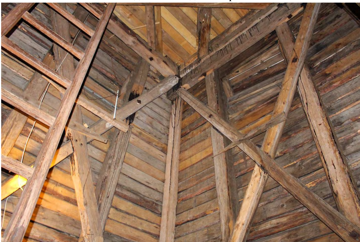
Фото 54. Вид на деревянный короб башни в северо-западной части здания кирхи.
