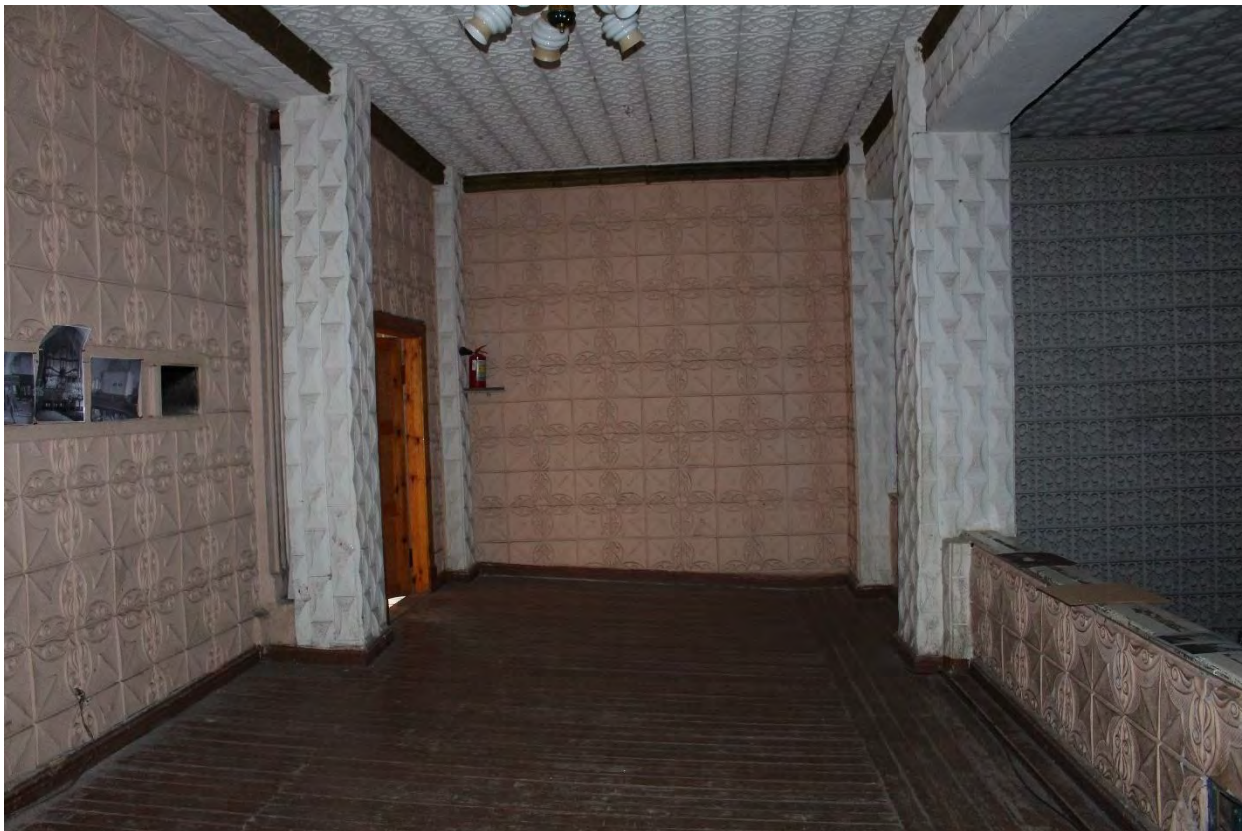
Фото 80. Внутренние помещения объекта культурного наследия регионального значения «Кирха». 2-й этаж, помещение № 17.
