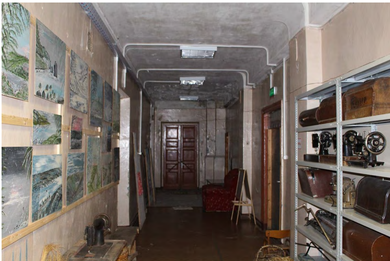
Фото 35. Внутренние помещения объекта культурного наследия регионального значения «Кирха». 1-й этаж, помещение № 11.
