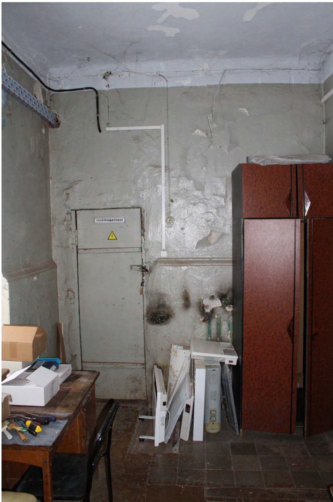
Фото 34. Внутренние помещения объекта культурного наследия регионального значения «Кирха». 1-й этаж, помещение № 20.
