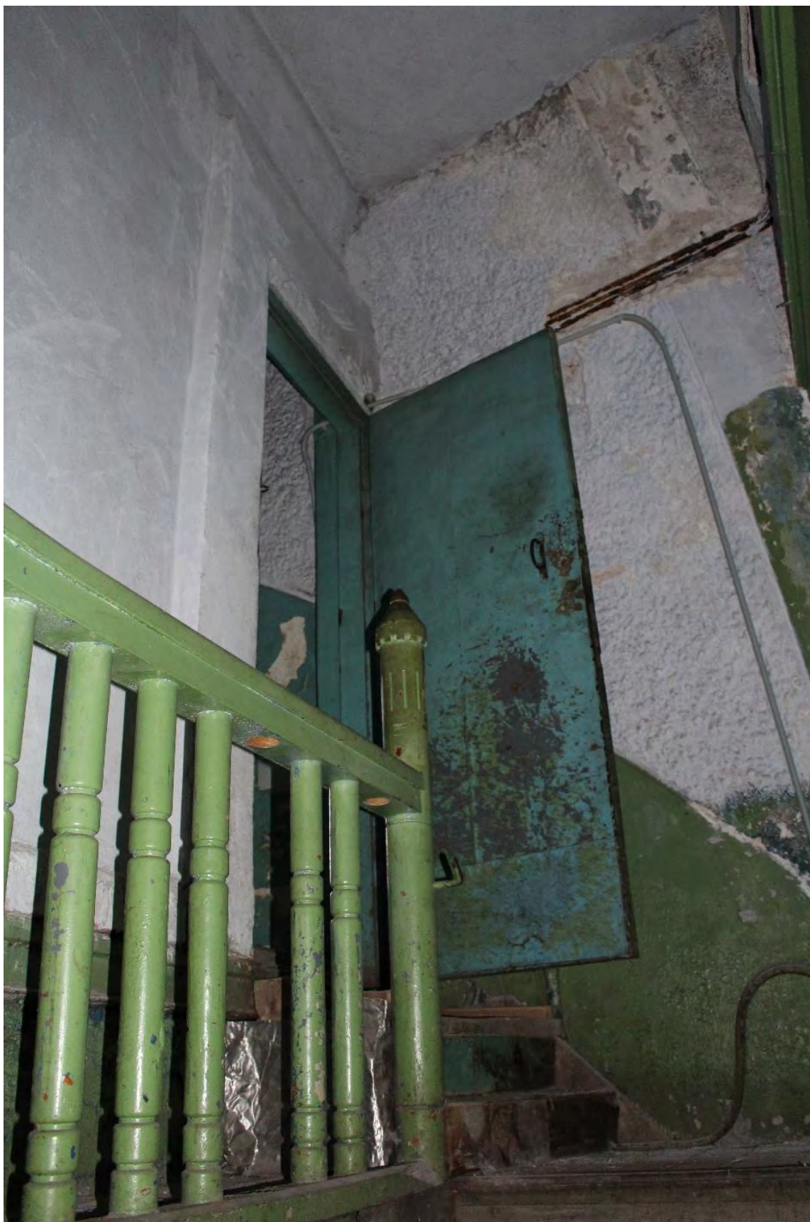
Фото 71. Внутренние помещения объекта культурного наследия регионального значения «Кирха». 2-й этаж, помещение № 14.
