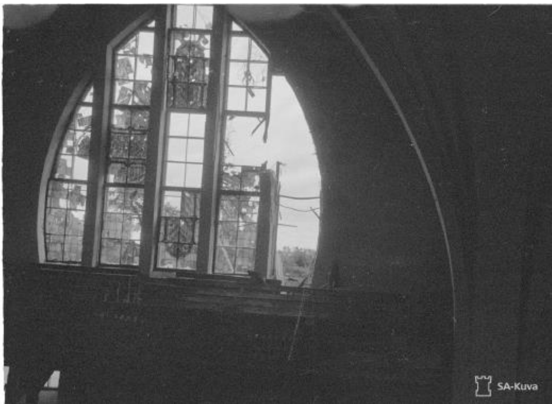
Илл. 81. Поврежденное снарядом боковое окно церкви. 1941 г. (источник: https://www.finna.fi/Record/sa-kuva.sa-kuva-61857 ).
