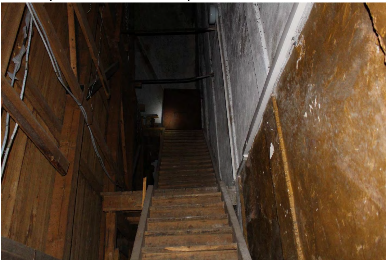
Фото 62. Внутренние помещения объекта культурного наследия регионального значения «Кирха». 1-й этаж, помещение № 13, лестница на технический этаж над сценой.
