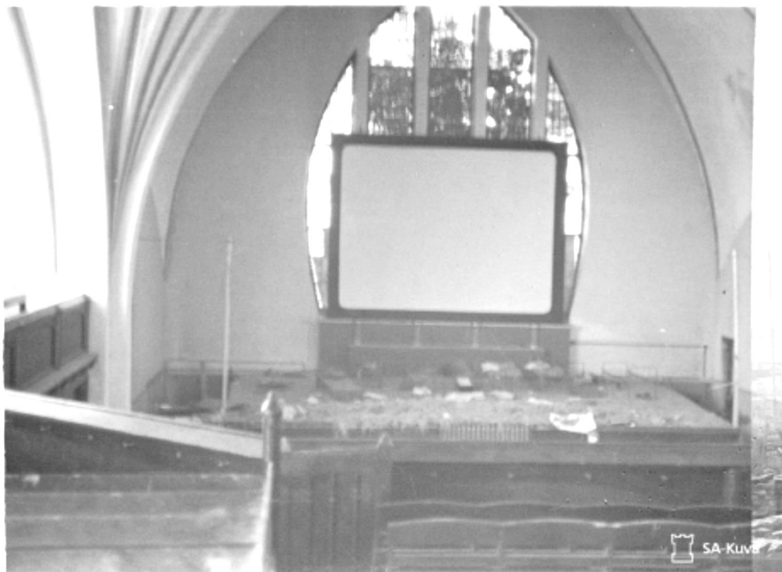
Илл. 83. Интерьер кирхи. Экран кинотеатра на западном окне. 1941 г. (источник: https://www.finna.fi/Record/sa-kuva.sa-kuva-63294 ).
