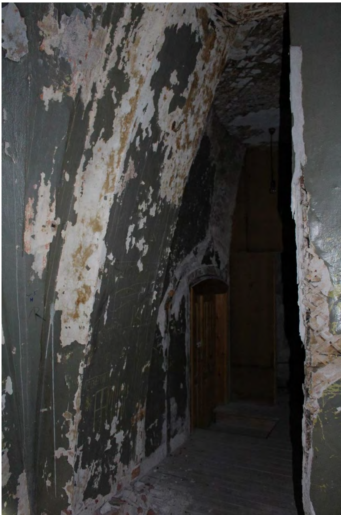
Фото 87. Внутренние помещения объекта культурного наследия регионального значения «Кирха». 2-й этаж, помещение № 9.
