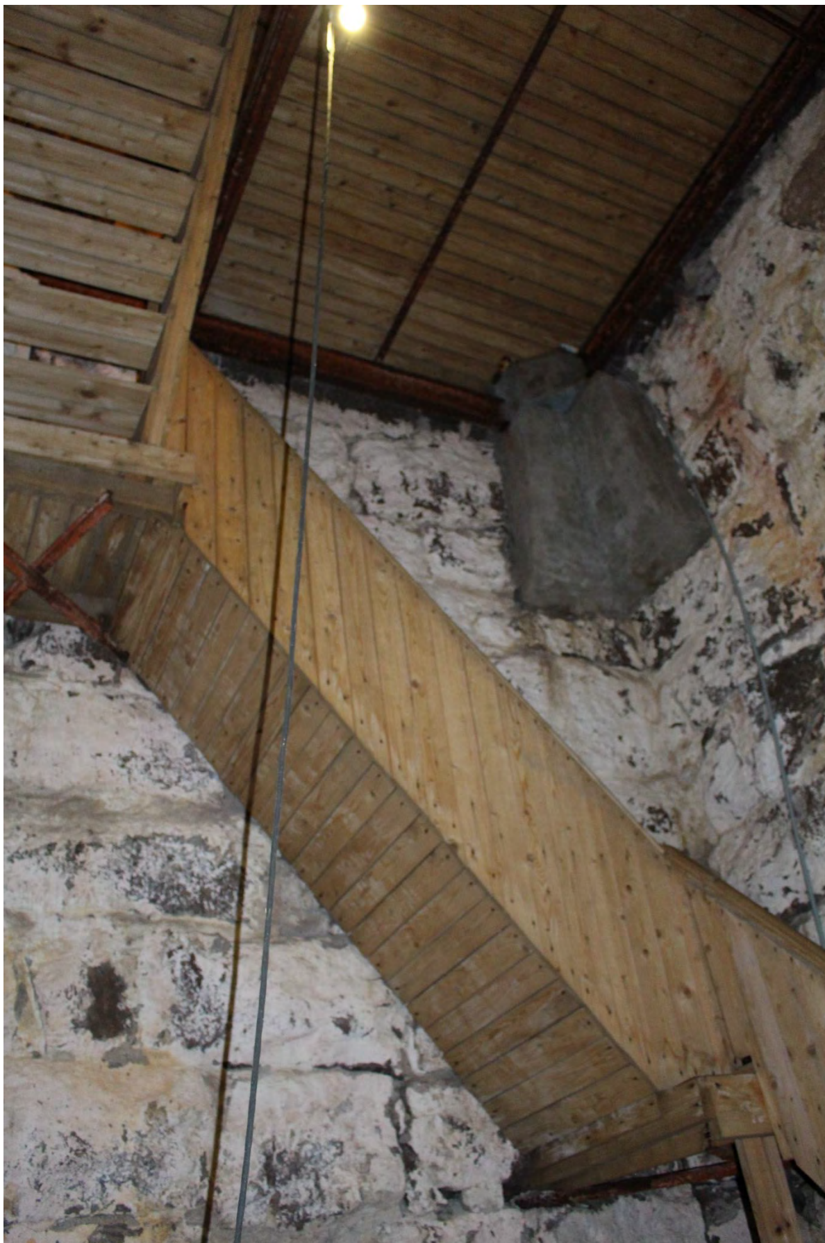
Фото 51. Внутренние помещения объекта культурного наследия регионального значения «Кирха». Лестница башни в северо-западной части здания.
