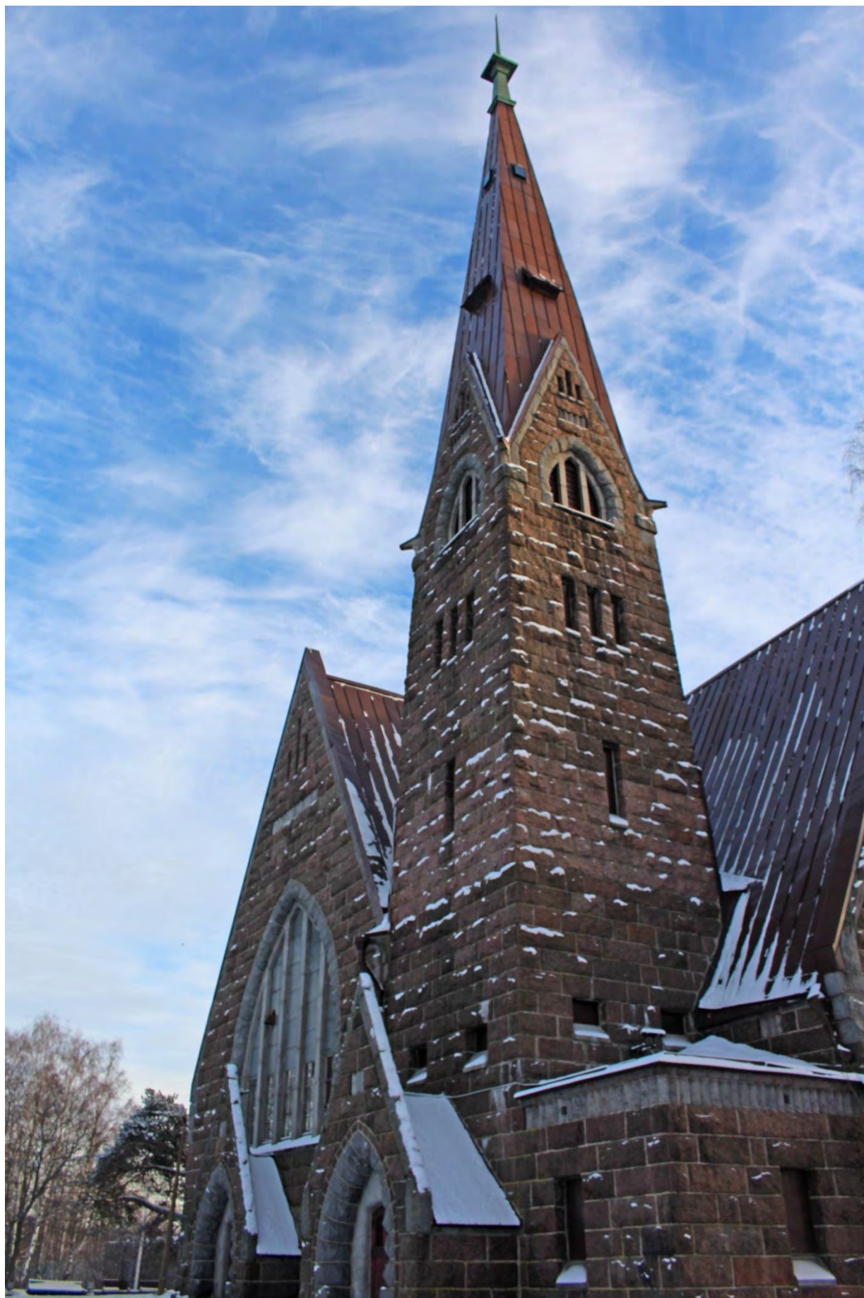
Фото 8. Вид на северный фасад объекта культурного наследия регионального значения «Кирха».
