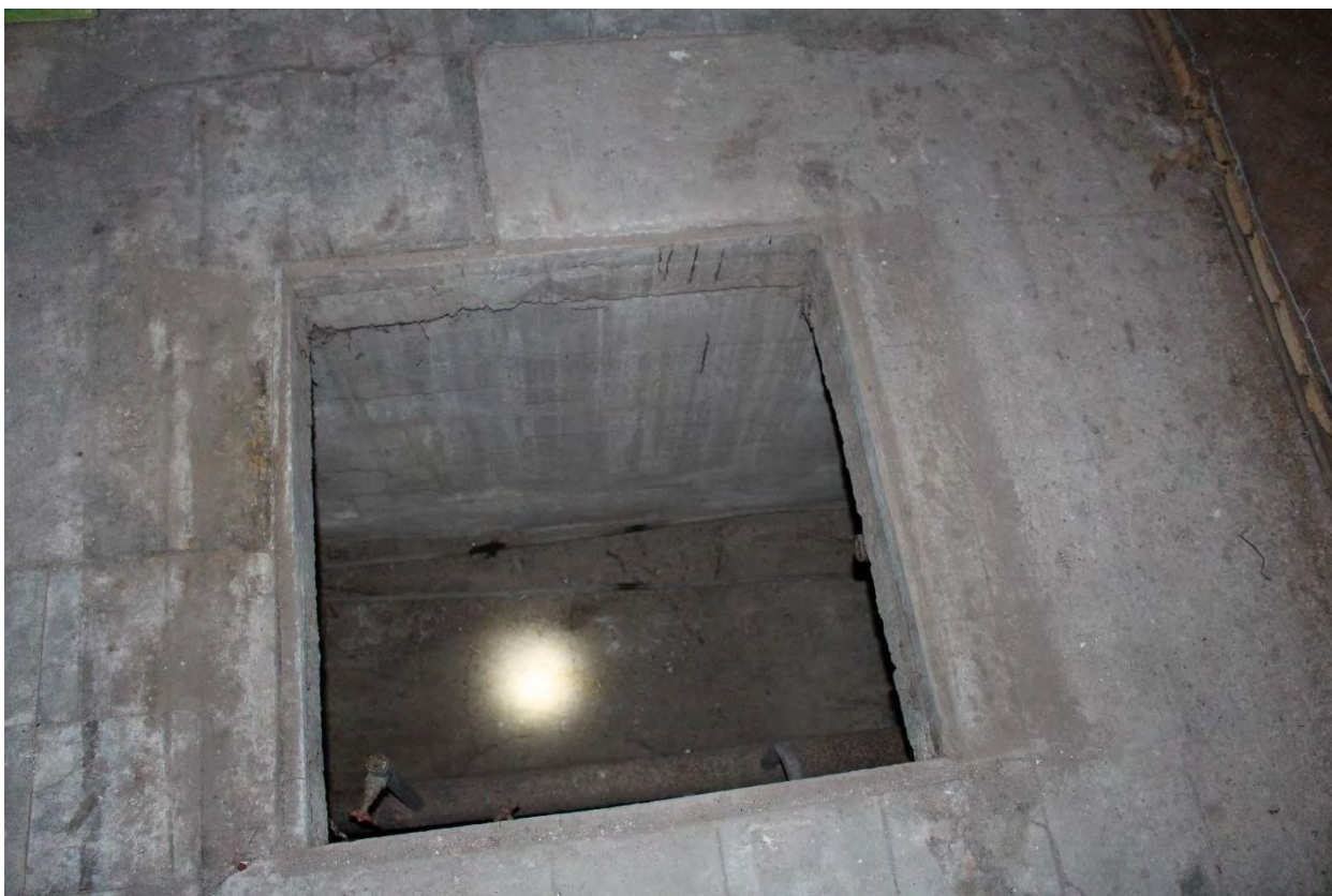
Фото 37. Подземный канал в помещении № 11 1-го этажа объекта культурного наследия регионального значения «Кирха».
