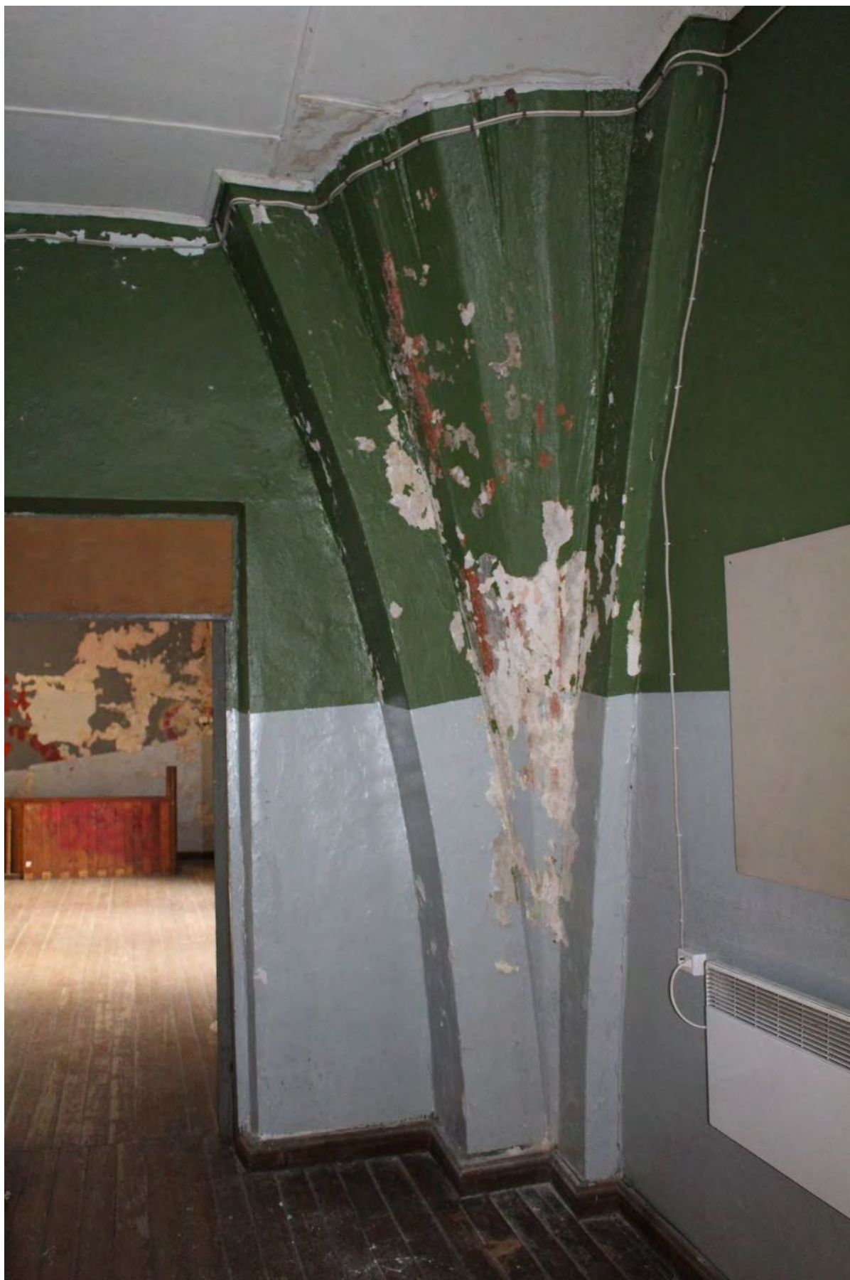
Фото 89. Внутренние помещения объекта культурного наследия регионального значения «Кирха». 2-й этаж, помещение № 2.
