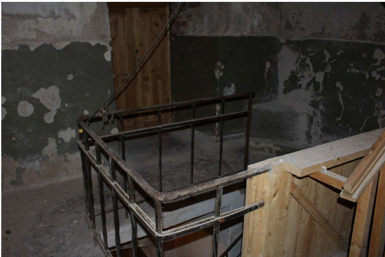
Фото 46. Внутренние помещения объекта культурного наследия регионального значения «Кирха». 2-й этаж, помещение № 8.
