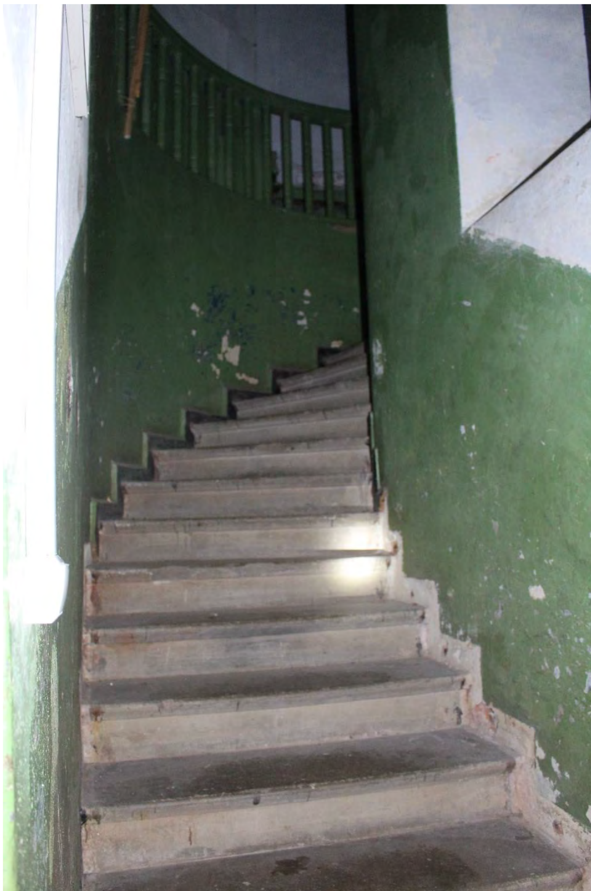
Фото 70. Внутренние помещения объекта культурного наследия регионального значения «Кирха». 1-й этаж, помещение № 24, вид на лестницу, ведущую на 2-й этаж.
