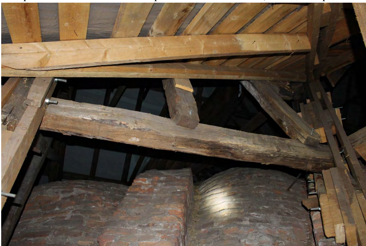
Фото 49. Внутренние помещения объекта культурного наследия регионального значения «Кирха». Технический этаж, чердачное помещение.
