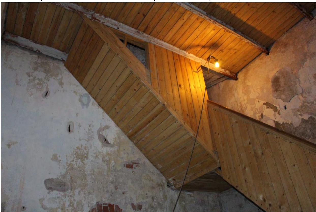
Фото 47. Внутренние помещения объекта культурного наследия регионального значения «Кирха». 2-й этаж, помещение № 8.
