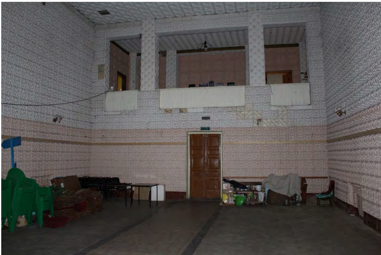
Фото 69. Внутренние помещения объекта культурного наследия регионального значения «Кирха». 1-й этаж, помещение № 10.
