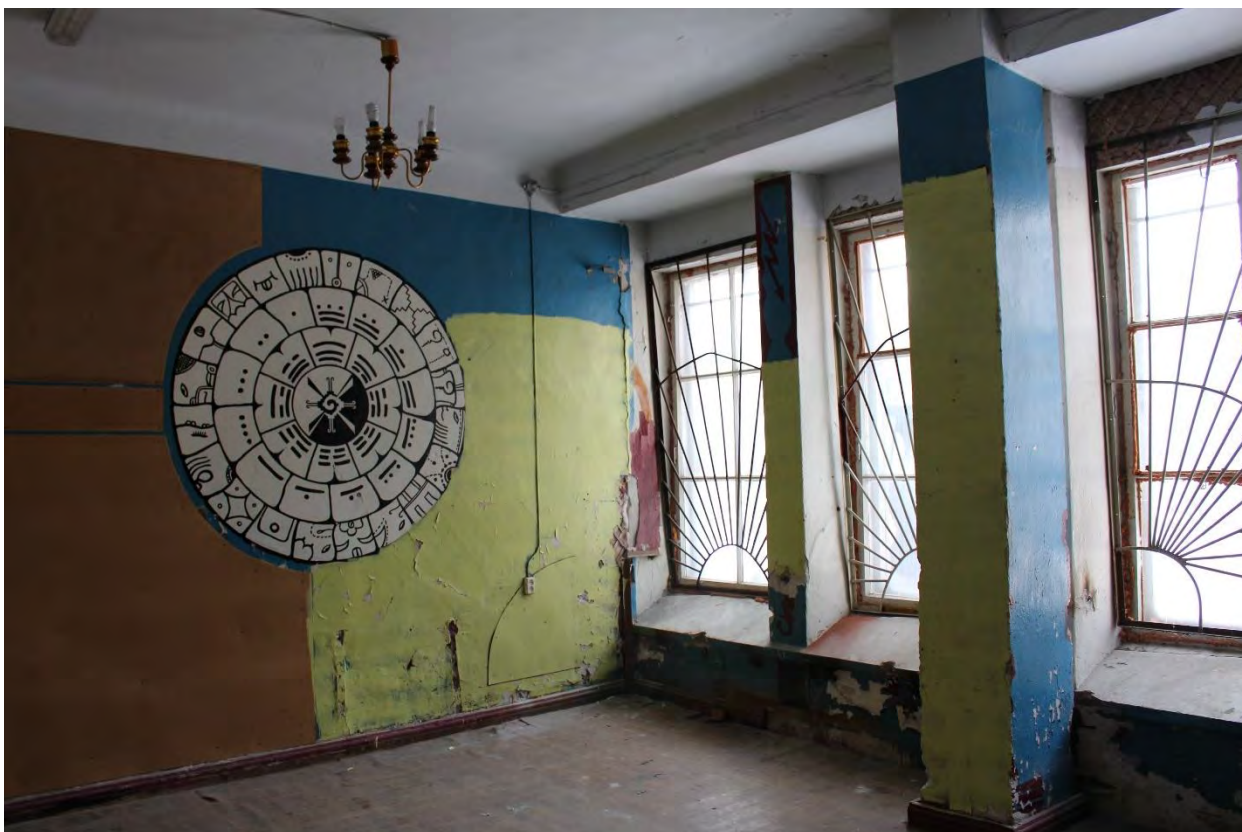
Фото 83. Внутренние помещения объекта культурного наследия регионального значения «Кирха». 2-й этаж, помещение № 11.
