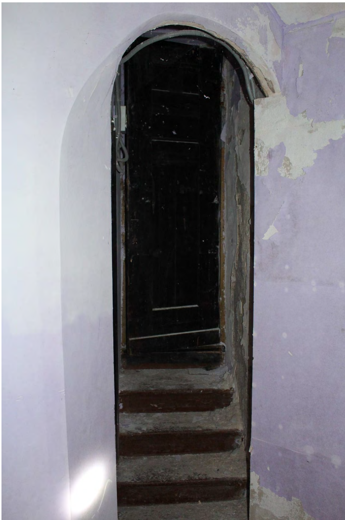
Фото 60. Внутренние помещения объекта культурного наследия регионального значения «Кирха». 1-й этаж, выход в помещение № 12.
