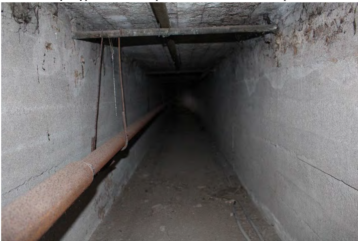
Фото 38. Подземный канал, соединяющий здание – объект культурного наследия регионального значения «Кирха» и здание бывшей котельной.
