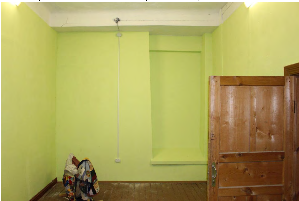
Фото 86. Внутренние помещения объекта культурного наследия регионального значения «Кирха». 2-й этаж, помещение № 10.
