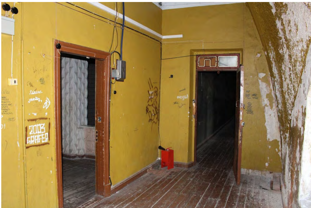
Фото 81. Внутренние помещения объекта культурного наследия регионального значения «Кирха». 2-й этаж, помещение № 12.
