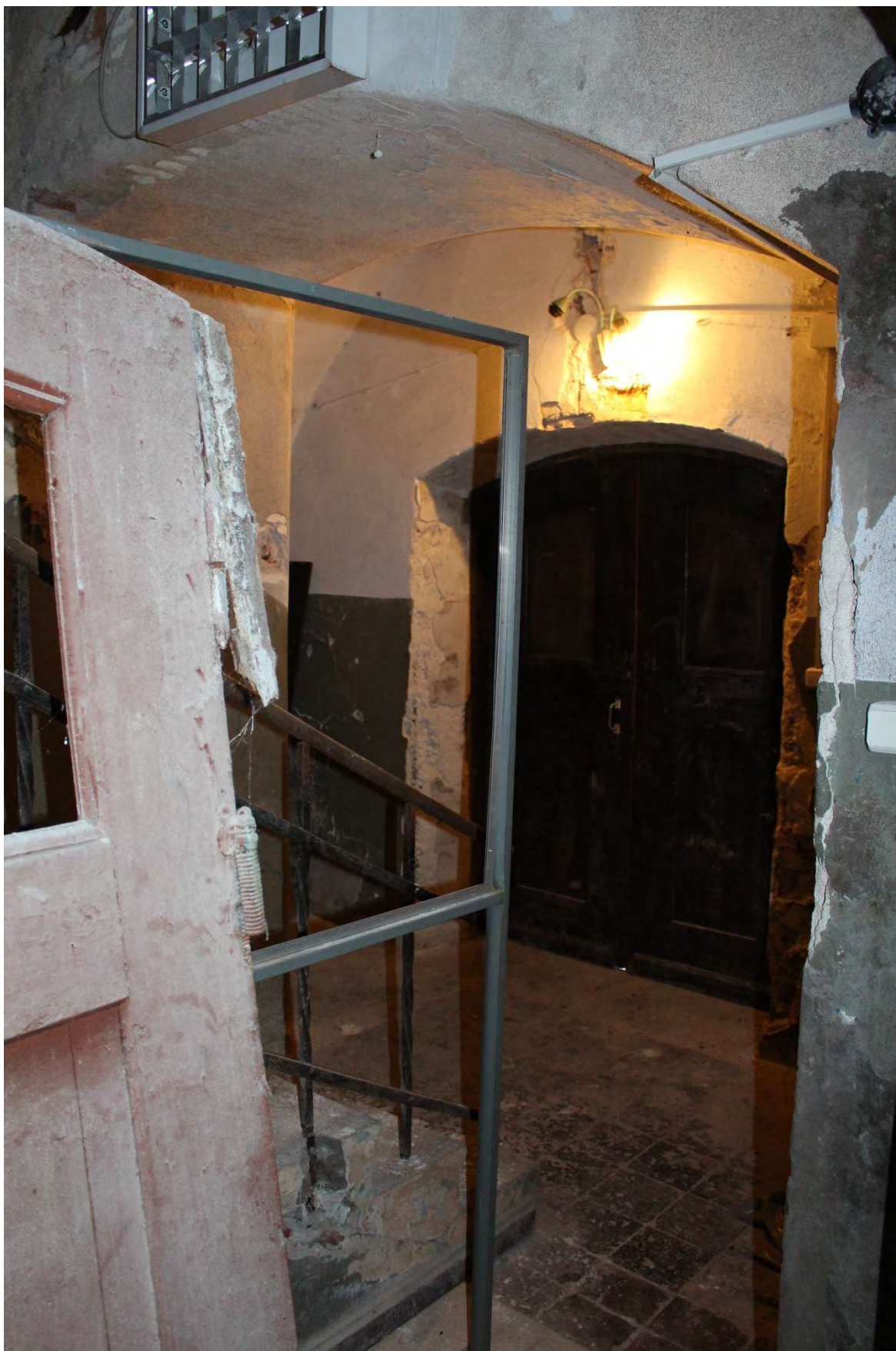
Фото 45. Внутренние помещения объекта культурного наследия регионального значения «Кирха». 1-й этаж, помещение № 15.
