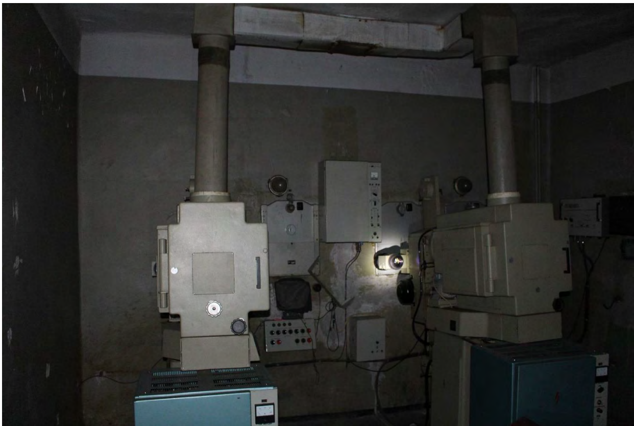
Фото 73. Внутренние помещения объекта культурного наследия регионального значения «Кирха». 2-й этаж, помещение № 15.
