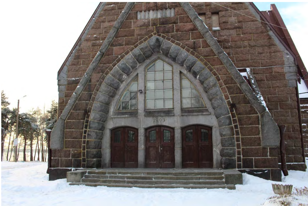
Фото 2. Вид на вход с востока в здание – объект культурного наследия регионального значения «Кирха».
