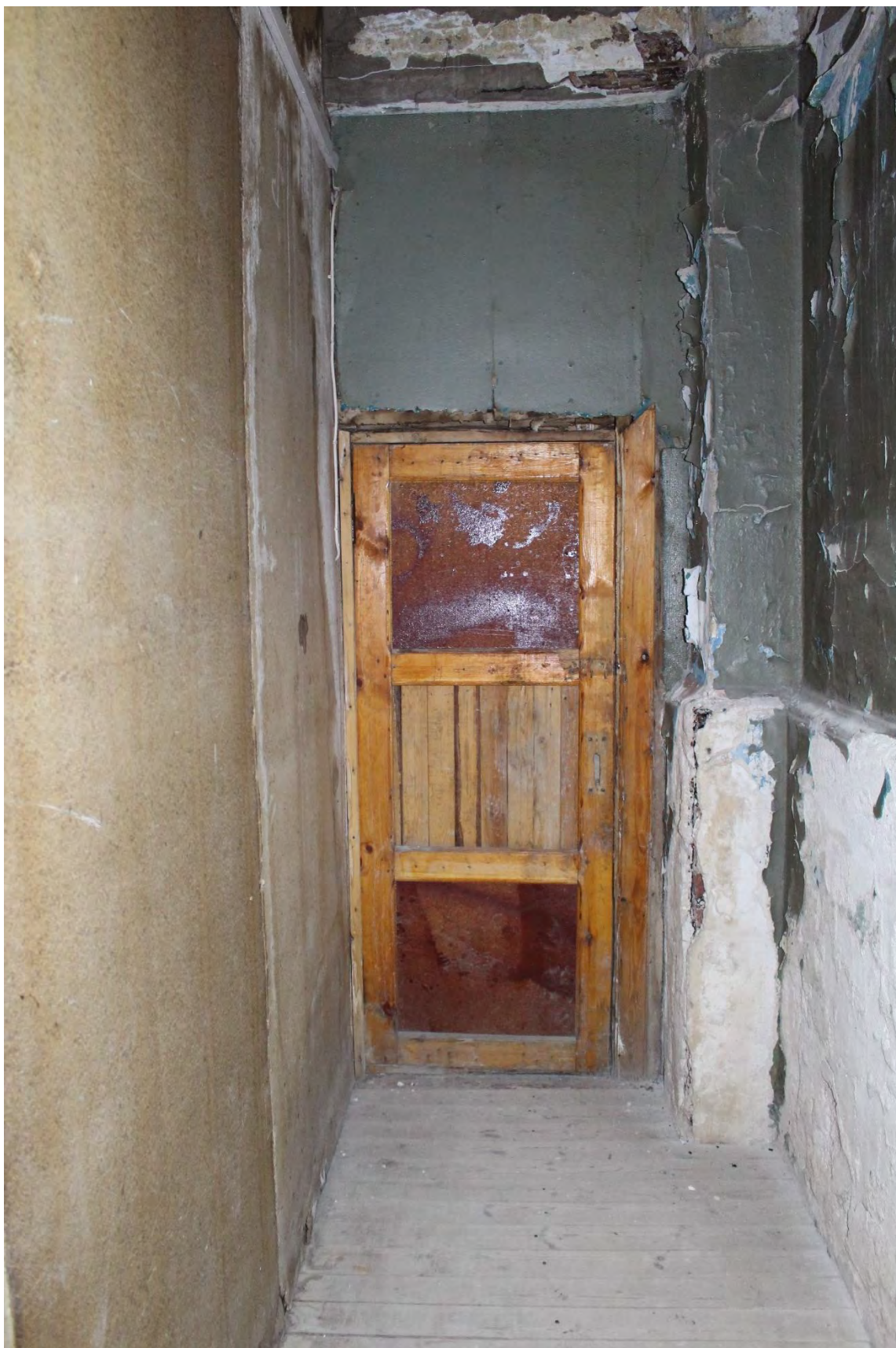
Фото 44. Внутренние помещения объекта культурного наследия регионального значения «Кирха». 1-й этаж, помещение № 16.
