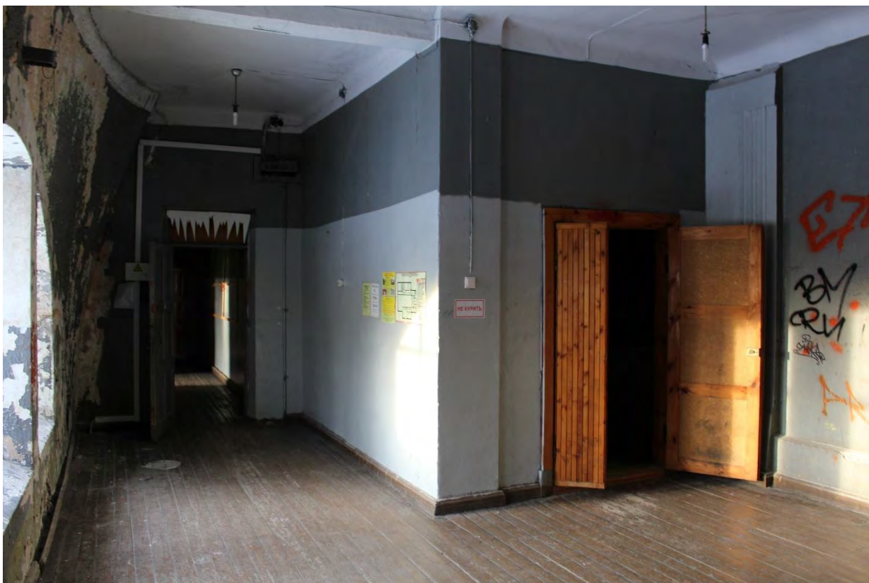
Фото 77. Внутренние помещения объекта культурного наследия регионального значения «Кирха». 2-й этаж, помещение № 1.
