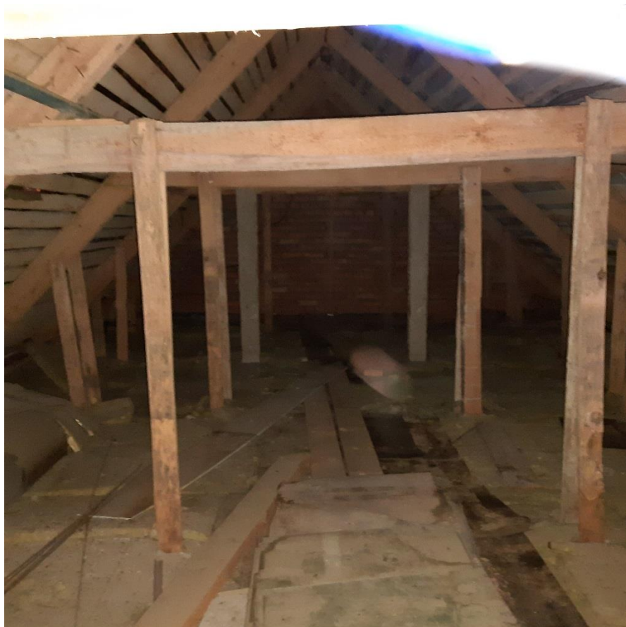
Фото 3. Чердак лицевого корпуса.
