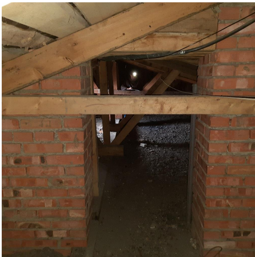
Фото 12. Чердак дворового корпуса. Вид на проем.
