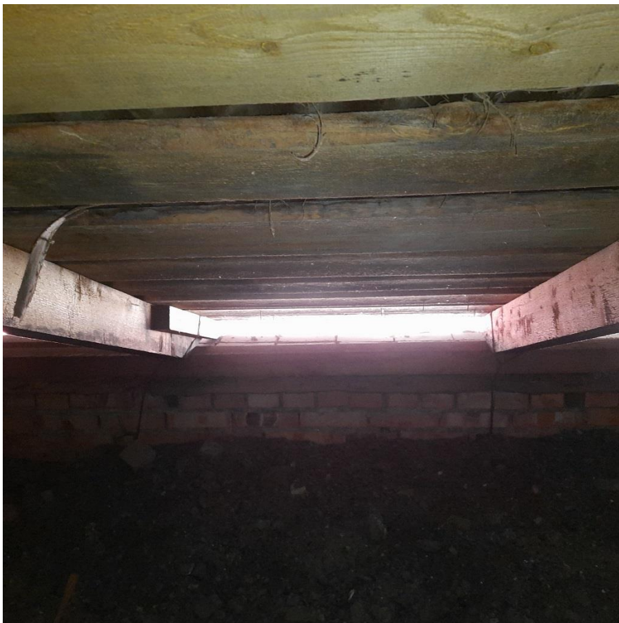
Фото 8. Чердак дворового корпуса.
