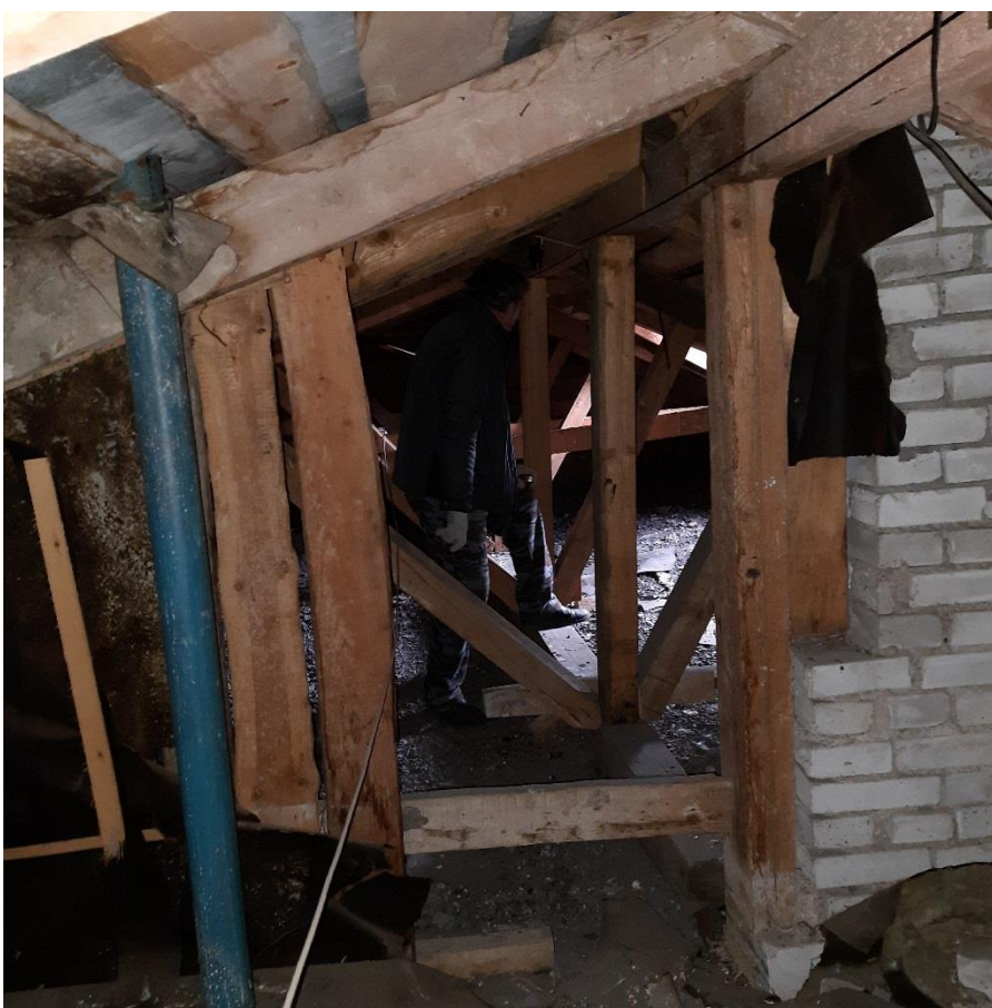
Фото 6. Чердак дворового корпуса.
