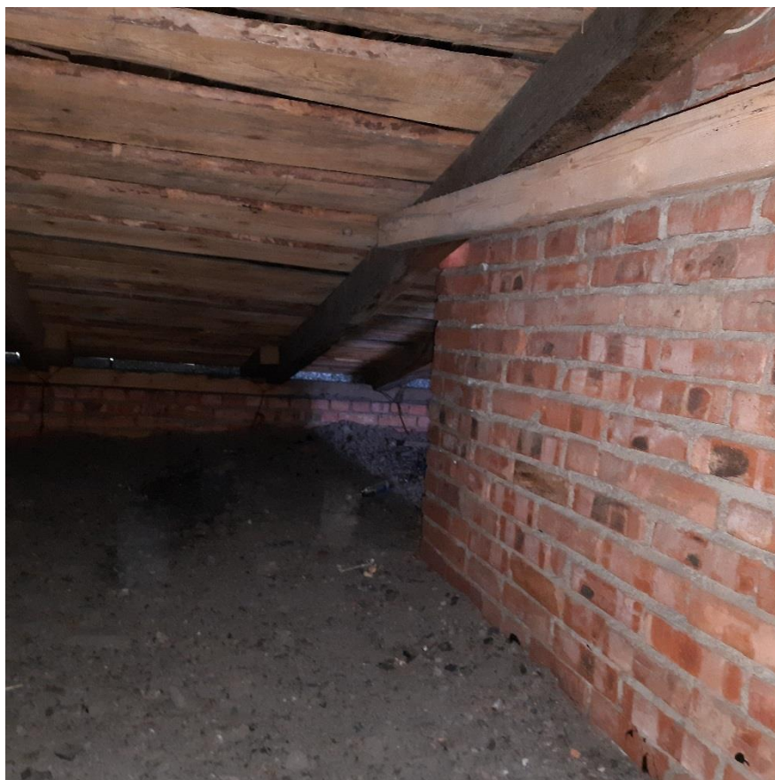
Фото 9. Чердак дворового корпуса.
