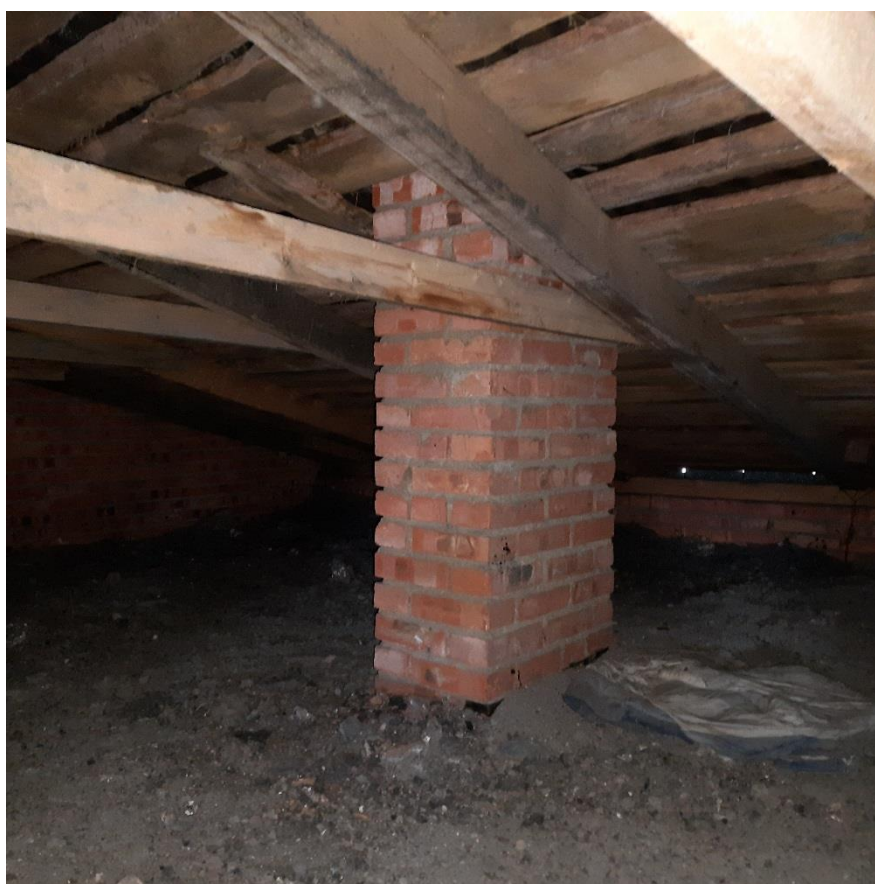
Фото 10. Чердак дворового корпуса. Вентшахта.
