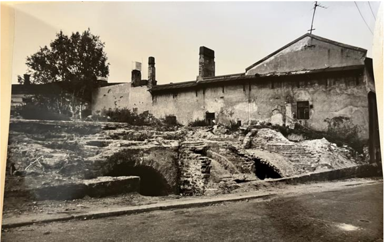
27. Общий вид над частично сохранившимися сводами подвалов.
