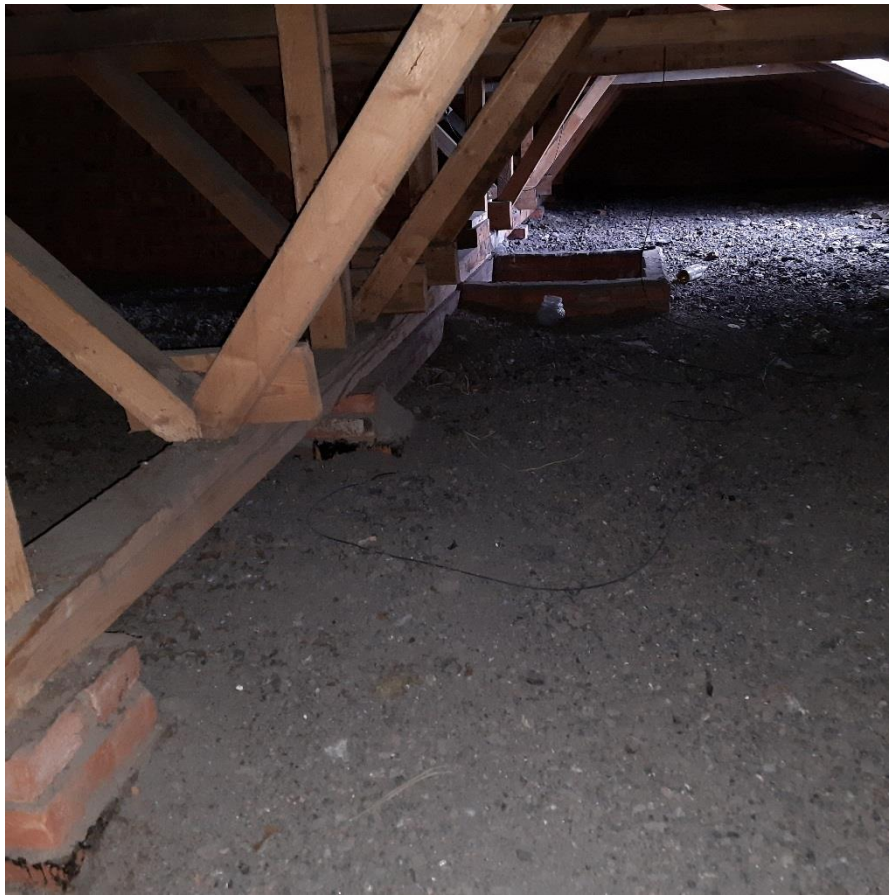
Фото 7. Чердак дворового корпуса.
