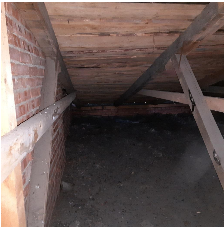
Фото 11. Чердак дворового корпуса.
