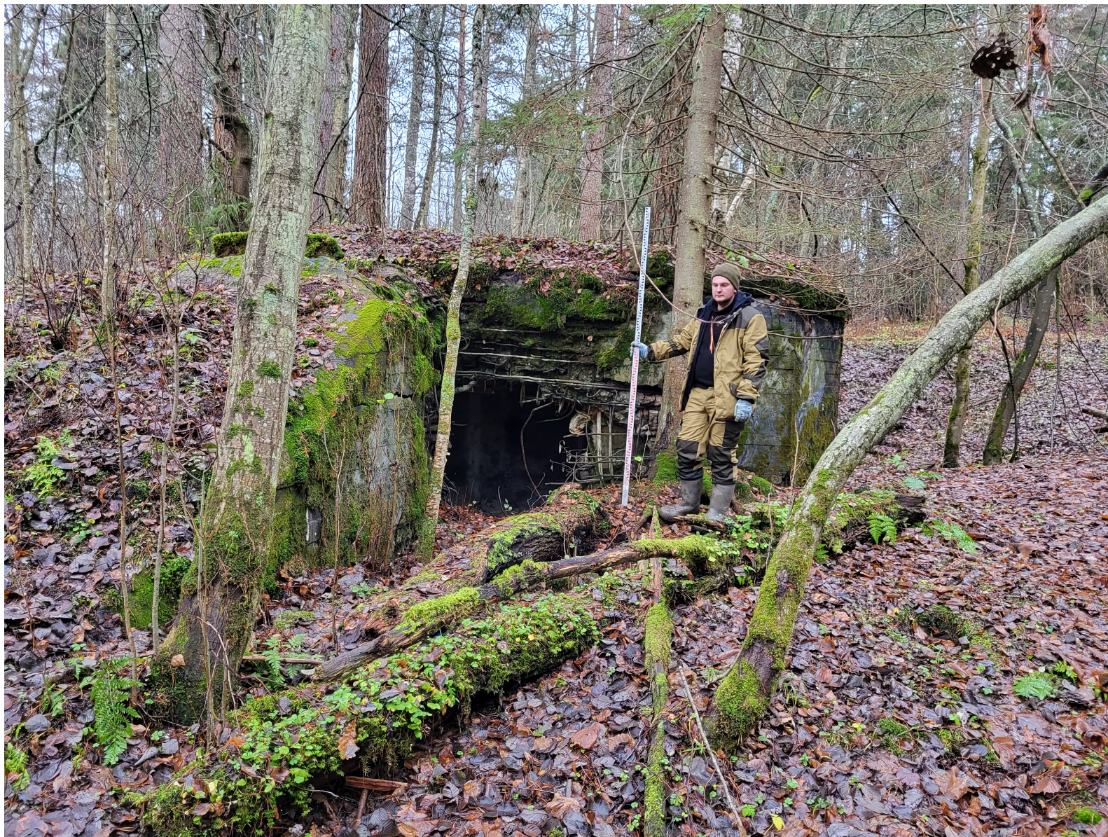
Рис. 7. «Лупинг магистрального нефтепровода «Палкино-Приморск» 700-706 км с сопутствующими сооружениями. ЛРНУ. Реконструкция». ОКН "ДОТ №2 укрепленного узла Инкиля". ТФ 1. Вид с северо-востока (2).
