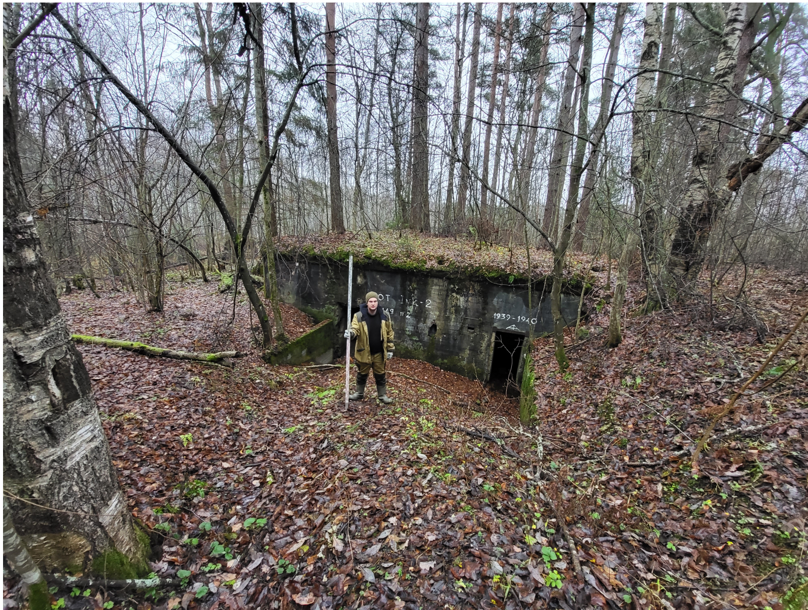
Рис. 8. «Лулинг магистрального нефтепровода «Палкино-Приморск» 700-706 км с сопутствующими сооружениями. ЛРНУ. Реконструкция». ОКН "ДОТ №2 укрепленного узла Инкиля". ТФ 2. Вид с северо-зпада(1).
