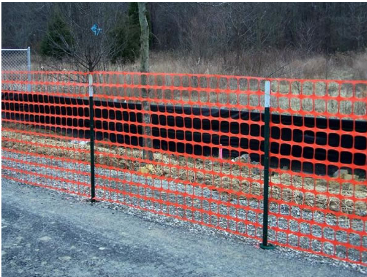
Ограждение объекта культурного наследия (пример выполнения).
