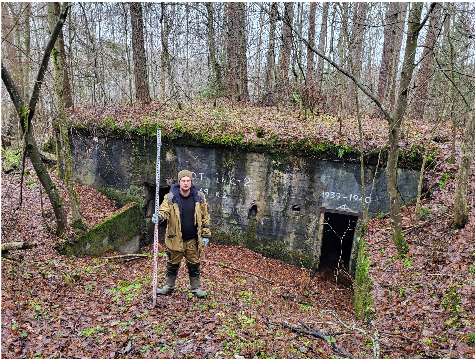
Рис. 9. «Лупинг магистрального нефтепровода «Палкино-Приморск» 700-706 км с сопутствующими сооружениями. ЛРПУ. Реконструкция». ОКН "ДОТ №2 укрепленного узла Инкиля". ТФ 2. Вид с северо-звпада(2).
