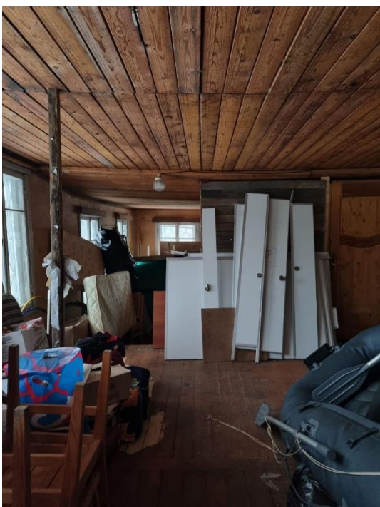
27. «Флигель для гостей», входящий в состав объекта культурного наследия федерального значения «Комплекс усадебных домов и парковых сооружений (бывший парк «Монрепо»», Ленинградская обл., Выборгский р-н, г. Выборг, парк Монрепо. 36Помещение №23. Помещение веранды. Фрагмент. Фото 01.02.2023г.
