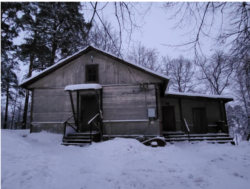
2. «Флигель для гостей», входящий в состав объекта культурного наследия федерального значения «Комплекс усадебных домов и парковых сооружений (бывший парк «Монрепо»», Ленинградская обл., Выборгский р-н, г. Выборг, парк Монрепо. Юго-западный фасад. Общий вид. Фото 01.02.2023г.
