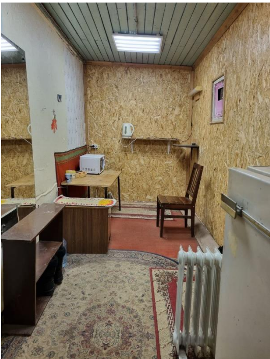
22. «Флигель для гостей», входящий в состав объекта культурного наследия федерального значения «Комплекс усадебных домов и парковых сооружений (бывший парк «Монрепо»», Ленинградская обл., Выборгский р-н, г. Выборг, парк Монрепо. 31 Помещение №9. Подсобное помещение. Общий вид. Фото 01.02.2023г.
