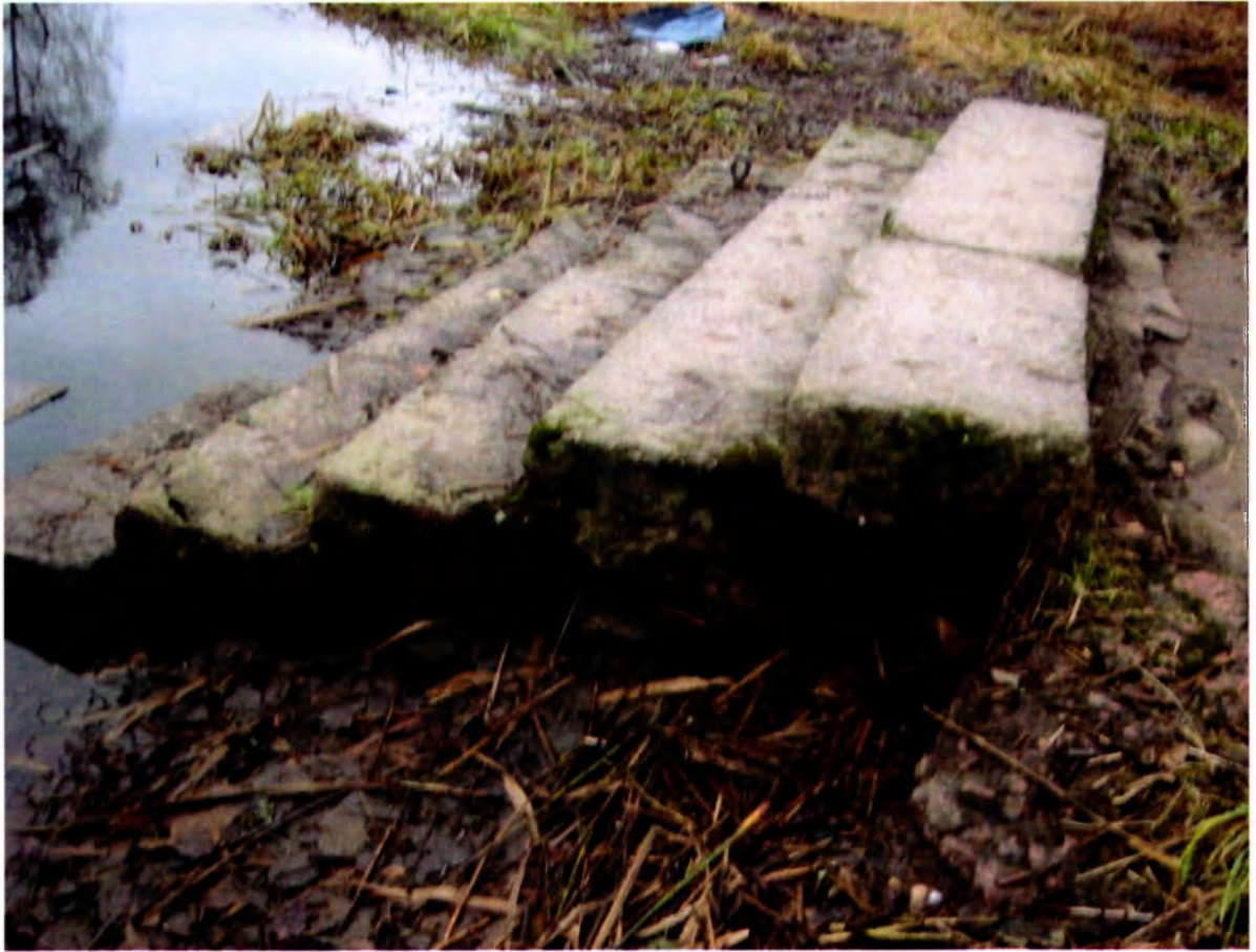
Паромная переправа. Причал на основном острове.
