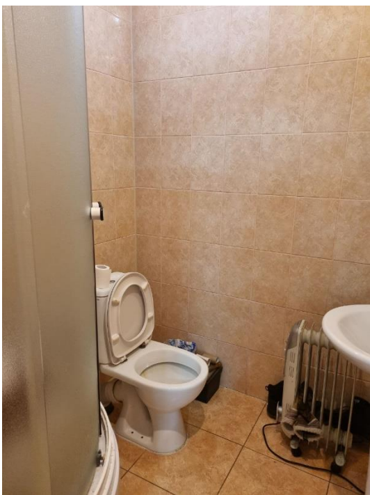
19. «Флигель для гостей», входящий в состав объекта культурного наследия федерального значения «Комплекс усадебных домов и парковых сооружений (бывший парк «Монрепо»», Ленинградская обл., Выборгский р-н, г. Выборг, парк Монрепо. 28 Помещение №5. Совмещенный санузел. Общий вид. Фото 01.02.2023г.
