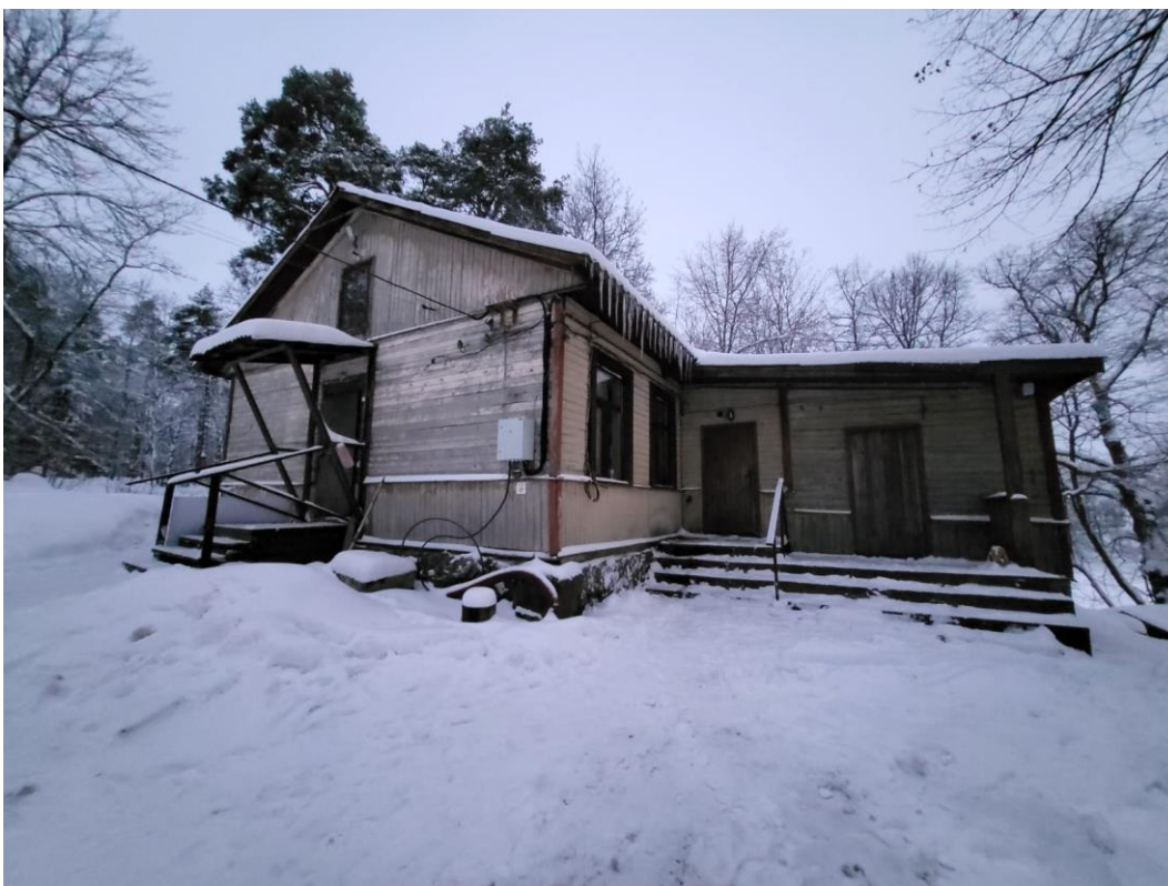
3. «Флигель для гостей», входящий в состав объекта культурного наследия федерального значения «Комплекс усадебных домов и парковых сооружений (бывший парк «Монрепо»», Ленинградская обл., Выборгский р-н, г. Выборг, парк Монрепо. Юго-западный фасад. Общий вид. Фото 01.02.2023г.
