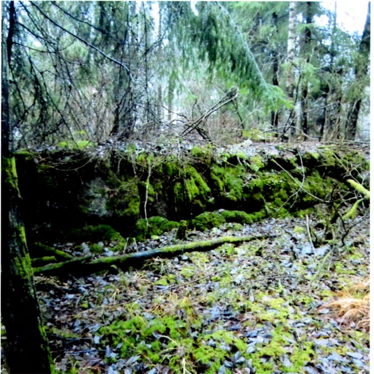
Дом жилой (фундамент).
