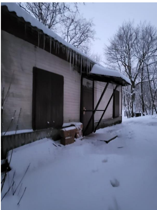
9. «Флигель для гостей», входящий в состав объекта культурного наследия федерального значения «Комплекс усадебных домов и парковых сооружений (бывший парк «Монрепо»», Ленинградская обл., Выборгский р-н, г. Выборг, парк Монрепо. Северо-западный фасад. Фрагмент. Фото 01.02.2023г.
