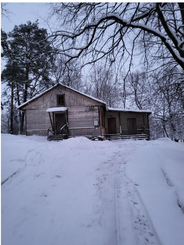
1. «Флигель для гостей», входящий в состав объекта культурного наследия федерального значения «Комплекс усадебных домов и парковых сооружений (бывший парк «Монрепо»», Ленинградская обл., Выборгский р-н, г. Выборг, парк Монрепо. Юго-западный фасад. Общий вид. Фото 01.02.2023г.
