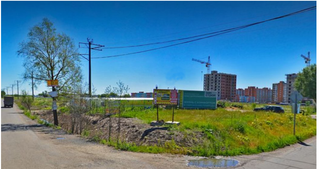
Рис. 13. ЛО-2022. Гатчинский район, г. Коммунар. Общий вид участка обследования со стороны ж/д. Территория строительной площадки. Панорама Yandex 2022 г.
