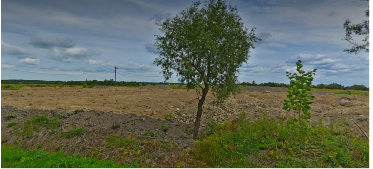
Рис. 12. ЛО-2022. Гатчинский район, г. Коммунар. Общий вид участка обследования со стороны ж/д. Территория строительной площадки. Панорама Yandex 2019 г.
