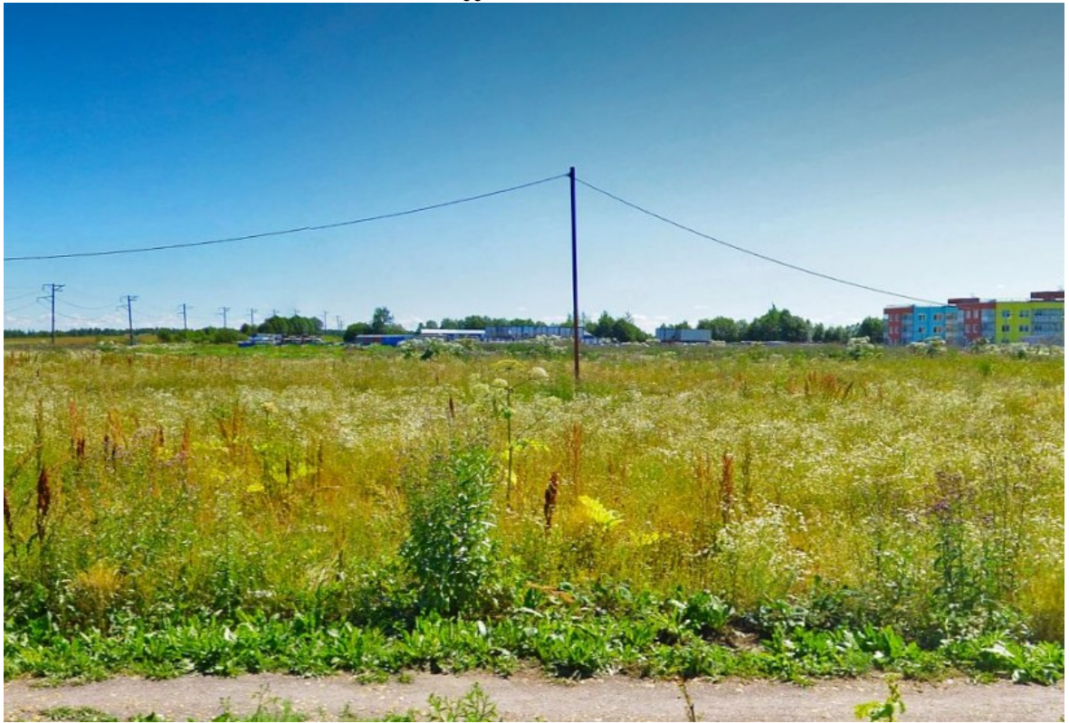
Рис. 16. ЛО-2022. Гатчинский район, г. Коммунар. Общий вид участка обследования со стороны ж/д. Территория строительной площадки. Панорама Yandex 2022 г.
