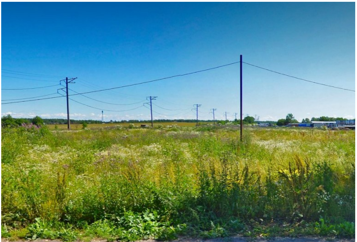
Рис. 15. ЛО-2022. Гатчинский район, г. Коммунар. Общий вид участка обследования со стороны ж/д. Территория строительной площадки. Панорама Yandex 2022 г.
