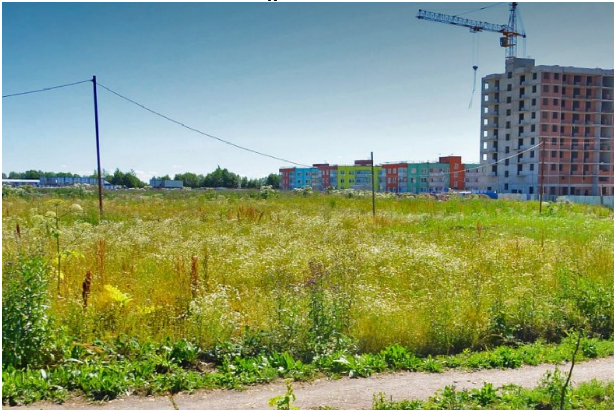
Рис. 14. ЛО-2022. Гатчинский район, г. Коммунар. Общий вид участка обследования со стороны ж/д. Территория строительной площадки. Панорама Yandex 2022 г.
