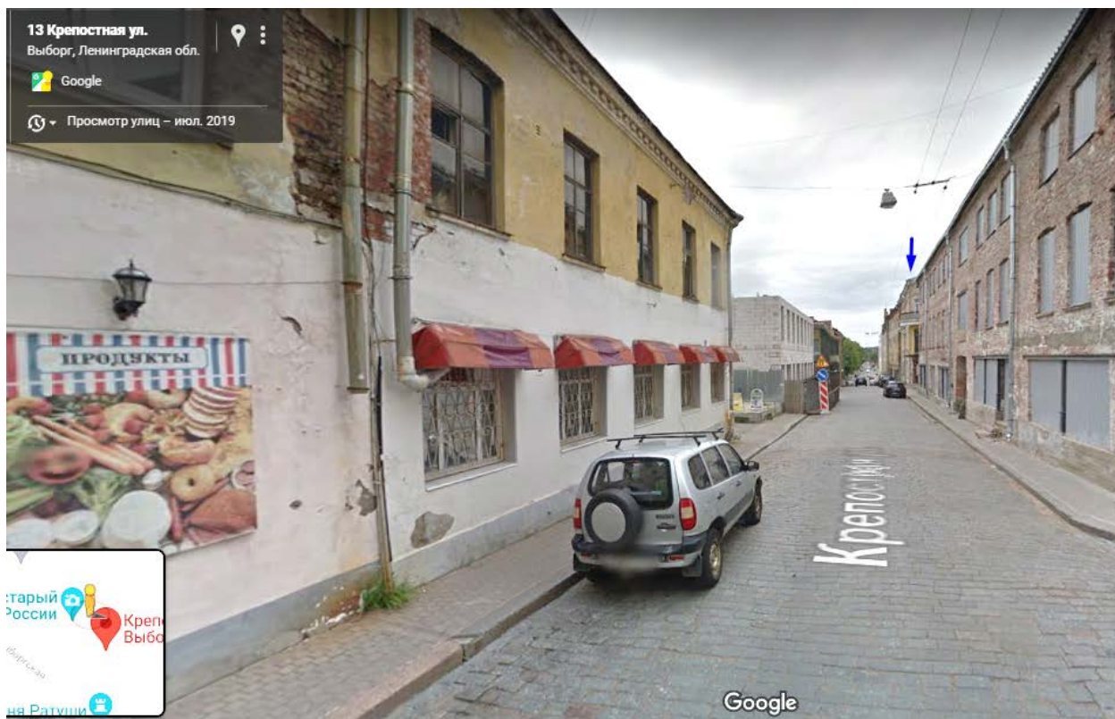
53. Перспектива Крепостной улицы. Вид на исследуемое здание (отмечено стрелкой) с северо-запада. Панорамы Google, 2019 г.
