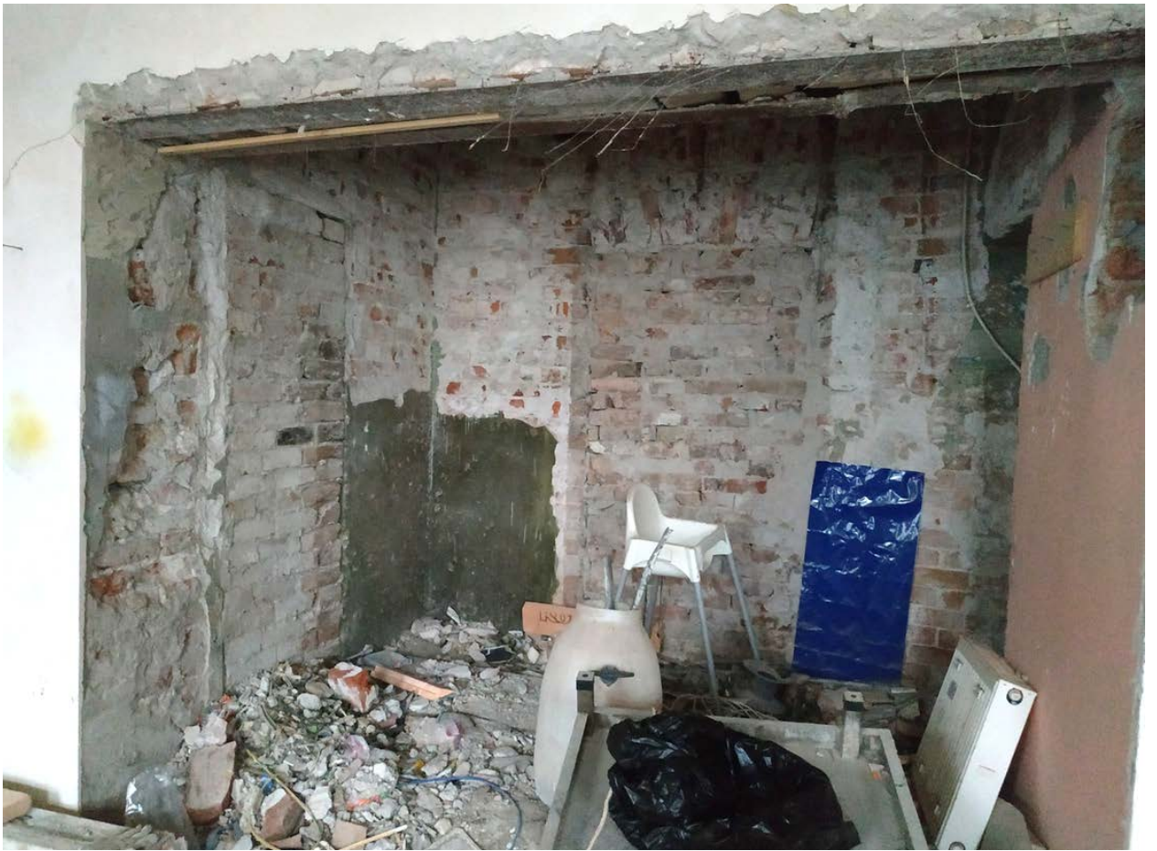
37. Объект культурного наследия регионального значения «Дом А. В. Шушина (Кихльгрена)». 2 этаж, вид в сторону дворового ризалита. В кадре слева и по центру видны заложенные проёмы.
