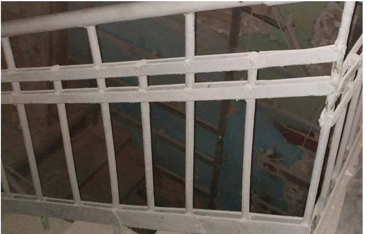
40. Объект культурного наследия регионального значения «Дом А. В. Шушина (Кихлырена)». 2 этаж, лестница, установленная в 1950-е-1960-е гг. Сварное ограждение.
