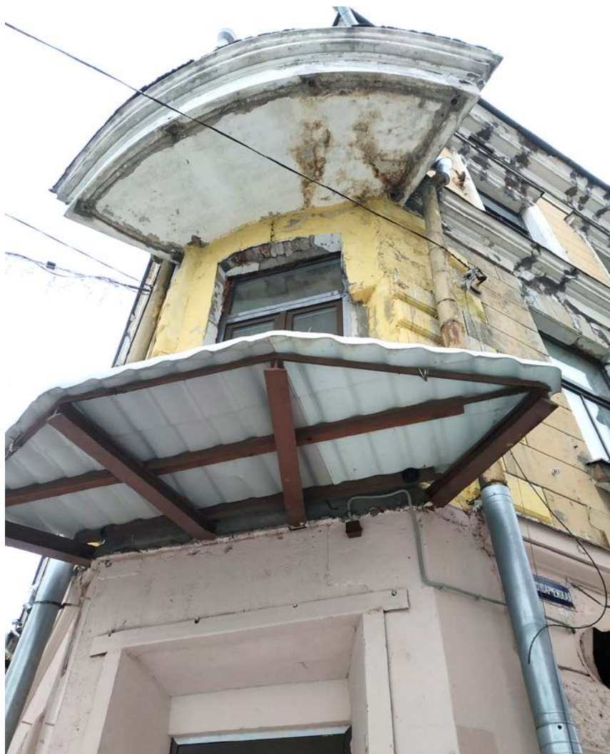
8. Объект культурного наследия регионального значения «Дом А. В. Шушина (Кихльгрена)». Угловой фасад. Балкон 2 этажа утрачен, на его месте смонтирован козырёк.
