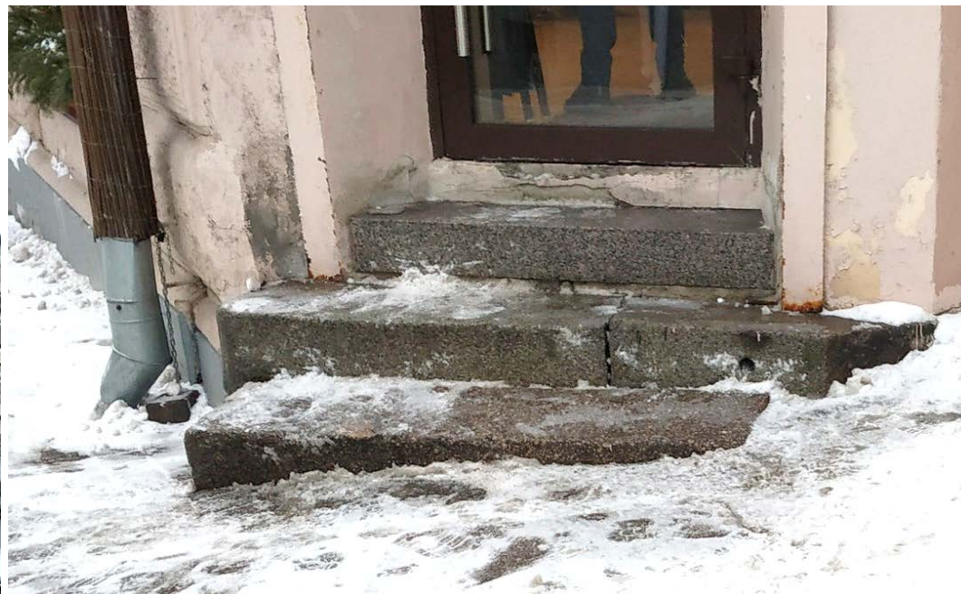
9. Объект культурного наследия регионального значения «Дом А. В. Шушина (Кихльгрена)». Угловой фасад. Историческое гранитное крыльцо.
