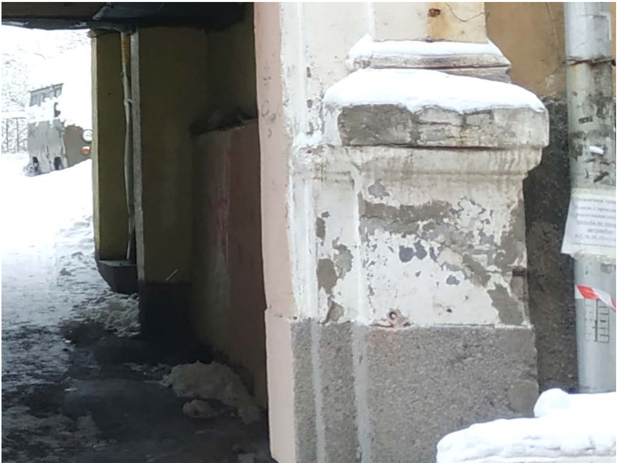
20. Объект культурного наследия регионального значения «Дом А. В. Шушина (Кихльгрена)». Фасад по Красноармейской ул., основание въездной арки. Наблюдаются сколы на базе пилястры, дугообразная трещина, утраты окрасочного и штукатурного слоя.
