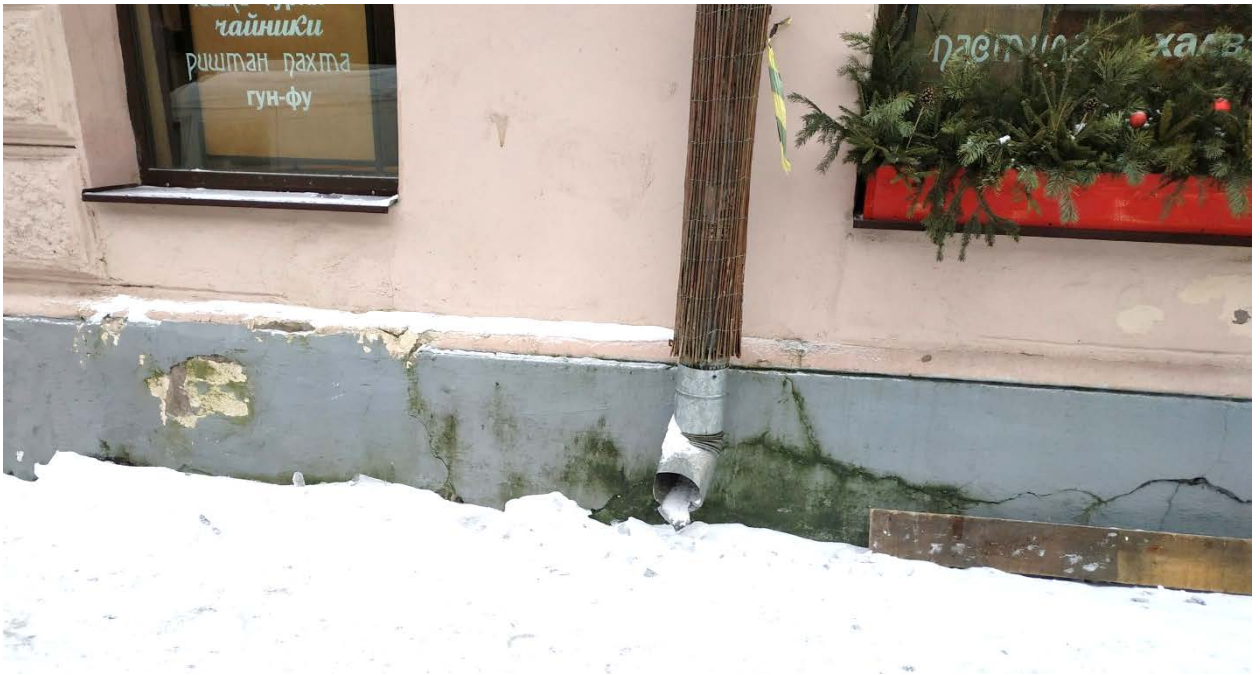
5. Объект культурного наследия регионального значения «Дом А. В. Шушина (Кихльгрена)». Центральная часть фасада по Крепостной ул. Трещины и биопоражения на цоколе, утраты штукатурного покрытия.
