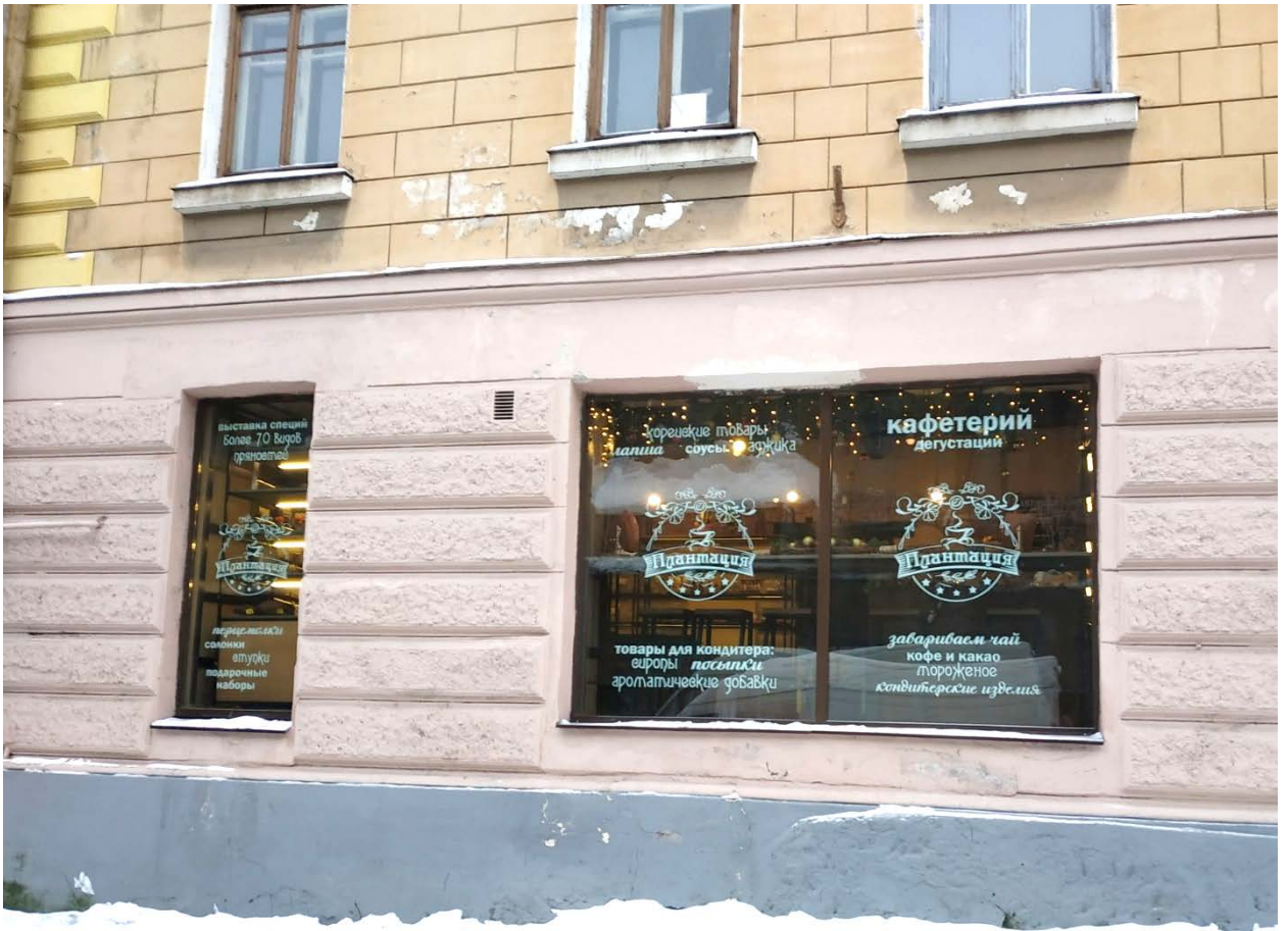
3. Объект культурного наследия регионального значения «Дом А. В. Шушина (Кихльгрена)». Южная часть фасада по Крепостной ул. в уровне 1 этажа.
