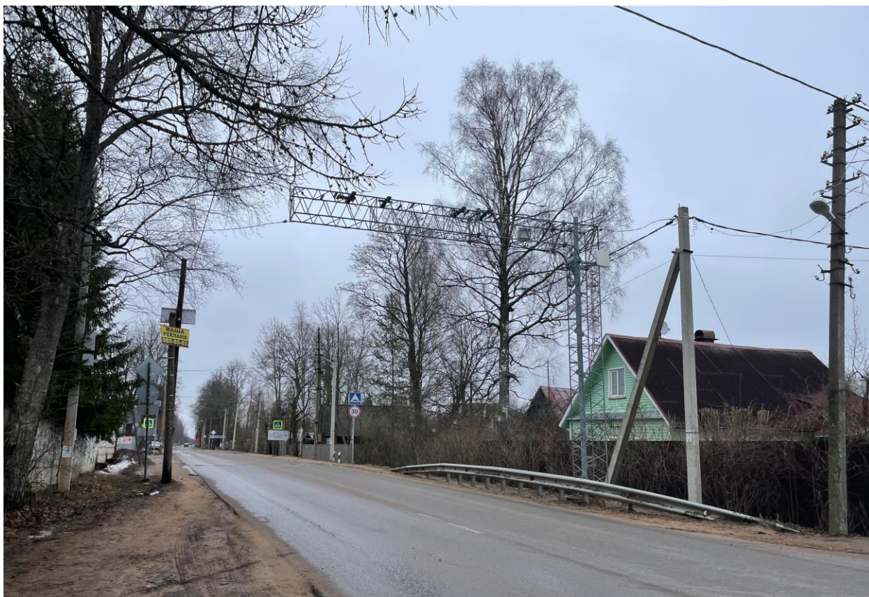
Фото 6. Вид на объект культурного наследия от перекрестка дороги с проездом (южная часть квартала).
