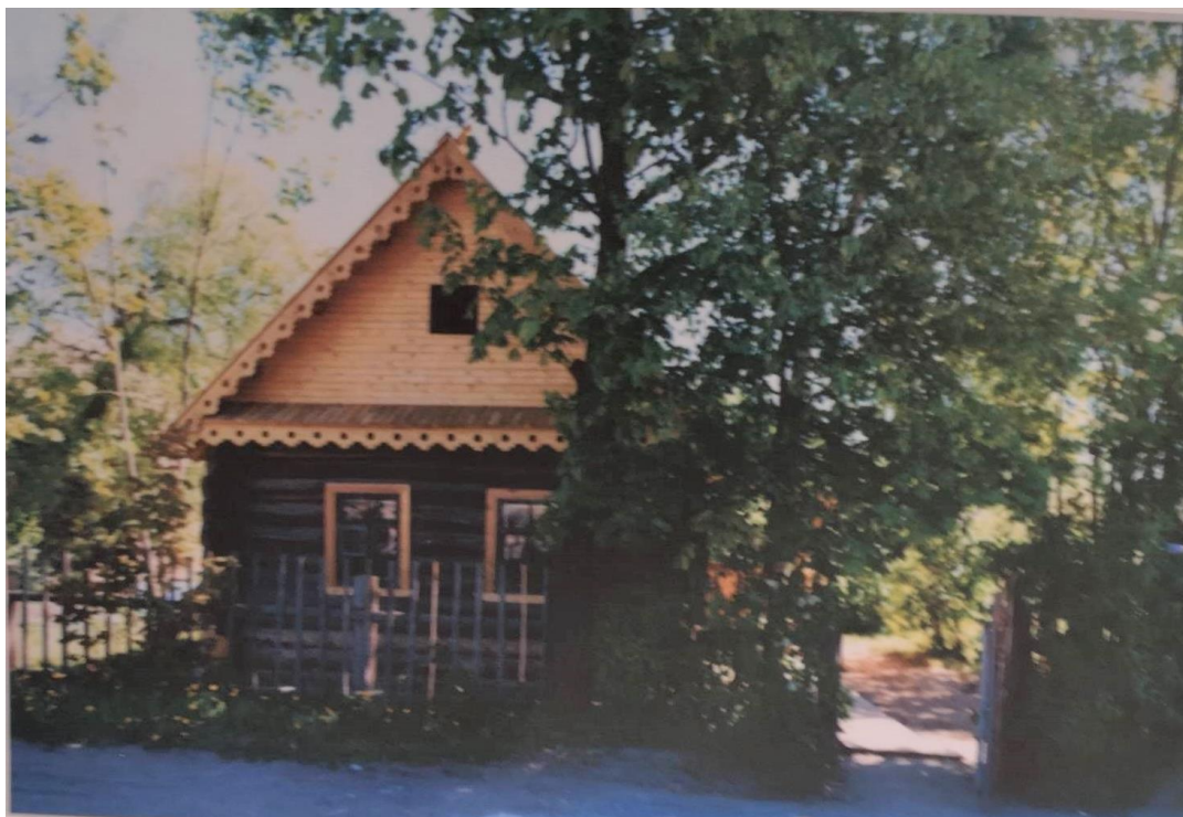
Илл. 37. Деревня Кобрино, дом 27. ОКН «Дом, где бывала няня А.С. Пушкина - Арина Родионовна». Фото 2002 г.// Фотофиксация в процессе авторского надзора. ГП СПбНИИНИ "СПР". 2002 г. (Проект ремонта и консервации дома НИИ СПР. 1999 г.). Архив комитета по сохранению культурного наследия Ленинградской области. №п/п 8165. № дела 461-13.
