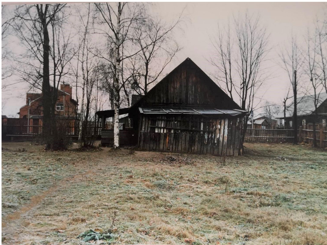
Илл. 36. Деревня Кобрино, дом 27. ОКН «Дом, где бывала няня А.С. Пушкина - Арина Родионовна». Фото 2001 г.// Фотофиксация в процессе авторского надзора. ГП СПбНИИНИ "СПР". 2002 г. (Проект ремонта и консервации дома НИИ СПР. 1999 г.). Архив комитета по сохранению культурного наследия Ленинградской области. №п/п 8165. № дела 461-13.
