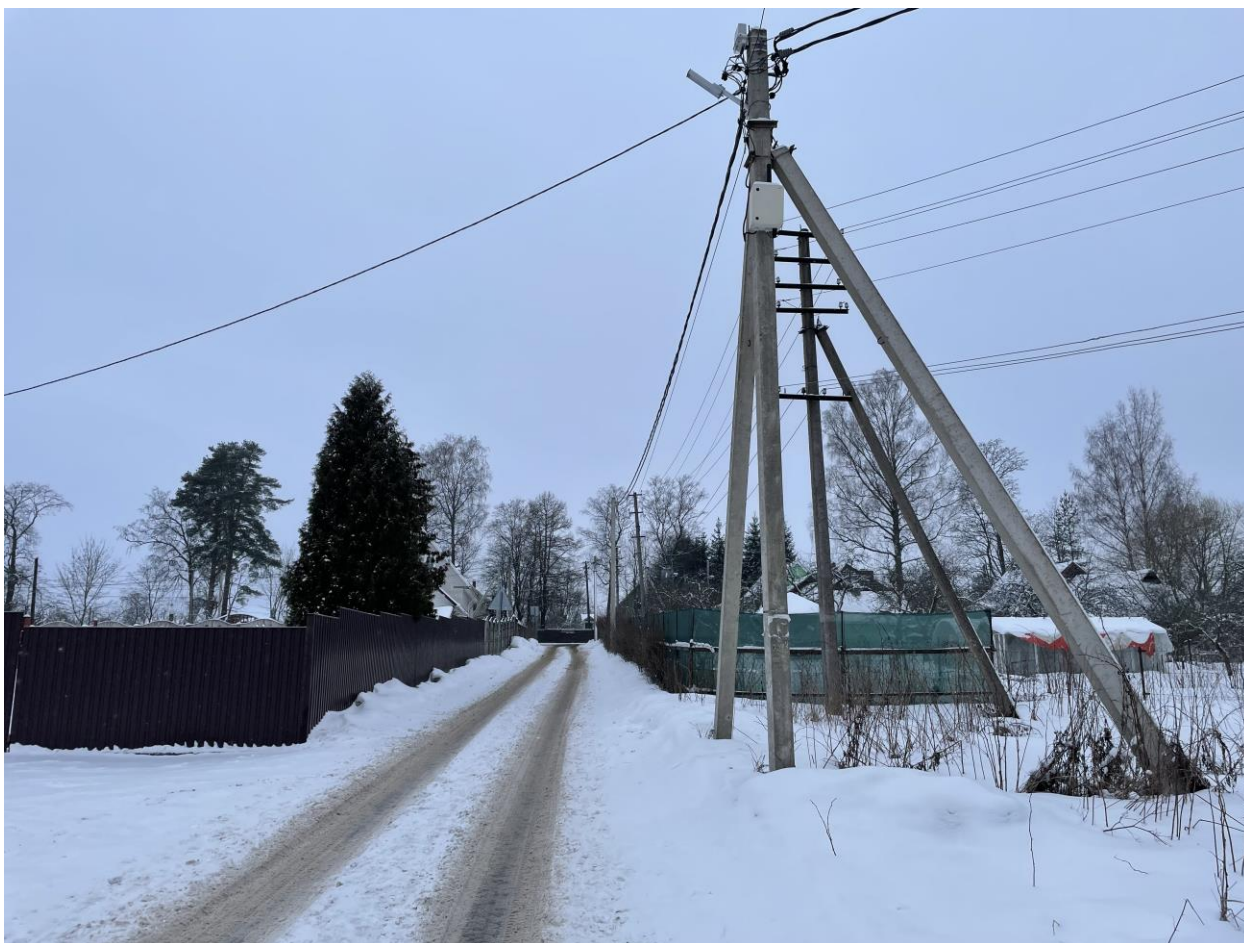
Фото 8. Вид на застройку деревни Кобріно у дома 27 с юго-востока.
