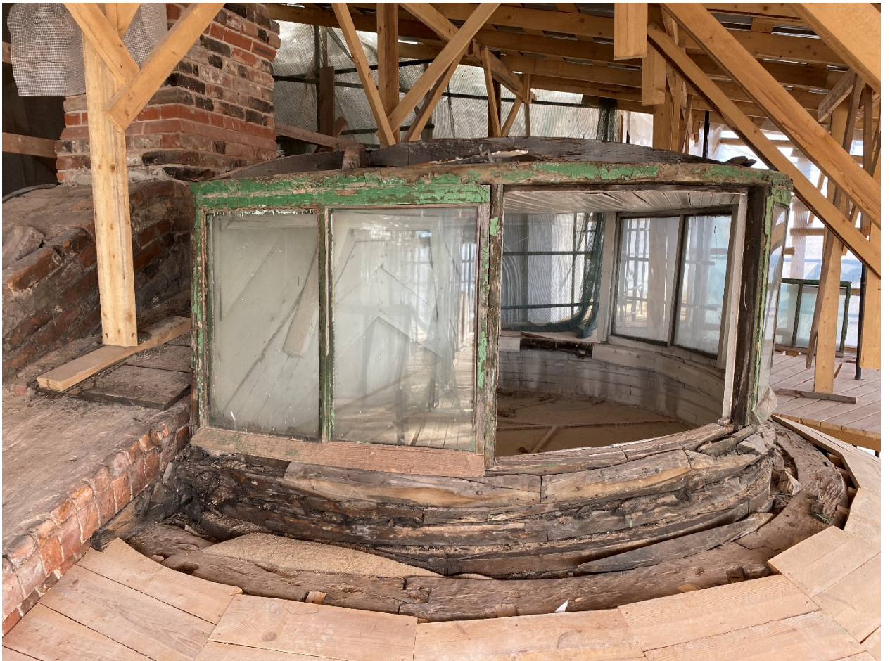
Фото 44. Заполнения провета конхи апсиды.
