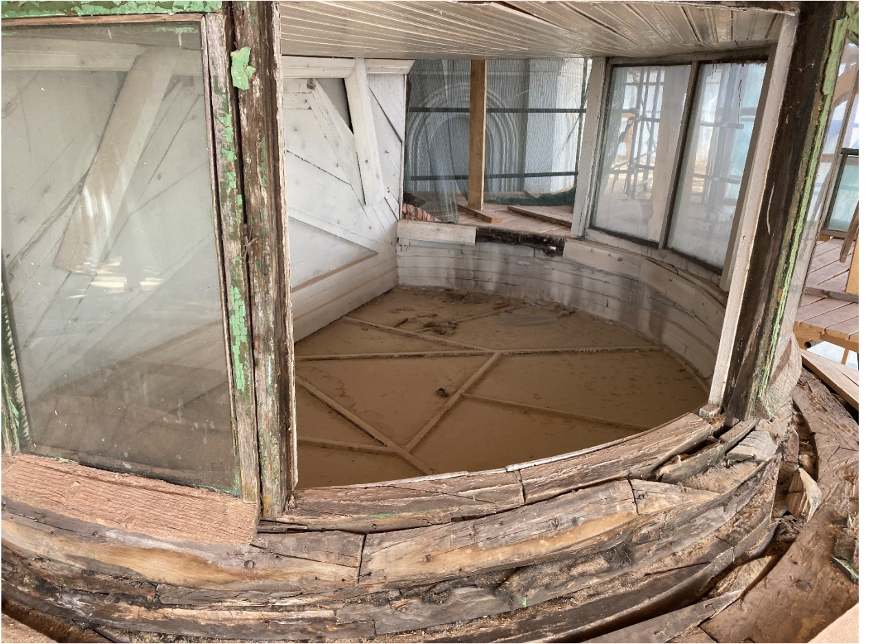
Фото 45. Заполнения провета конхи апсиды.
