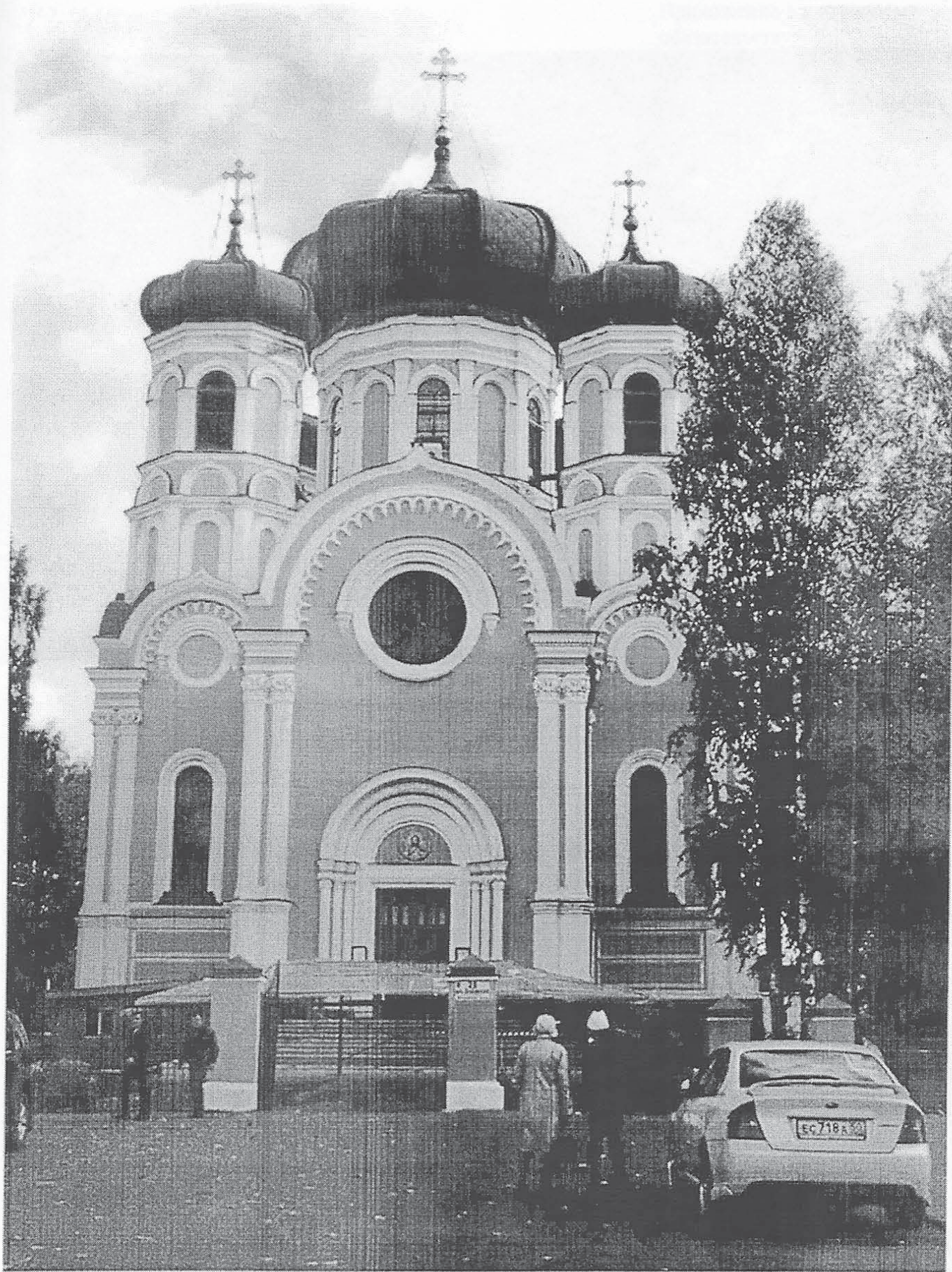
Общий вид. Западный фасад.
