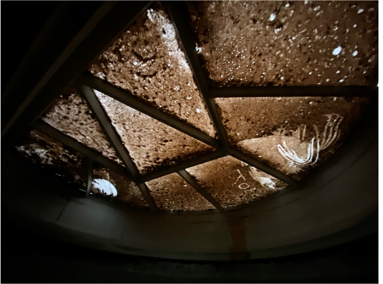
Фото 46. Заполнения просвета конхи апсиды.
