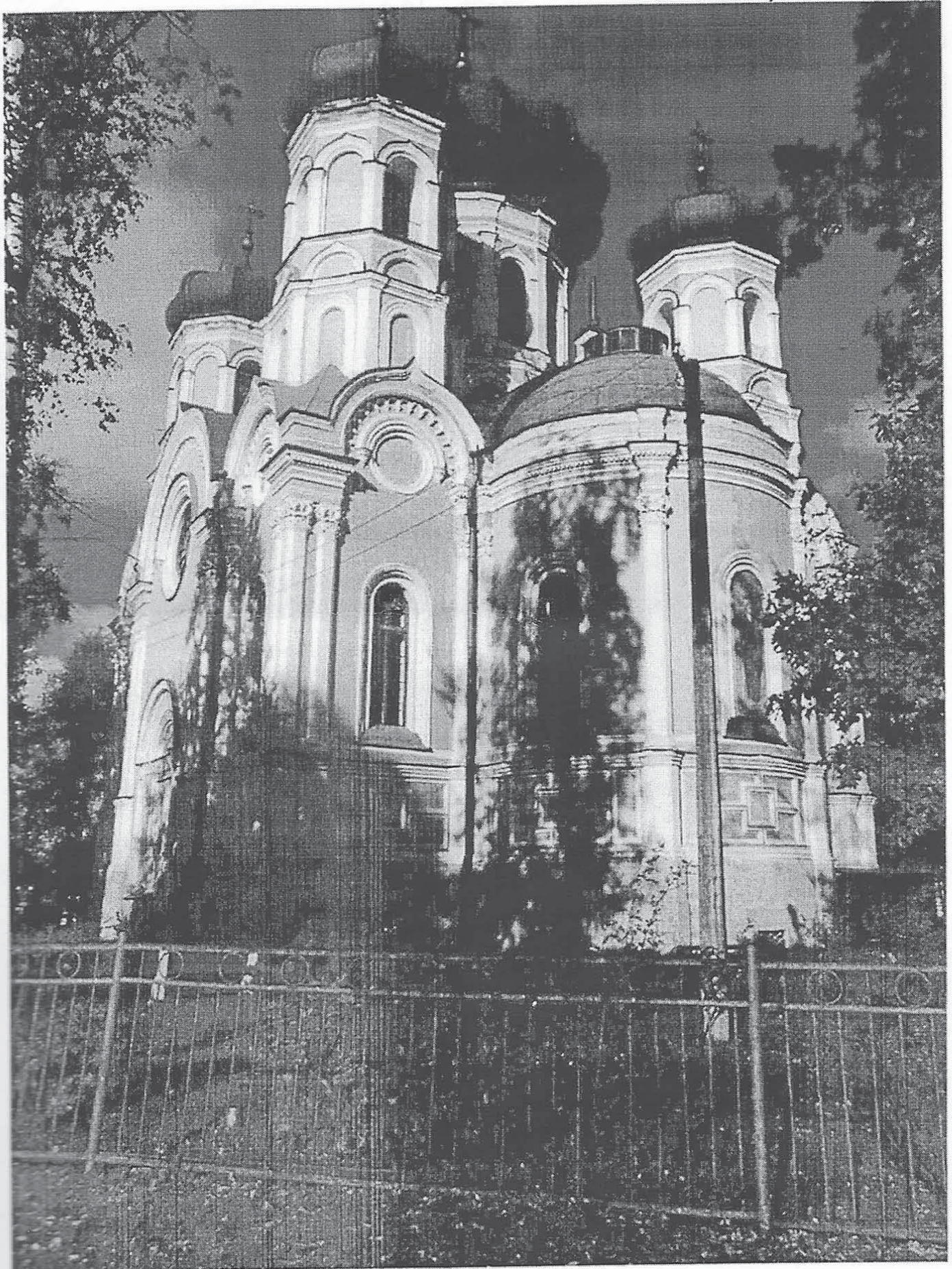
Общий вид. Восточный фасад.
