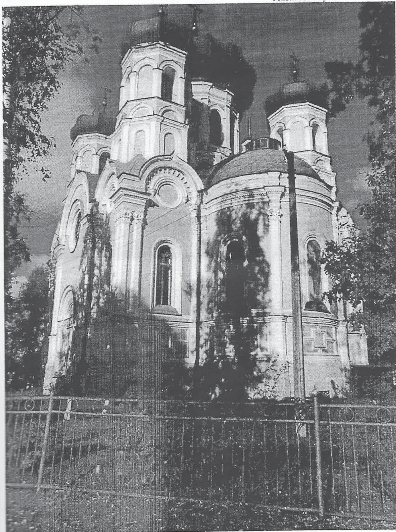
Общий вид. Восточный фасад.
