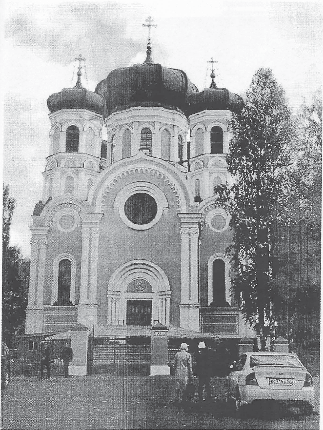
Общий вид. Западный фасад.
