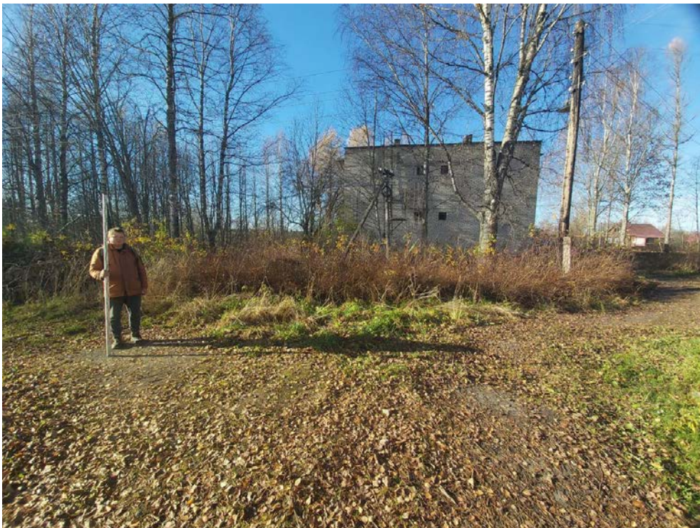
Рис. 110. Межпоселковый газопровод от ГРС Овино – д. Овино – д. Чемихино – д. Сугорово – д. Свирь с отводом на д. Устье и д. Новая Ленинградская область. Общий вид участка обследования. Точка съемки 30. Вид с В.
