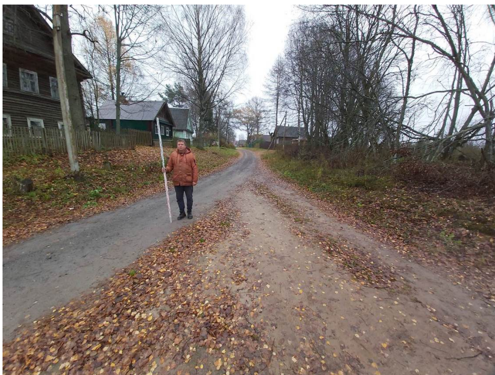
Рис. 22. Межпоселковый газопровод от ГРС Овино – д. Овино – д. Чемихино – д. Сугорово – д. Свирь с отводом на д. Устье и д. Новая Ленинградская область. Общий вид участка обследования. Точка съемки 3. Вид с ЮВ.
