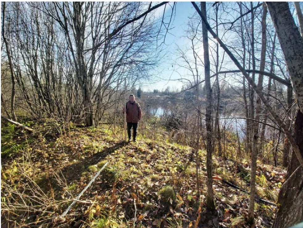
Рис. 114. Межпоселковый газопровод от ГРС Овино – д. Овино – д. Чемихино – д. Сугорово – д. Свирь с отводом на д. Устье и д. Новая Ленинградская область. Общий вид участка обследования. Точка съемки 32. Вид с ССЗ.
