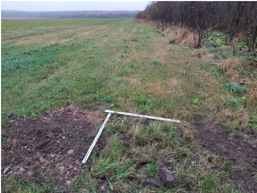
Рис. 41. Межпоселковый газопровод от ГРС Овино – д. Овино – д. Чемихино – д. Сугорово – д. Свирь с отводом на д. Устье и д. Новая Ленинградская область. Шурф 3. Засыпка. Вид с СВ.
