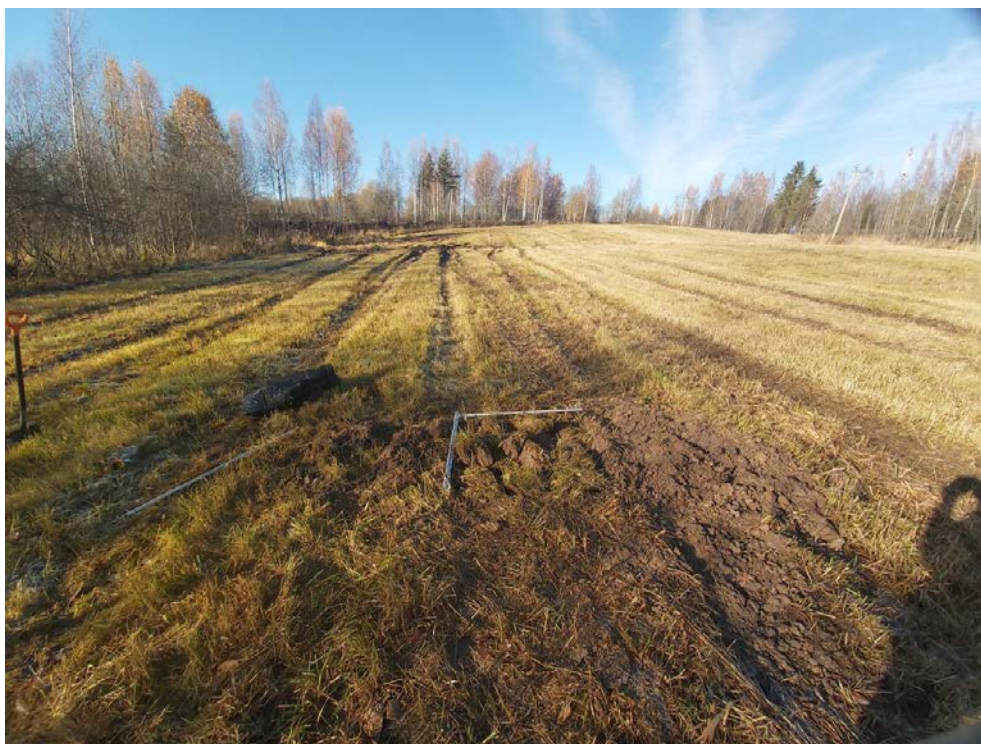
Рис. 99. Межпоселковый газопровод от ГРС Овино – д. Овино – д. Чемихино – д. Сугорово – д. Свирь с отводом на д. Устье и д. Новая Ленинградская область. Шурф 10. Засыпка. Вид с В.
