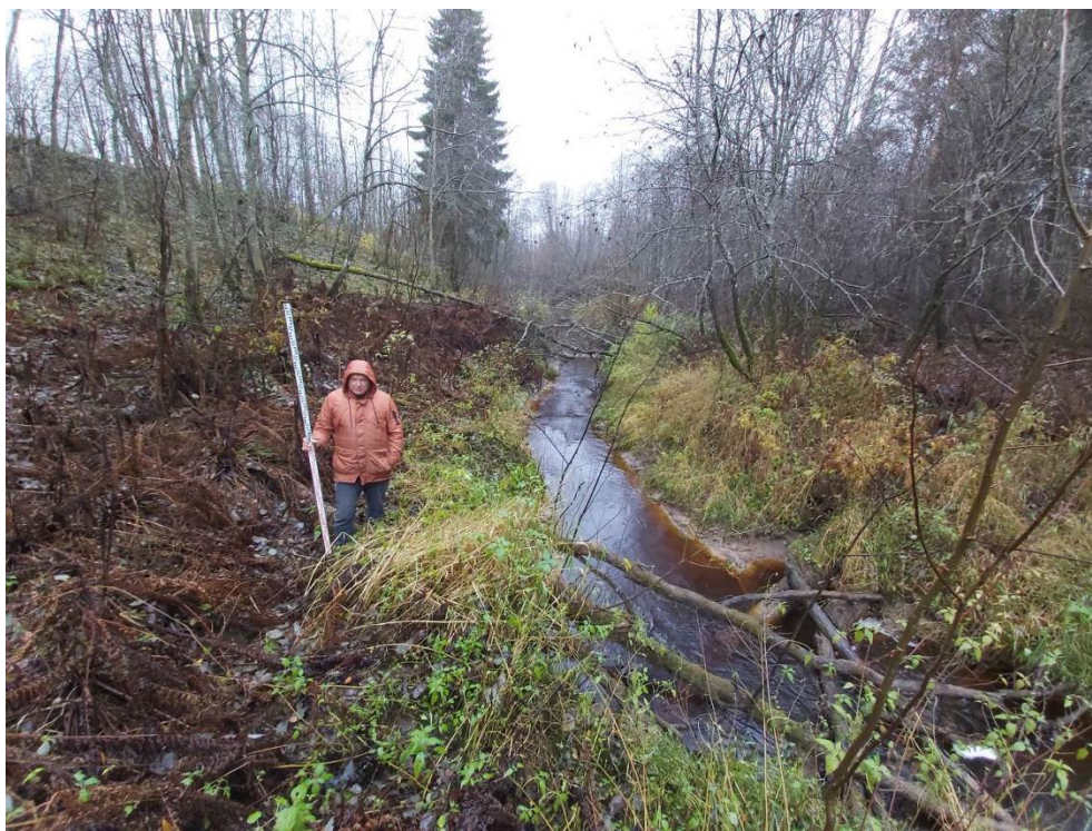
Рис. 27. Межпоселковый газопровод от ГРС Овино – д. Овино – д. Чемихино – д. Сугорово – д. Свирь с отводом на д. Устье и д. Новая Ленинградская область. Общий вид участка обследования. Точка съемки 6. Вид с ЮЗ.
