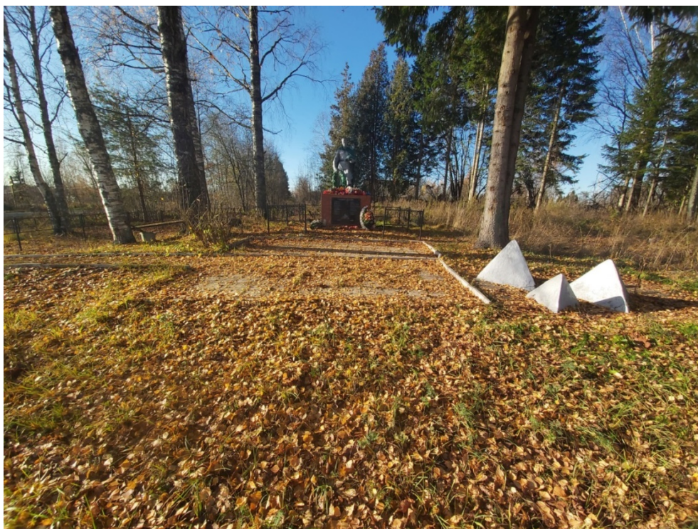
Рис. 105. Межпоселковый газопровод от ГРС Овино – д. Овино – д. Чемихино – д. Сугорово – д. Свирь с отводом на д. Устье и д. Новая Ленинградская область. Общий вид участка обследования. Точка съемки 27. Вид с В.
