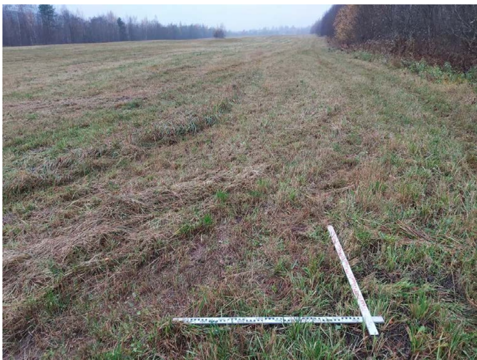
Рис. 44. Межпоселковый газопровод от ГРС Овино – д. Овино – д. Чемихино – д. Сугорово – д. Свирь с отводом на д. Устье и д. Новая Ленинградская область. Шурф 4. До начала работ. Вид с СВ.
