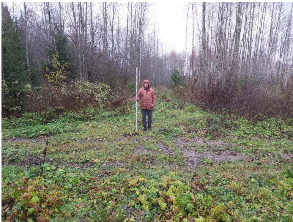
Рис. 48. Межпоселковый газопровод от ГРС Овино – д. Овино – д. Чемихино – д. Сугорово – д. Свирь с отводом на д. Устье и д. Новая Ленинградская область. Общий вид участка обследования. Точка съемки 10. Вид с ЮВ.
