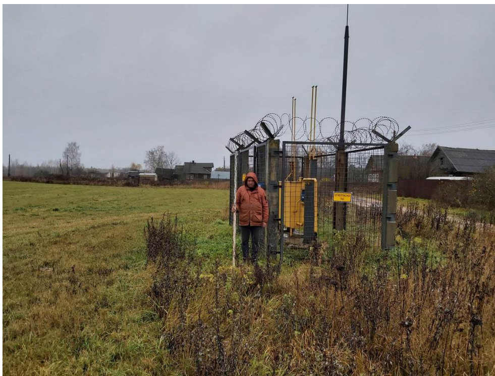
Рис. 13. Межпоселковый газопровод от ГРС Овино – д. Овино – д. Чемихино – д. Сугорово – д. Свирь с отводом на д. Устье и д. Новая Ленинградская область. Общий вид участка обследования. Точка съемки 1. Вид с В.
