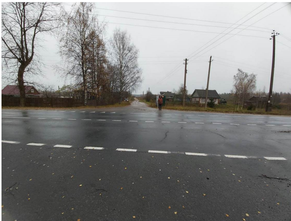
Рис. 21. Межпоселковый газопровод от ГРС Овино – д. Овино – д. Чемихино – д. Сугорово – д. Свирь с отводом на д. Устье и д. Новая Ленинградская область. Общий вид участка обследования. Точка съемки 2. Вид с З.
