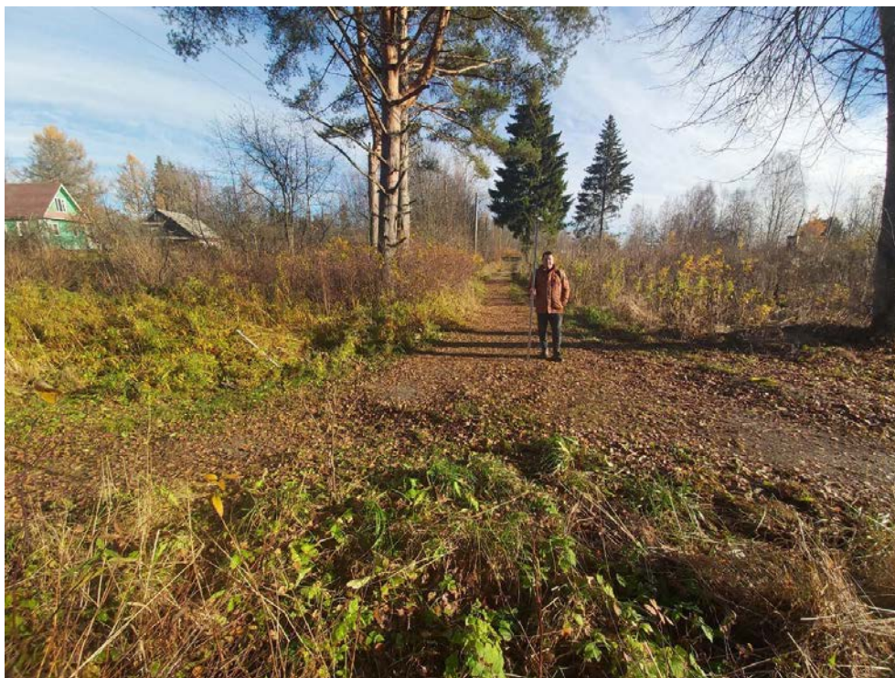
Рис. 111. Межпоселковый газопровод от ГРС Овино – д. Овино – д. Чемихино – д. Сугорово – д. Свирь с отводом на д. Устье и д. Новая Ленинградская область. Общий вид участка обследования. Точка съемки 30. Вид с З.
