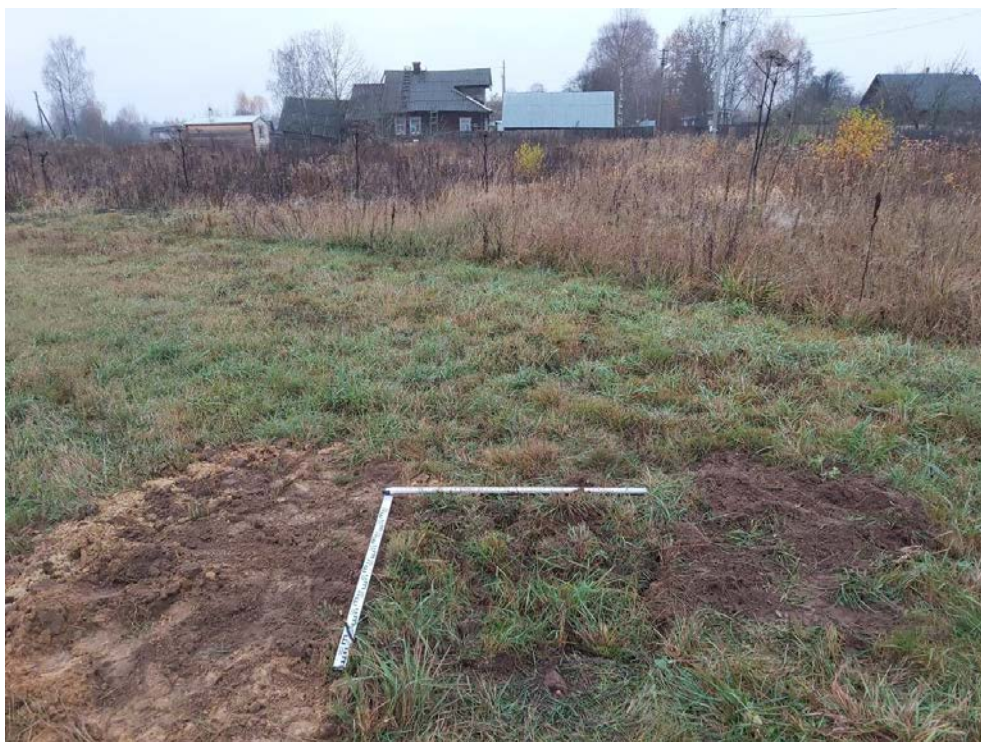
Рис. 19. Межпоселковый газопровод от ГРС Овино – д. Овино – д. Чемихино – д. Сугорово – д. Свирь с отводом на д. Устье и д. Новая Ленинградская область. Шурф 1. Засыпка. Вид с В.
