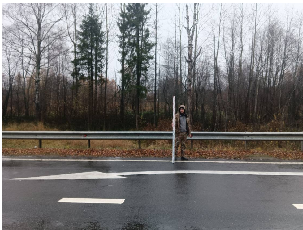
Рис. 85. Межпоселковый газопровод от ГРС Овино – д. Овино – д. Чемихино – д. Сугорово – д. Свирь с отводом на д. Устье и д. Новая Ленинградская область. Общий вид участка обследования. Точка съемки 23. Вид с ССВ.
