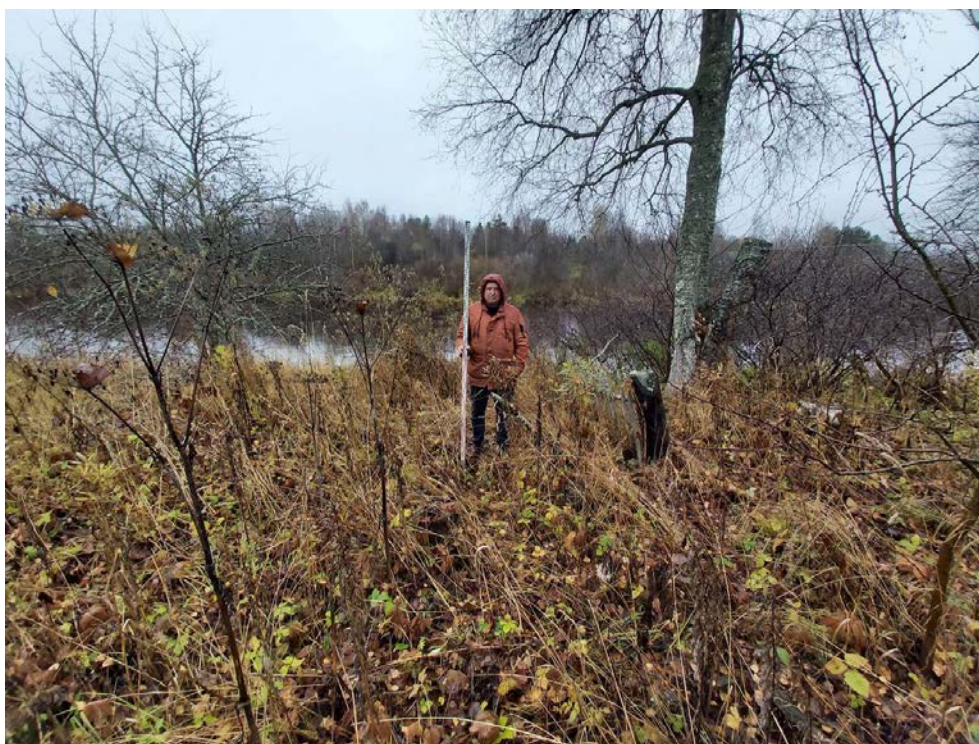
Рис. 115. Межпоселковый газопровод от ГРС Овино – д. Овино – д. Чемихино – д. Сугорово – д. Свирь с отводом на д. Устье и д. Новая Ленинградская область. Общий вид участка обследования. Точка съемки 33. Вид с Ю.
