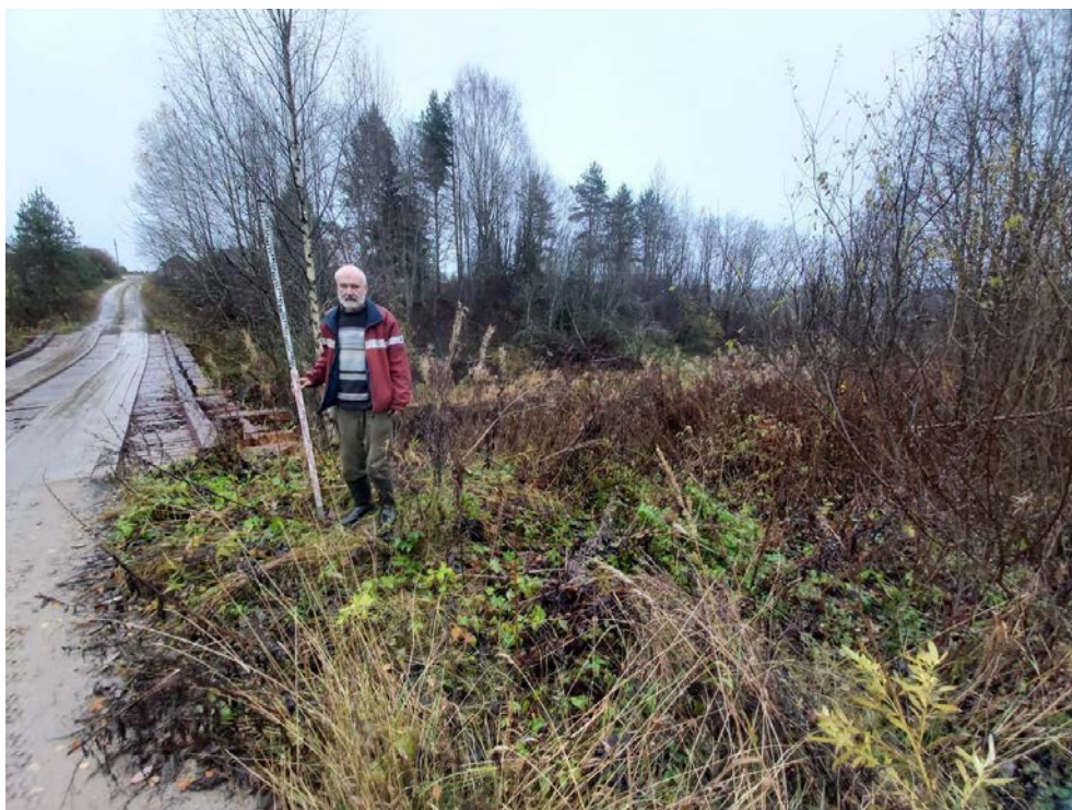
Рис. 125. Межпоселковый газопровод от ГРС Овино – д. Овино – д. Чемихино – д. Сугорово – д. Свирь с отводом на д. Устье и д. Новая Ленинградская область. Общий вид участка обследования. Точка съемки 37. Вид с В.
