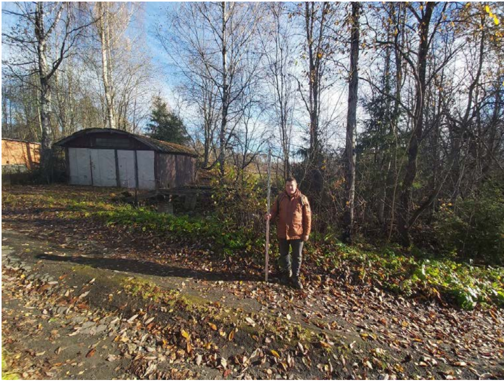
Рис. 107. Межпоселковый газопровод от ГРС Овино – д. Овино – д. Чемихино – д. Сугорово – д. Свирь с отводом на д. Устье и д. Новая Ленинградская область. Общий вид участка обследования. Точка съемки 28. Вид с З.
