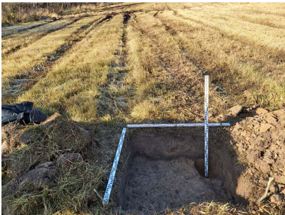
Рис. 97. Межпоселковый газопровод от ГРС Овино – д. Овино – д. Чемихино – д. Сугорово – д. Свирь с отводом на д. Устье и д. Новая Ленинградская область. Шурф 10. Зачистка по матерiku. Вид с В.
