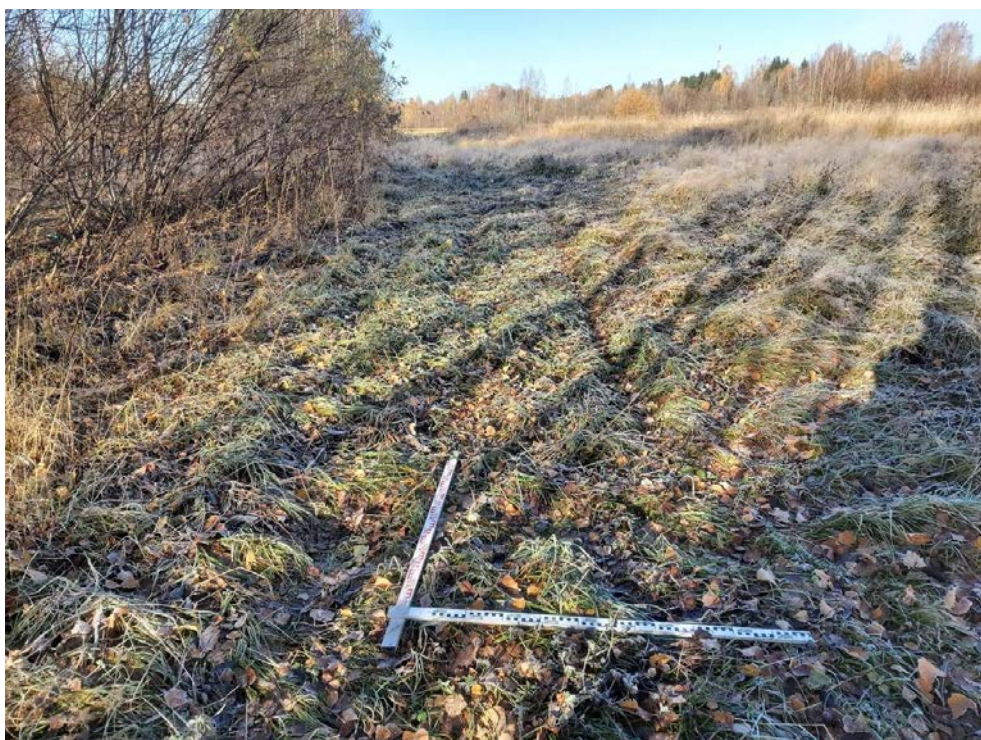
Рис. 88. Межпоселковый газопровод от ГРС Овино – д. Овино – д. Чемихино – д. Сугорова – д. Свирь с отводом на д. Устье и д. Новая Ленинградская область. Шурф 9. До начала работ. Вид с ВЮВ.
