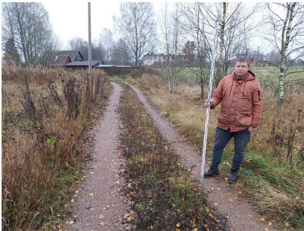
Рис. 25. Межпоселковый газопровод от ГРС Овино – д. Овино – д. Чемихино – д. Сугорово – д. Свирь с отводом на д. Устье и д. Новая Ленинградская область. Общий вид участка обследования. Точка съемки 4. Вид с СЗ.
