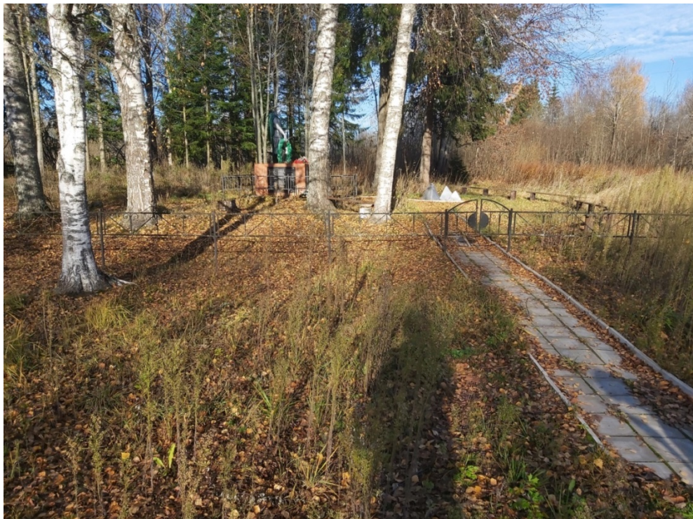
Рис. 102. Межпоселковый газопровод от ГРС Овино – д. Овино – д. Чемихино – д. Сугорово – д. Свирь с отводом на д. Устье и д. Новая Ленинградская область. Общий вид участка обследования. Точка съемки 27. Вид с Ю.
