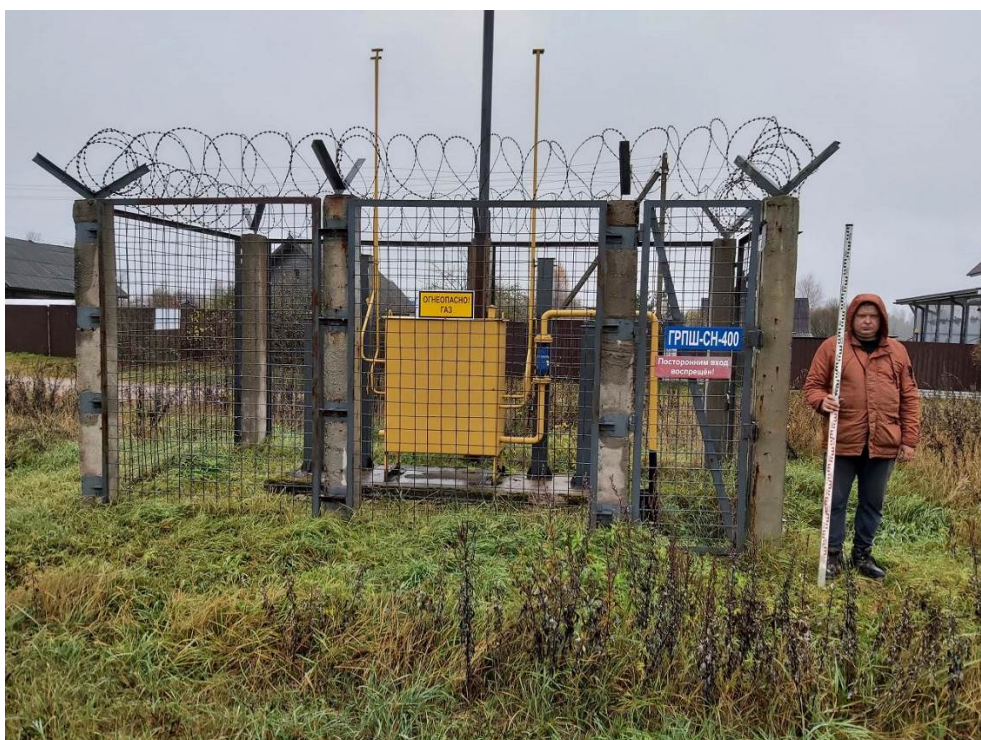
Рис. 14. Межпоселковый газопровод от ГРС Овино – д. Овино – д. Чемихино – д. Сугорово – д. Свирь с отводом на д. Устье и д. Новая Ленинградская область. Общий вид участка обследования. Точка съемки 1. Вид с Ю.
