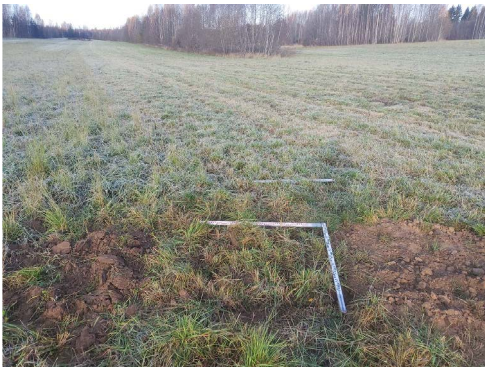
Рис. 81. Межпоселковый газопровод от ГРС Овино – д. Овино – д. Чемихино – д. Сугорово – д. Свирь с отводом на д. Устье и д. Новая Ленинградская область. Шурф 8. Засыпка. Вид с ЮВ.
