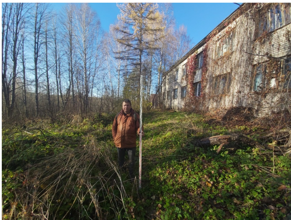
Рис. 112. Межпоселковый газопровод от ГРС Овино – д. Овино – д. Чемихино – д. Сугорово – д. Свирь с отводом на д. Устье и д. Новая Ленинградская область. Общий вид участка обследования. Точка съемки 31. Вид с В
