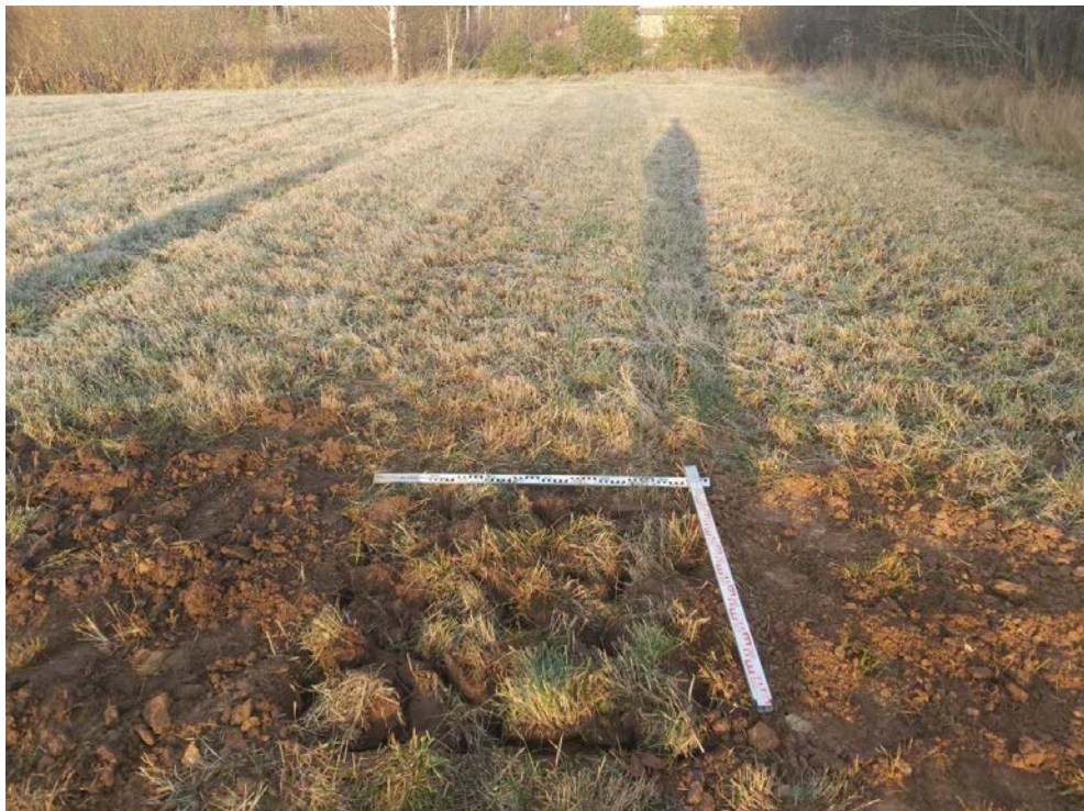
Рис. 64. Межпоселковый газопровод от ГРС Овино – д. Овино – д. Чемихино – д. Сугорово – д. Свирь с отводом на д. Устье и д. Новая Ленинградская область. Шурф 6. Засыпка. Вид с ЮВ.
