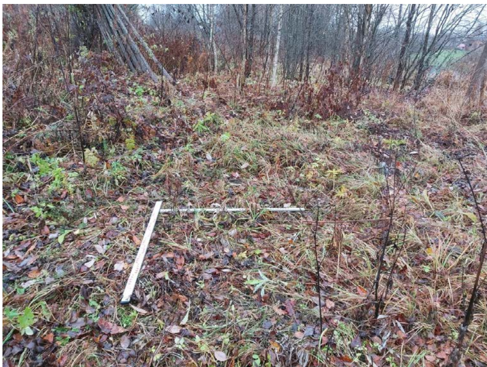
Рис. 117. Межпоселковый газопровод от ГРС Овино – д. Овино – д. Чемихино – д. Сугорово – д. Свирь с отводом на д. Устье и д. Новая Ленинградская область. Шурф 11. До начала работ. Вид с В.
