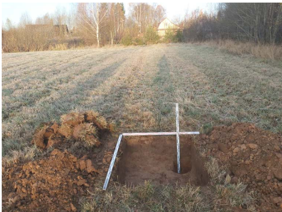
Рис. 62. Межпоселковый газопровод от ГРС Овино – д. Овино – д. Чемихино – д. Сугорово – д. Свирь с отводом на д. Устье и д. Новая Ленинградская область. Шурф 6. Зачистка по матерiku. Вид с ЮВ.
