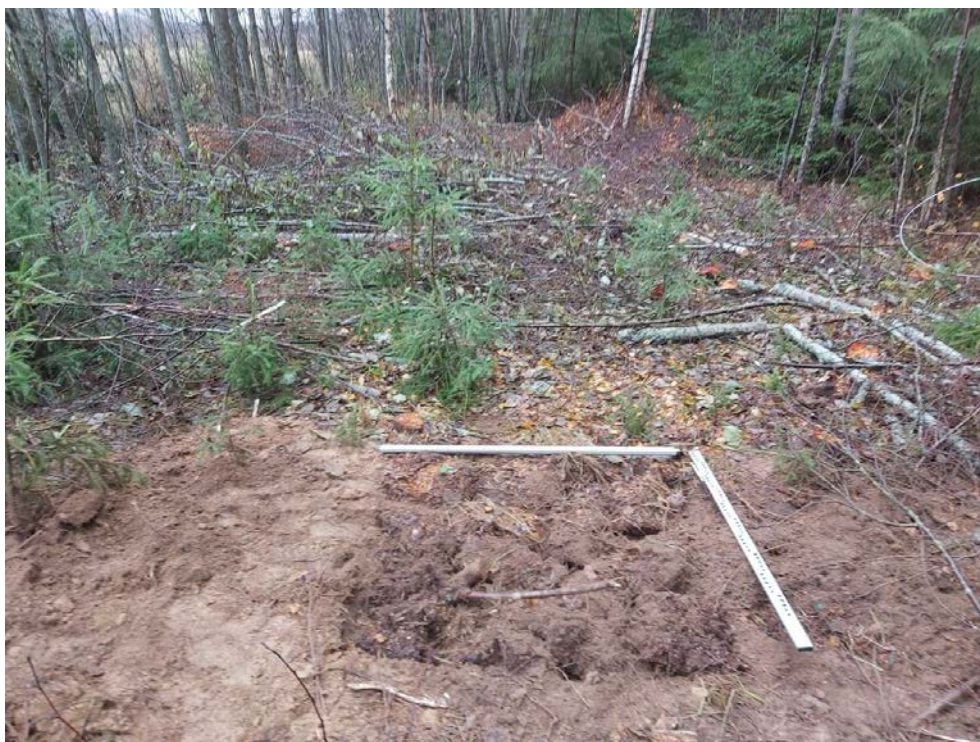
Рис. 55. Межпоселковый газопровод от ГРС Овино – д. Овино – д. Чемихино – д. Сугорово – д. Свирь с отводом на д. Устье и д. Новая Ленинградская область. Шурф 5. Засыпка. Вид с ЮВ.
