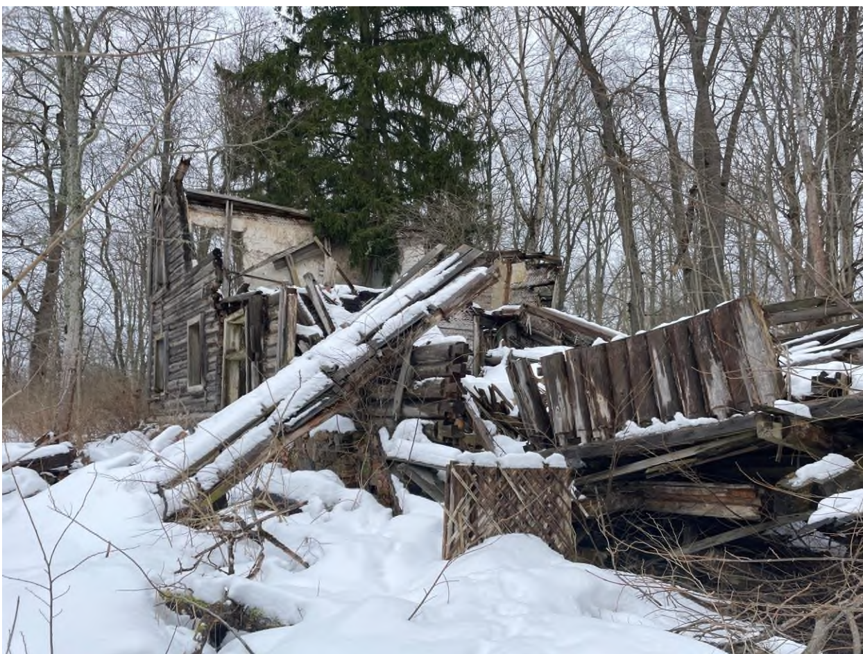
Фото 34. Объект культурного наследия регионального значения «Флигель (деревянный)»
