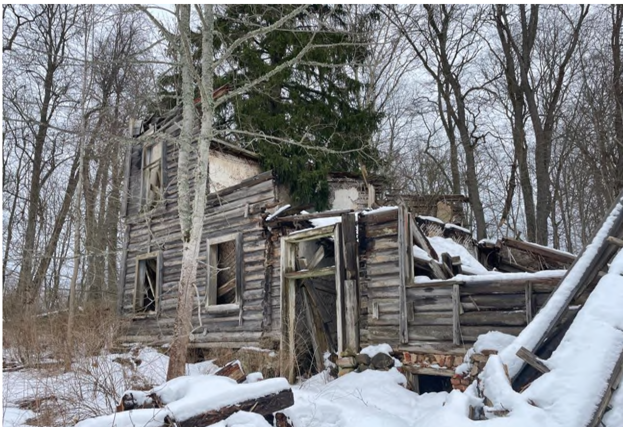
Фото 35. Объект культурного наследия регионального значения «Флигель (деревянный)»
