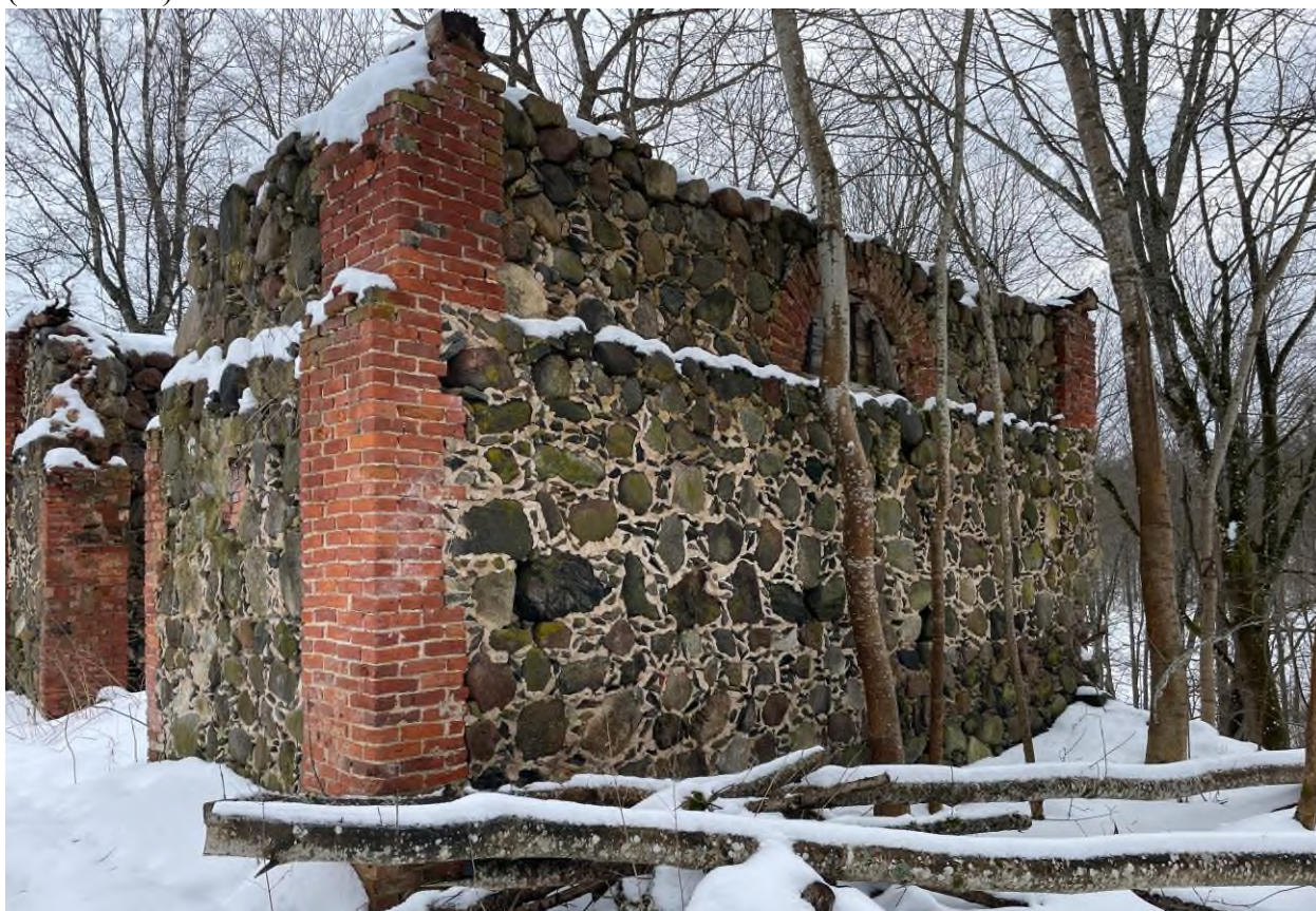
Фото 22. Объект культурного наследия регионального значения «Каретный сарай (каменный)»
