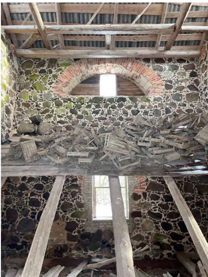
Фото 15. Объект культурного наследия регионального значения «Конюшня (каменная)». Интерьер.
