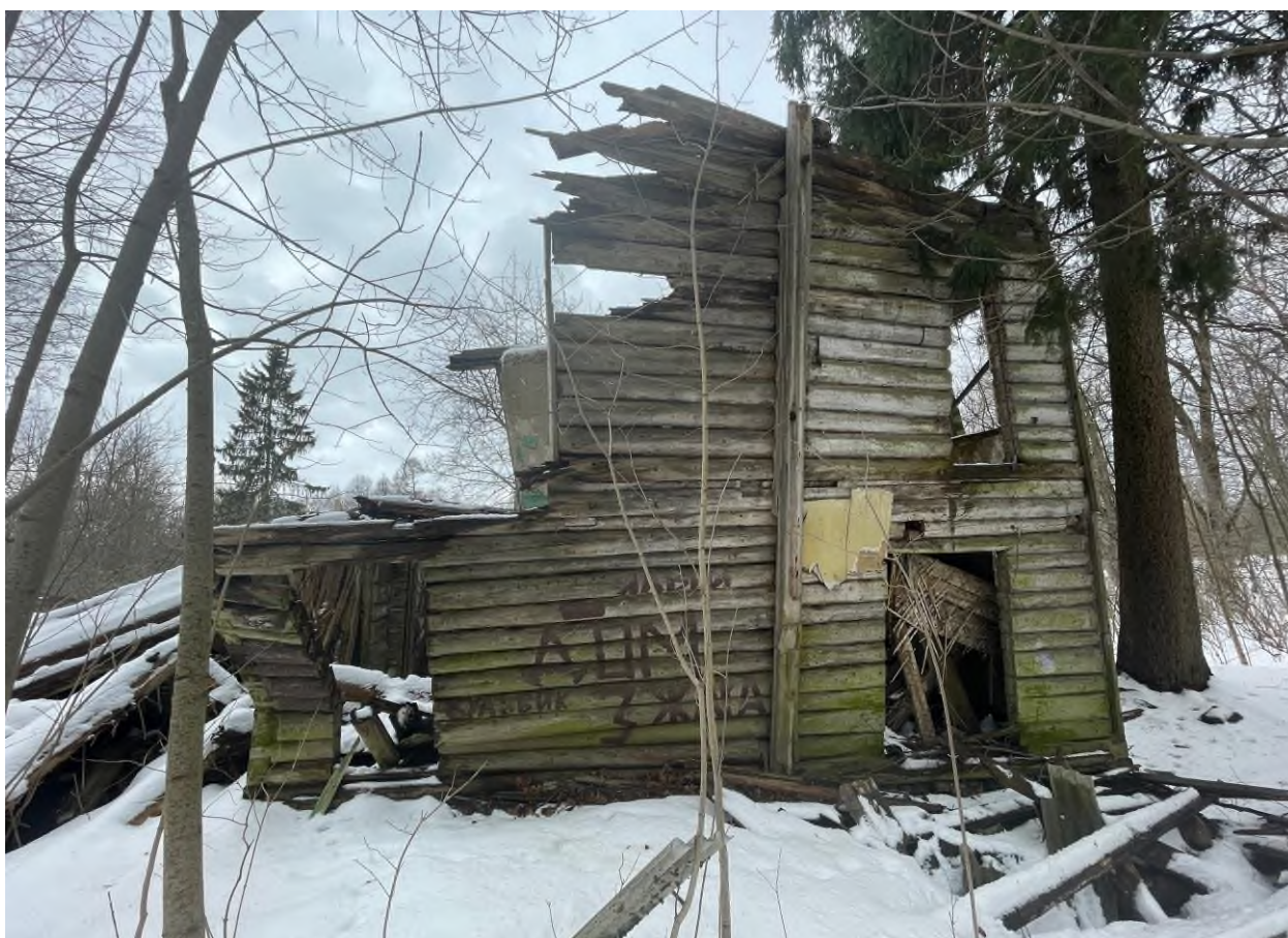
Фото 30. Объект культурного наследия регионального значения «Флигель (деревянный)»
