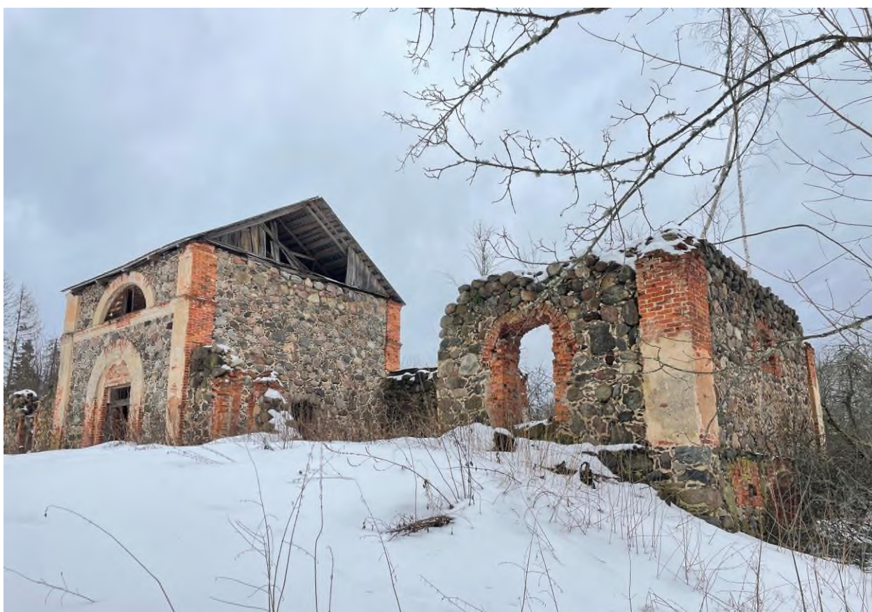
Фото 12. Вид на объект культурного наследия регионального значения «Конюшня (каменная)»
