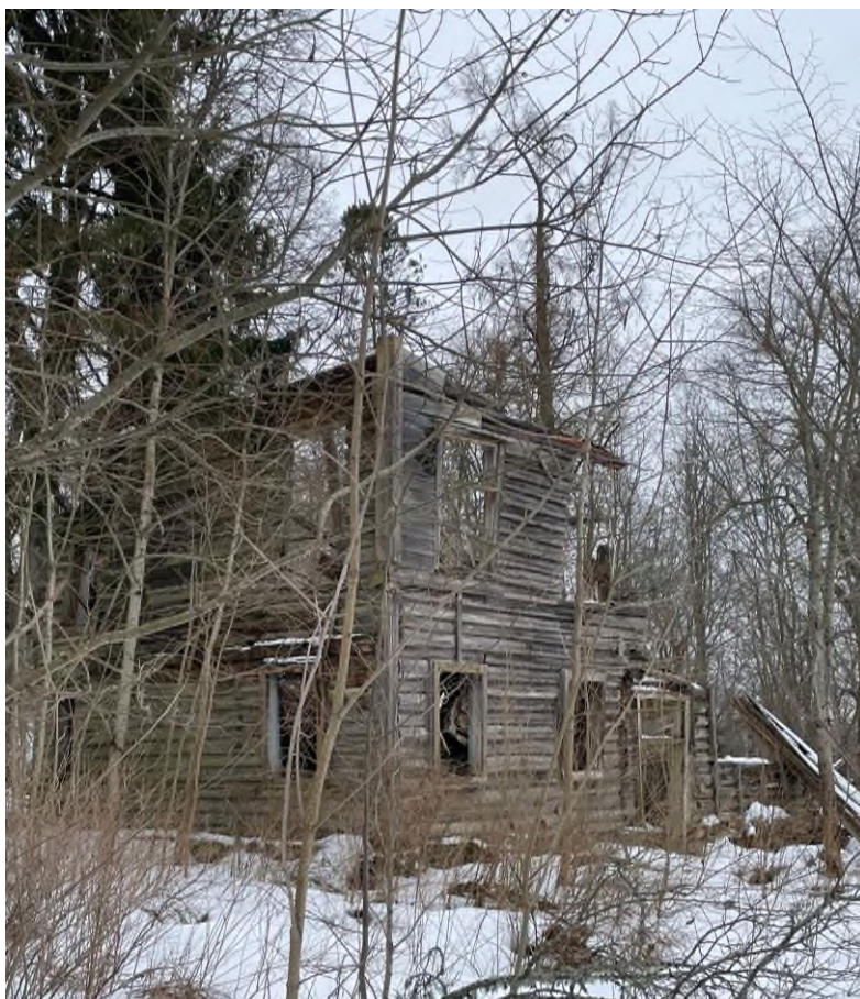
Фото 39. Объект культурного наследия регионального значения «Флигель (деревянный)»
