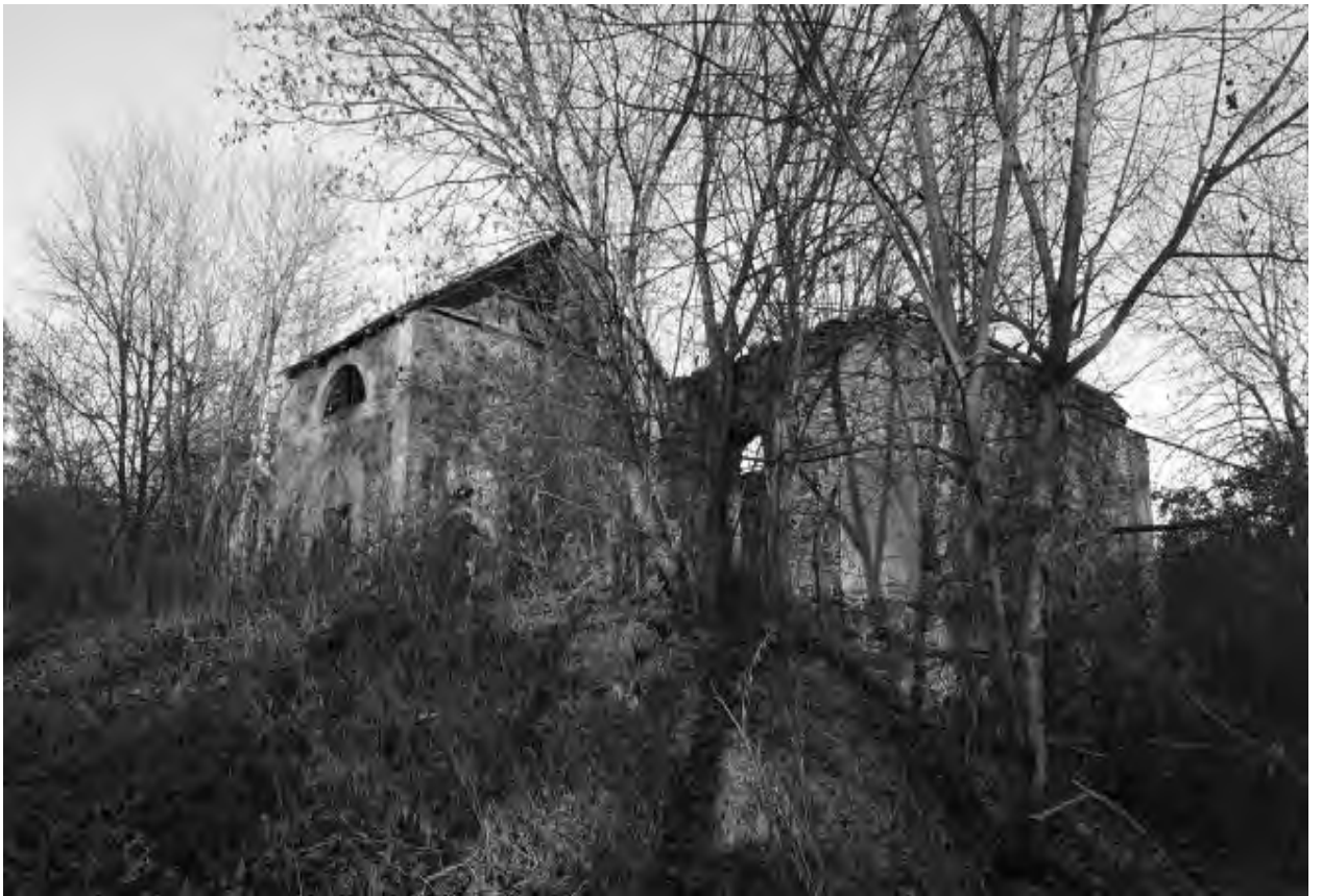
Илл. 66. Здание конюшни. Фотография 1990 г.
