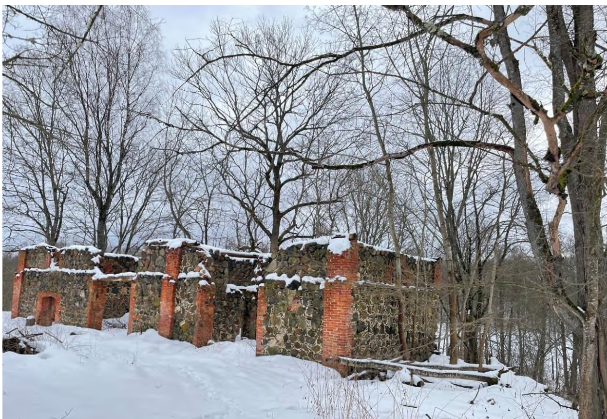
Фото 20. Объект культурного наследия регионального значения «Каретный сарай (каменный)».
