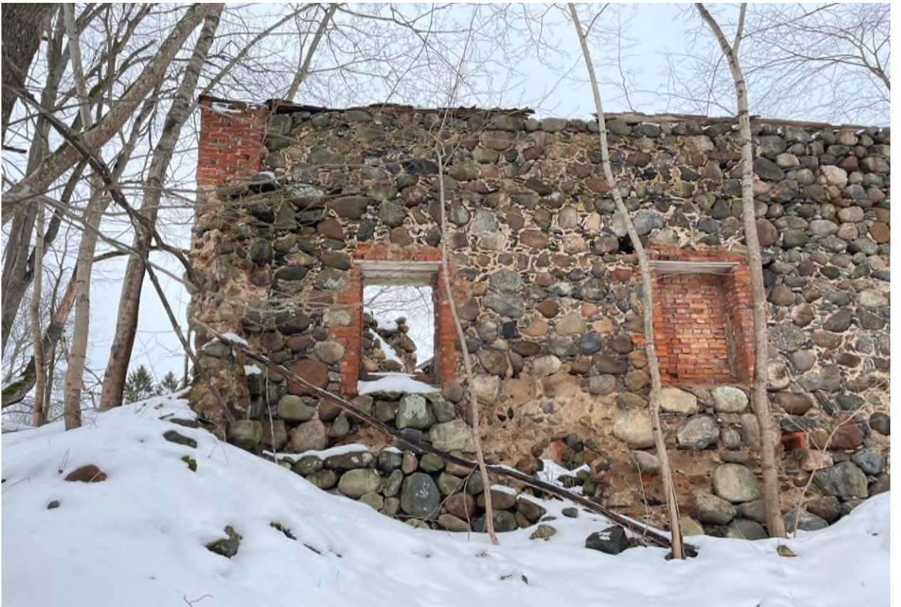
Фото 24. Объект культурного наследия регионального значения «Каретный сарай (каменный)»
