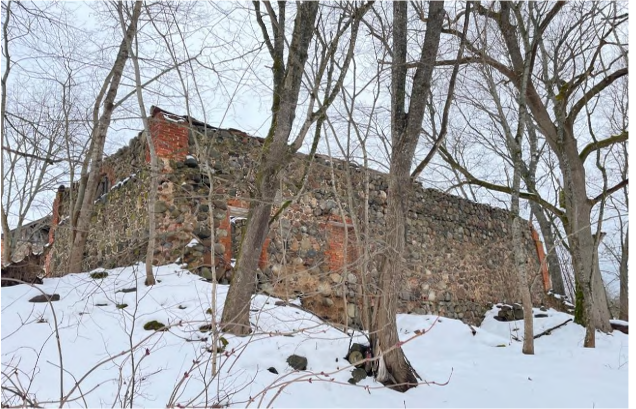
Фото 23. Объект культурного наследия регионального значения «Каретный сарай (каменный)»
