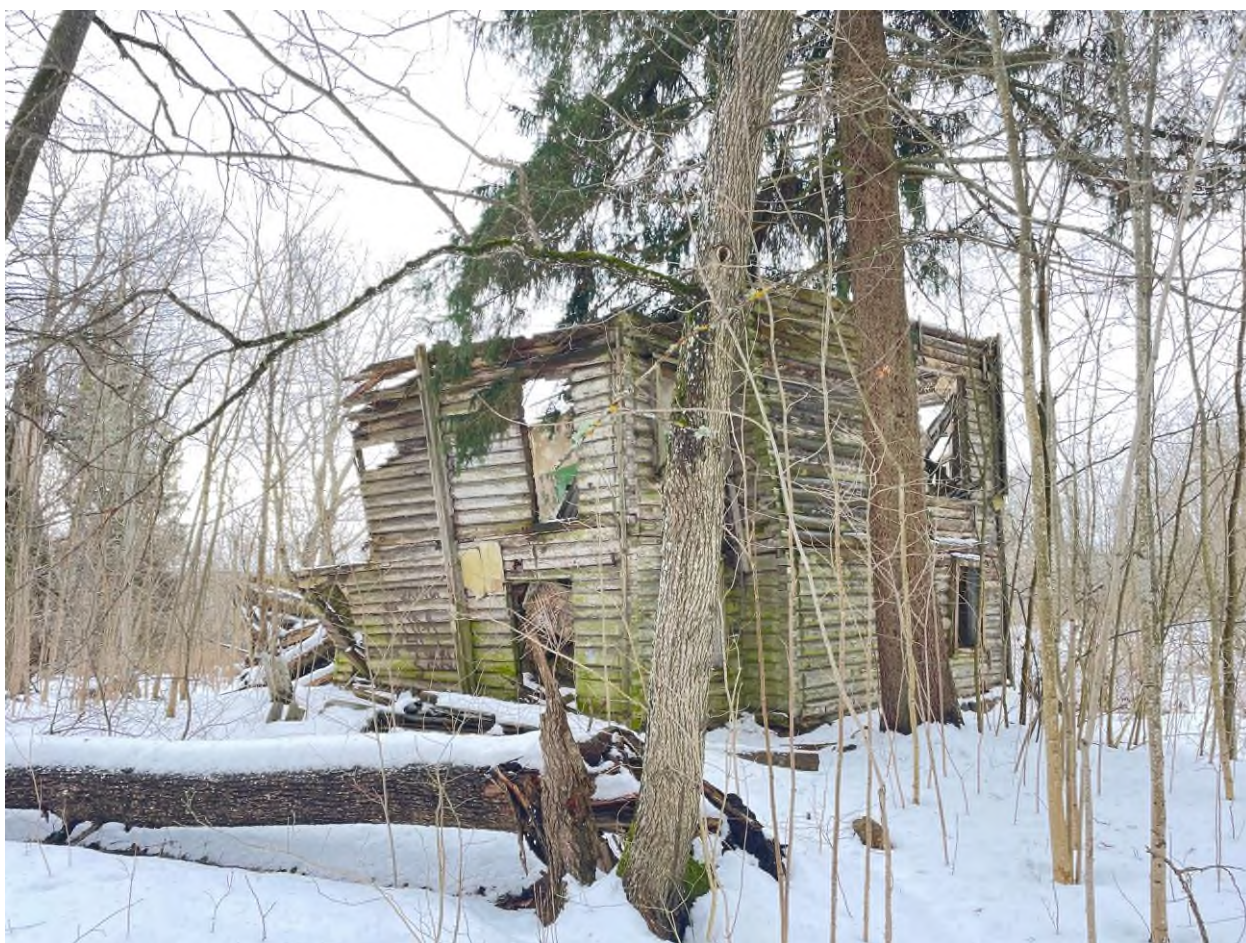
Фото 28. Объект культурного наследия регионального значения «Флигель (деревянный)»
