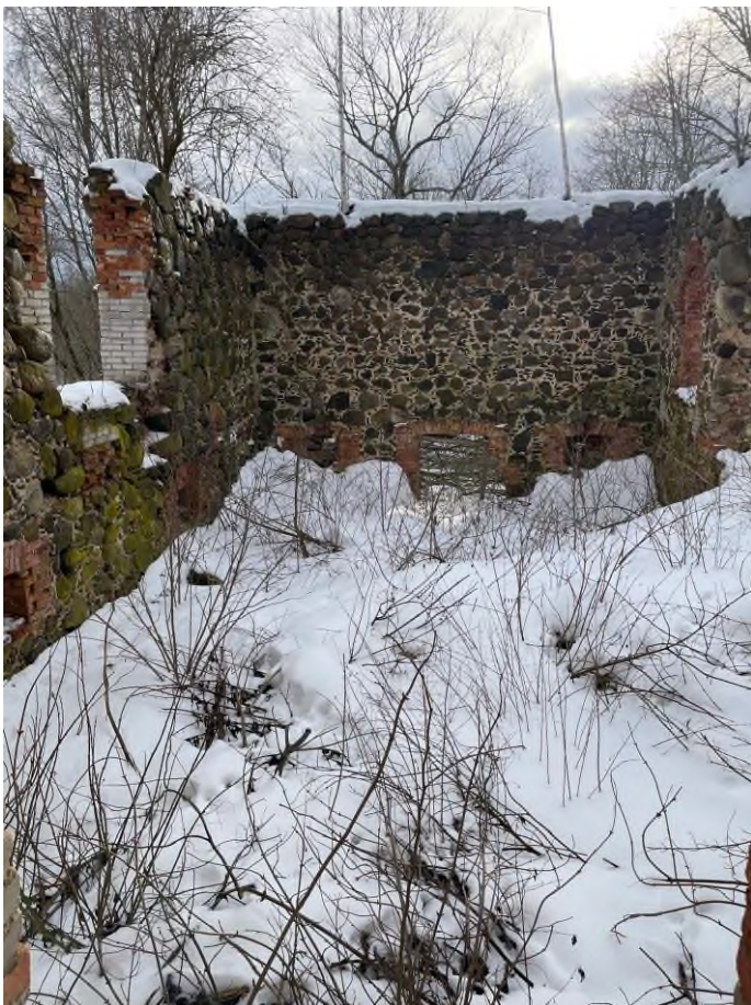
Фото 17. Объект культурного наследия регионального значения «Конюшня (каменная)». Интерьер.
