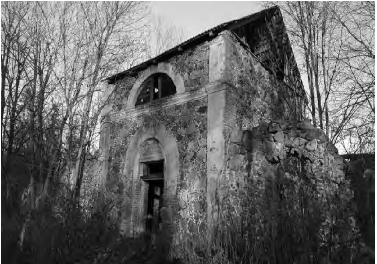
Илл. 65. Здание конюшни. Фотография 1990 г.
