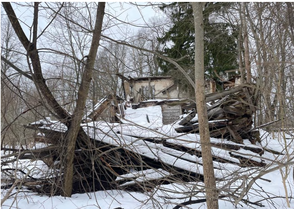
Фото 33. Объект культурного наследия регионального значения «Флигель (деревянный)»
