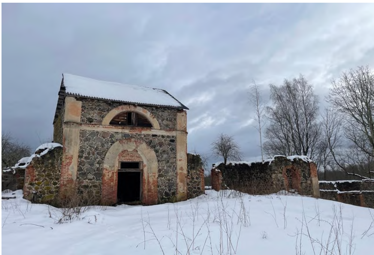
Фото 8. Вид на объект культурного наследия регионального значения «Конюшня (каменная)»
