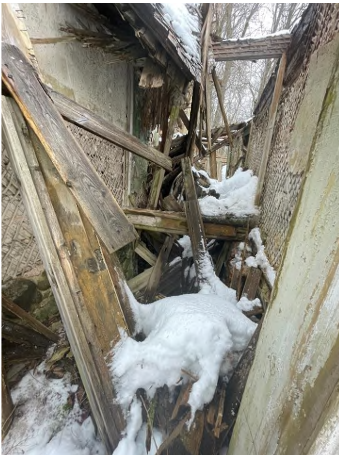
Фото 37. Объект культурного наследия регионального значения «Флигель (деревянный)». Интерьер.
