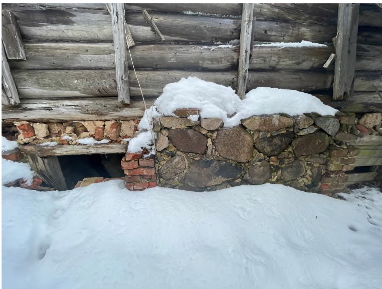
Фото 36. Объект культурного наследия регионального значения «Флигель (деревянный)»
