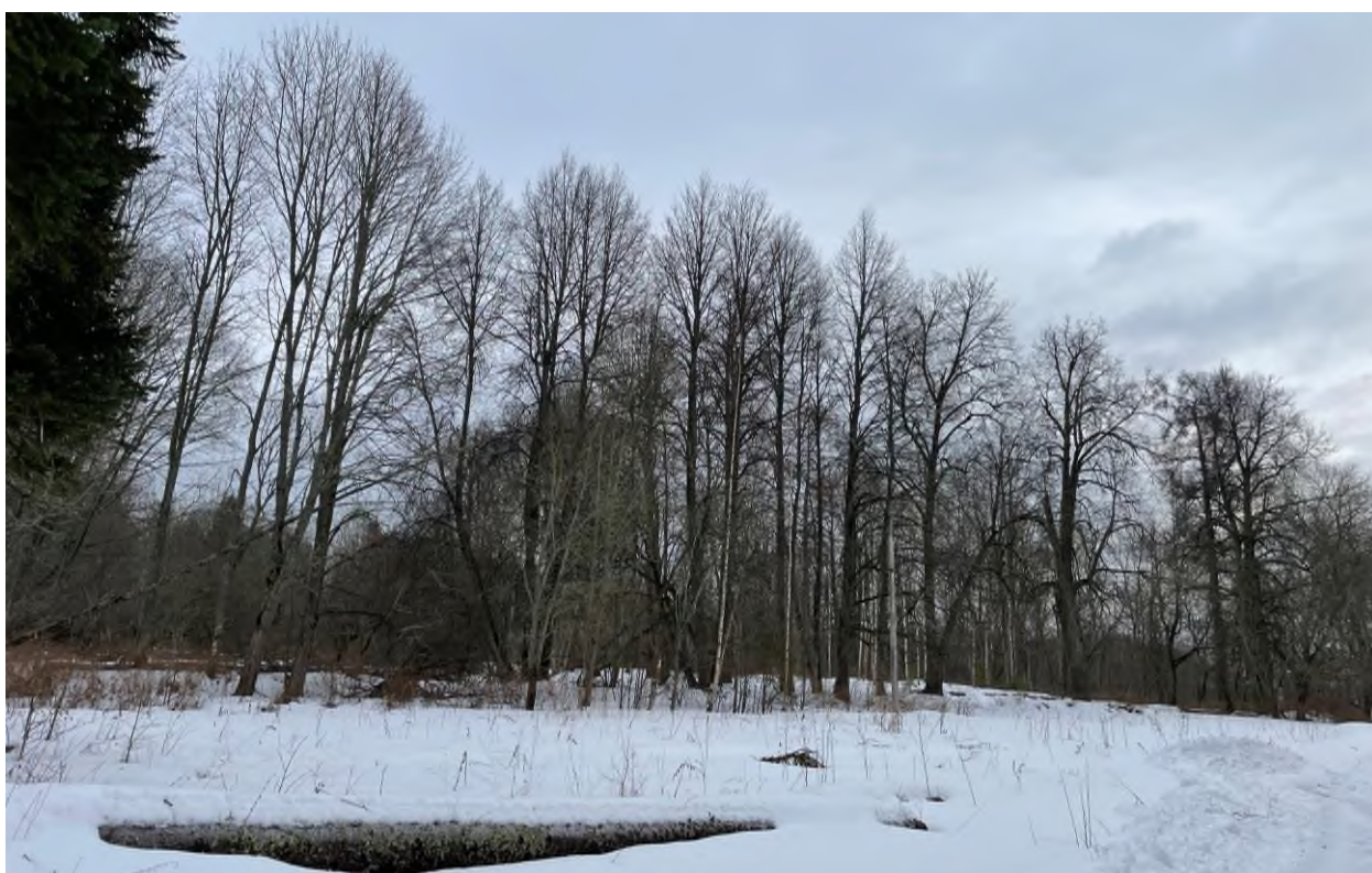
Фото 2. Вид на фундамент – объекта культурного наследия регионального значения «Церковь Архистратига Михаила».
