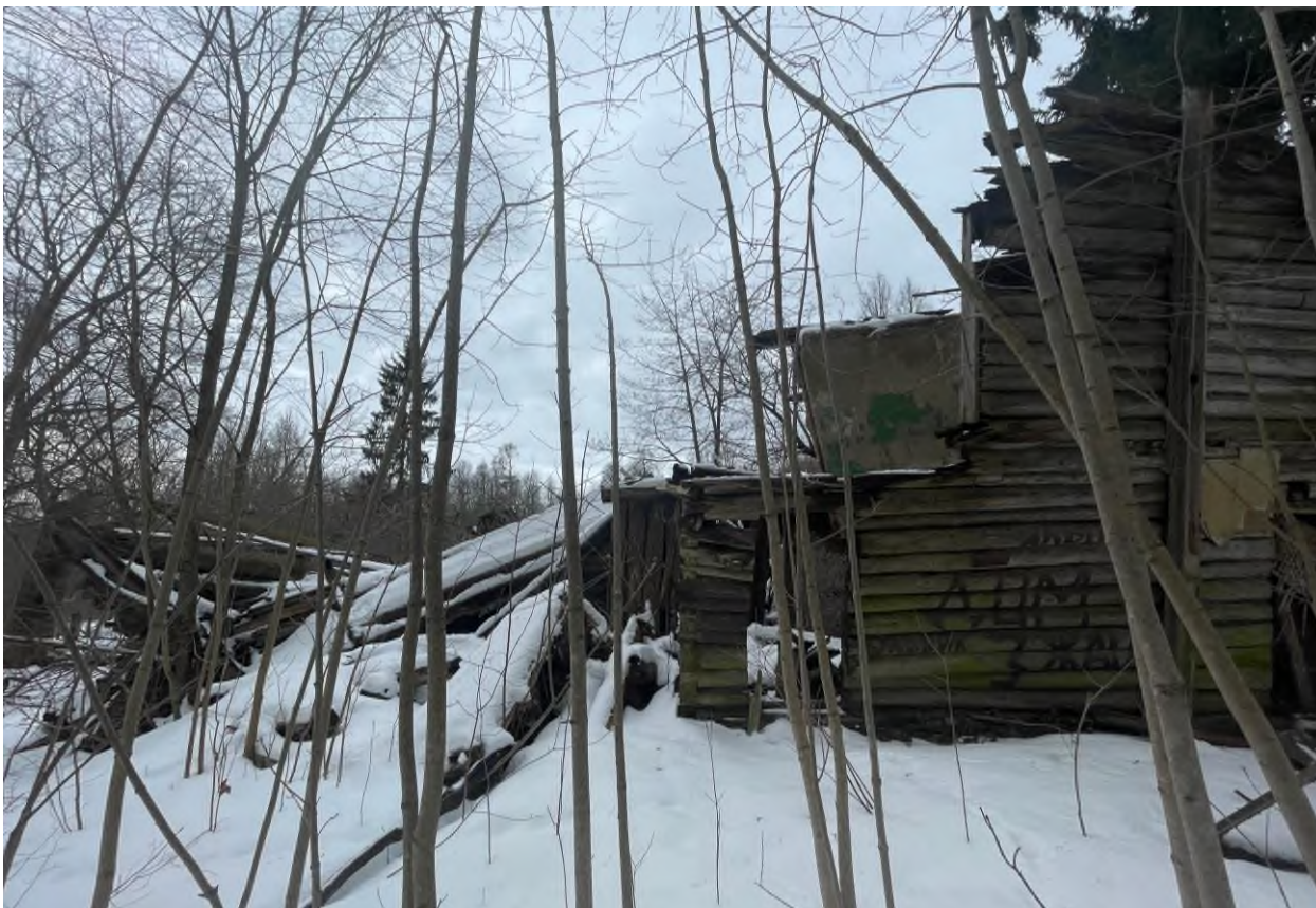
Фото 31. Объект культурного наследия регионального значения «Флигель (деревянный)»
