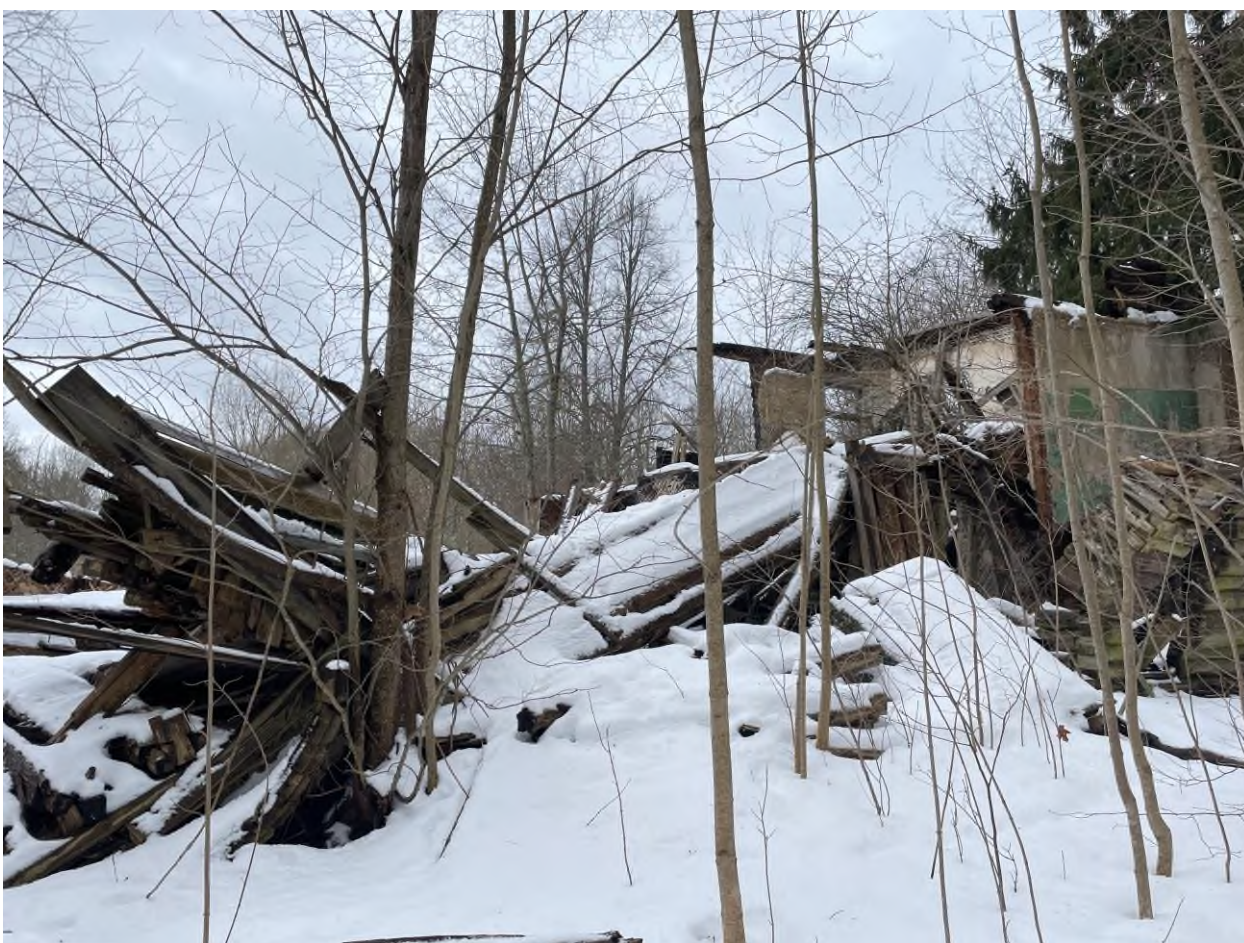
Фото 32. Объект культурного наследия регионального значения «Флигель (деревянный)»
