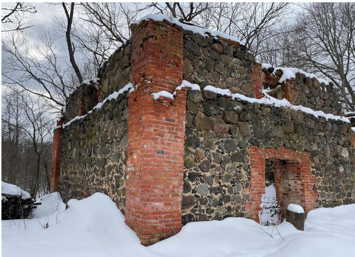
Фото 21. Объект культурного наследия регионального значения «Каретный сарай (каменный)»
