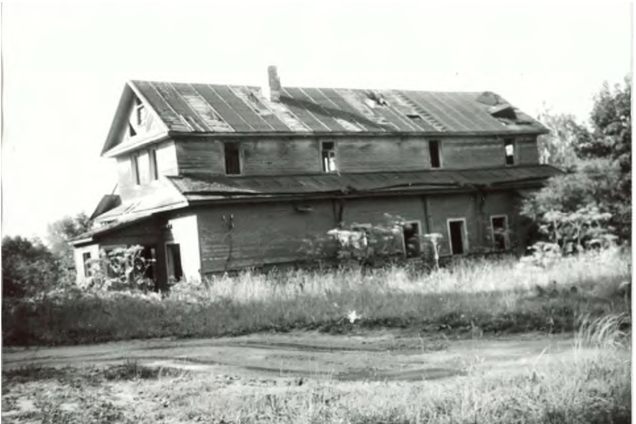
Илл. 60. Здание школы. Фотография 1992 г.
