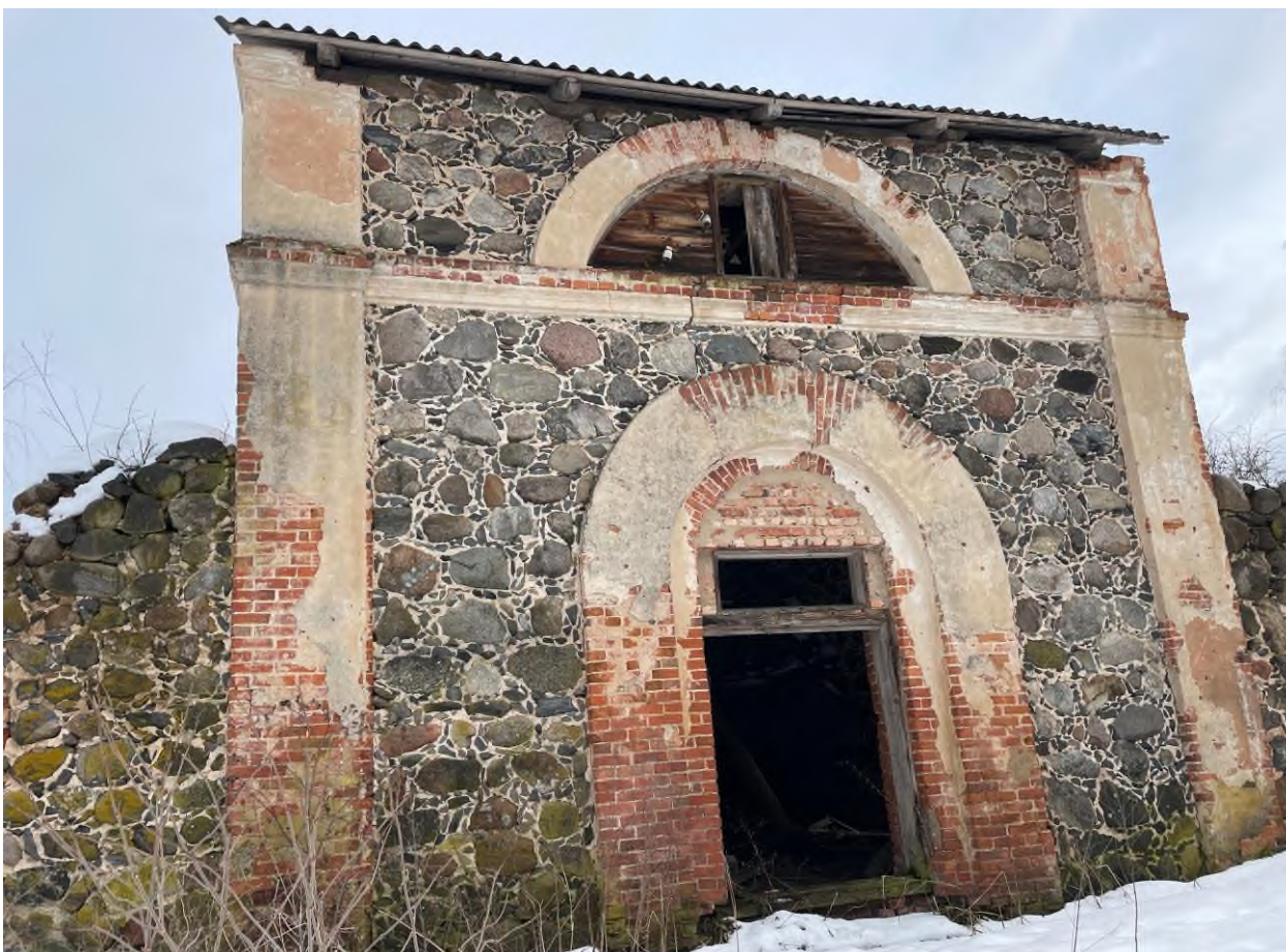
Фото 9. Вид на объект культурного наследия регионального значения «Конюшня (каменная)»
