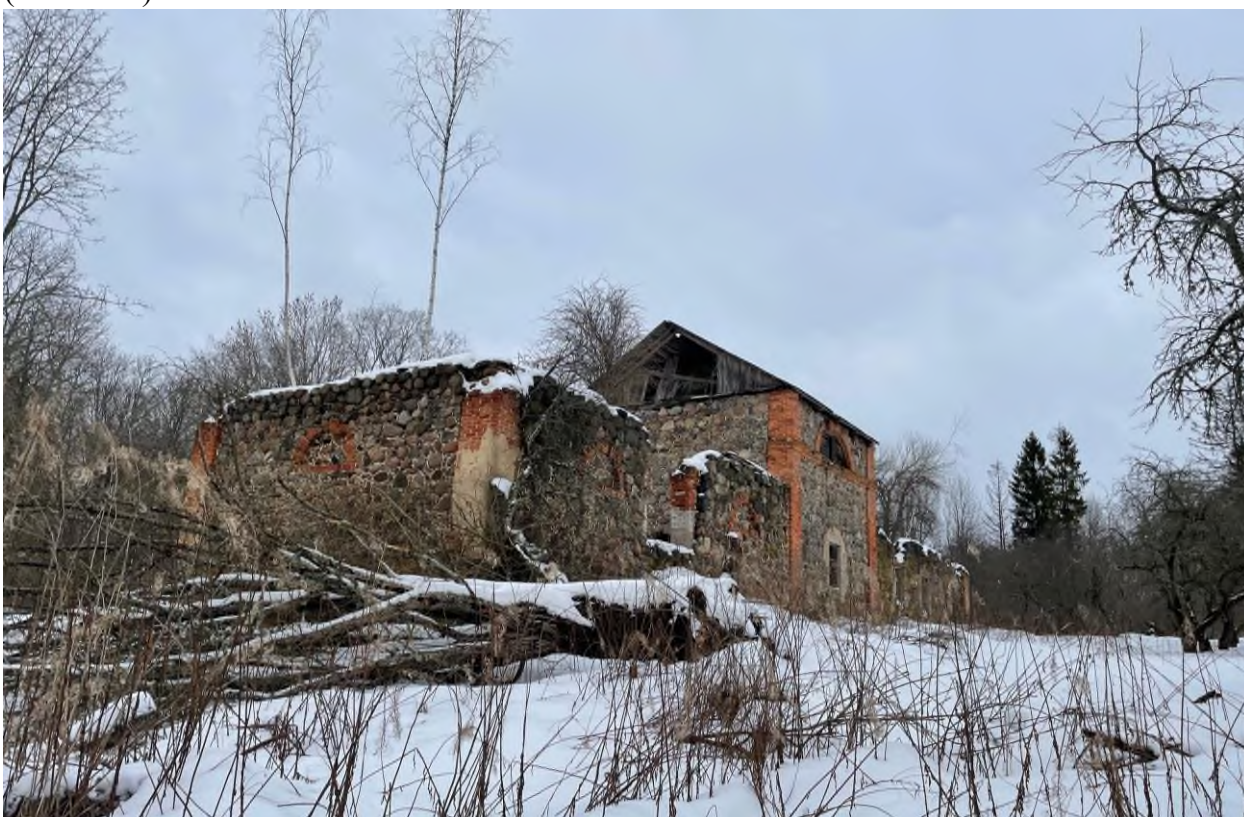
Фото 14. Вид на объект культурного наследия регионального значения «Конюшня (каменная)»
