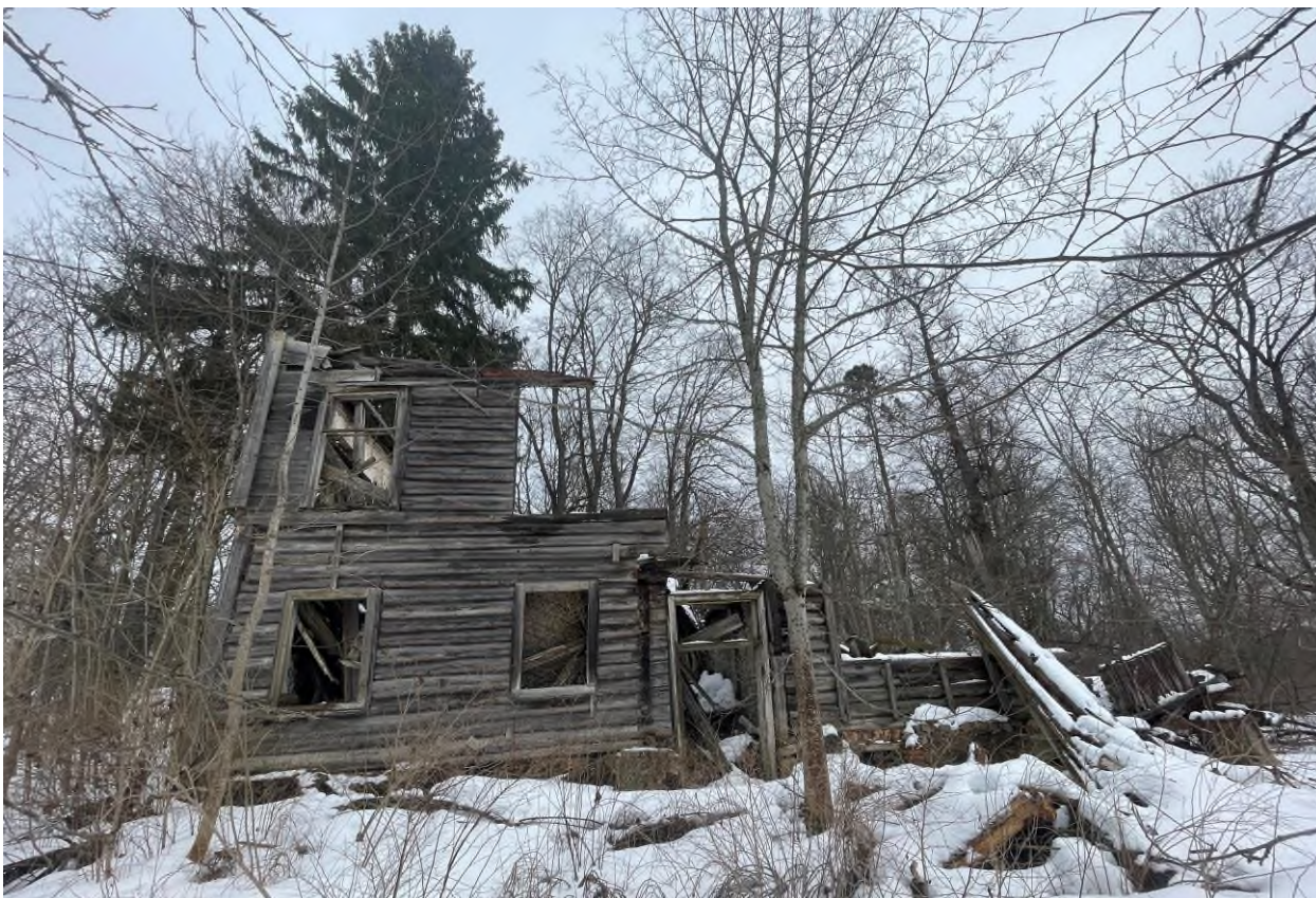
Фото 38. Объект культурного наследия регионального значения «Флигель (деревянный)»
