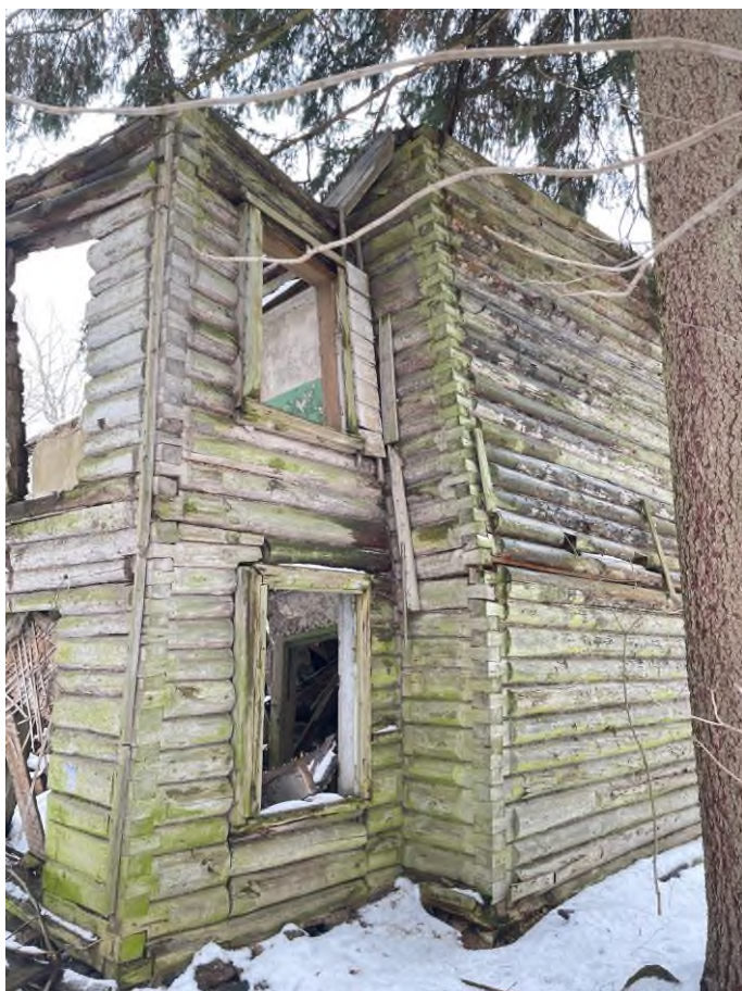
Фото 29. Объект культурного наследия регионального значения «Флигель (деревянный)»
