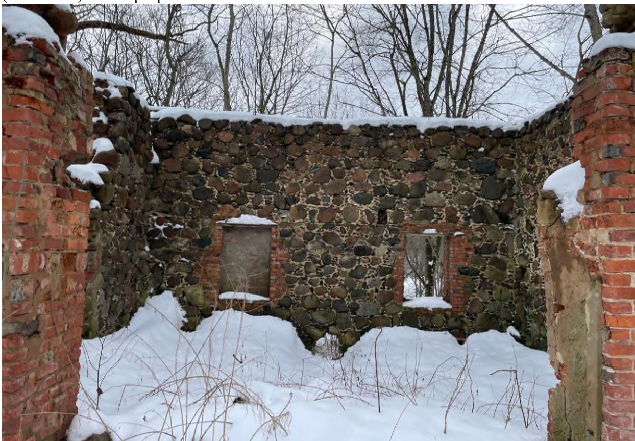
Фото 26. Объект культурного наследия регионального значения «Каретный сарай (каменный)». Интерьер.
