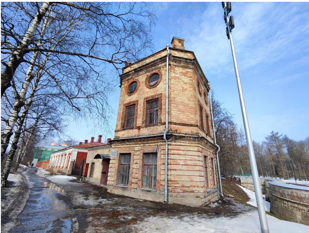
2. «Екатеринвердерская башня», 1797г.» в составе объекта культурного наследия федерального значения «Ансамбль Гатчинского дворца и парка», Ленинградская область, Гатчинский муниципальный район, Гатчинское городское поселение, г. Гатчина, проспект Красноармейский, дом 1, строение 18. Южный фасад. Общий вид. Фото 23.03.2023г.
