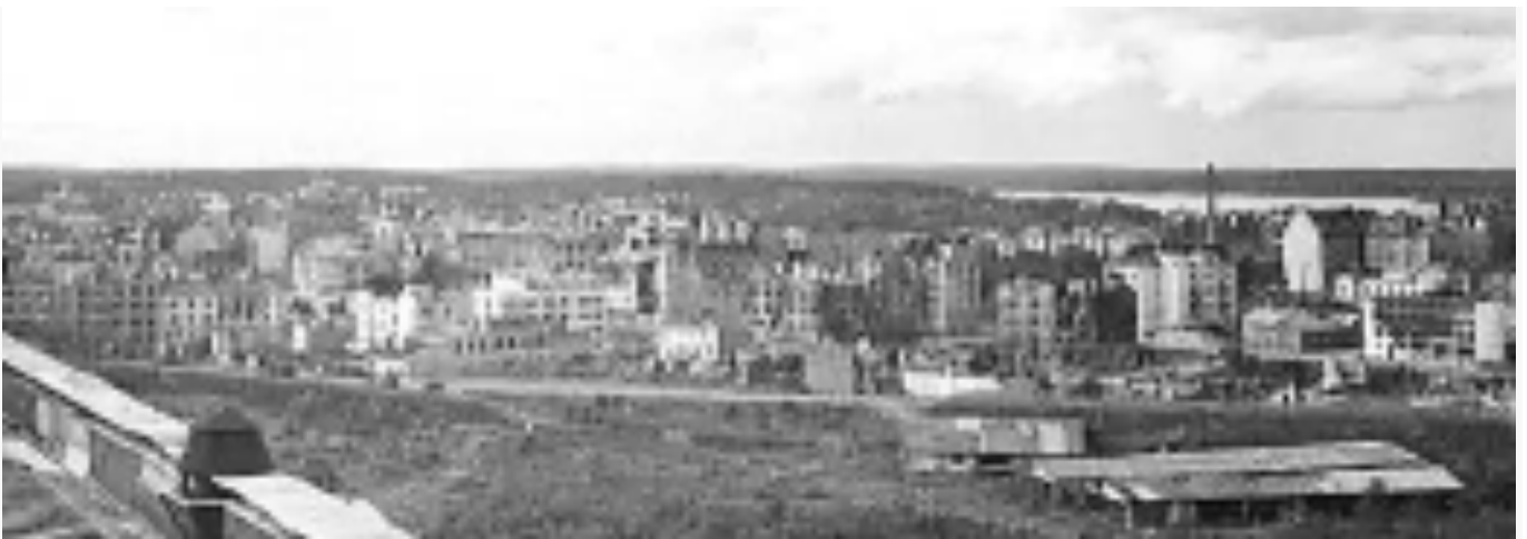
17. То же, фрагмент. Многоэтажная застройка имеет значительные повреждения.
