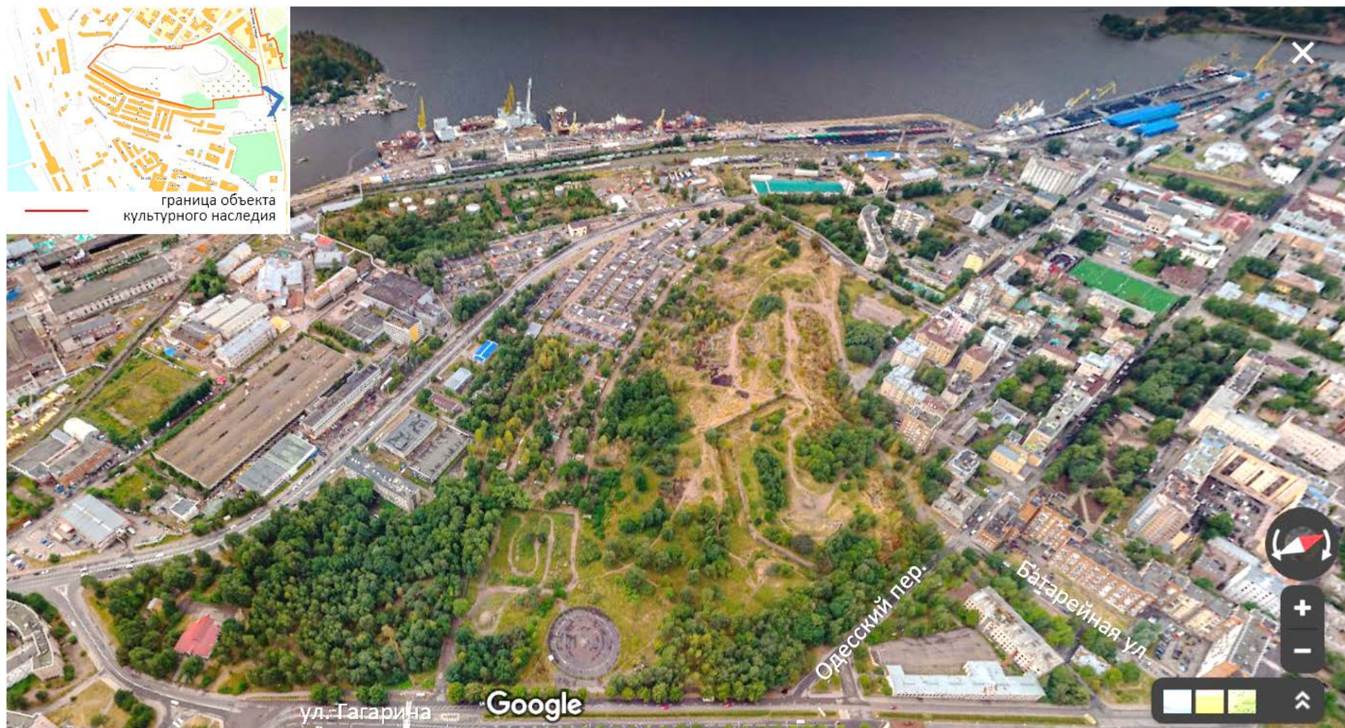
1. Вид от ул. Гагарина на запад. Между Интендантской горой и Выборгским заливом расположена коммунально-производственная зона.
