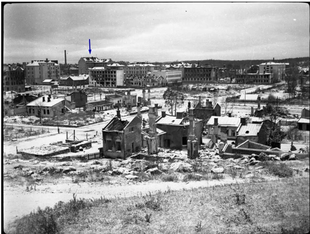
4. Вид с северного склона Батарейной горы в сторону железной дороги (на север). 1941. Автор фото: Jalmari Lankinen Музей г. Лаппеенранта. Инв № KUVLANKN67:54. Эл. доступ: https://finna.fi/Record/lappeenrannanmuseot.F4AD5174-0F89-4A7F-9ECE-2FF4414774D21 Здесь и далее стрелкой показан опорный объект для сравнения.
