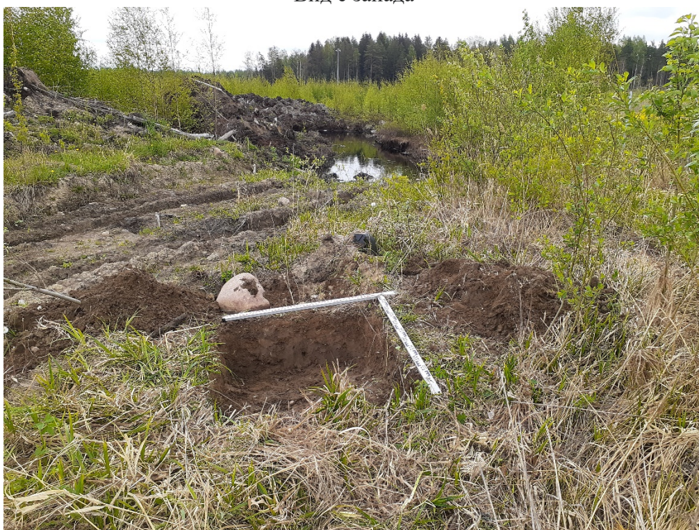
Рис. 15. Земельный участок с кадастровым номером 47:14:0203003:368 Шурф 1 Общий вид после проведения земляных работ Вид с запада В качестве масштаба использованы линейки длиной 1 м
