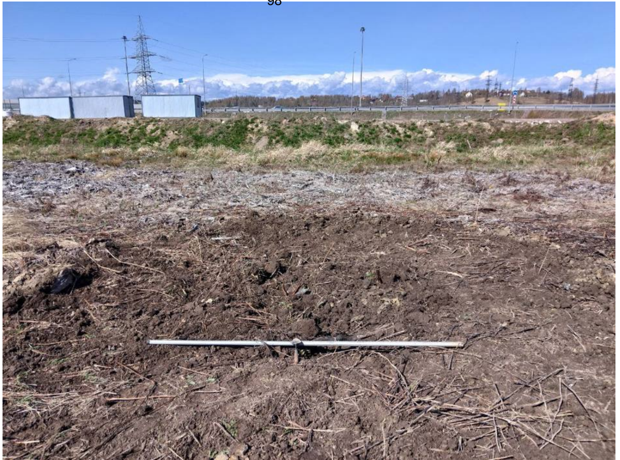
Рис. 37. Д. Порошкино-2023. Шурф 1 после рекультивации, вид на север.
