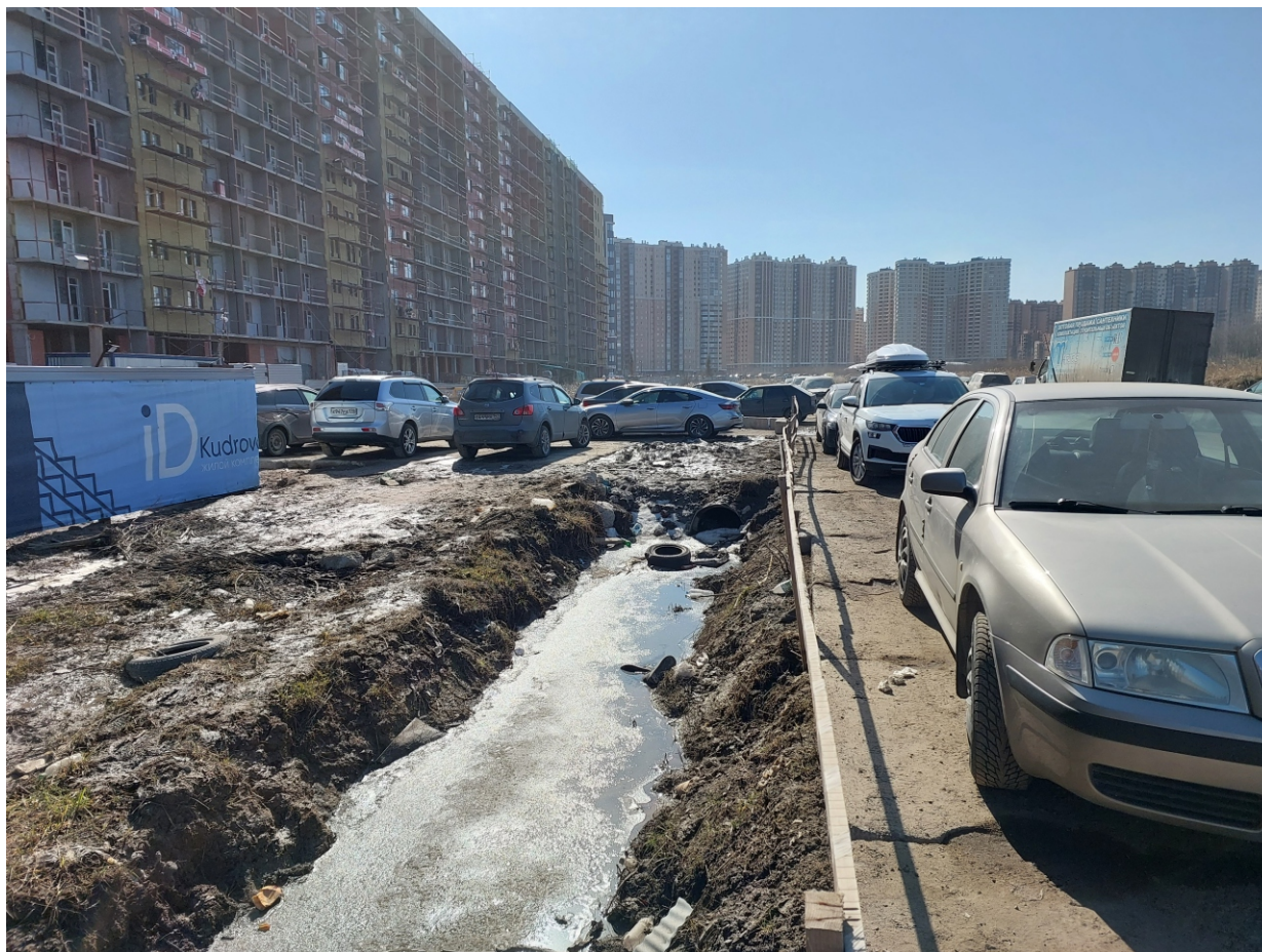
Точка фотофиксации 11. Центральная часть территории обследования. Вид с СВ.
