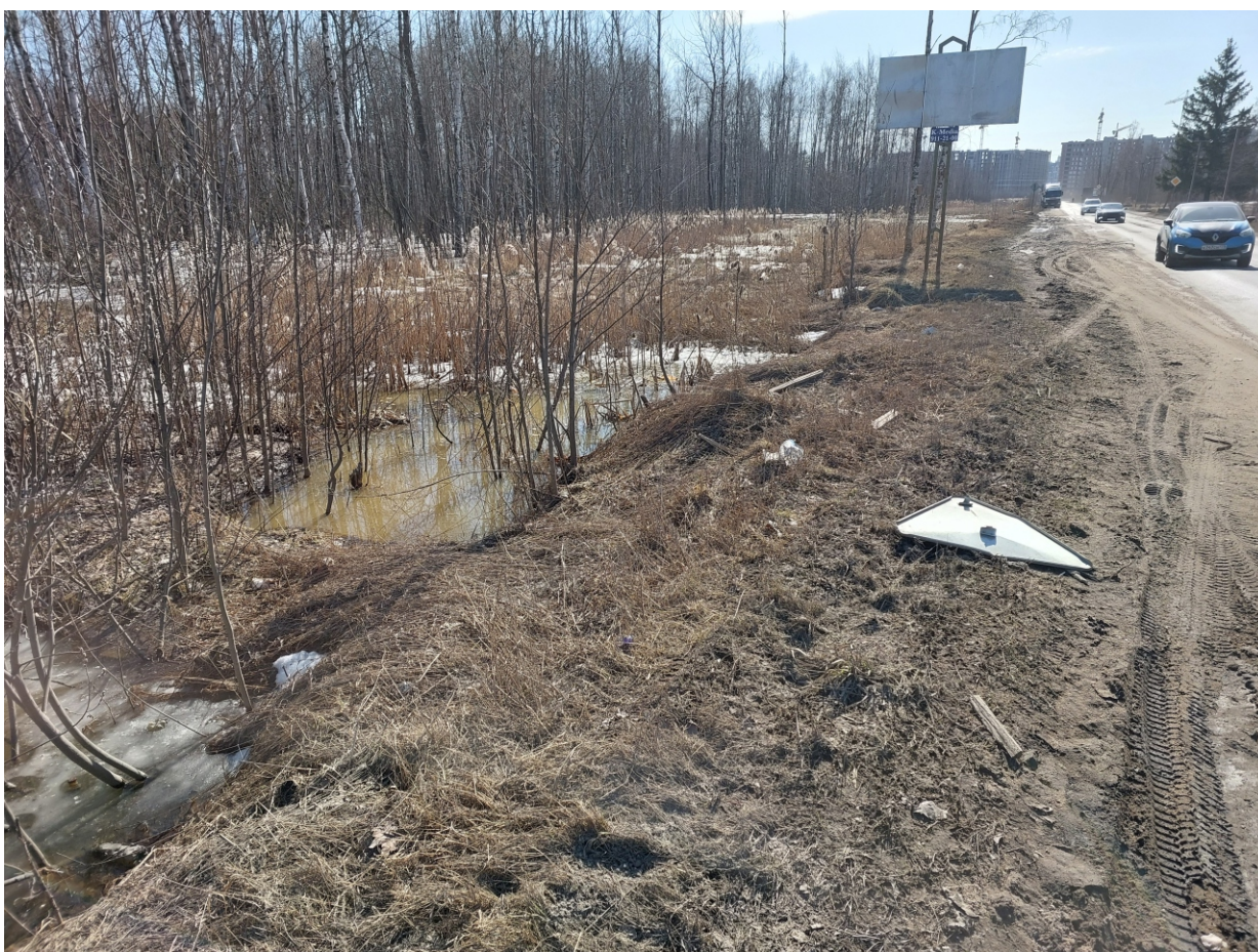
Точка фотофиксации 2. Северная часть территории обследования. Вид с С.
