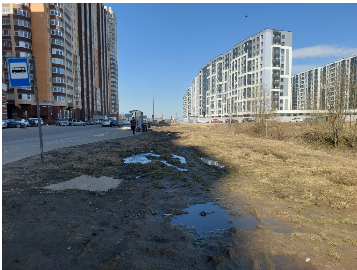
Точка фотофиксации 15. Южная часть территории обследования. Вид с ЮВ.
