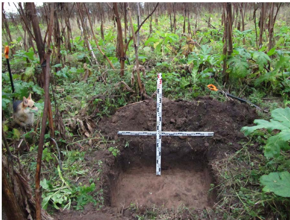
Рис. 255. Ленинградская область, Лужский район. Межпоселковый газопровод до п. Оредеж – д. Борщово – д. Ям-Тесово – п. Приозерный. Шурф 59. Общий вид зачистки по материке. Вид с юга
