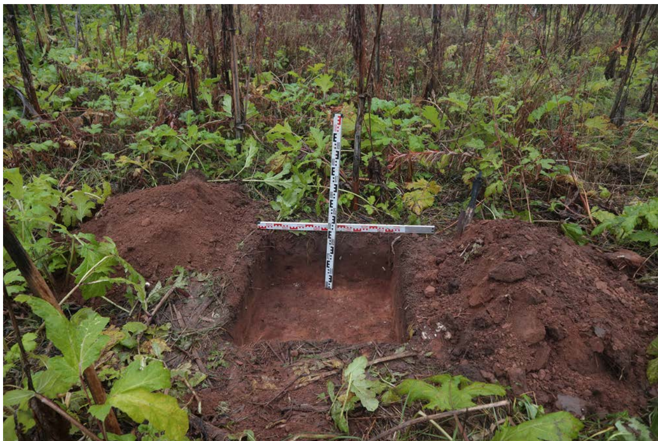
Рис. 160. Ленинградская область, Лужский район. Межпоселковый газопровод до п. Оредеж – д. Борщово – д. Ям-Тесово – п. Приозерный. Шурф 38. Общий вид зачистки по материк. Вид с юга
