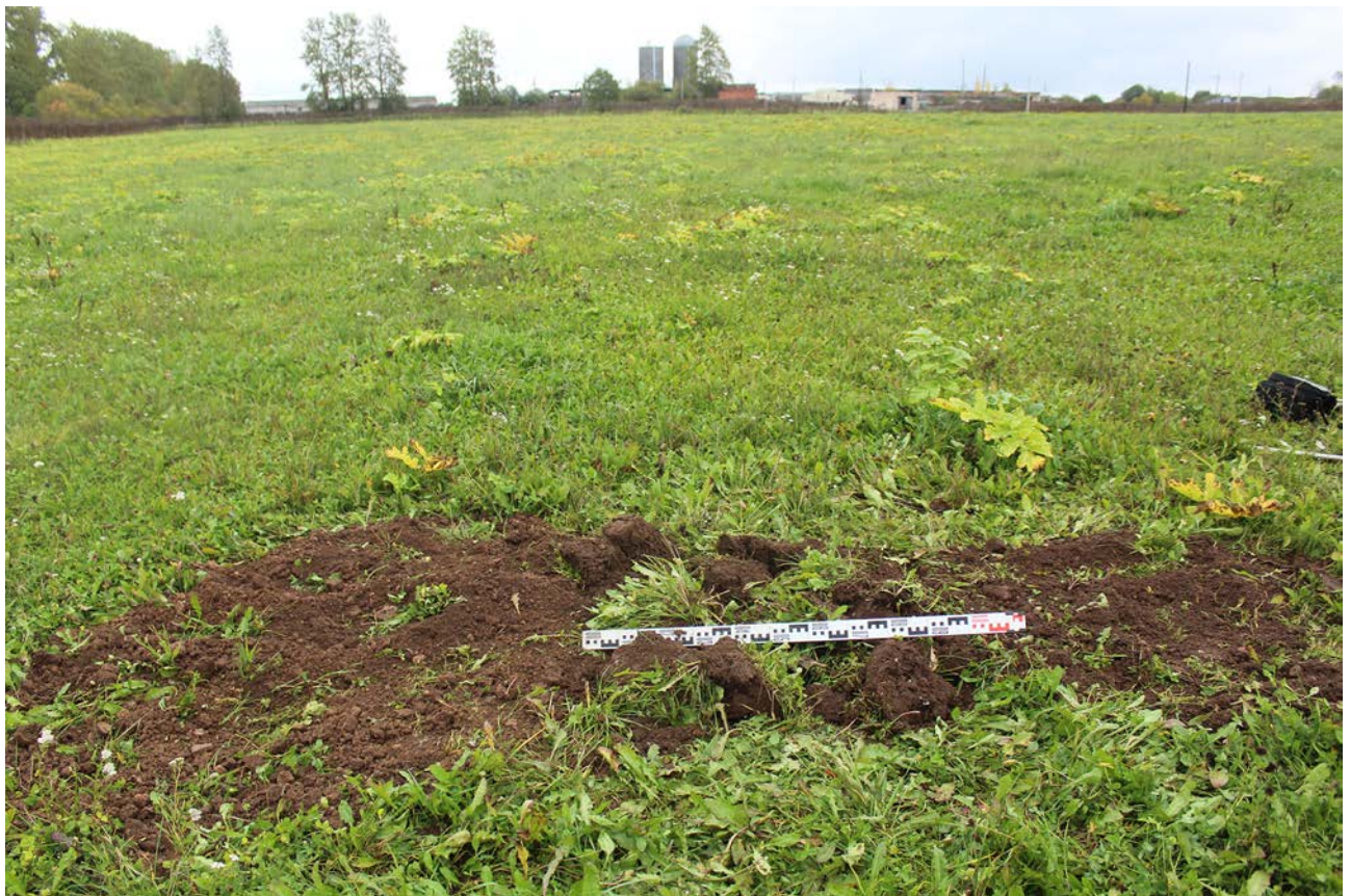
Рис. 238. Ленинградская область, Лужский район. Межпоселковый газопровод до п. Оредеж – д. Борщово – д. Ям-Тесово – п. Приозерный. Шурф 54. Рекультивация. Вид с юга
