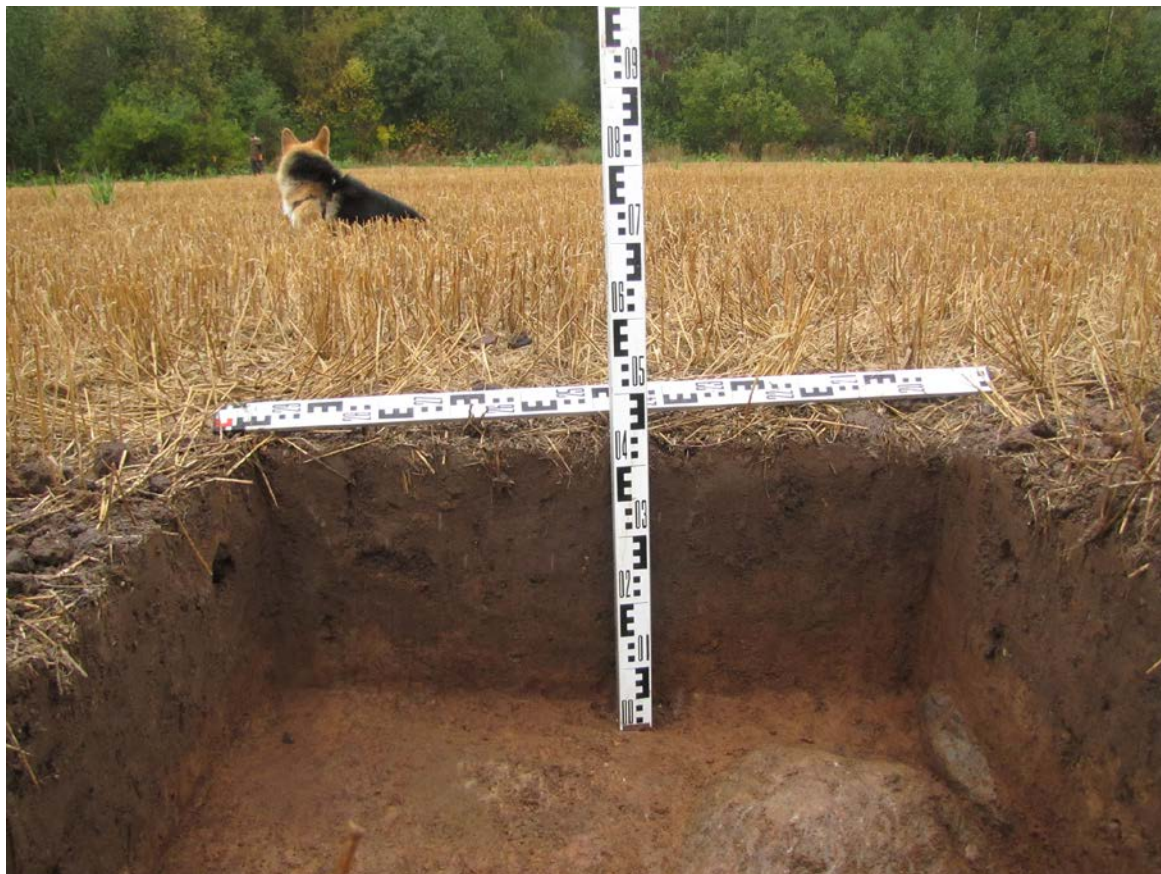
Рис. 61. Ленинградская область, Лужский район. Межпоселковый газопровод до п. Оредеж – д. Борщово – д. Ям-Тесово – п. Приозерный. Шурф 13. Стратиграфия северной стенки. Вид с юга
