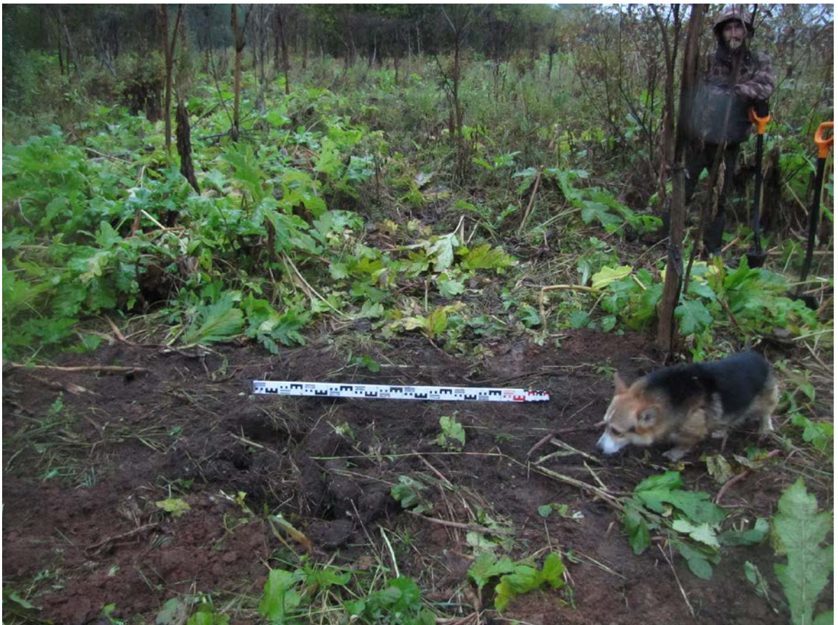
Рис. 154. Ленинградская область, Лужский район. Межпоселковый газопровод до п. Оредеж – д. Борщово – д. Ям-Тесово – п. Приозерный. Шурф 36. Рекультивация. Вид с юга
