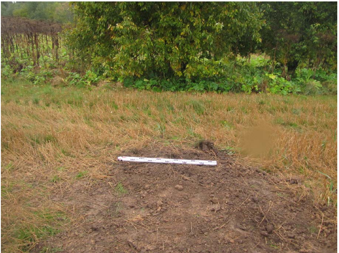
Рис. 22. Ленинградская область, Лужский район. Межпоселковый газопровод до п. Оредеж – д. Борщово – д. Ям-Тесово – п. Приозерный. Шурф 3. Рекультивация. Вид с юга
