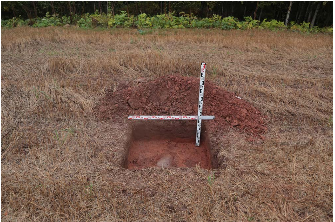
Рис. 48. Ленинградская область, Лужский район. Межпоселковый газопровод до п. Оредеж – д. Борщово – д. Ям-Тесово – п. Приозерный. Шурф 10. Общий вид зачистки по матерiku. Вид с юга
