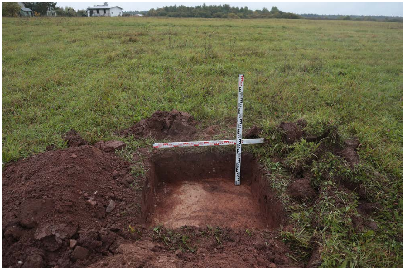
Рис. 92. Ленинградская область, Лужский район. Межпоселковый газопровод до п. Оредеж – д. Борщово – д. Ям-Тесово – п. Приозерный. Шурф 21. Общий вид зачистки по матерiku. Вид с юга
