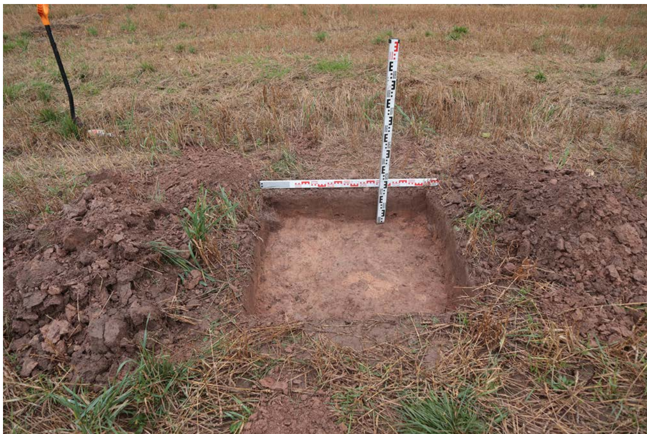
Рис. 32. Ленинградская область, Лужский район. Межпоселковый газопровод до п. Оредеж – д. Борщово – д. Ям-Тесово – п. Приозерный. Шурф 6. Общий вид зачистки по матерiku. Вид с юга
