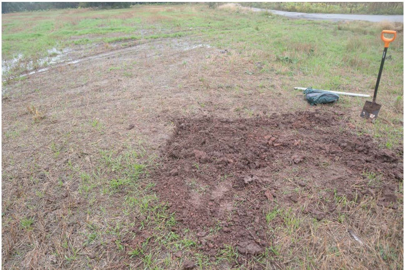
Рис. 146. Ленинградская область, Лужский район. Межпоселковый газопровод до п. Оредеж – д. Борщово – д. Ям-Тесово – п. Приозерный. Шурф 34. Рекультивация. Вид с юга
