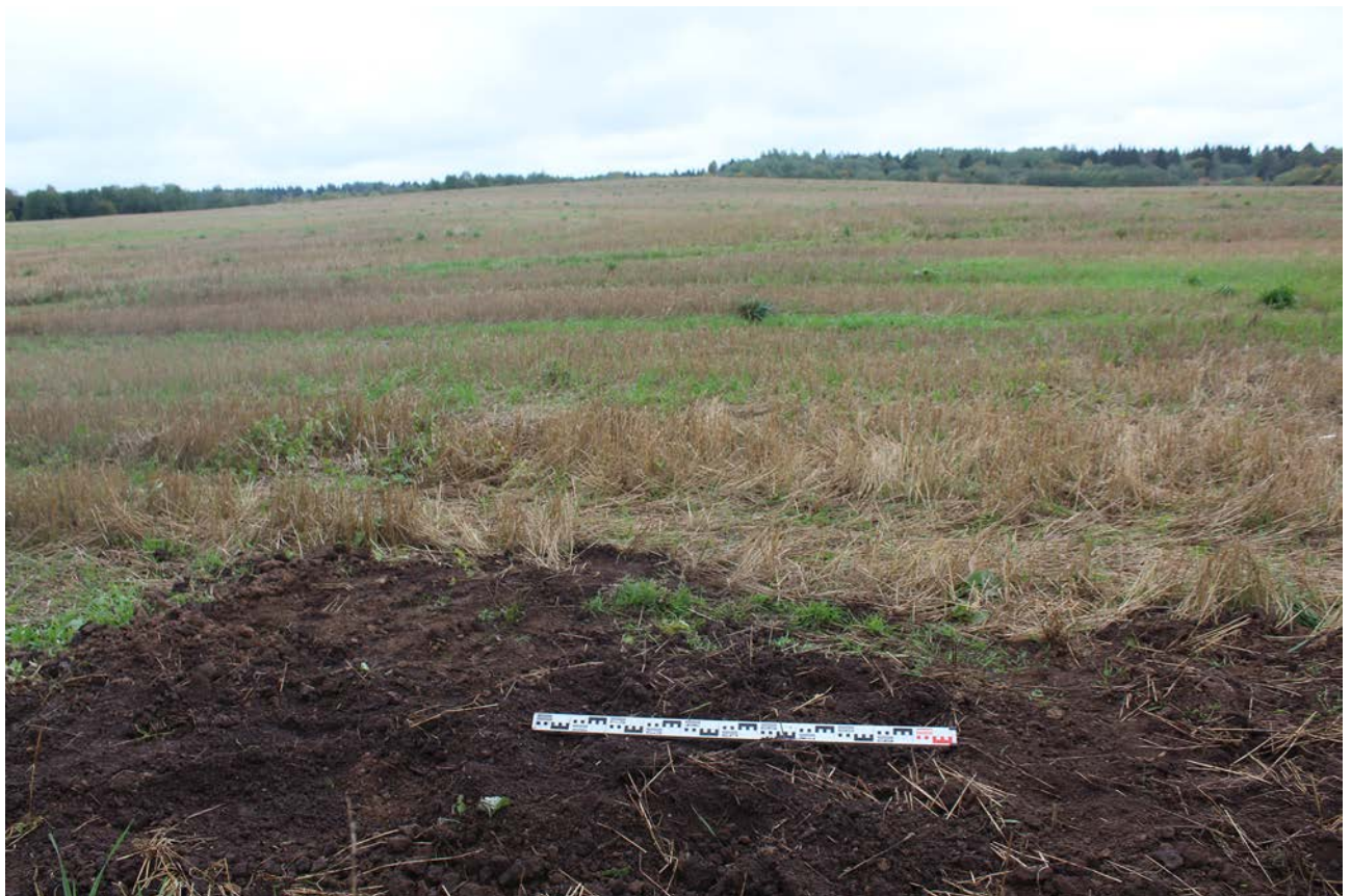
Рис. 192. Ленинградская область, Лужский район. Межпоселковый газопровод до п. Оредеж – д. Борщово – д. Ям-Тесово – п. Приозерный. Шурф 45. Рекультивация. Вид с юга
