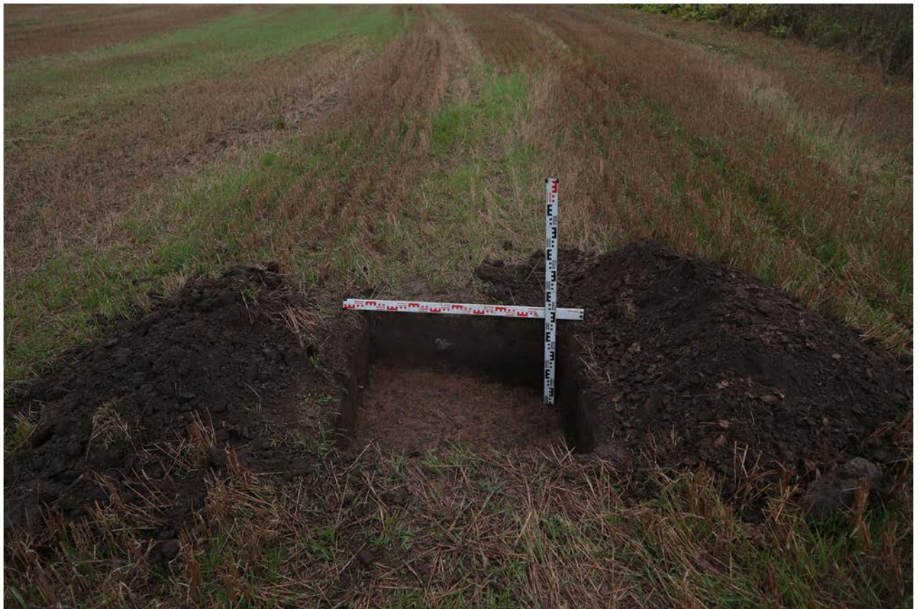
Рис. 104. Ленинградская область, Лужский район. Межпоселковый газопровод до п. Оредеж – д. Борщово – д. Ям-Тесово – п. Приозерный. Шурф 24. Общий вид зачистки по материке. Вид с юга
