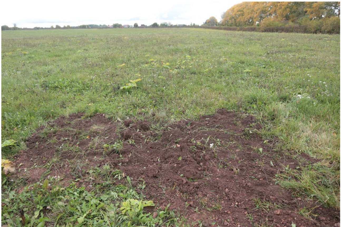
Рис. 222. Ленинградская область, Лужский район. Межпоселковый газопровод до п. Оредеж – д. Борщово – д. Ям-Тесово – п. Приозерный. Шурф 50. Рекультивация. Вид с юга
