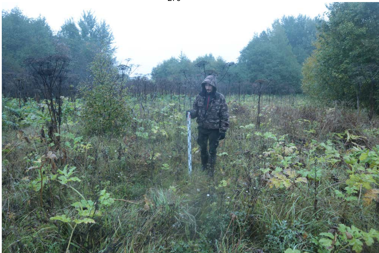
Рис. 171. Ленинградская область, Лужский район. Межпоселковый газопровод до п. Оредеж – д. Борщово – д. Ям-Тесово – п. Приозерный. Шурф 41. Общий вид до начала работ. Вид с юга
