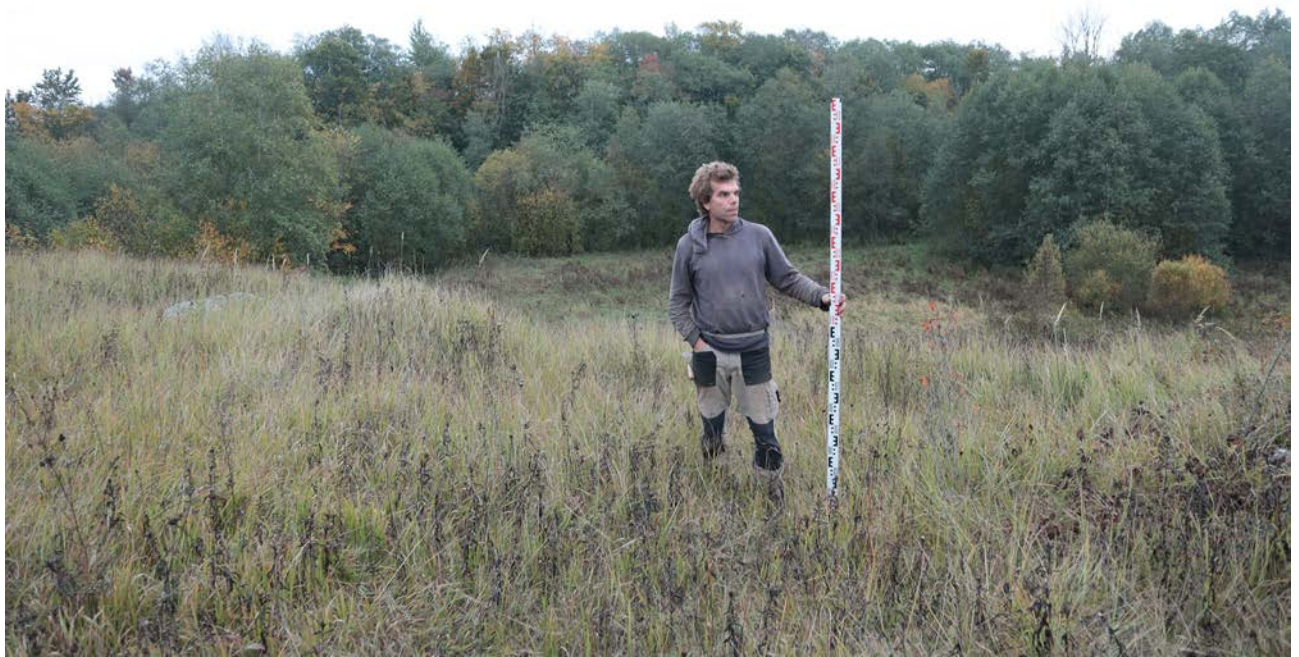
Рис. 338. Ленинградская область, Лужский район. Межпоселковый газопровод до п. Оредеж – д. Борщово – д. Ям-Тесово – п. Приозерный. Шурф 79. Общий вид до начала работ. Вид с юга
