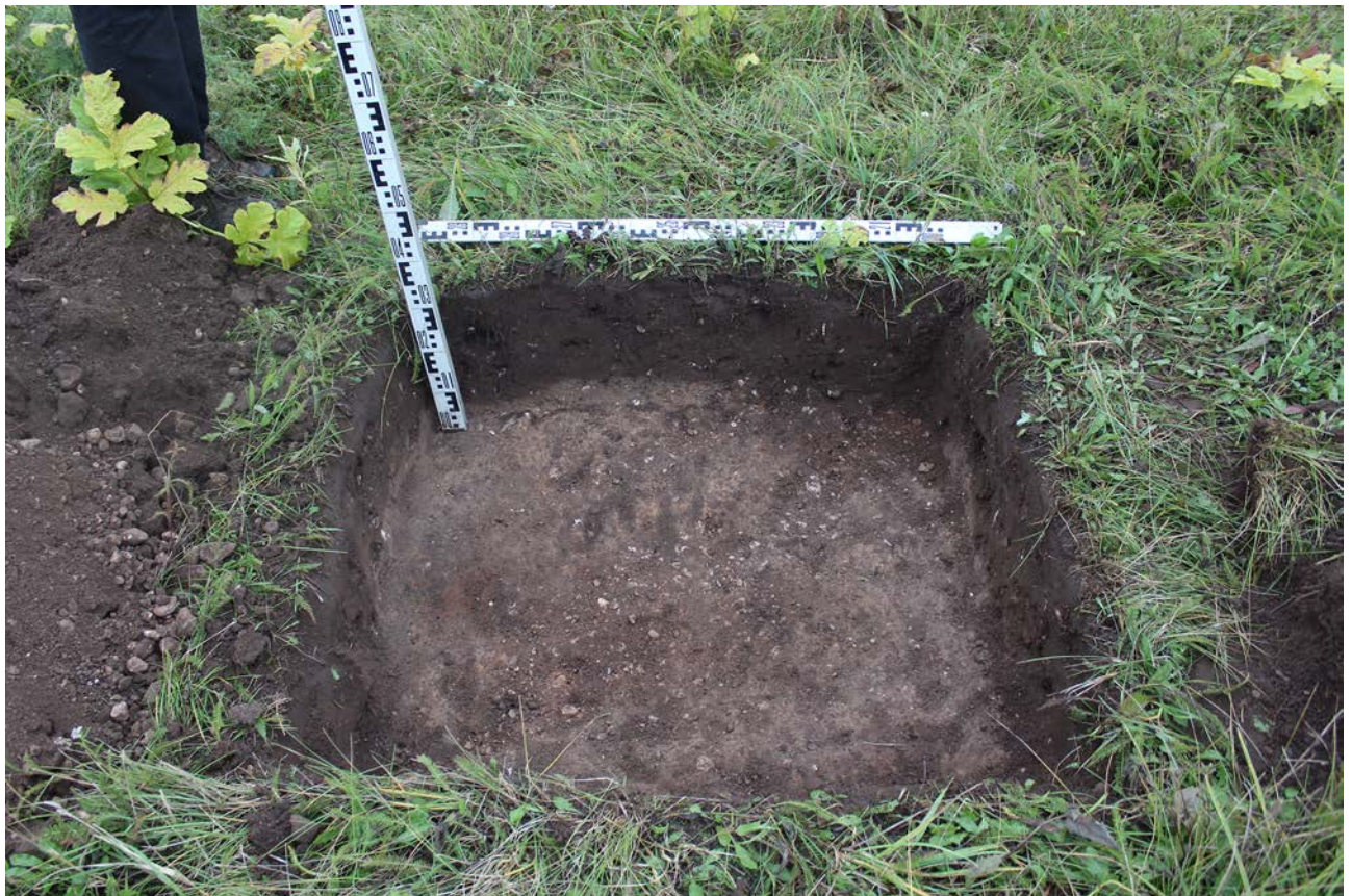
Рис. 279. Ленинградская область, Лужский район. Межпоселковый газопровод до п. Оредеж – д. Борщово – д. Ям-Тесово – п. Приозерный. Шурф 65. Общий вид зачистки по материке. Вид с юга
