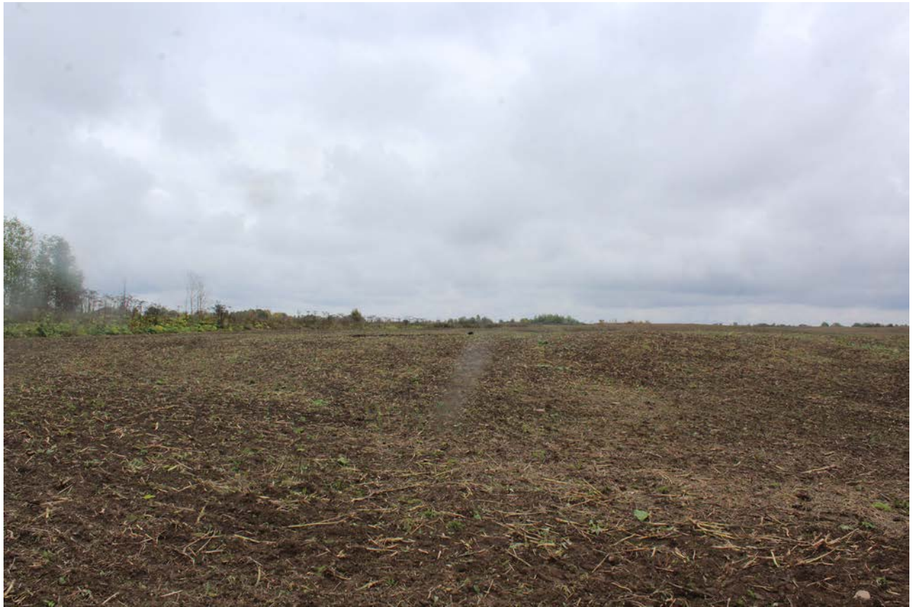
Рис. 217. Ленинградская область, Лужский район. Межпоселковый газопровод до п. Оредеж – д. Борщово – д. Ям-Тесово – п. Приозерный. Прохождение трассы проектируемого газопровода между д. Моровино и д. Ям-Тесово. Вид с запада
