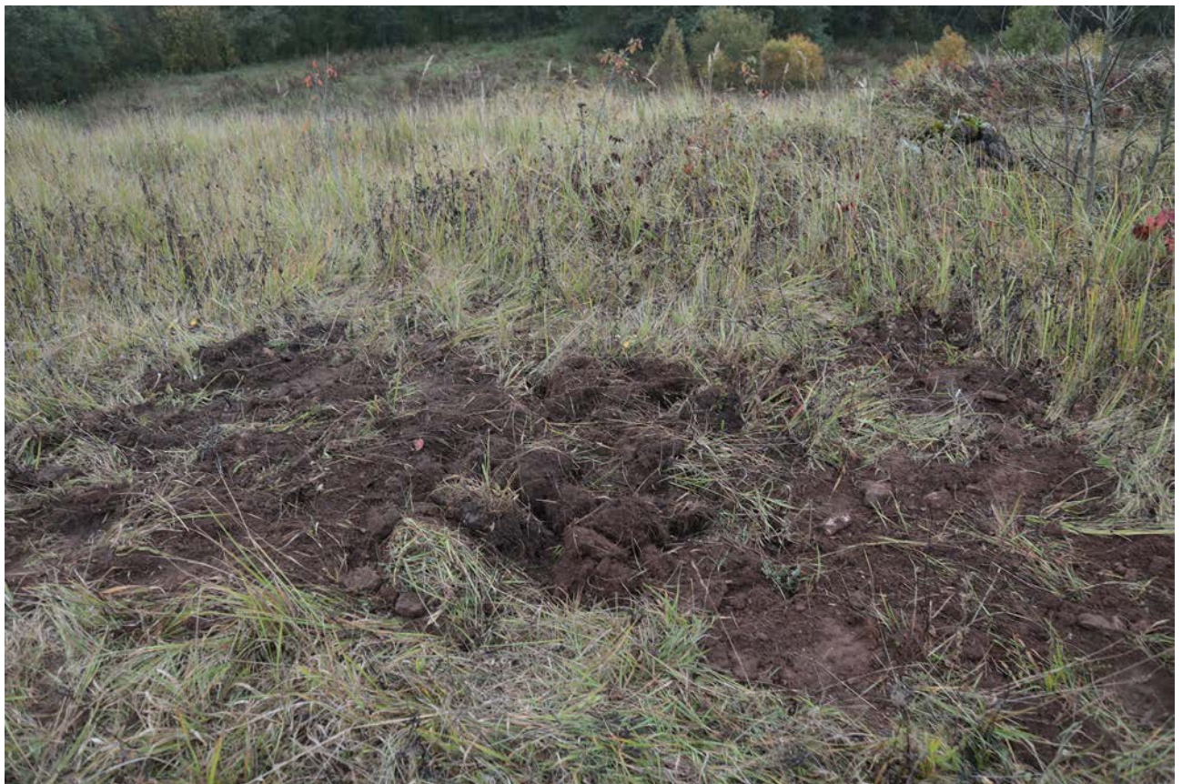
Рис. 341. Ленинградская область, Лужский район. Межпоселковый газопровод до п. Оредеж – д. Борщово – д. Ям-Тесово – п. Приозерный. Шурф 79. Рекультивация. Вид с юга
