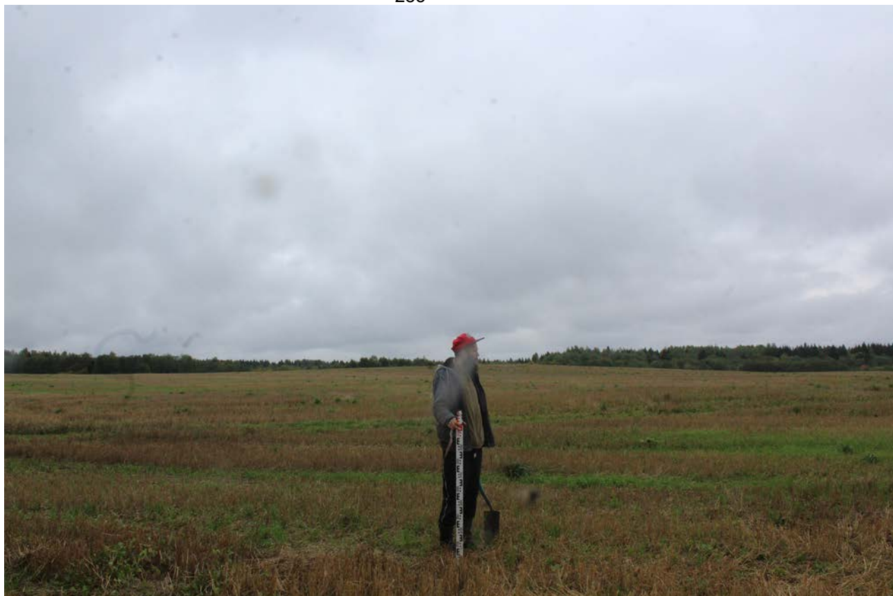
Рис. 189. Ленинградская область, Лужский район. Межпоселковый газопровод до п. Оредеж – д. Борщово – д. Ям-Тесово – п. Приозерный. Шурф 45. Общий вид до начала работ. Вид с юга
