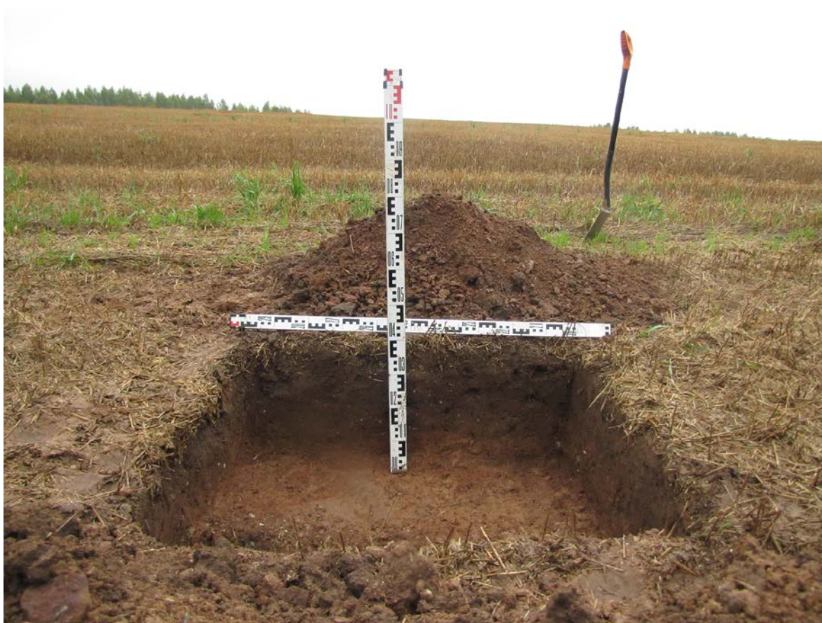
Рис. 68. Ленинградская область, Лужский район. Межпоселковый газопровод до п. Оредеж – д. Борщово – д. Ям-Тесово – п. Приозерный. Шурф 15. Общий вид зачистки по материку. Вид с юга
