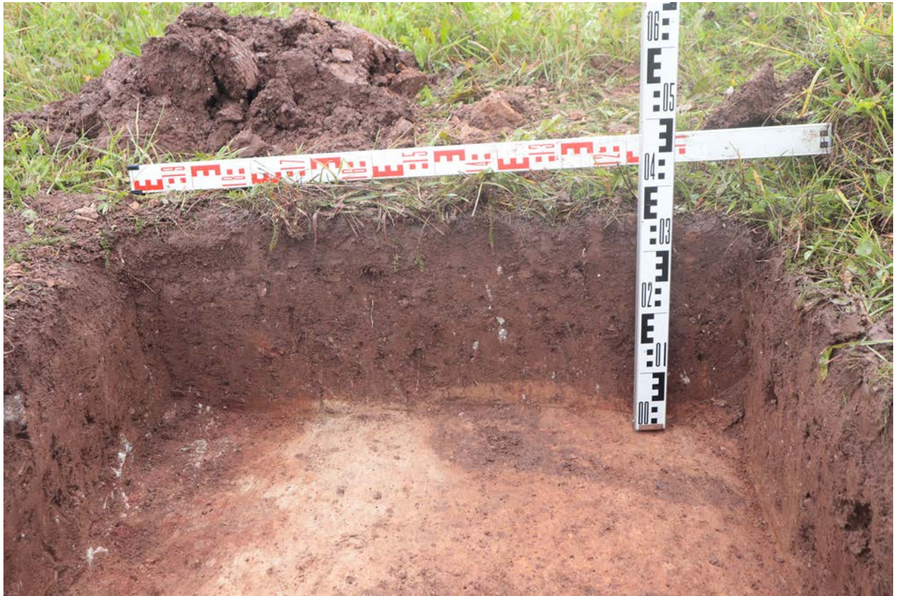
Рис. 93. Ленинградская область, Лужский район. Межпоселковый газопровод до п. Оредеж – д. Борщово – д. Ям-Тесово – п. Приозерный. Шурф 21. Стратиграфия северной стенки. Вид с юга
