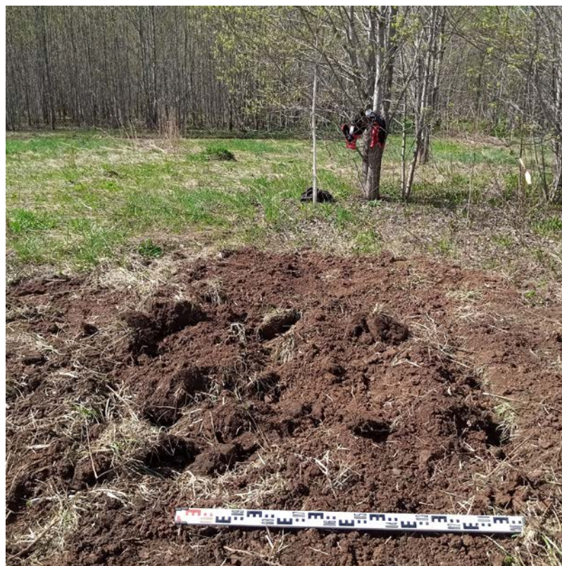
Рис.397. Ленинградская область, Лужский район. Межпоселковый газопровод до п. Оредеж – д. Борщово – д. Ям-Тесово – п. Приозерный. Шурф 93. Рекультивация. Вид с юга
