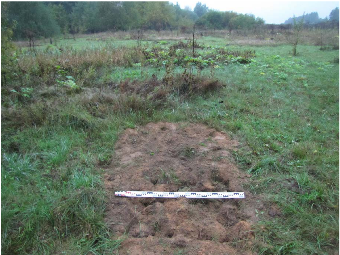
Рис. 158. Ленинградская область, Лужский район. Межпоселковый газопровод до п. Оредеж – д. Борщово – д. Ям-Тесово – п. Приозерный. Шурф 37. Рекультивация. Вид с юга
