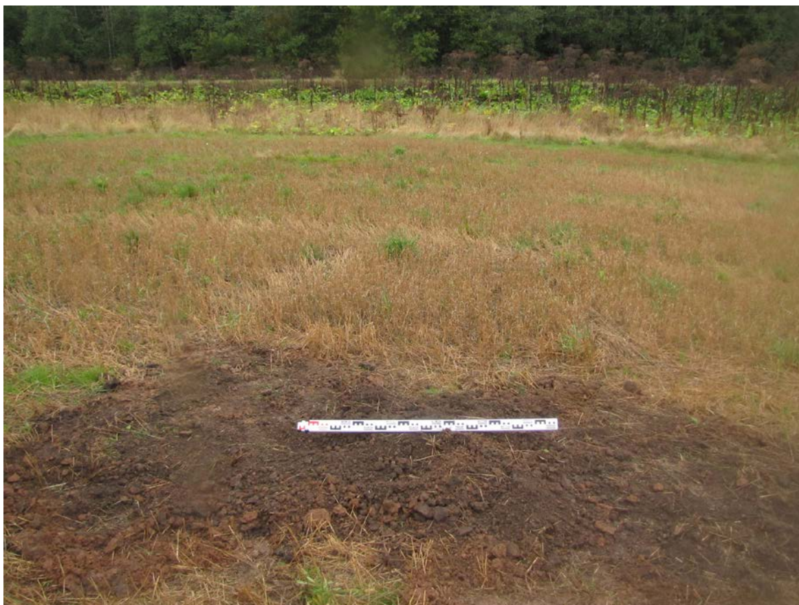
Рис. 26. Ленинградская область, Лужский район. Межпоселковый газопровод до п. Оредеж – д. Борцово – д. Ям-Тесово – п. Приозерный. Шурф 4. Рекультивация. Вид с юга
