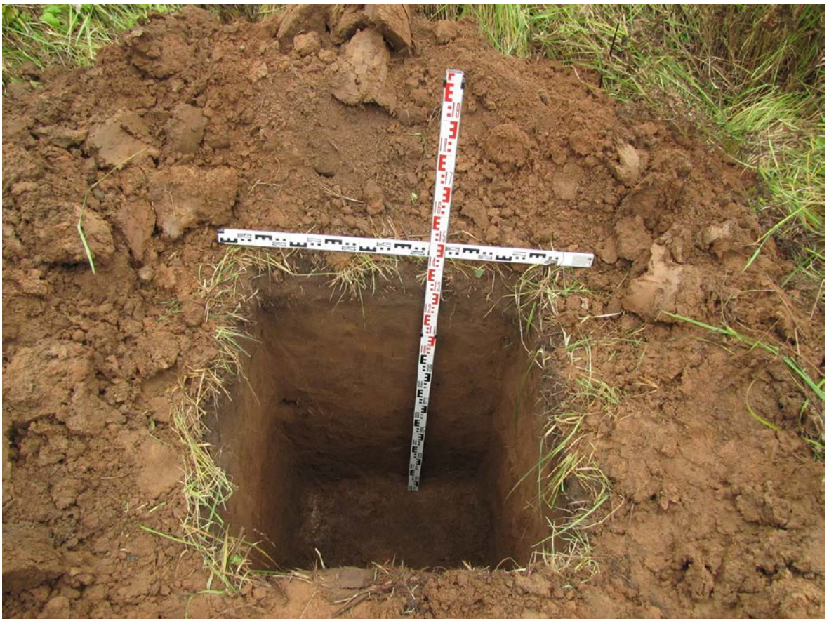
Рис. 331. Ленинградская область, Лужский район. Межпоселковый газопровод до п. Оредеж – д. Борщово – д. Ям-Тесово – п. Приозерный. Шурф 77. Общий вид зачистки по материкову. Вид с юга
