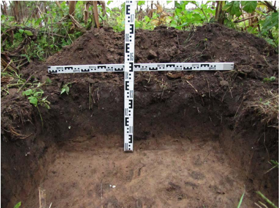
Рис. 256. Ленинградская область, Лужский район. Межпоселковый газопровод до п. Оредеж – д. Борщово – д. Ям-Тесово – п. Приозерный. Шурф 59. Стратиграфия северной стенки. Вид с юга
