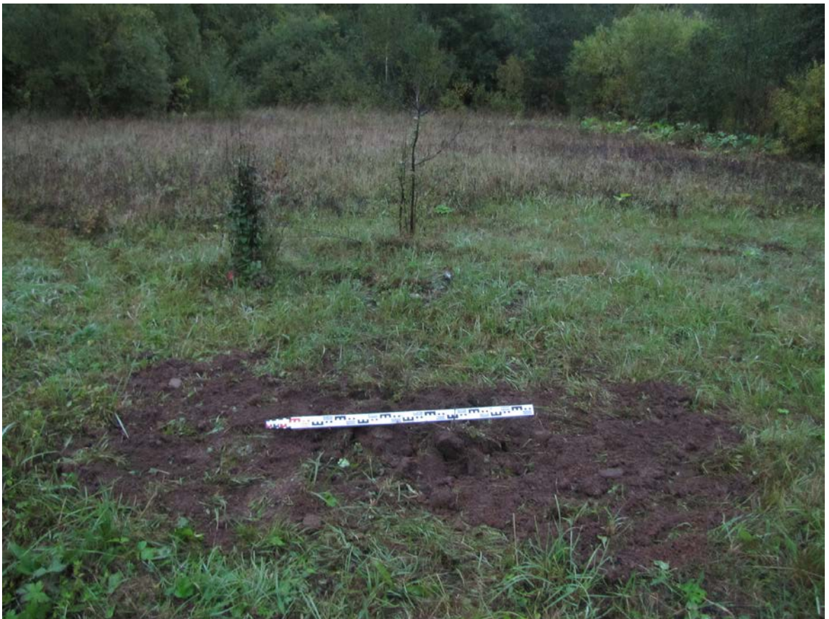
Рис. 150. Ленинградская область, Лужский район. Межпоселковый газопровод до п. Оредеж – д. Борщово – д. Ям-Тесово – п. Приозерный. Шурф 35. Рекультивация. Вид с юга
