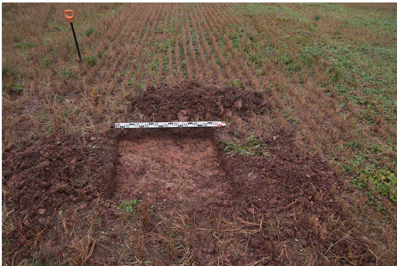
Рис. 128. Ленинградская область, Лужский район. Межпоселковый газопровод до п. Оредеж – д. Борщово – д. Ям-Тесово – п. Приозерный. Шурф 30. Общий вид зачистки по материке. Вид с юга
