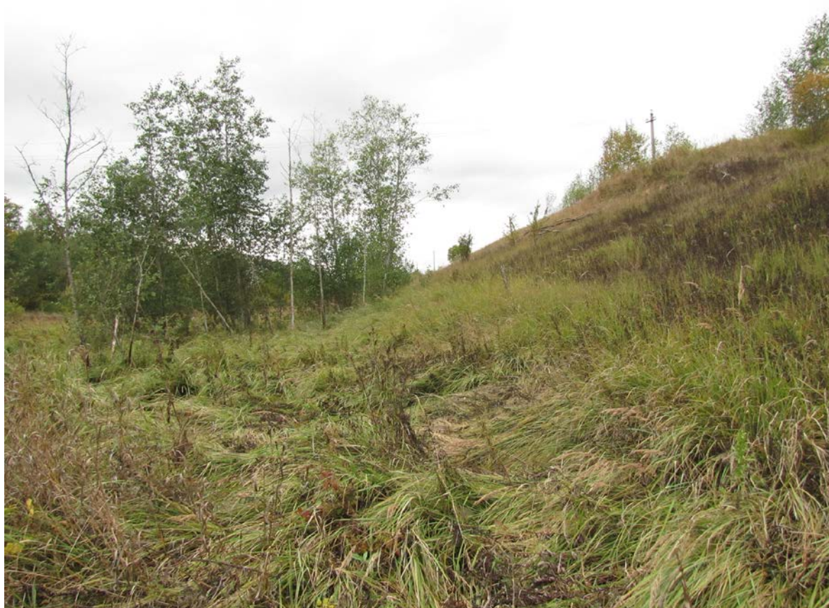
Рис. 329. Ленинградская область, Лужский район. Межпоселковый газопровод до п. Оредеж – д. Борщово – д. Ям-Тесово – п. Приозерный. Прохождение трассы проектируемого газопровода через р. Тесова. Вид с востока
