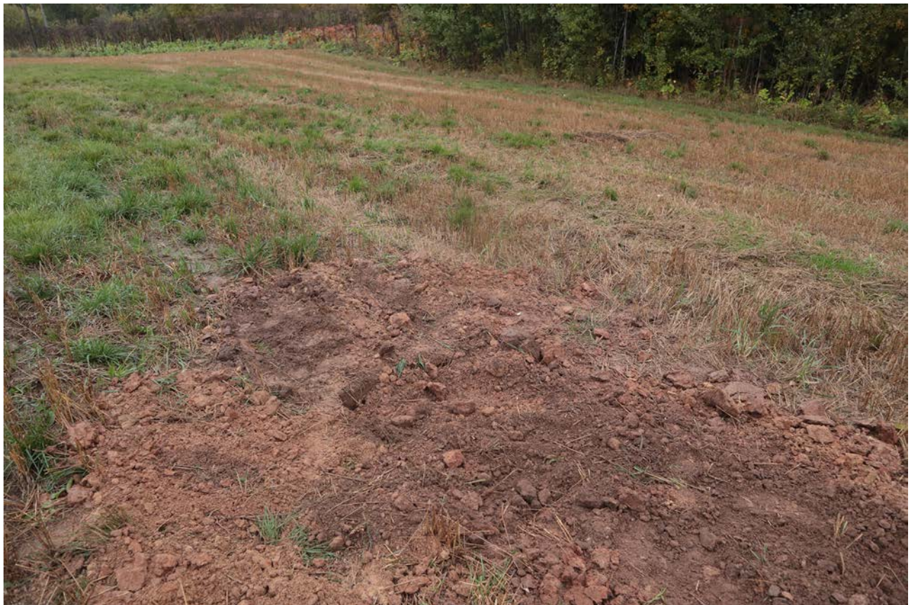
Рис. 38. Ленинградская область, Лужский район. Межпоселковый газопровод до п. Оредеж – д. Борцово – д. Ям-Тесово – п. Приозерный. Шурф 7. Рекультивация. Вид с юга
