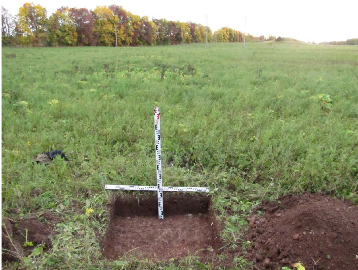
Рис. 309. Ленинградская область, Лужский район. Межпоселковый газопровод до п. Оредеж – д. Борщово – д. Ям-Тесово – п. Приозерный. Шурф 72. Общий вид зачистки по материкову. Вид с юга
