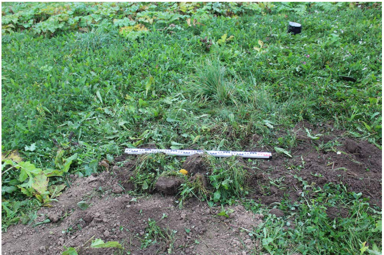
Рис. 230. Ленинградская область, Лужский район. Межпоселковый газопровод до п. Оредеж – д. Борщово – д. Ям-Тесово – п. Приозерный. Шурф 52. Рекультивация. Вид с юга
