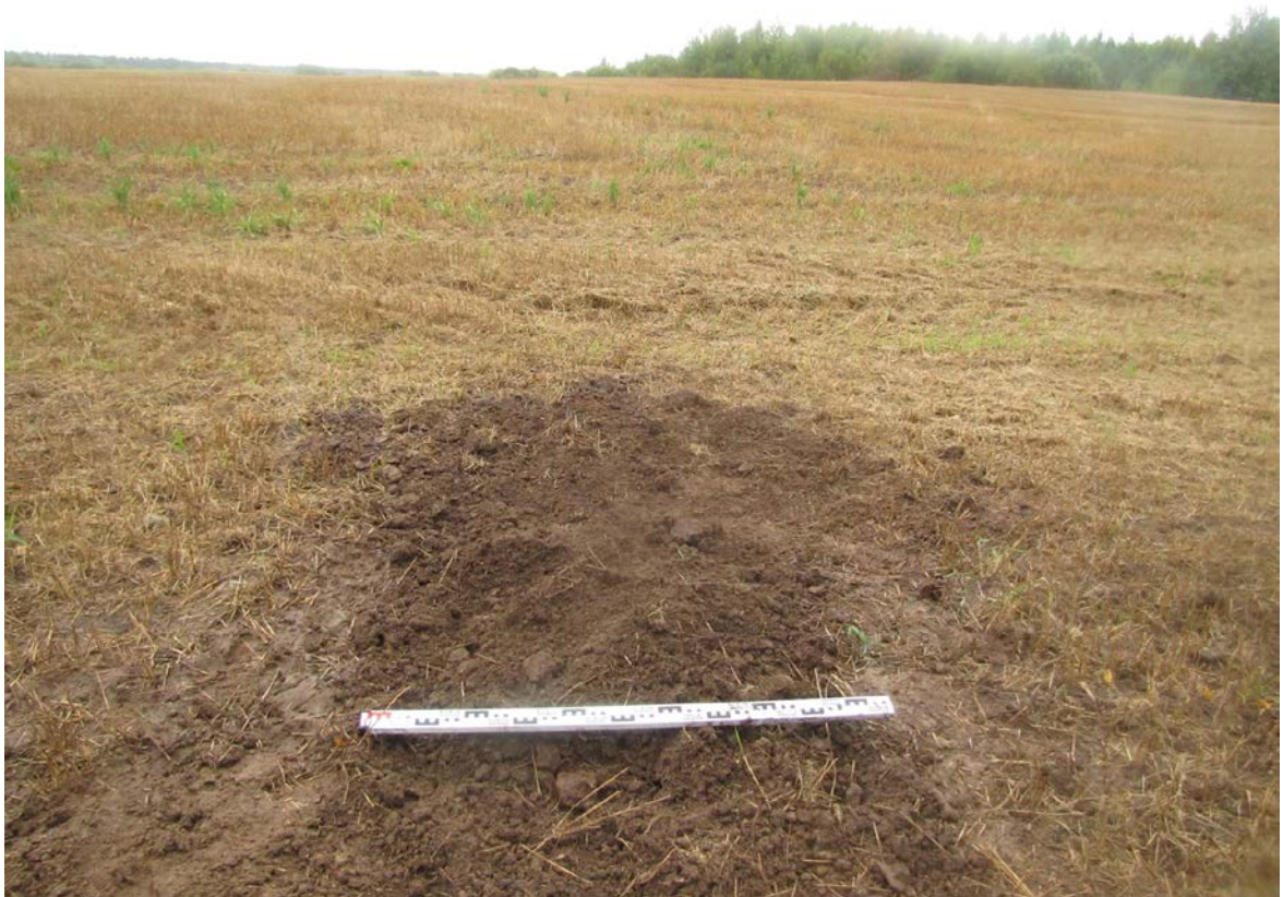
Рис. 78. Ленинградская область, Лужский район. Межпоселковый газопровод до п. Оредеж – д. Борщово – д. Ям-Тесово – п. Приозерный. Шурф 17. Рекультивация. Вид с юга
