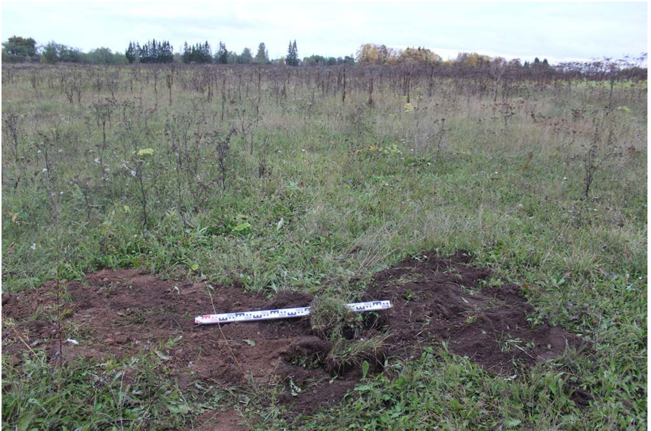
Рис. 269. Ленинградская область, Лужский район. Межпоселковый газопровод до п. Оредеж – д. Борщово – д. Ям-Тесово – п. Приозерный. Шурф 62. Рекультивация. Вид с юга
