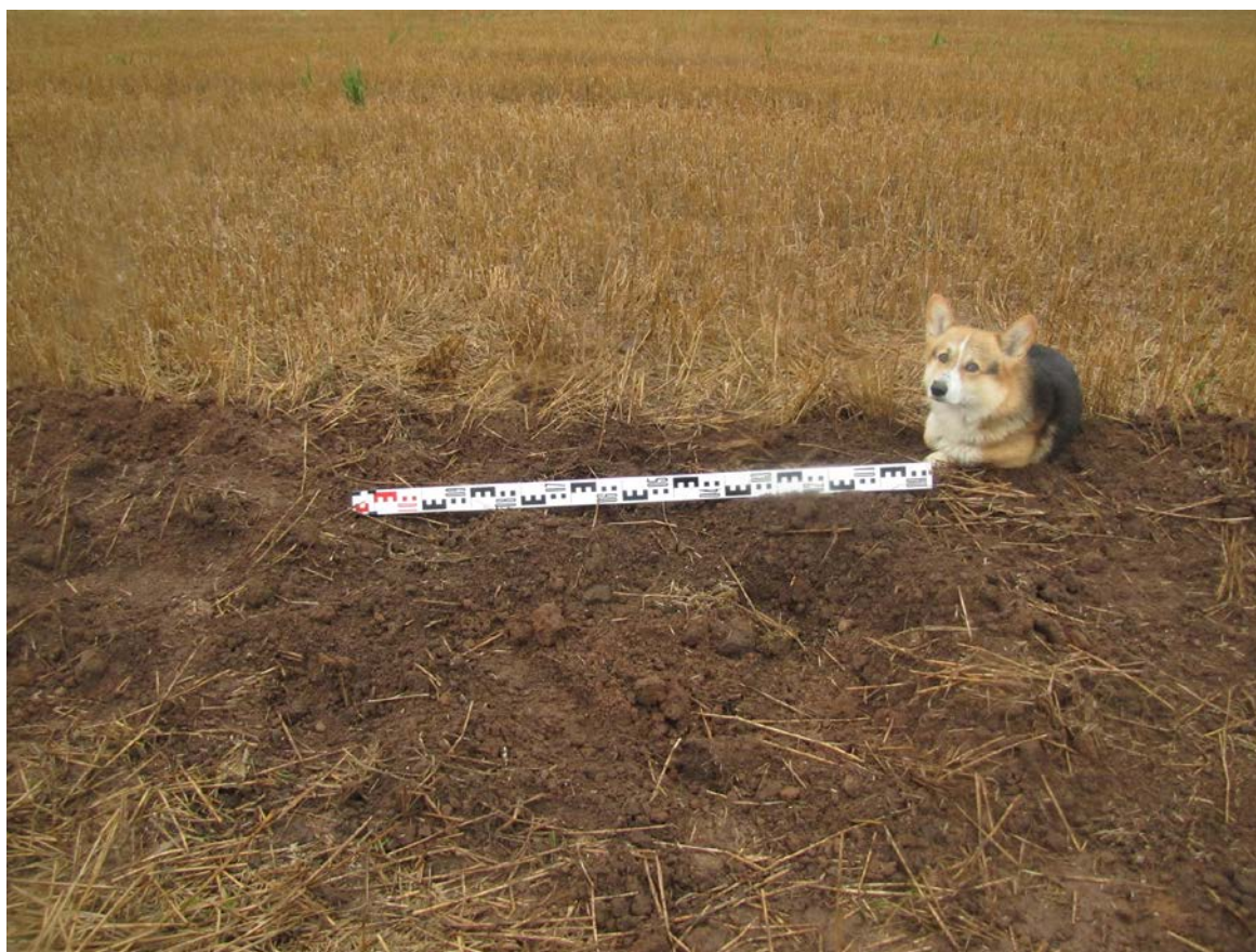
Рис. 62. Ленинградская область, Лужский район. Межпоселковый газопровод до п. Оредеж – д. Борщово – д. Ям-Тесово – п. Приозерный. Шурф 13. Рекультивация. Вид с юга
