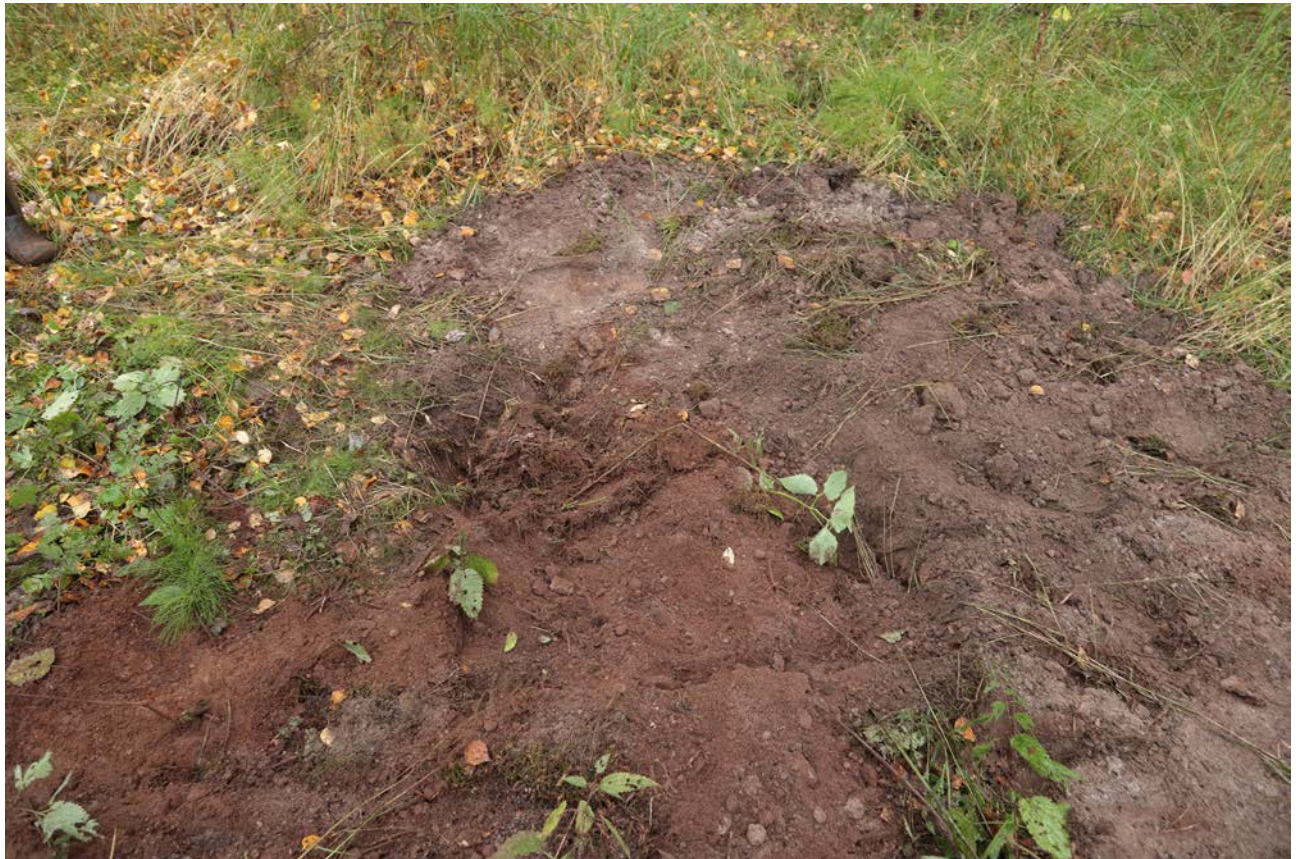
Рис. 58. Ленинградская область, Лужский район. Межпоселковый газопровод до п. Оредеж – д. Борщово – д. Ям-Тесово – п. Приозерный. Шурф 12. Рекультивация. Вид с юга
