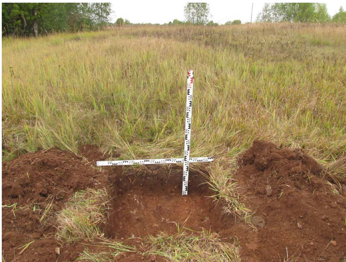
Рис. 363. Ленинградская область, Лужский район. Межпоселковый газопровод до п. Оредеж – д. Борщово – д. Ям-Тесово – п. Приозерный. Шурф 85. Общий вид зачистки по материке. Вид с юга
