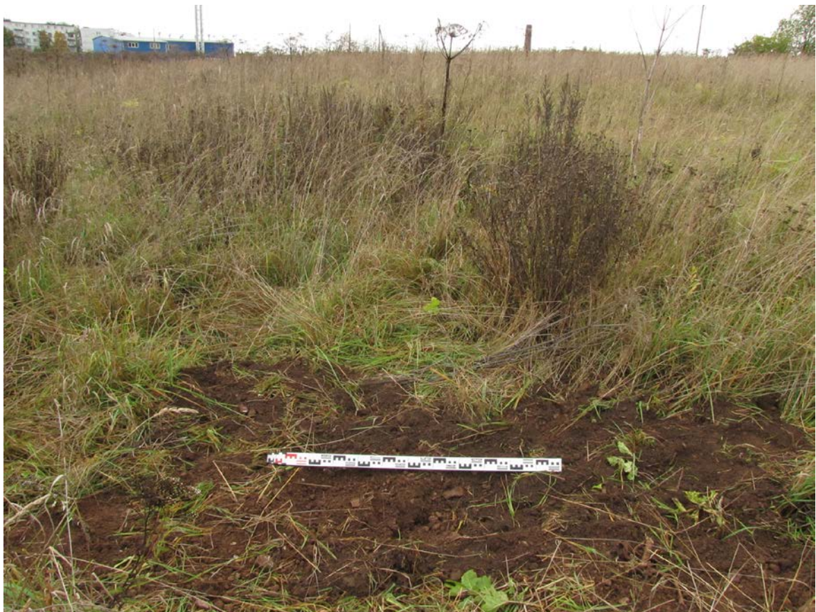
Рис. 301. Ленинградская область, Лужский район. Межпоселковый газопровод до п. Оредеж – д. Борщово – д. Ям-Тесово – п. Приозерный. Шурф 70. Рекультивация. Вид с юга
