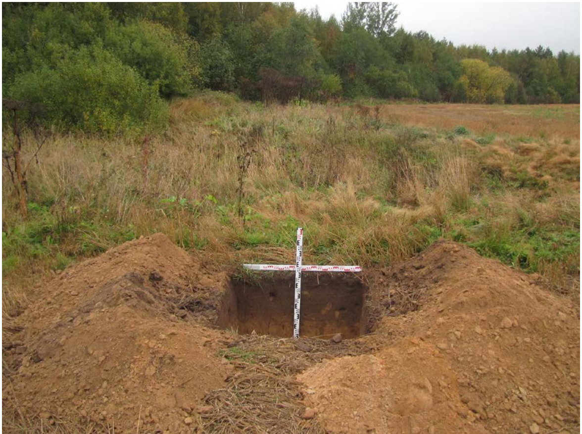
Рис. 64. Ленинградская область, Лужский район. Межпоселковый газопровод до п. Оредеж – д. Борщово – д. Ям-Тесово – п. Приозерный. Шурф 14. Общий вид зачистки по матерiku. Вид с юга
