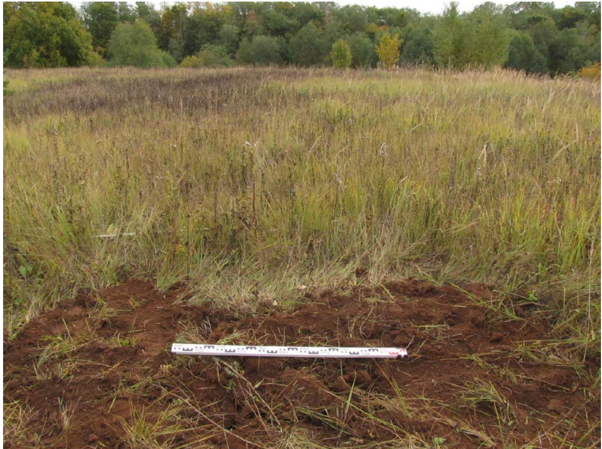
Рис. 373. Ленинградская область, Лужский район. Межпоселковый газопровод до п. Оредеж – д. Борщово – д. Ям-Тесово – п. Приозерный. Шурф 87. Рекультивация. Вид с юга
