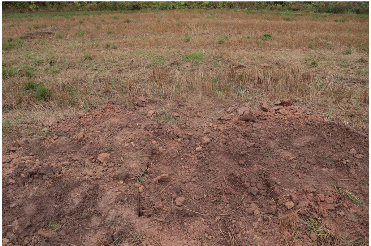
Рис. 42. Ленинградская область, Лужский район. Межпоселковый газопровод до п. Оредеж – д. Борцово – д. Ям-Тесово – п. Приозерный. Шурф 8. Рекультивация. Вид с юга
