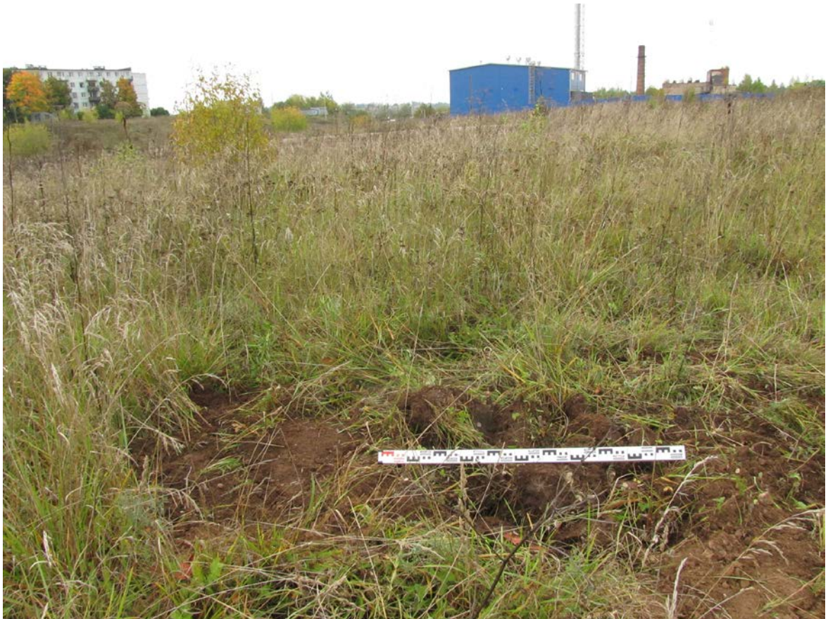
Рис. 285. Ленинградская область, Лужский район. Межпоселковый газопровод до п. Оредеж – д. Борщово – д. Ям-Тесово – п. Приозерный. Шурф 66. Рекультивация. Вид с юга
