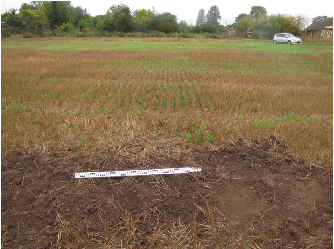
Рис. 114. Ленинградская область, Лужский район. Межпоселковый газопровод до п. Оредеж – д. Борщово – д. Ям-Тесово – п. Приозерный. Шурф 26. Рекультивация. Вид с юга
