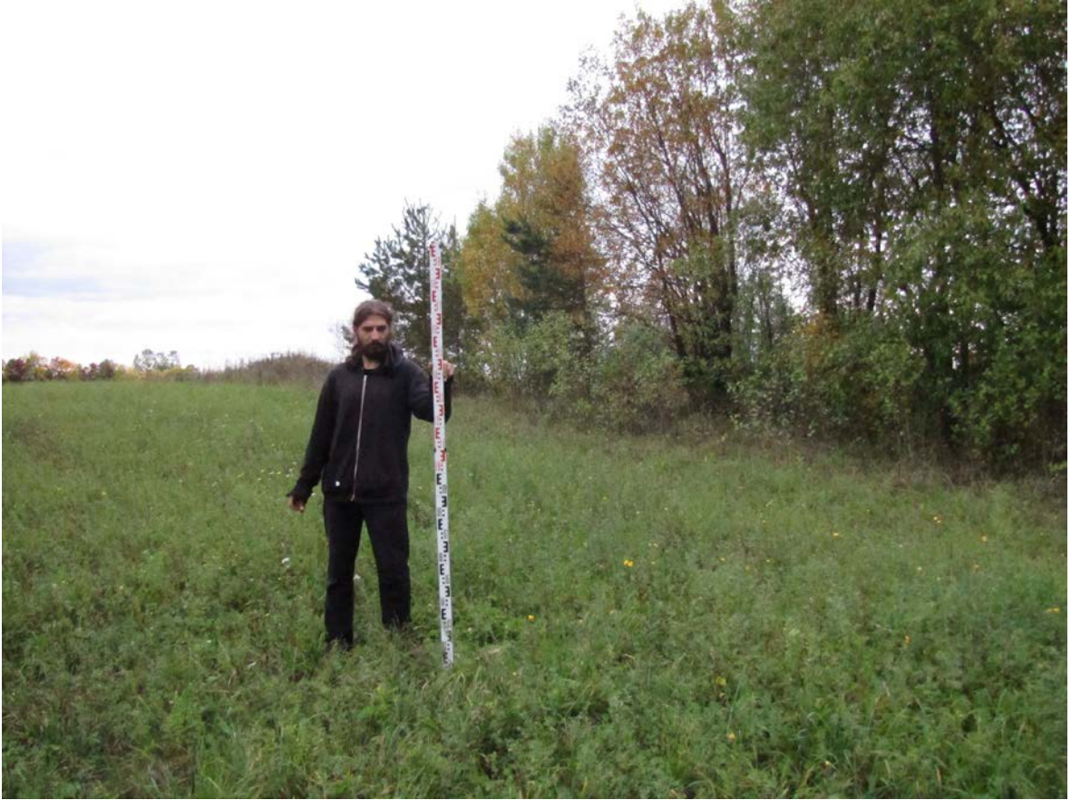
Рис. 324. Ленинградская область, Лужский район. Межпоселковый газопровод до п. Оредеж – д. Борщово – д. Ям-Тесово – п. Приозерный. Шурф 76. Общий вид до начала работ. Вид с юга
