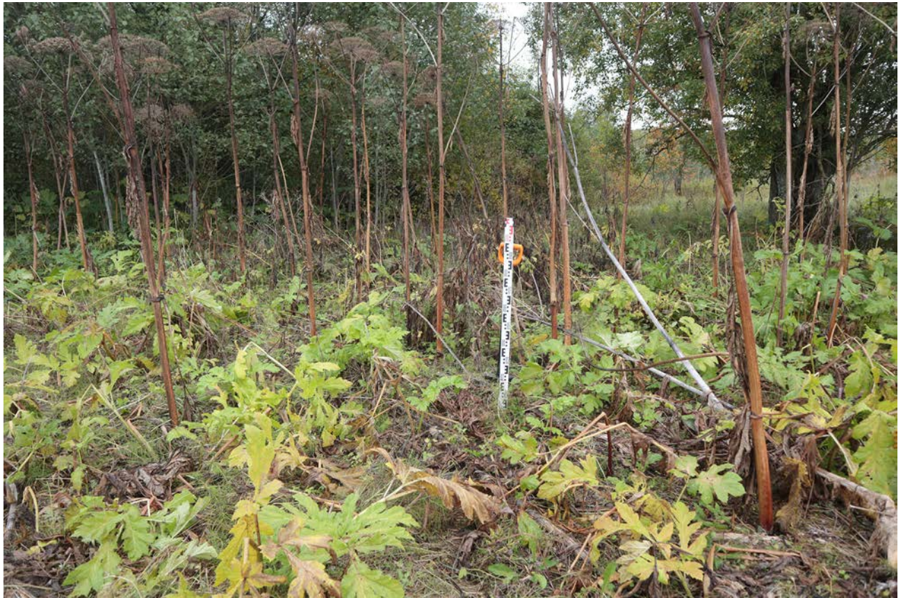
Рис. 378. Ленинградская область, Лужский район. Межпоселковый газопровод до п. Оредеж – д. Борщово – д. Ям-Тесово – п. Приозерный. Шурф 89. Общий вид до начала работ. Вид с юга
