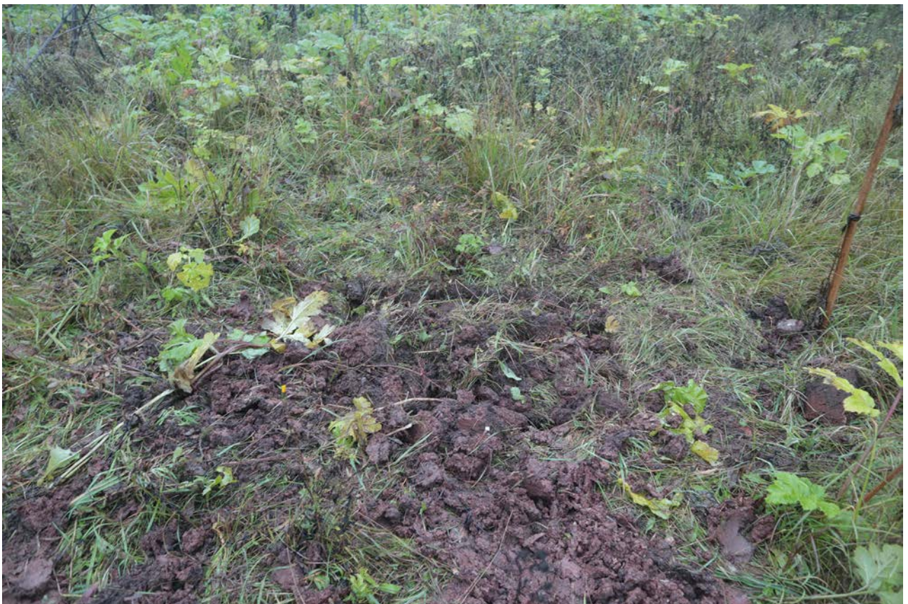
Рис. 170. Ленинградская область, Лужский район. Межпоселковый газопровод до п. Оредеж – д. Борщово – д. Ям-Тесово – п. Приозерный. Шурф 40. Рекультивация. Вид с юга
