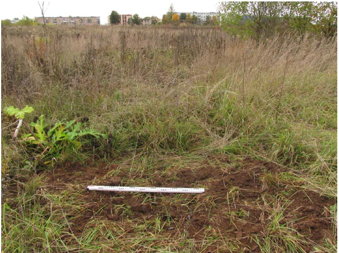
Рис. 297. Ленинградская область, Лужский район. Межпоселковый газопровод до п. Оредеж – д. Борщово – д. Ям-Тесово – п. Приозерный. Шурф 69. Рекультивация. Вид с юга
