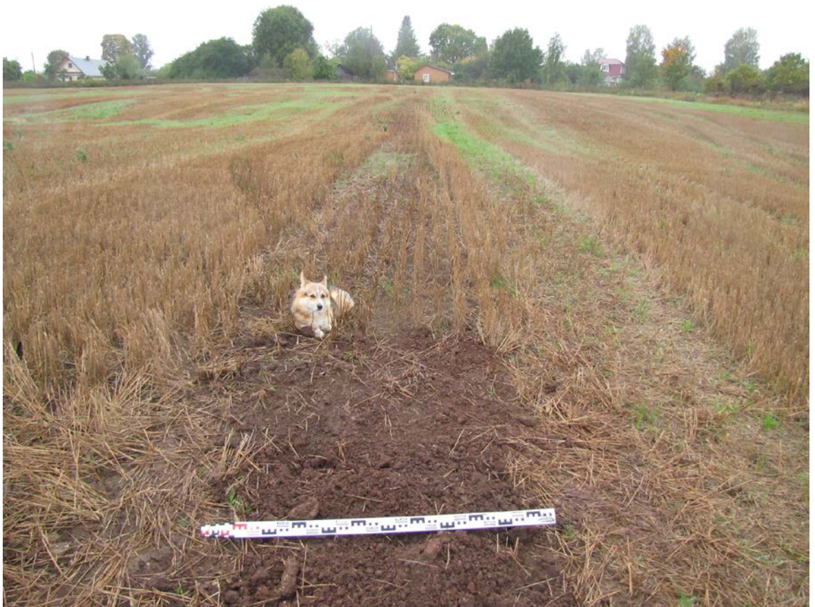
Рис. 122. Ленинградская область, Лужский район. Межпоселковый газопровод до п. Оредеж – д. Борщово – д. Ям-Тесово – п. Приозерный. Шурф 28. Рекультивация. Вид с юга
