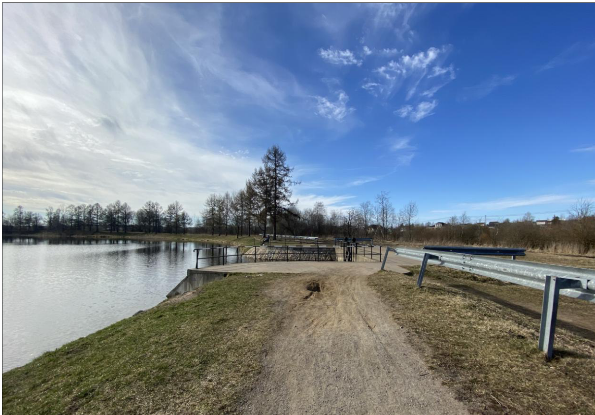
7. Территория объекта культурного наследия федерального значения «Водоподводящая система Петергофа». Вид на северо-запад в сторону Шинкарской улицы от Шинкарского пруда. 21.04.23г.
