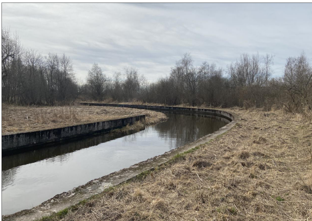
6. Объект культурного наследия федерального значения «Канал Шинкарский». Вид на запад от Шинкарского канала. 21.04.23 г.
