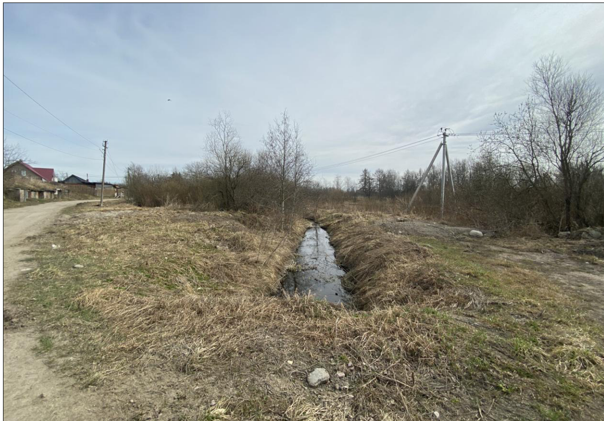
15. Территория объекта культурного наследия федерального значения «Водоподводящая система Петергофа». Вид на юго-восток от дома № 2 по улице Шинкарской. 21.04.23 г.
