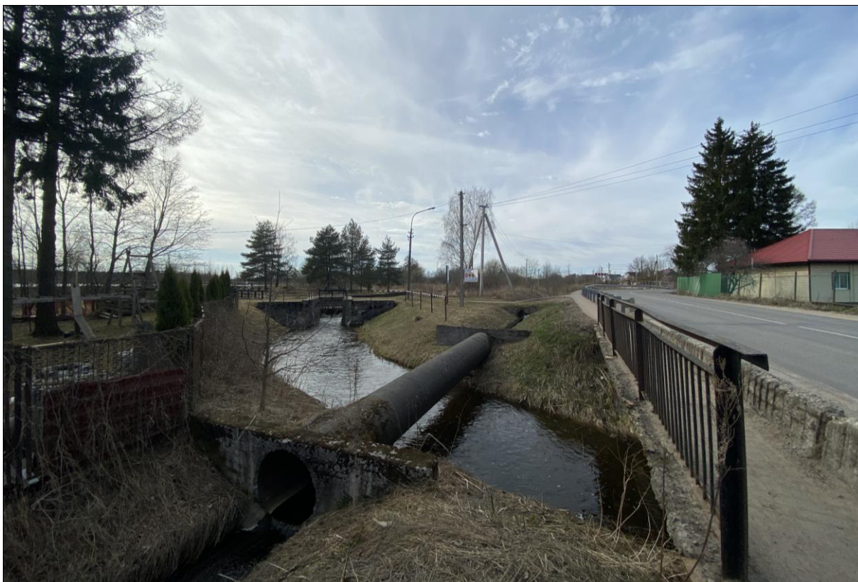
4. Объект культурного наследия федерального значения «Канал Старопетергофский со шлюзом и водоотводным каналом к Царской мельнице». Вид на северо-запад от Санинского шоссе. 21.04.23 г.
