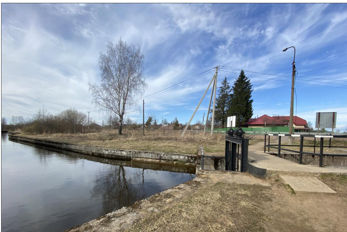
8. Территория объекта культурного наследия федерального значения «Водоподводящая система Петергофа». Вид на северо-запад в сторону Шинкарской улицы от шлюзов. 21.04.23 г.
