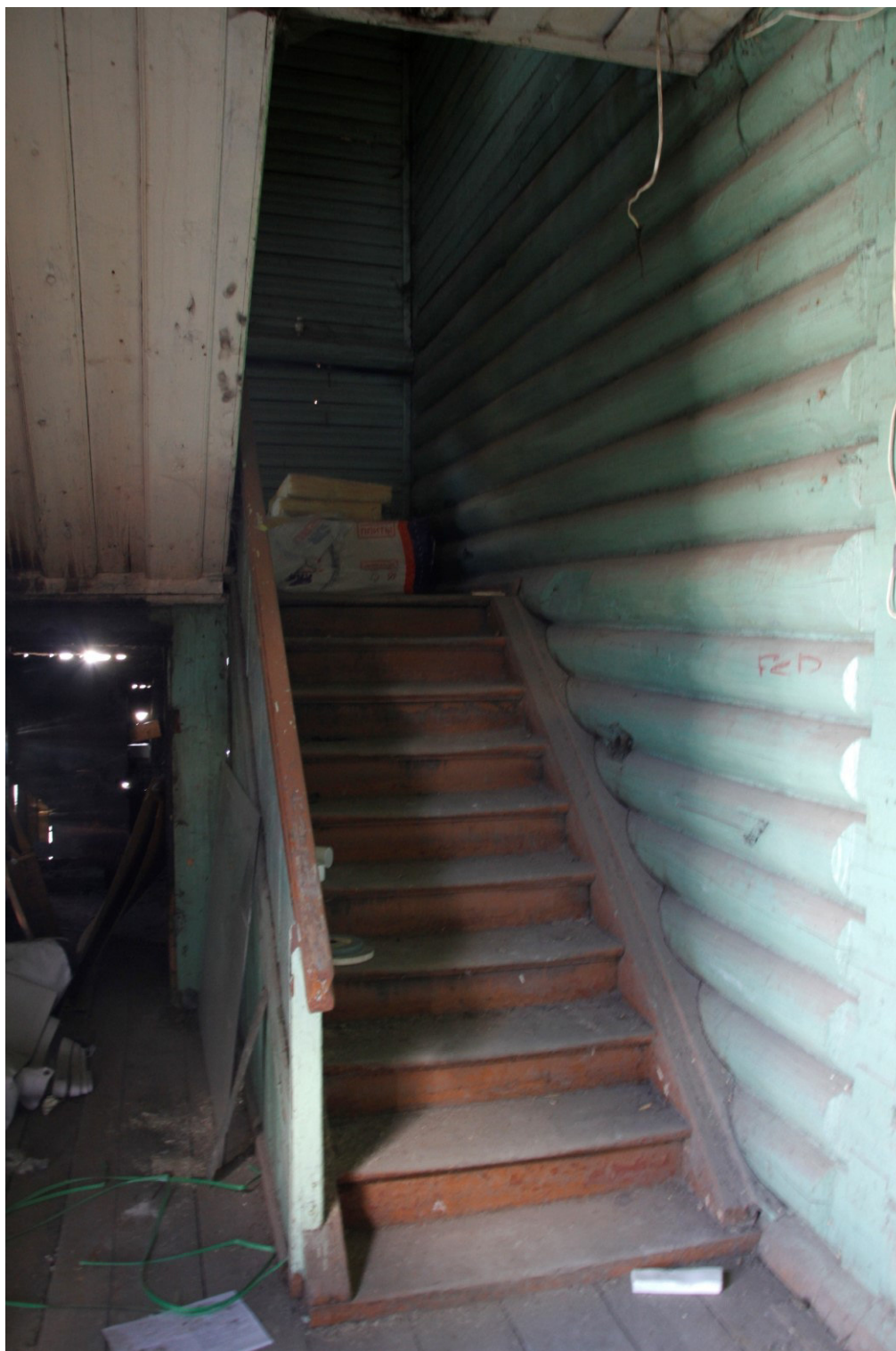
13. «Жилой дом». Ленинградская область, г. Луга, пр. Кирова, д. 34. Фрагмент интерьера помещения 1-го этажа. Лестничный марш.
