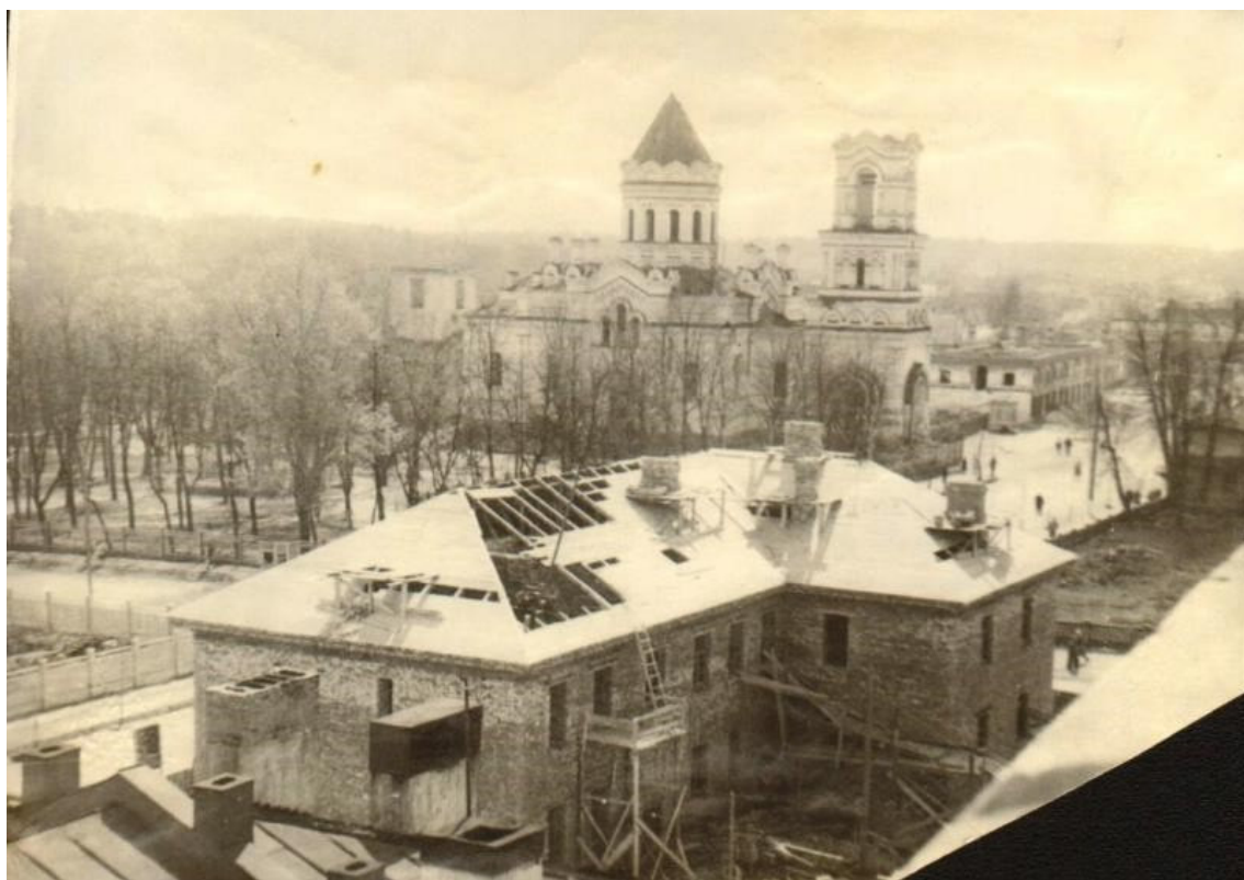
Ил. 16. Луга. Разрушенный дом. 1944 г. Источник: сайт pastvu.com.
