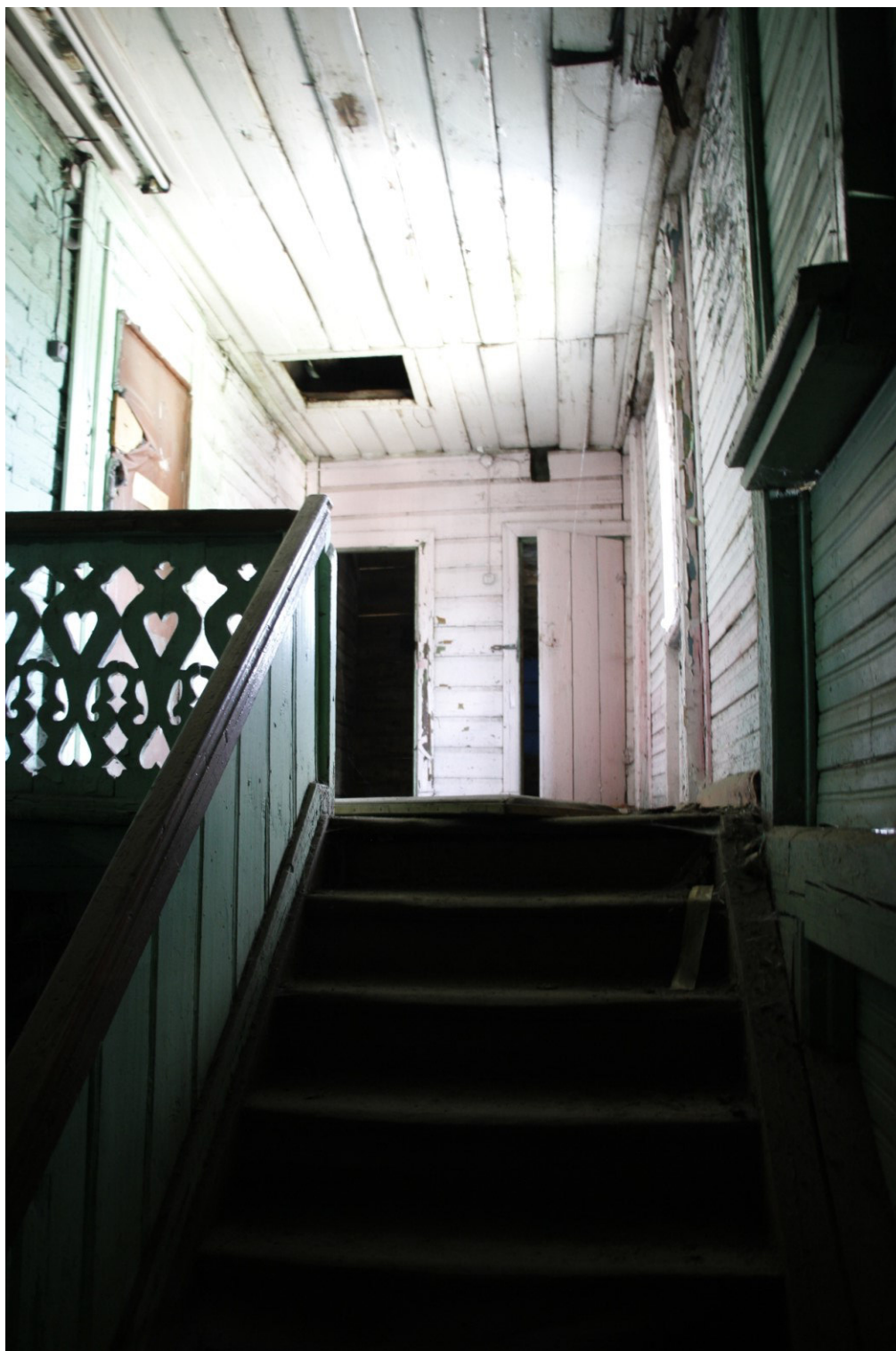
14. «Жилой дом». Ленинградская область, г. Луга, пр. Кирова, д. 34. Фрагмент лестничного марша в уровне 2-го этажа.
