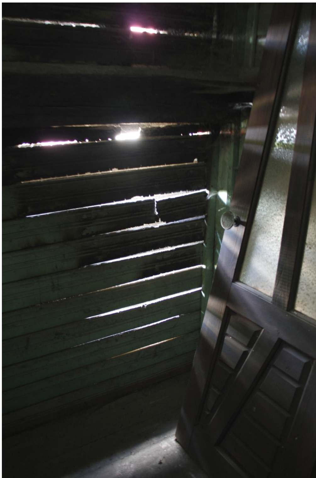
16. «Жилой дом». Ленинградская область, г. Луга, пр. Кирова, д. 34. Лестничный марш.
