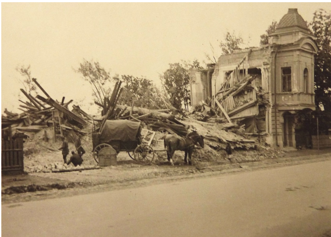
Ил. 14. Луга. Разрушенный дом (особняк Сунно, пр. Кирова 32). 1941 г. Источник: сайт pastvu.com .
