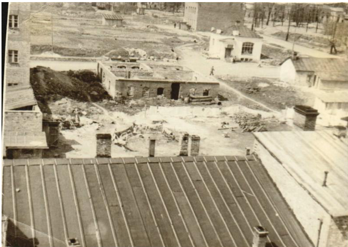
Ил. 20. Луга. Разрушенные здания. 1944-1946 гг. Источник: сайт pastvu.com.
