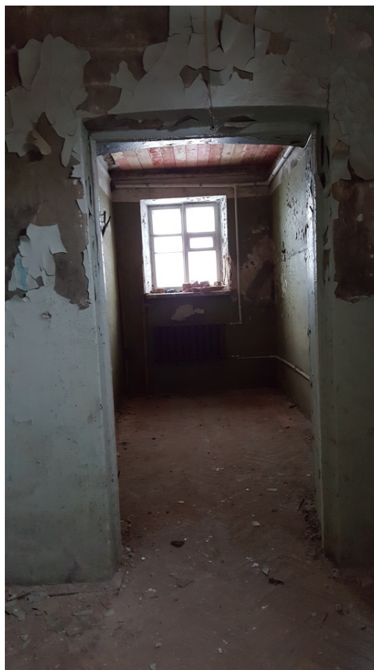
15. Помещения 2-го этажа.
