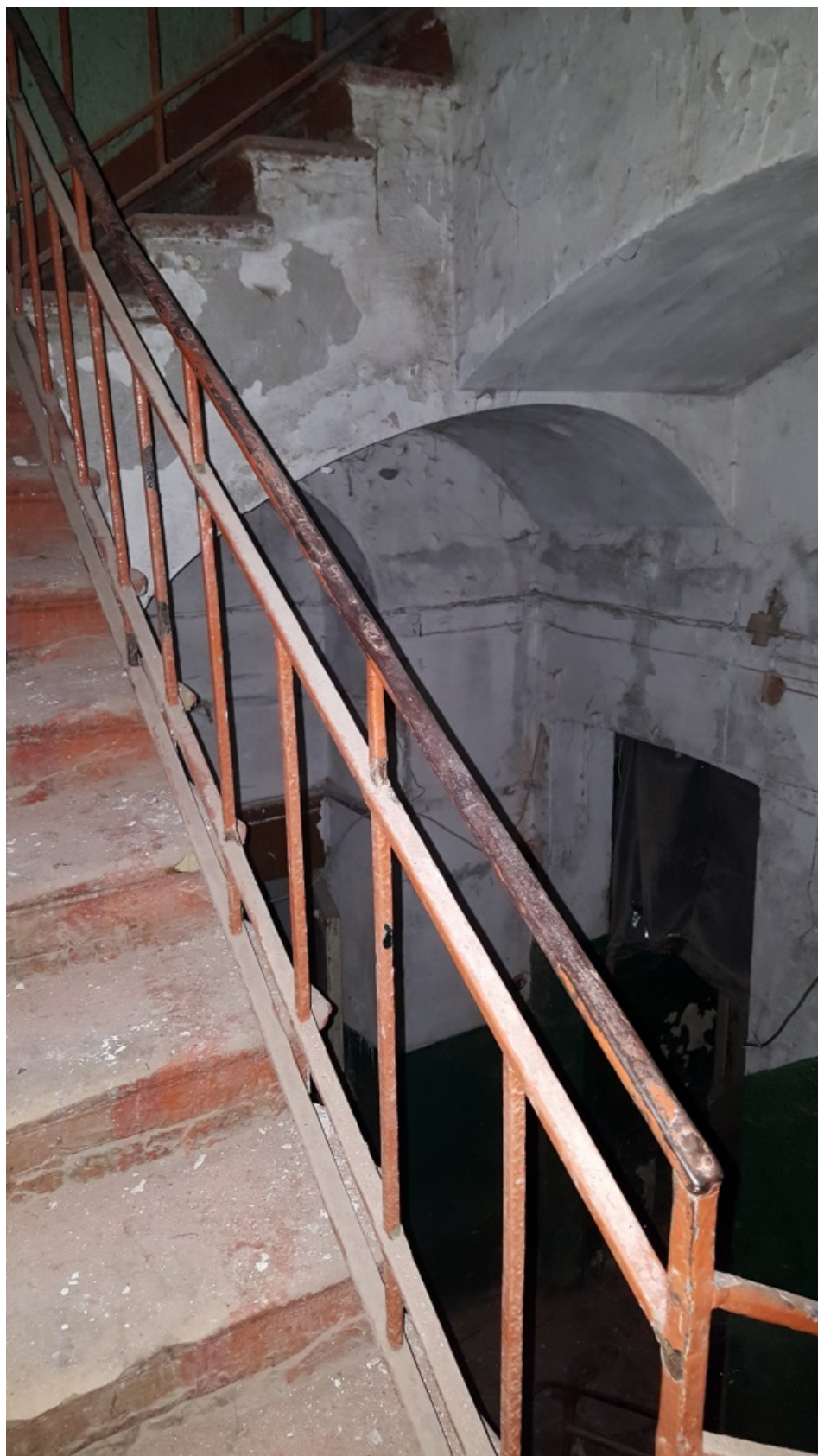
12. Лестница 1-Н. Общий вид конструкций.
