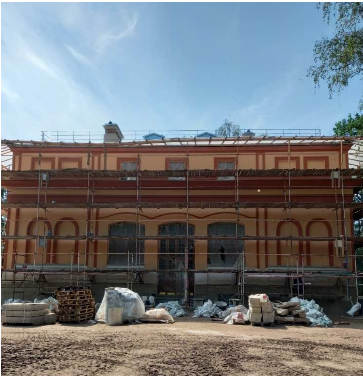
5. Общий вид северного (дворового) фасада.
