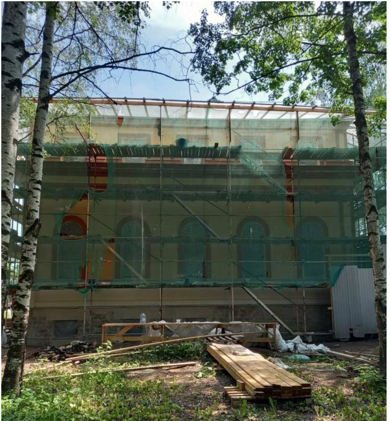
6. Общий вид западного фасада.
