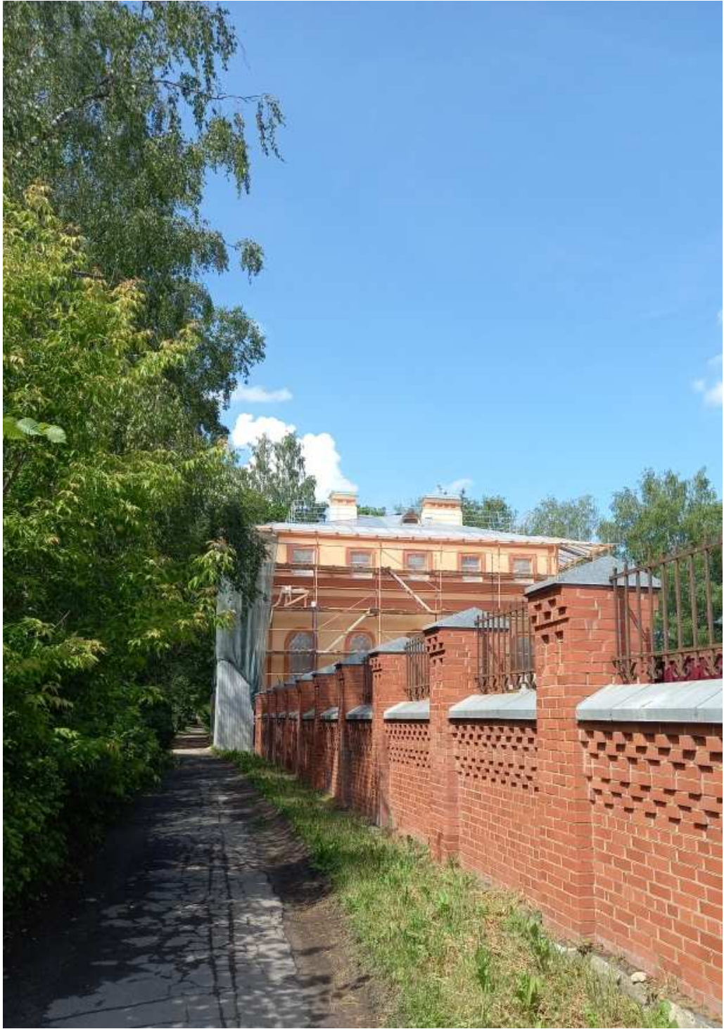
2. Вид объекта с востока.
