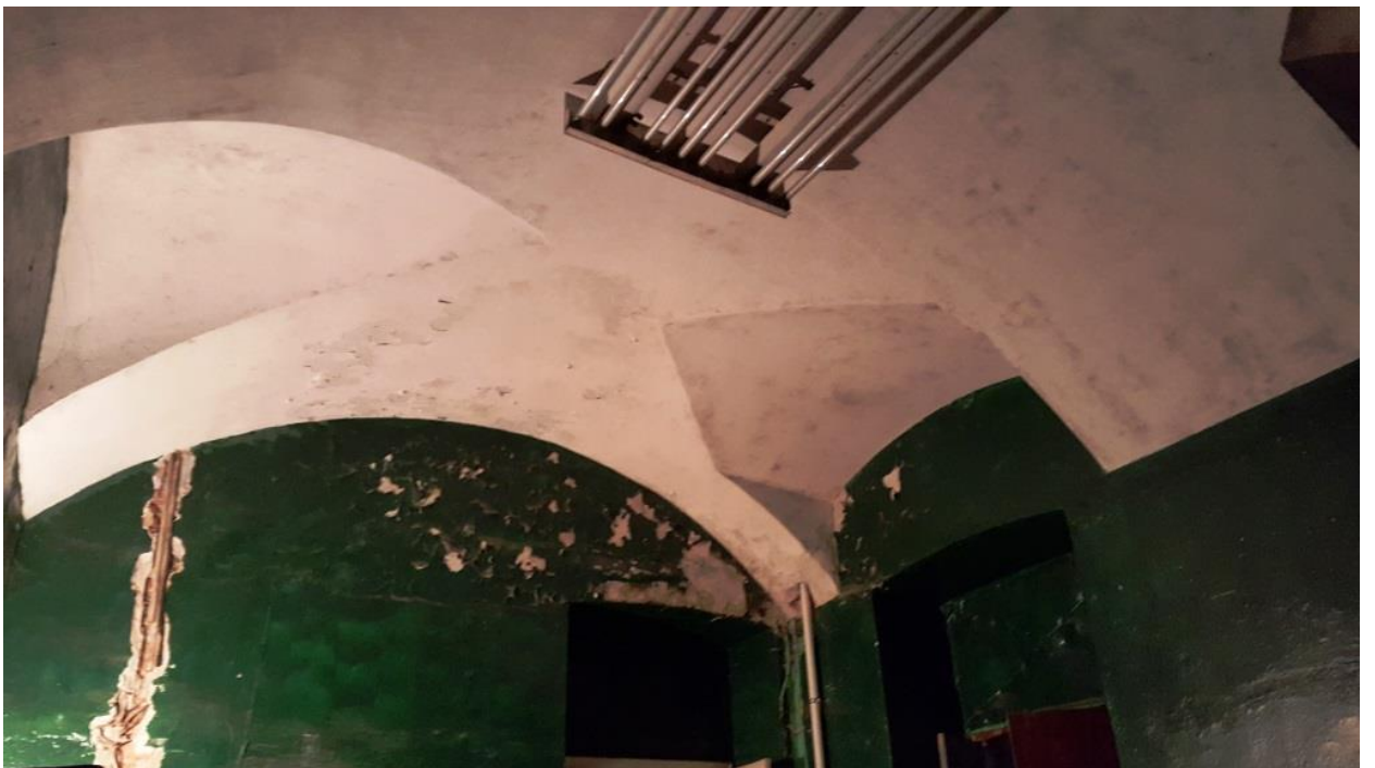
9. Свод с распалубками. Пом.2, 1-й этаж.
