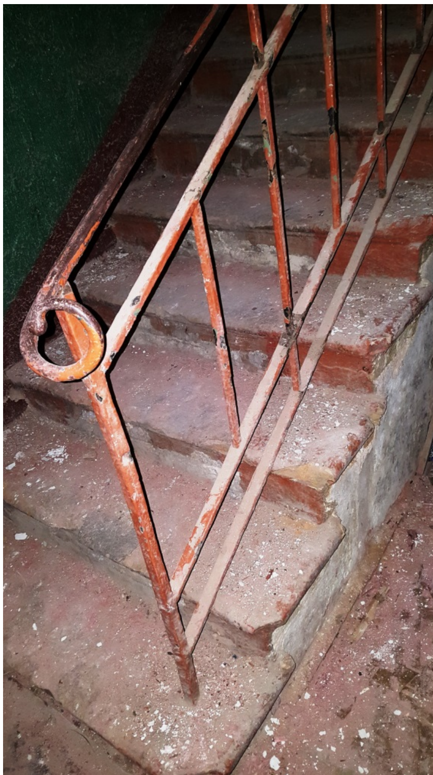
13. Лестница 1-Н. Вид ступеней и ограждения.
