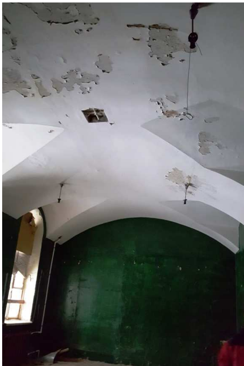
10. Свод с распалубками в пом. №5, 1-й этаж.
