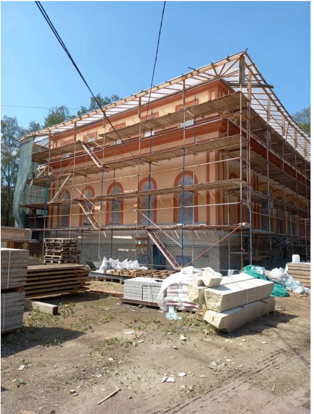
4. Общий вид восточного фасада.
