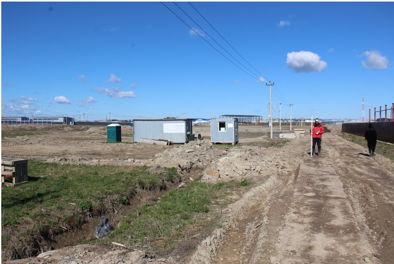
Рис. 13. Ленинградская область. Тосненский район, дер. Аннолово., Точка съёмки 1. Общий вид участка обследования. Вид на СЗ.
