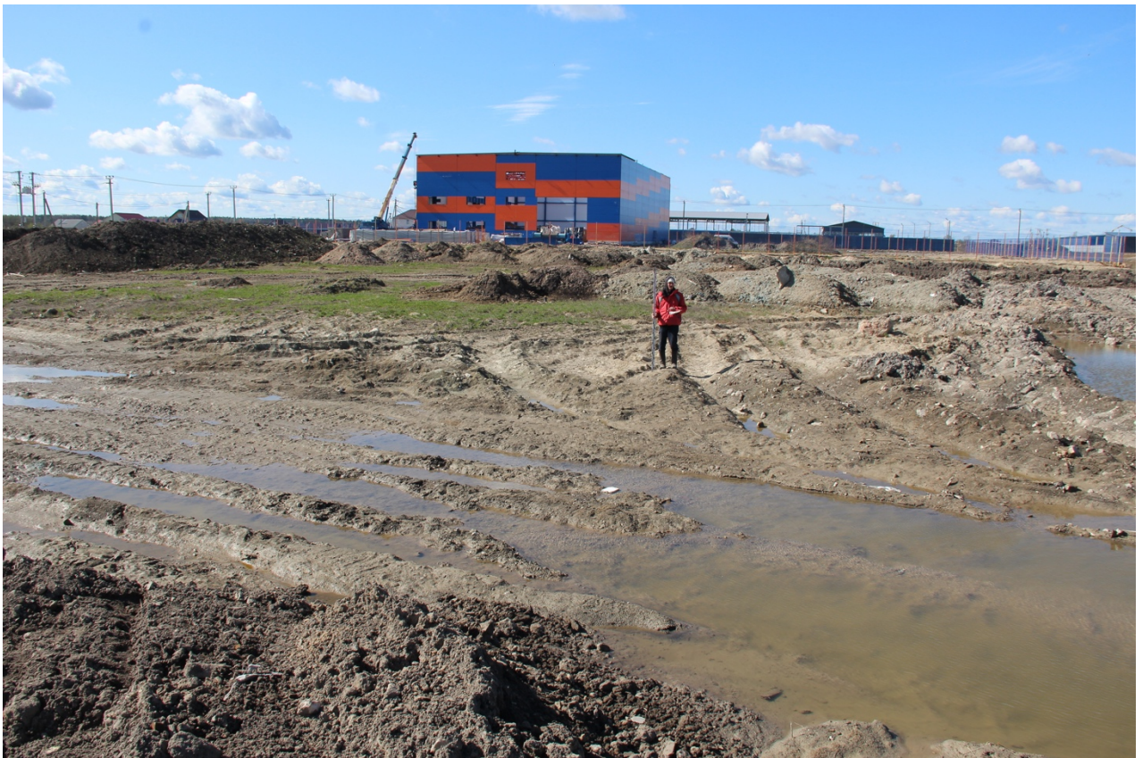
Рис. 18. Ленинградская область. Госненский район, дер. Аннолово., Точка съемки 2. Общий вид участка обследования. Вид на З.
