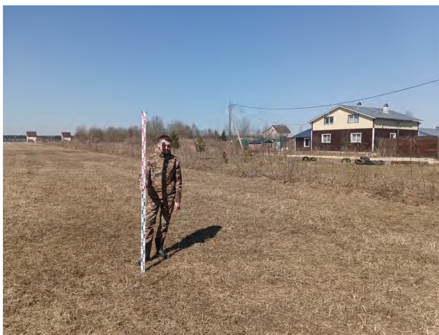
Рис. 175. Ленинградская область, Гатчинский район, «Межпоселковый газопровод до д. Холоповицы - д. Алексеевка - д. Раболово с отводами на д. Яскелево, д. Березнево, д. Ознаково, д. Колодези Гатчинского района Ленинградской области». 2023 г. Шурф 13. Общий вид с Ю
