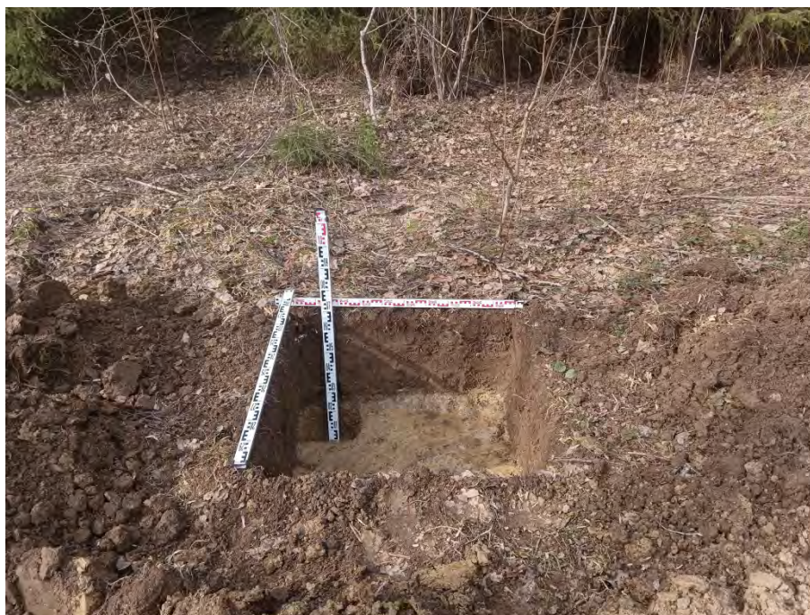
Рис. 96. Ленинградская область, Гатчинский район, «Межпоселковый газопровод до д. Холоповицы - д. Алексеевка - д. Раболово с отводами на д. Яскелево, д. Березнево, д. Ознаково, д. Колодези Гатчинского района Ленинградской области». 2023 г. Шурф 7. Зачистка по матерiku. Вид с Ю
