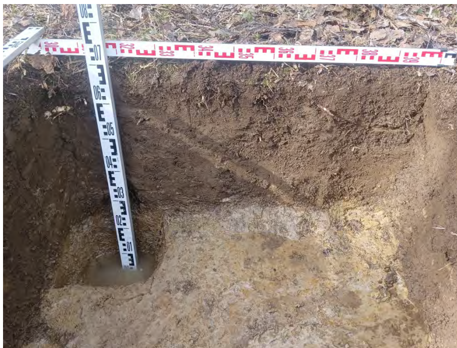
Рис. 98. Ленинградская область, Гатчинский район, «Межпоселковый газопровод до д. Холоповицы - д. Алексеевка - д. Раболово с отводами на д. Яскелево, д. Березнево, д. Ознаково, д. Колодези Гатчинского района Ленинградской области». 2023 г. Шурф 7. Северная стенка и контрольный прокоп. Вид с Ю
