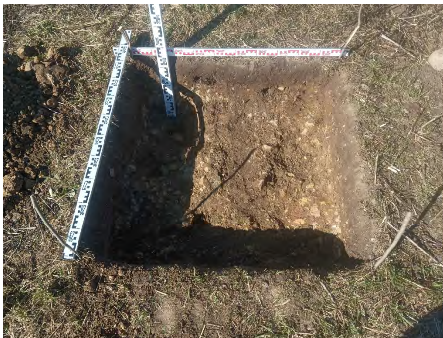
Рис. 148. Ленинградская область, Гатчинский район, «Межпоселковый газопровод до д. Холоповицы - д. Алексеевка - д. Раболово с отводами на д. Яскелево, д. Березнево, д. Ознаково, д. Колодези Гатчинского района Ленинградской области». 2023 г. Шурф 11. Зачистка по материке. Вид с Ю
