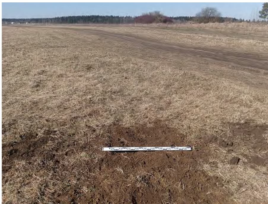
Рис. 162. Ленинградская область, Гатчинский район, «Межпоселковый газопровод до д. Холоповицы - д. Алексеевка - д. Раболово с отводами на д. Яскелево, д. Березнево, д. Ознаково, д. Колодези Гатчинского района Ленинградской области». 2023 г. Шурф 12. Рекультивация. Общий вид с Ю
