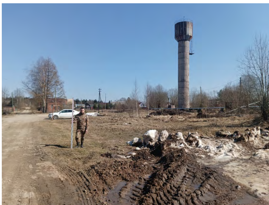
Рис. 189. Ленинградская область, Гатчинский район, «Межпоселковый газопровод до д. Холоповицы - д. Алексеевка - д. Раболово с отводами на д. Яскелево, д. Березнево, д. Ознаково, д. Колодези Гатчинского района Ленинградской области». 2023 г. Общий вид участка обследования. Точка фиксации 39. Вид с З
