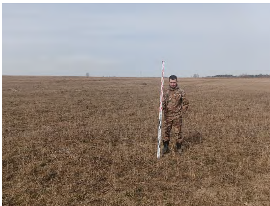
Рис. 71. Ленинградская область, Гатчинский район, «Межпоселковый газопровод до д. Холоповицы - д. Алексеевка - д. Раболово с отводами на д. Яскелево, д. Березнево, д. Ознаково, д. Колодези Гатчинского района Ленинградской области». 2023 г. Шурф 5. Общий вид на место закладки с Ю
