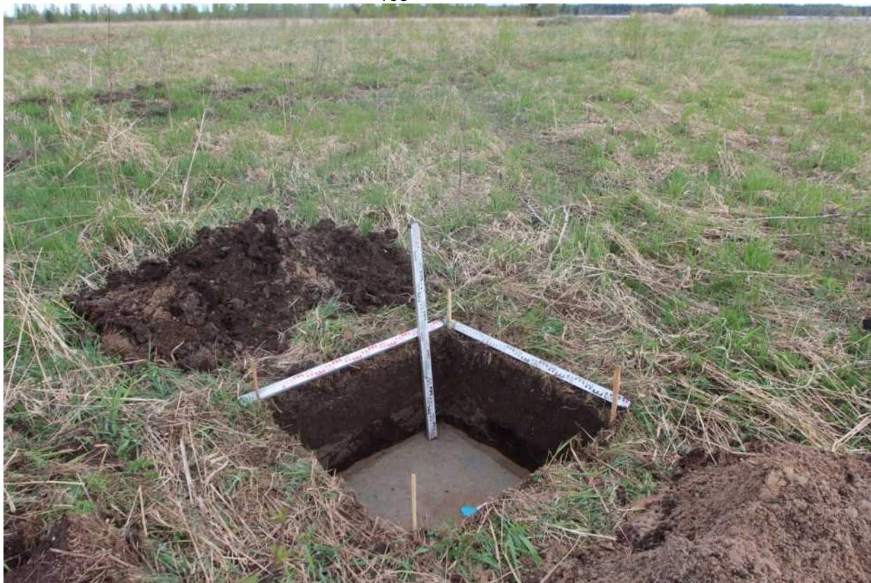
Рис. 75. Всеволожск-2023. КН: 47:07:0957003:526 и 47:07:0957003:3. Шурф 5. Фиксация по уровню окончания работ, вид на северо-восток.
