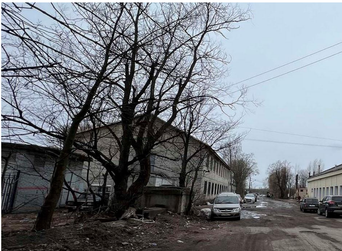
Фото 32. Существующая застройка по ул. Путейской. Фото с юго-востока. Дата съемки: 23.01.2023 г. Автор: эксперт Куваева Ю.П.
