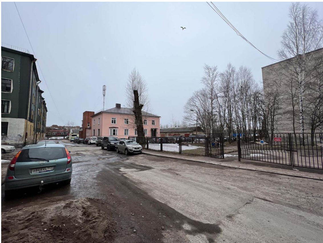
Фото 35. Современная застройка по ул. Горной. Фото с северо-востока. Дата съемки: 23.01.2023 г. Автор: эксперт Куваева Ю.П.
