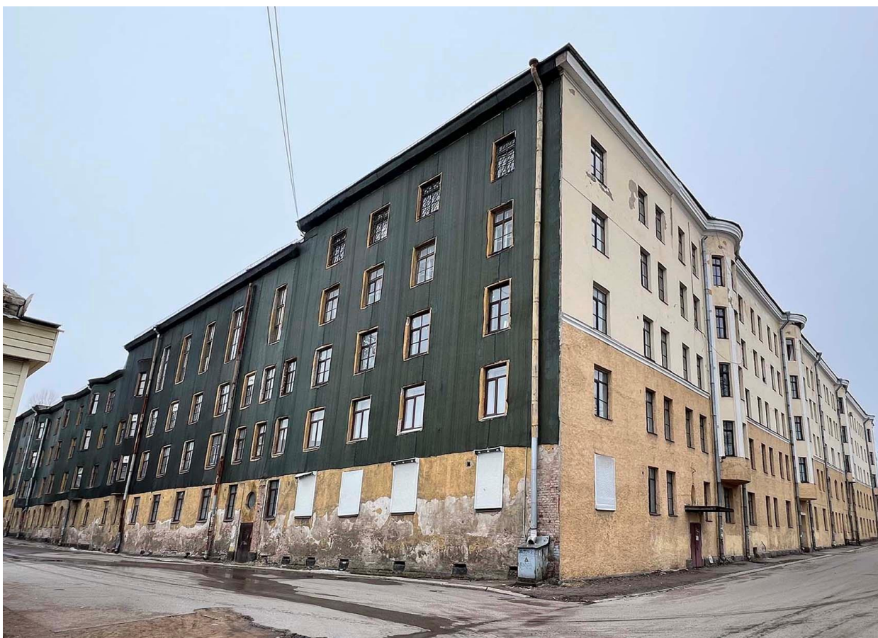
Фото 4. Общий вид Комплекса застройки квартала (8 объектов) (исторического квартала № 12) по ул. Путьейской, 8, исторически ценного градоформирующего объекта исторического поселения федерального значения г. Выборг Ленинградской области. Фото с запада, с перекрестка ул. Горной и Офицерской. На переднем плане – Жилой дом, 1906 г. и Жилой дом, 1911 г. (исторический участок № 34). Дата съемки: 23.01.2023 г. Автор: эксперт Куваева Ю.П.
