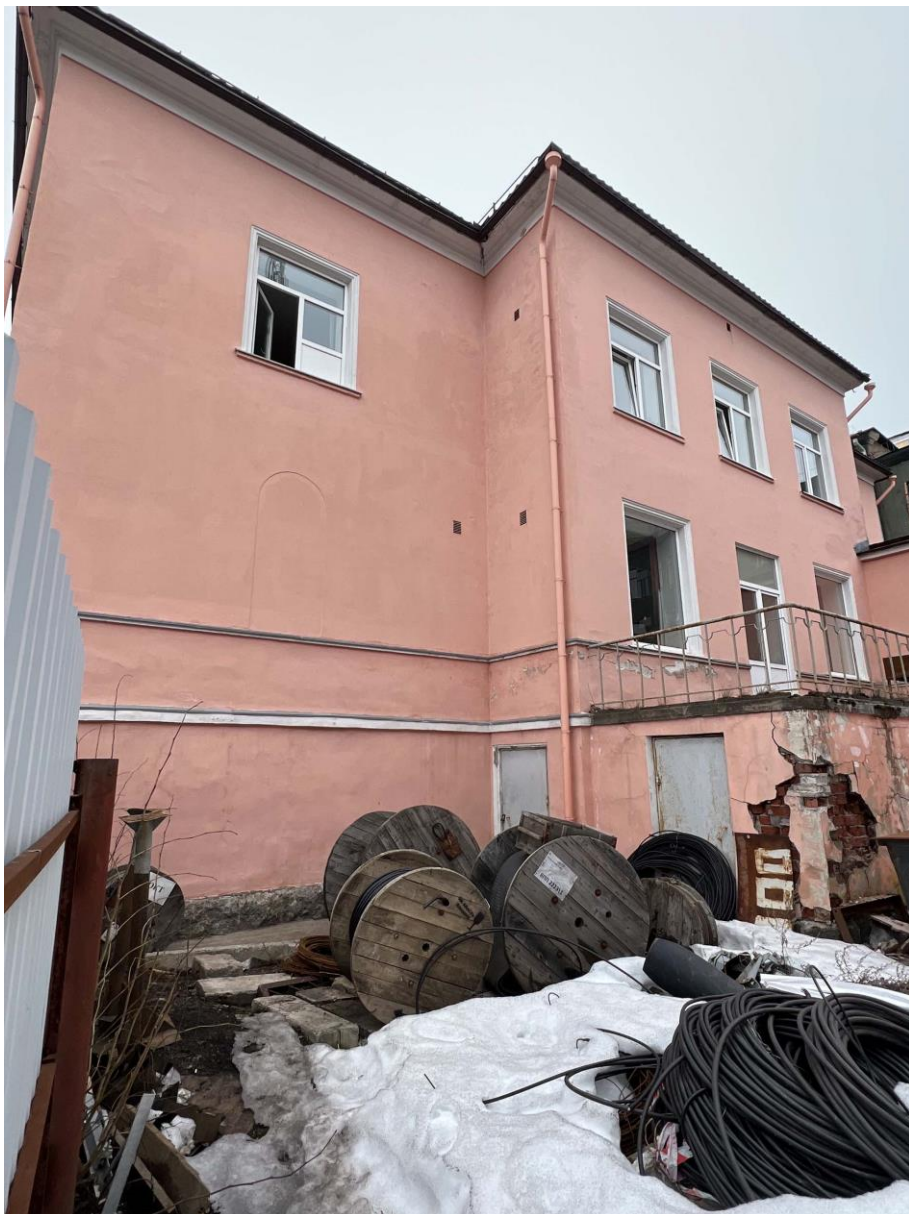
Фото 24. Вид на «Жилой дом», входящий в состав выявленного объекта культурного наследия «Комплекс городской усадьбы Б. Прокопе», ул. Горная, 4, 4 а. Фото с юго-запада. Дата съемки: 23.01.2023 г. Автор: эксперт Куваева Ю.П.
