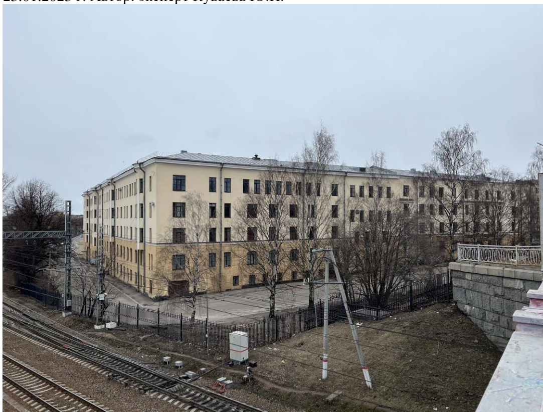
Фото 2. Общий вид Комплекса застройки квартала (8 объектов) по ул. Путейской, 8, кон. XIX – 1-я треть XX вв., 1950-1960-е гг. - исторически ценного градоформирующего объекта исторического поселения федерального значения г. Выборг Ленинградской области. Фото с юга, со стороны Железнодорожного моста. Дата съемки: 23.01.2023 г. Автор: эксперт Куваева Ю.П.
