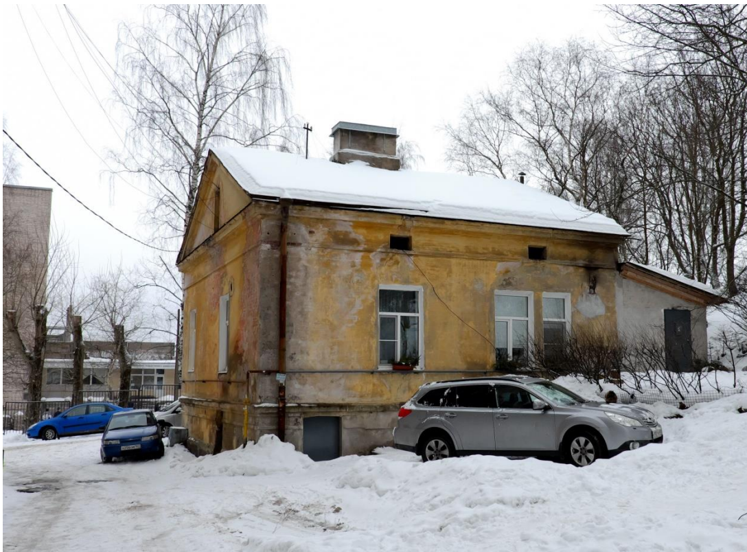
Фото 30. «Жилой дом», 1-я треть XX в., ул. Горная, 5 (исторический участок № 33 квартала № 10) – исторически ценный градоформирующий объект исторического поселения федерального значения г. Выборг Ленинградской области. Общий вид с юго-востока. Дата съемки: 23.01.2023 г. Автор: эксперт Куваева Ю.П.
