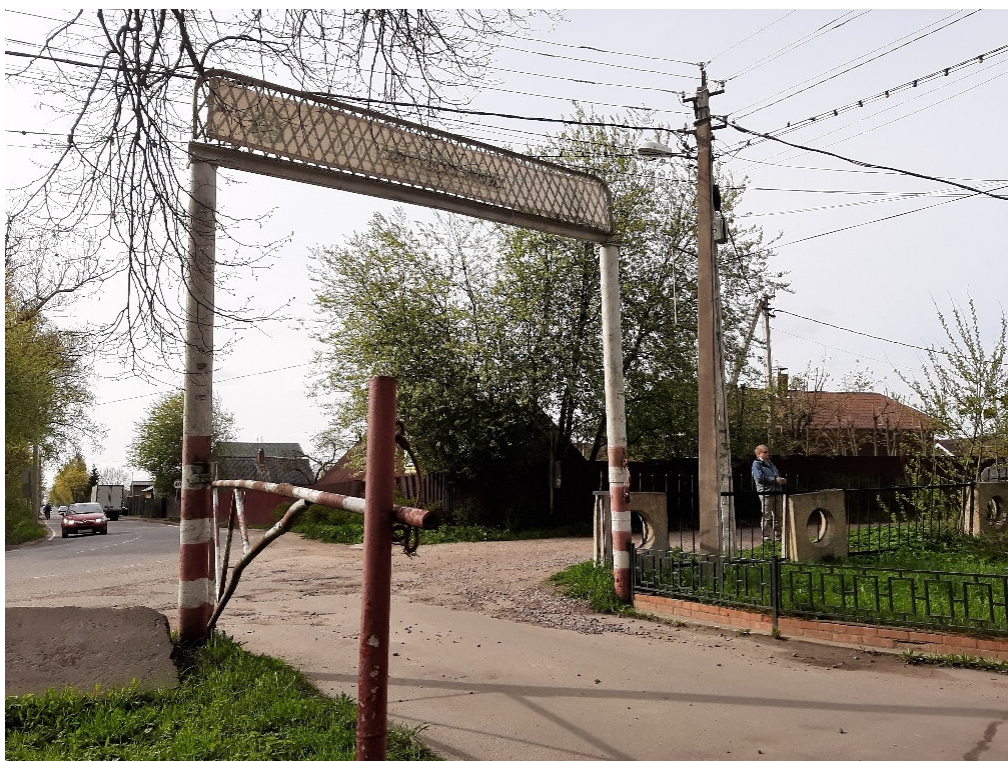
Фото 1. Вид на вход в парк, перекресток улиц Центральной и Магистральной.
