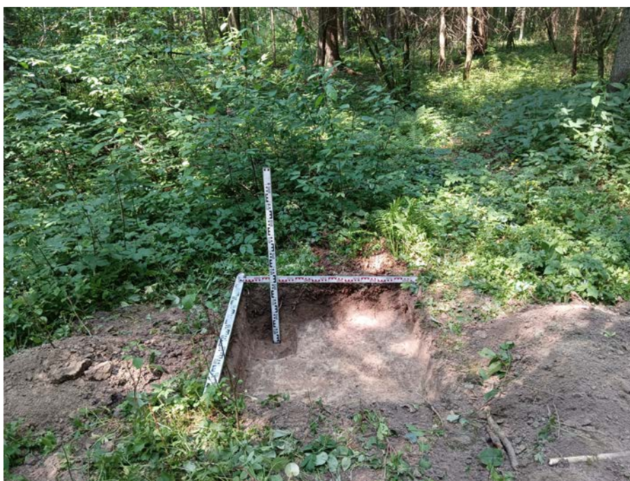
Рис. 53. Ленинградская область, Гатчинский район, «Межпоселковый газопровод до д. Тихковицы с отводами на д. Старое Колено, д. Новое Поддубье, д. Старое Поддубье, д. Новое Колено Гатчинского района Ленинградской области». 2023 г. Шурф 3. Зачистка по материке. Общий вид с Ю
