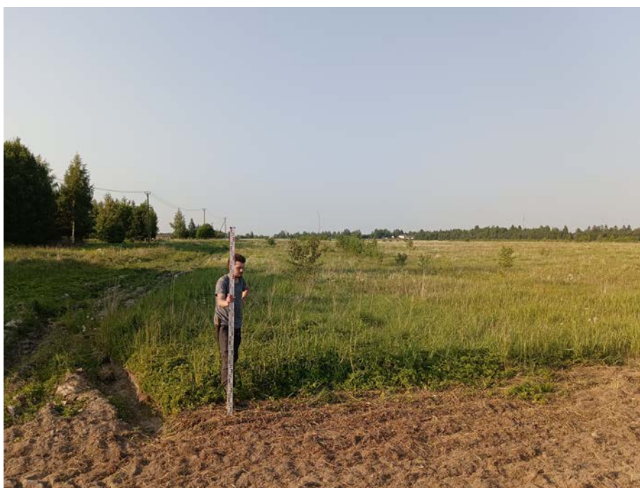
Рис. 109. Ленинградская область, Гатчинский район, «Межпоселковый газопровод до д. Тихковицы с отводами на д. Старое Колено, д. Новое Поддубье, д. Старое Поддубье, д. Новое Колено Гатчинского района Ленинградской области». 2023 г. Общий вид участка обследования. Точка фиксации 23. Вид с ЮЗ
