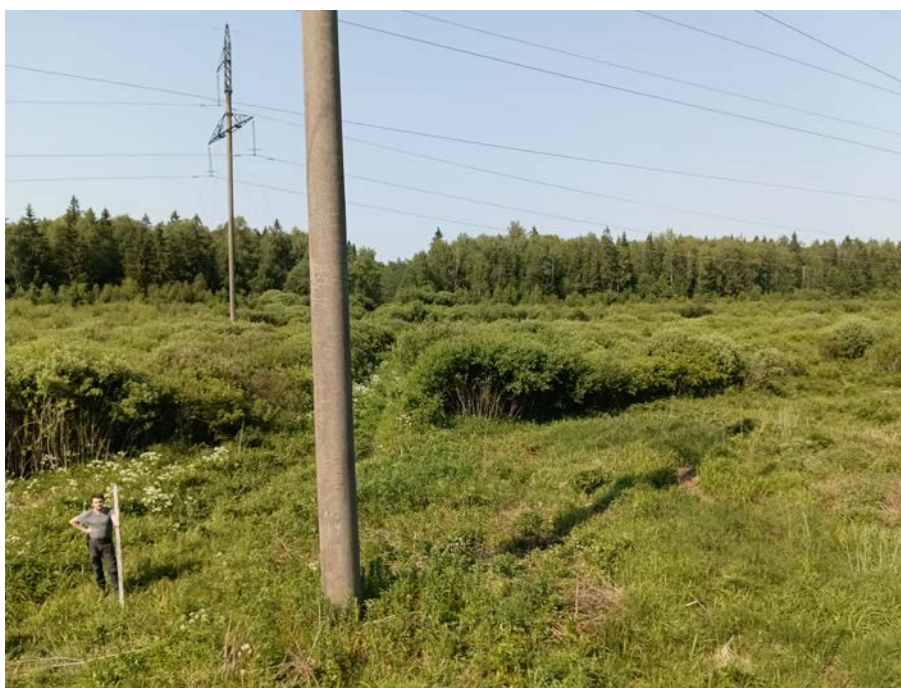
Рис. 89. Ленинградская область, Гатчинский район, «Межпоселковый газопровод до д. Тихковицы с отводами на д. Старое Колено, д. Новое Поддубье, д. Старое Поддубье, д. Новое Колено Гатчинского района Ленинградской области». 2023 г. Общий вид участка обследования. Точка фиксации 17. Вид с засидки, с С
