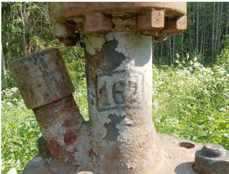
Рис. 80. Ленинградская область, Гатчинский район, «Межпоселковый газопровод до д. Тихковицы с отводами на д. Старое Колено, д. Новое Поддубье, д. Старое Поддубье, д. Новое Колено Гатчинского района Ленинградской области». 2023 г. Номер скважины. Вид с С
