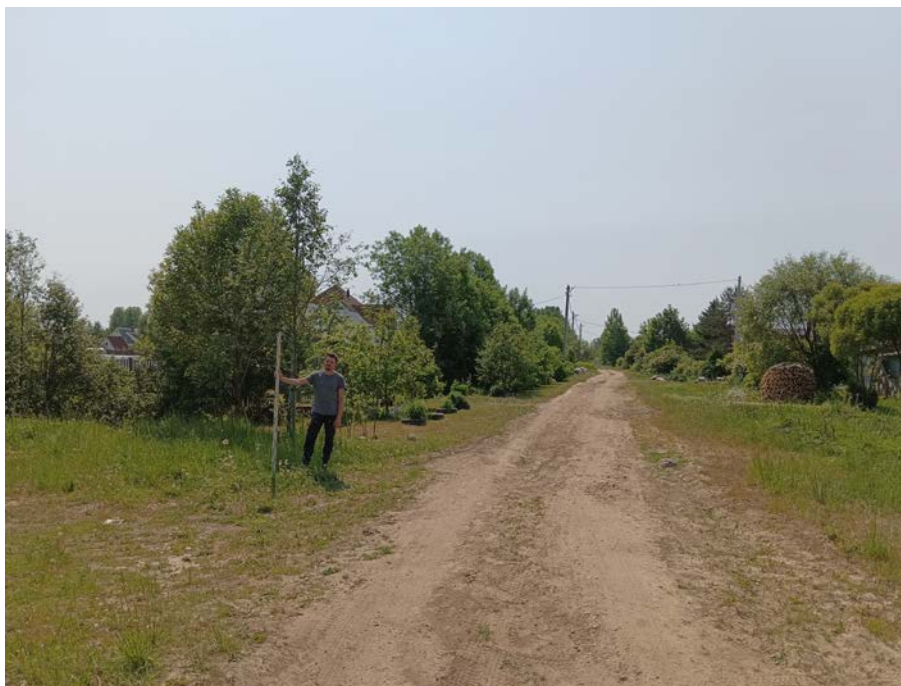
Рис. 62. Ленинградская область, Гатчинский район, «Межпоселковый газопровод до д. Тиховицы с отводами на д. Старое Колено, д. Новое Поддубье, д. Старое Поддубье, д. Новое Колено Гатчинского района Ленинградской области». 2023 г. Общий вид участка обследования. Точка фиксации 12. Вид с С
