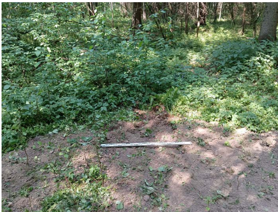
Рис. 56. Ленинградская область, Гатчинский район, «Межпоселковый газопровод до д. Тихковицы с отводами на д. Старое Колено, д. Новое Поддубье, д. Старое Поддубье, д. Новое Колено Гатчинского района Ленинградской области». 2023 г. Шурф 3. Рекультивация. Вид с Ю
