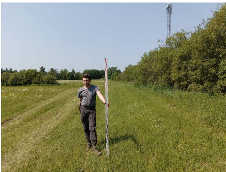
Рис. 23. Ленинградская область, Гатчинский район, «Межпоселковый газопровод до д. Тихковицы с отводами на д. Старое Колено, д. Новое Поддубье, д. Старое Поддубье, д. Новое Колено Гатчинского района Ленинградской области». 2023 г. Общий вид участка обследования. Точка фиксации 3. Вид с В
