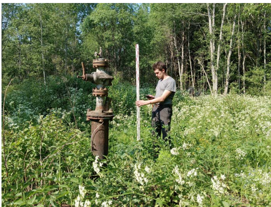
Рис. 79. Ленинградская область, Гатчинский район, «Межпоселковый газопровод до д. Тихковицы с отводами на д. Старое Колено, д. Новое Поддубье, д. Старое Поддубье, д. Новое Колено Гатчинского района Ленинградской области». 2023 г. Общий вид участка обследования. Точка фиксации 16. Вид с ЮЗ
