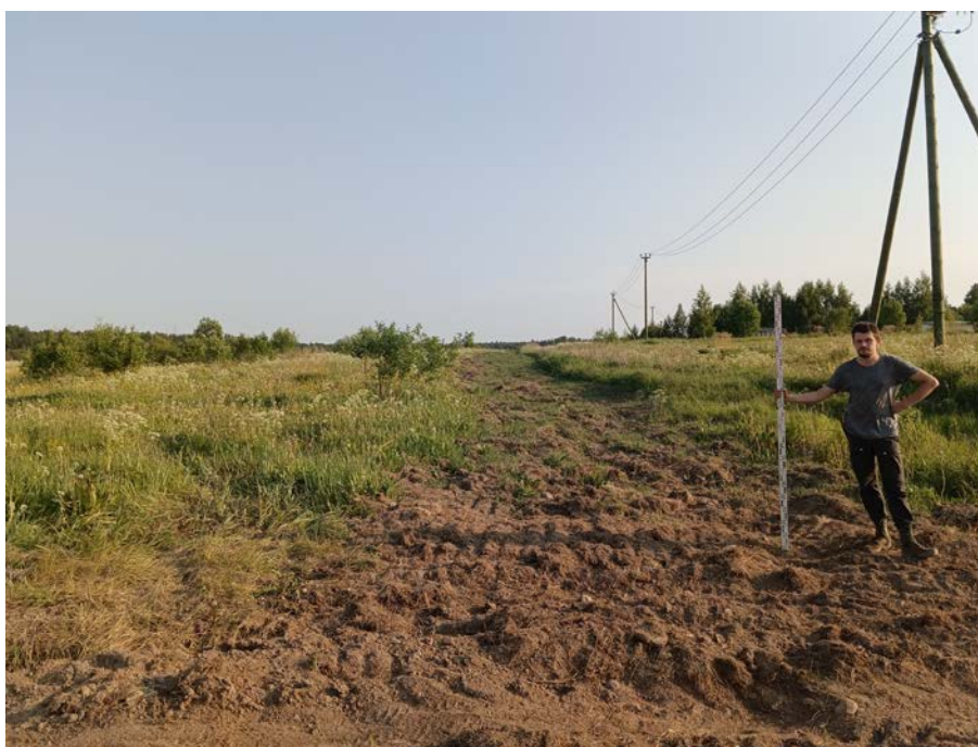
Рис. 119. Ленинградская область, Гатчинский район, «Межпоселковый газопровод до д. Тихковицы с отводами на д. Старое Колено, д. Новое Поддубье, д. Старое Поддубье, д. Новое Колено Гатчинского района Ленинградской области». 2023 г. Общий вид участка обследования. Точка фиксации 25. Вид с СВ
