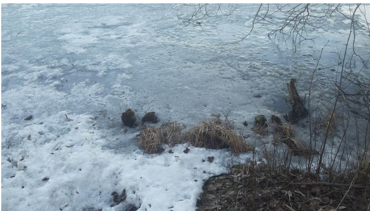
14. Приоратский парк. Фрагменты сохранившихся шпунтовых конструкций западного берега Черного озера. Штиглиц М.С. 08.04.2023.
