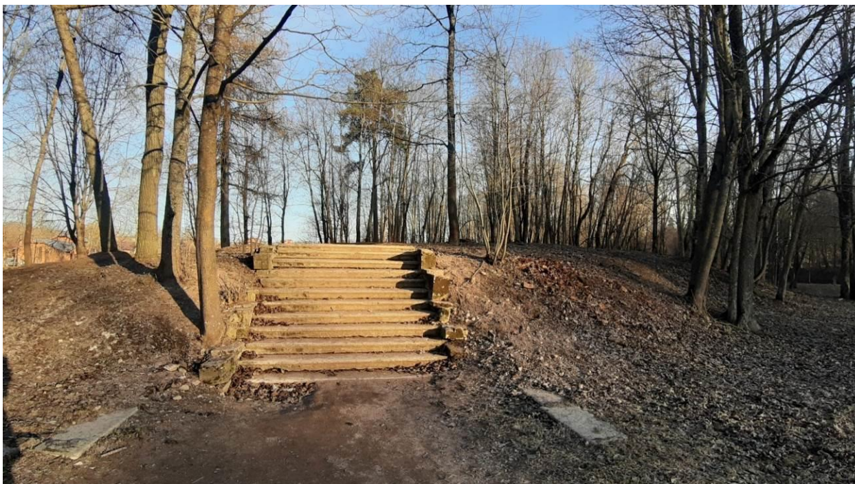
15. Приоратский парк. Каменная лестница, выходящая на пр. 25 Октября и остатки цоколя ограды. Штиглиц М.С. 08.04.2023.
