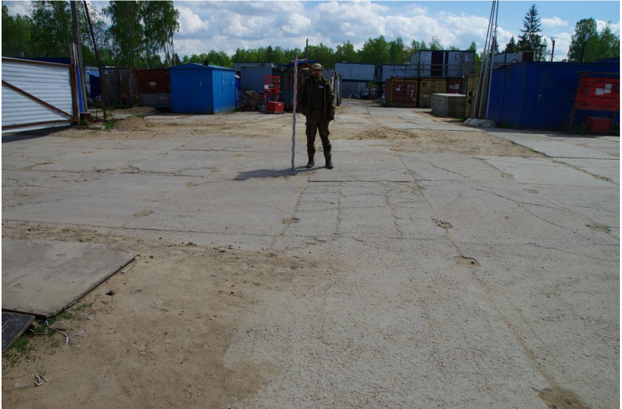
Рис. 15. Ленинградская область, Всеволожский муниципальный район, Сертоловское городское поселение, г. Сертолово, мкрн Сертолово-2, ул. Мира, земельный участок с кадастровым номером 47:08:0103002:2344, вид с запада.
