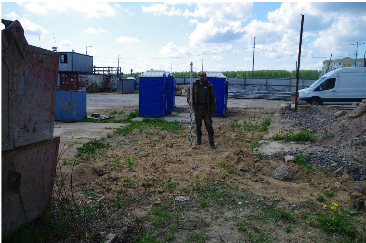
Рис. 17. Ленинградская область, Всеволожский муниципальный район, Сертоловское городское поселение, г. Сертолово, мкрн Сертолово-2, ул. Мира, земельный участок с кадастровым номером 47:08:0103002:2344. Шурф 1. Место шурфа до начала работ, вид с севера.
