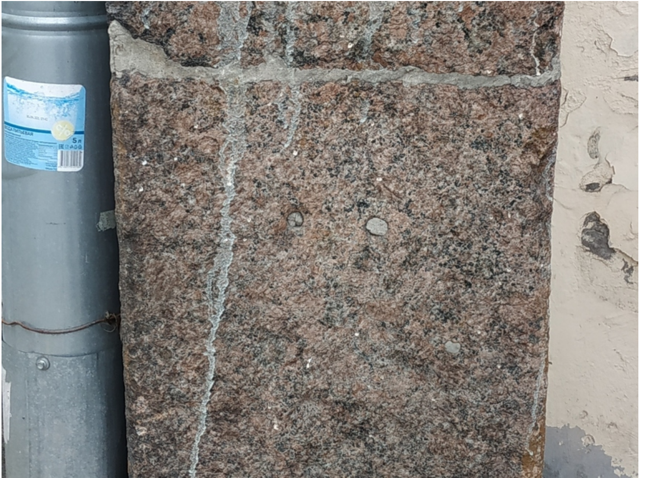
4. Следы крепления ограждения прямка в гранитной отделке цоколя (южнее проёма).
