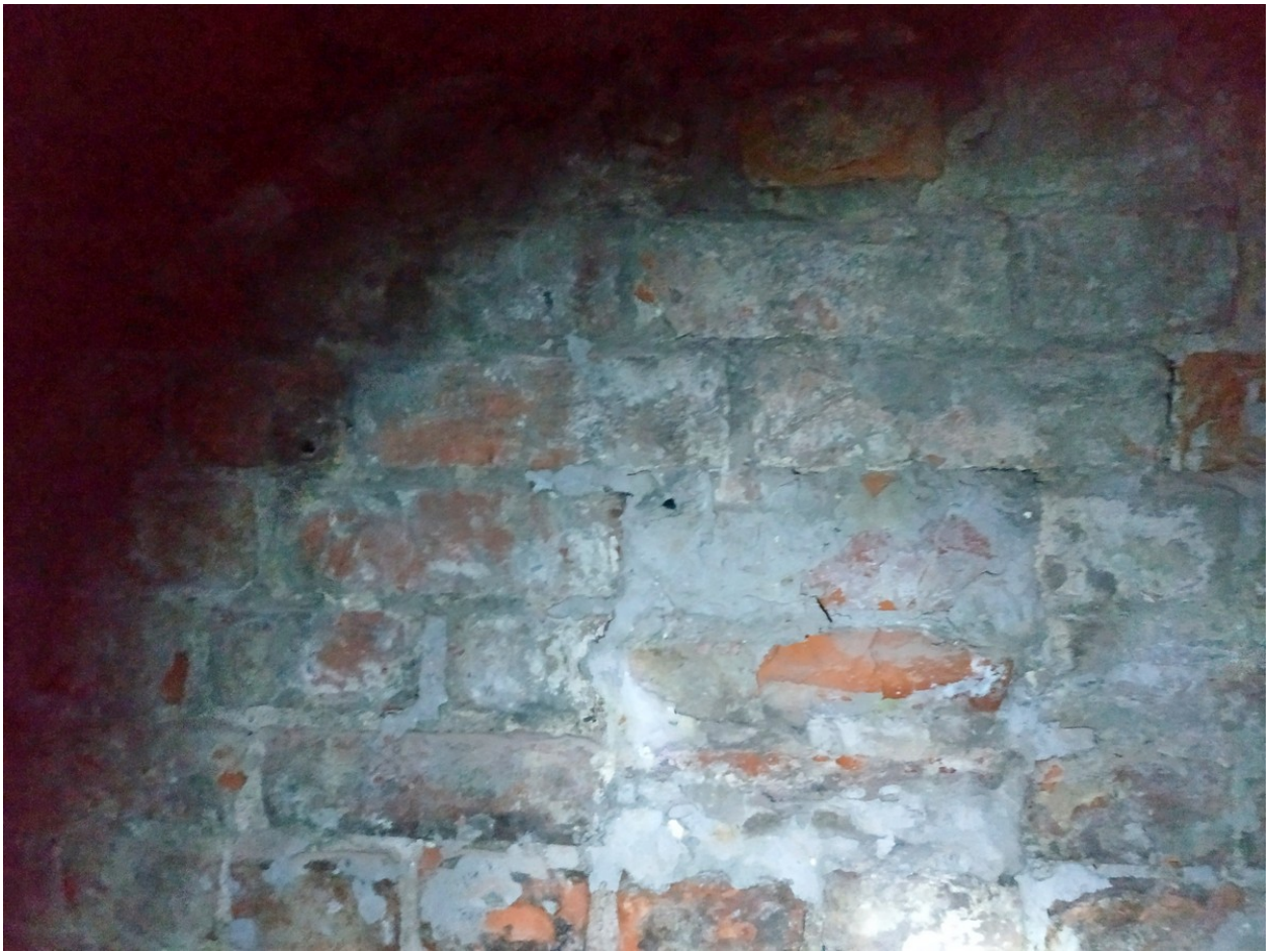
28. Второе заложенное отверстие (канал?) между помещениями 1 и 2.
