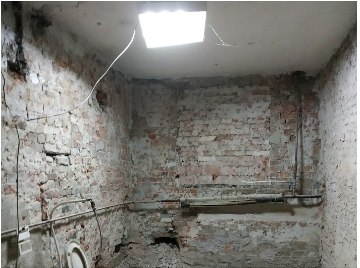
32. Помещение 5, общий вид. Заложённый проём окна, выходящего во двор.
