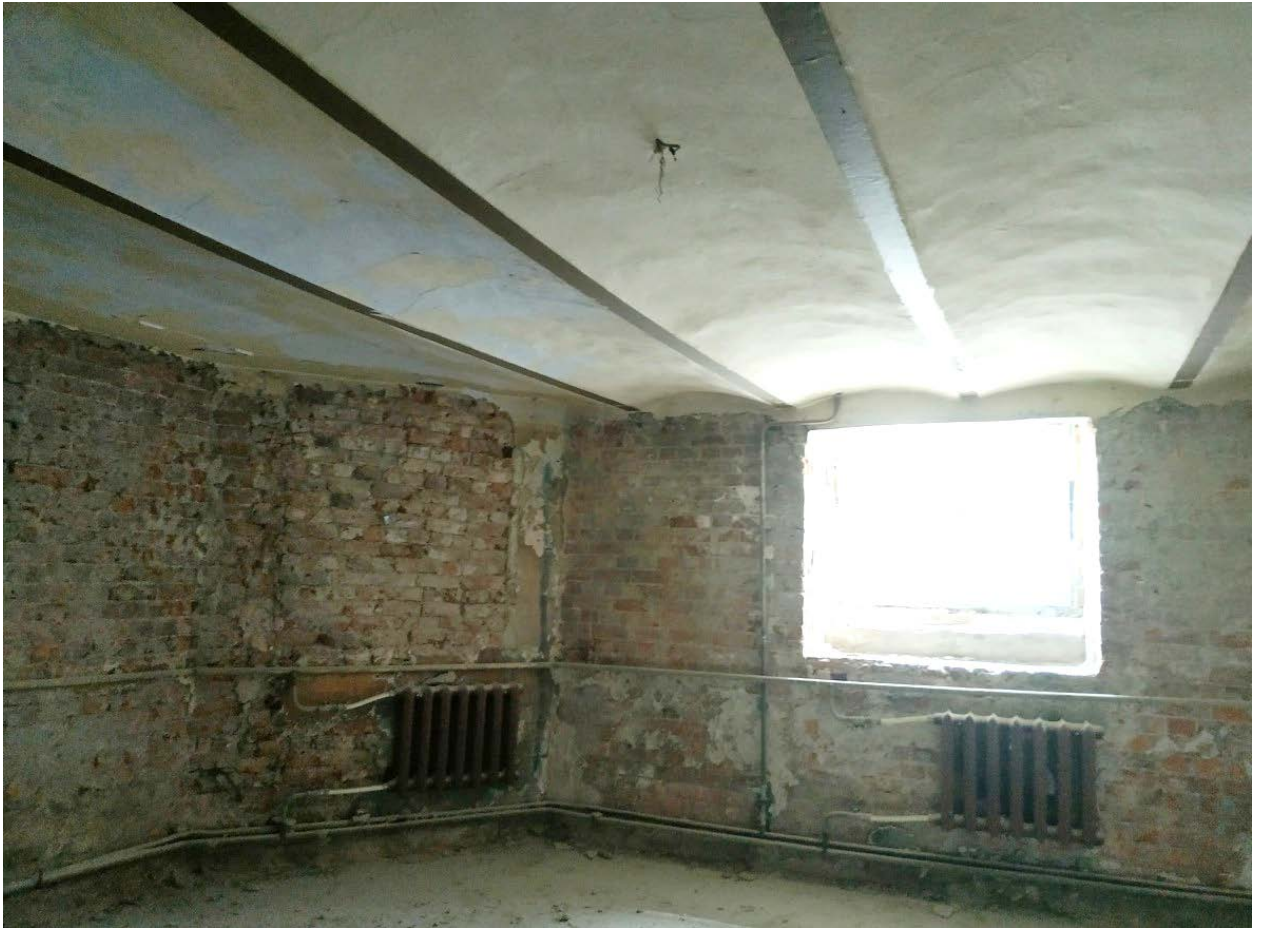
20. Помещение №1 (угловое). Сводчатые перекрытия по металлическим балкам.
