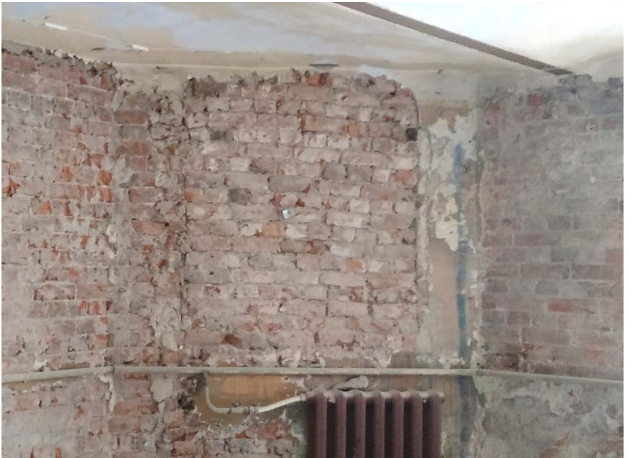
22. Заложённый исторический дверной проём в угловой ясти здания.
