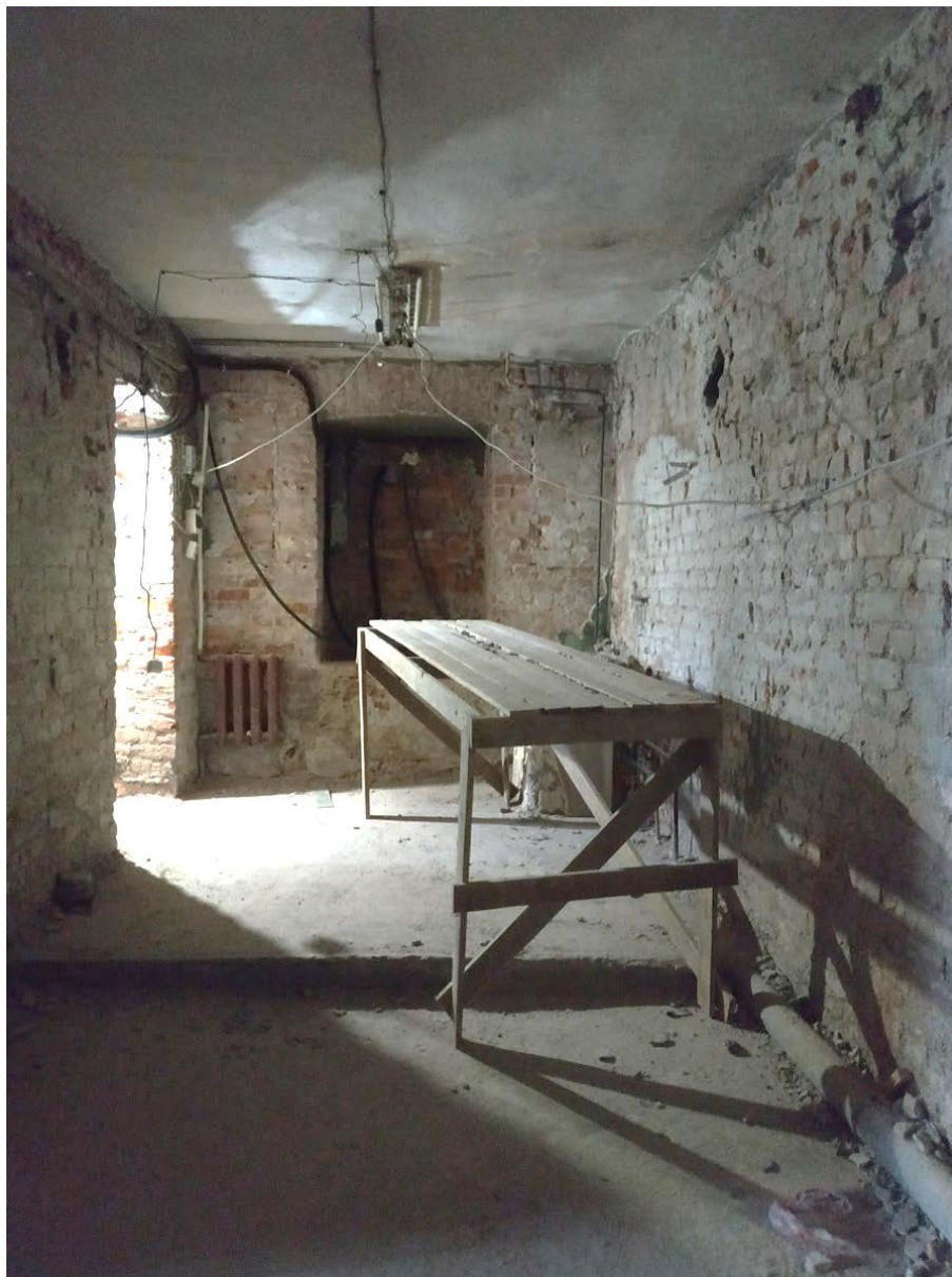
17. Помещение №4 в составе помещения 1-Н, вид в сторону дворового фасада. Заложенный исторический оконный проём.
