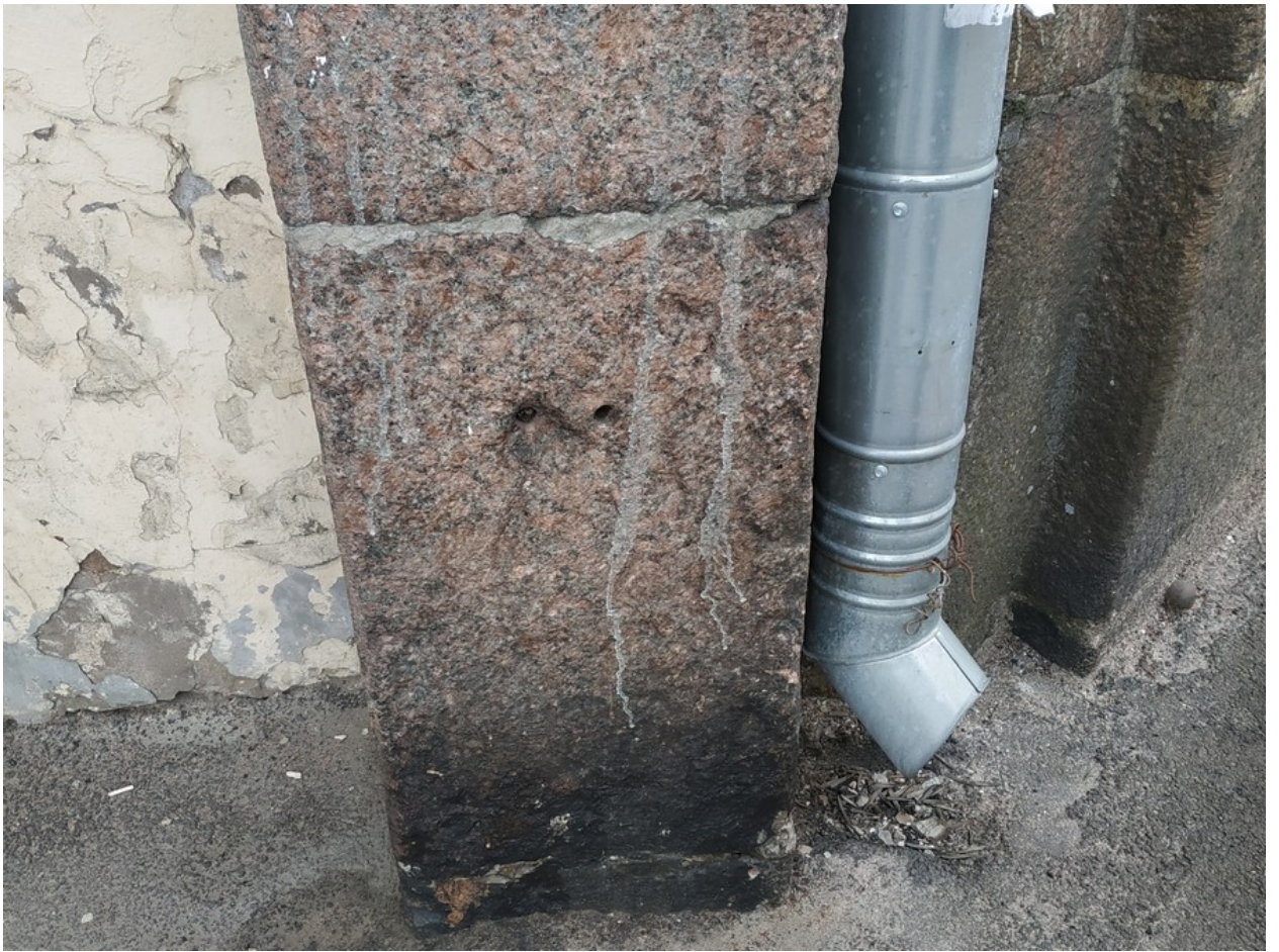
3. Следы крепления ограждения приямка в гранитной отделке цоколя (севернее проёма).
