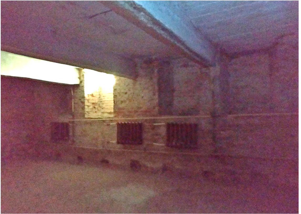
29. Помещение 2, общий вид (вид в сторону Выборгской ул.). Перекрытие – по железобетонным балкам.
