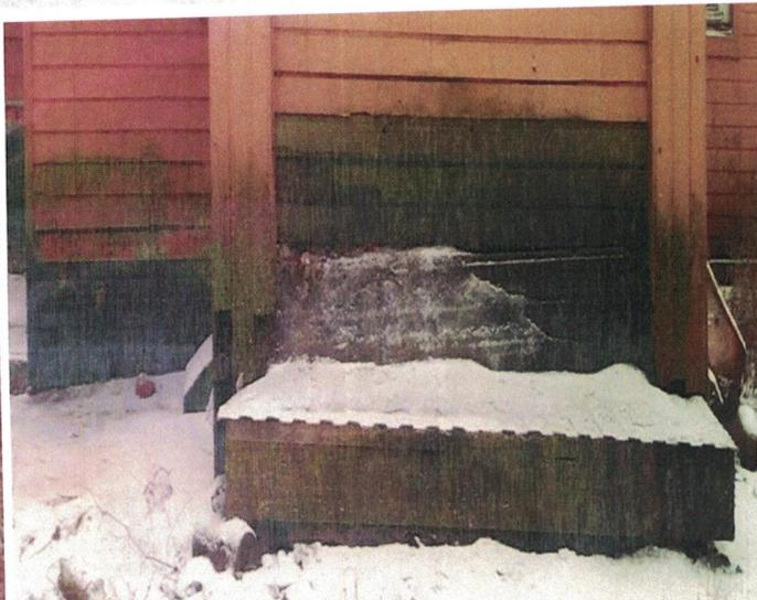
Местами трещины и сколы, биоповреждения отделки цоколя; просадка грунта и фундамента на отдельных участках; на отдельных участках по периметру здания трещины, нарушение сопряжения отмостки и цоколя, дефекты отмостки, произрастание деревьев ближе 5 м от фундамента здания. нарушение целостности конструкций ям, повреждение гидроизоляции, покрытия выгребных ям.
