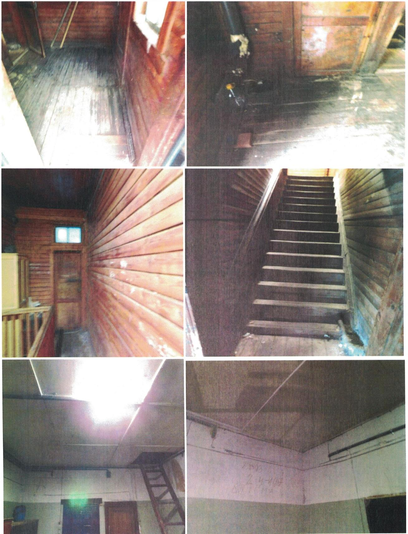
Выпучивание и коробление деревянной обшивки; неравномерная просадка стен внутри помещений, перекос дверных проемов внутри помещений; ощутимая зыбкость перегородок, отклонение их от вертикали, выпучивание и выпирание досок на отдельных участках. Уклон полов и лестницы. Уклон полов, просадки досок в отдельных местах. Прогиб чердачного перекрытия.
