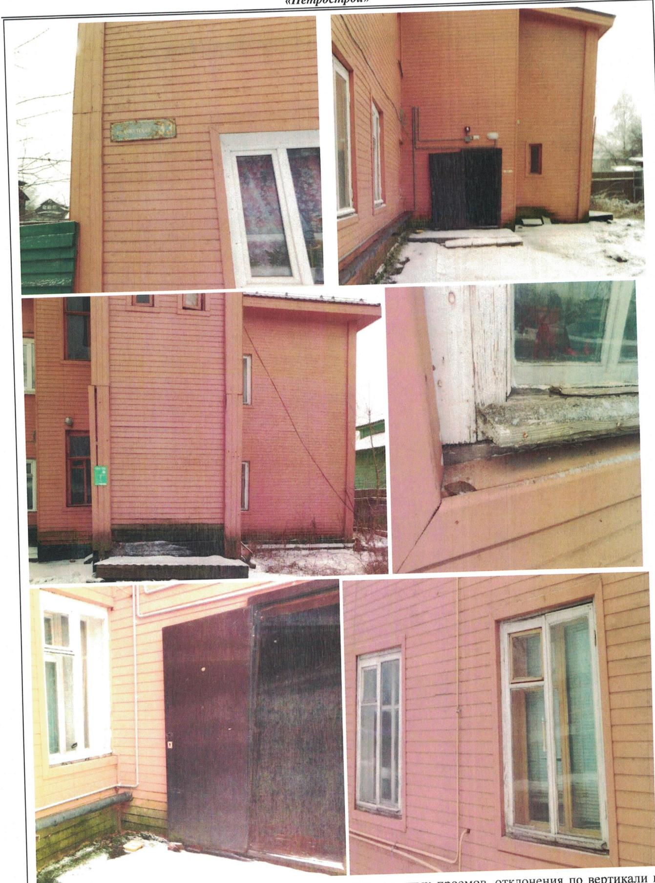
Просадка здания по углам, наблюдается перекос, гниль оконных проемов, отклонения по вертикали по углам и по плоскости стен. Отклонение от вертикали стен пристройки, поражение древесины каркаса, обшивки гнилью. Коррозия, повреждение окрасочного слоя по низу дверного полотна входной двери в подъезд.
