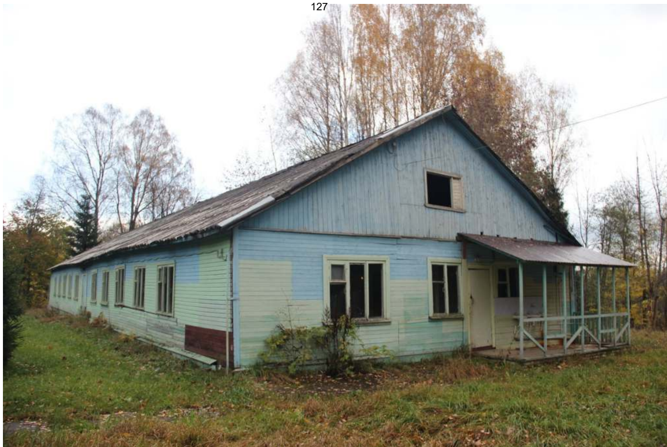
57 Выявленный ОКН «Усадьба Марковых «Александровская» - парк (на территории Дом, где жил композитор П.И. Чайковский)» по адресу: Ленинградская область, д. Надино, Шапкинская волость. Северный и западный фасады здания детского корпуса. Дата съемки: 25.10.2022 г.
