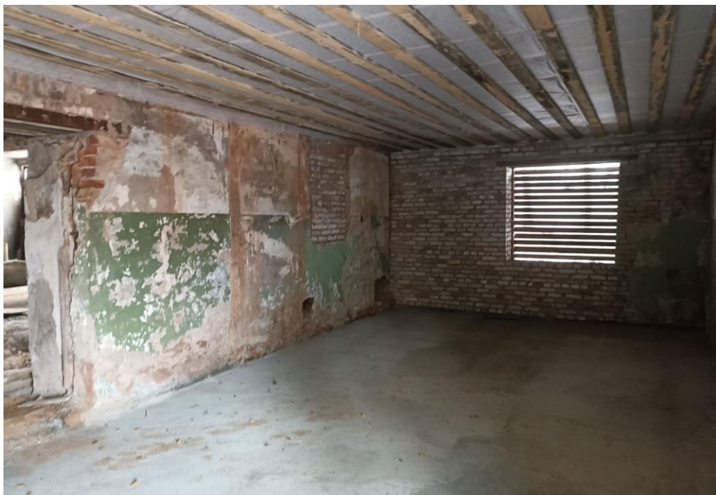
12. Объект культурного наследия регионального значения «Дом, где в 1918 году проходил первый уездный съезд Советов» по адресу: Ленинградская область, Тихвинский муниципальный район, Тихвинское городское поселение, город Тихвин, ул. Советская, д.51. Поздняя пристройка (западная часть здания). Общий вид интерьера.
