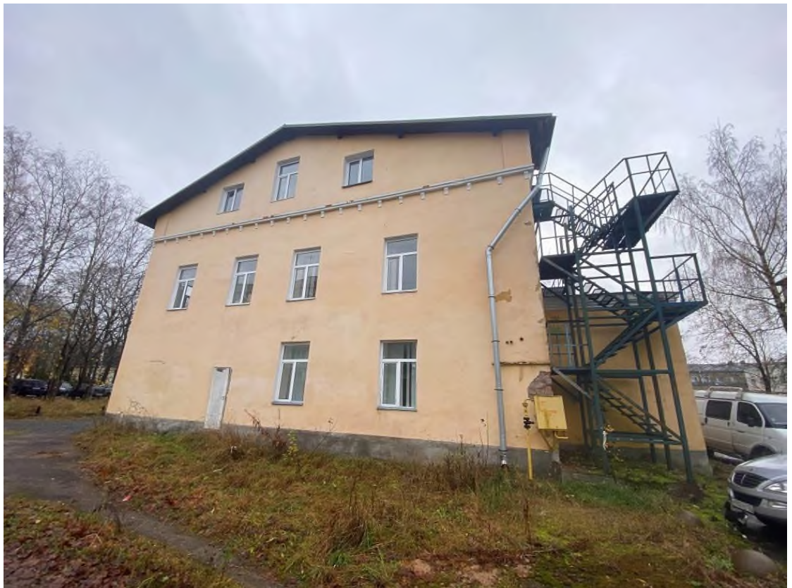
Фото 14. Общий вид реконструируемого ОКС с севера
