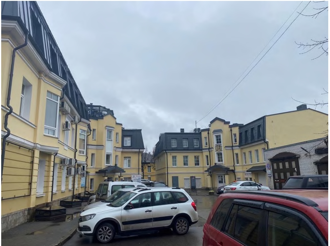
Фото 5. Общий вид на объекты со стороны двора, с севера
