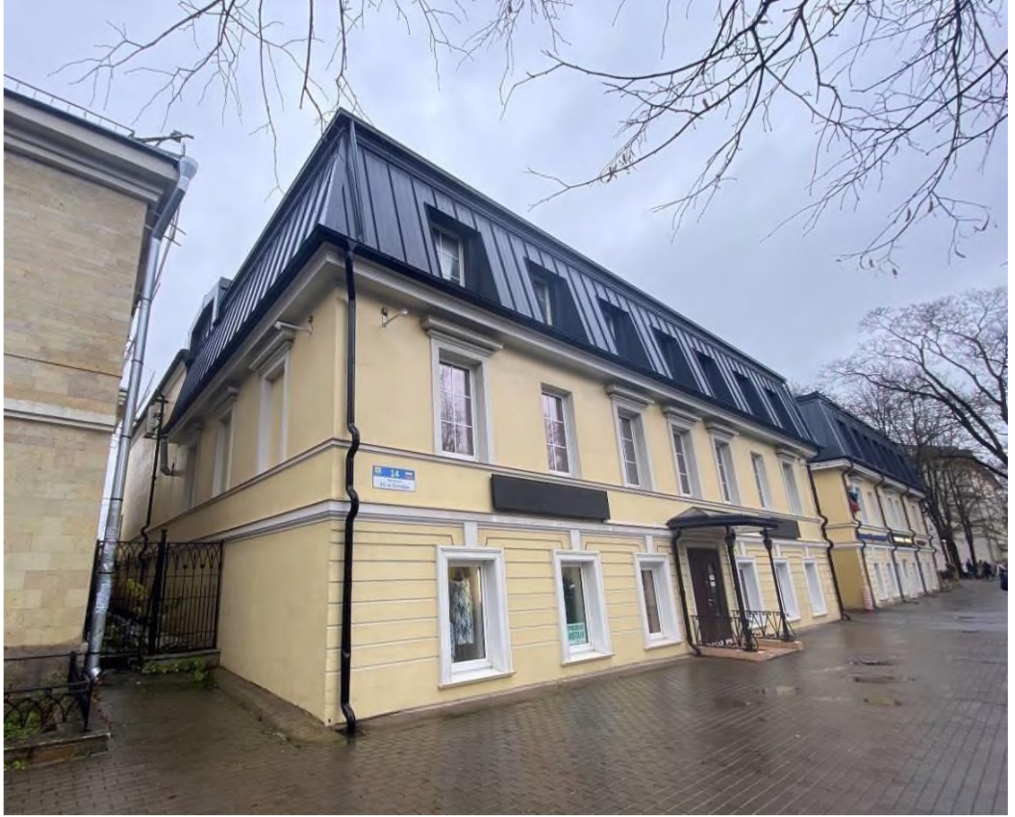
Фото 4. Фасад объекта с юго-востока (г. Гатчина, пр. 25 Октября, д. 14)
