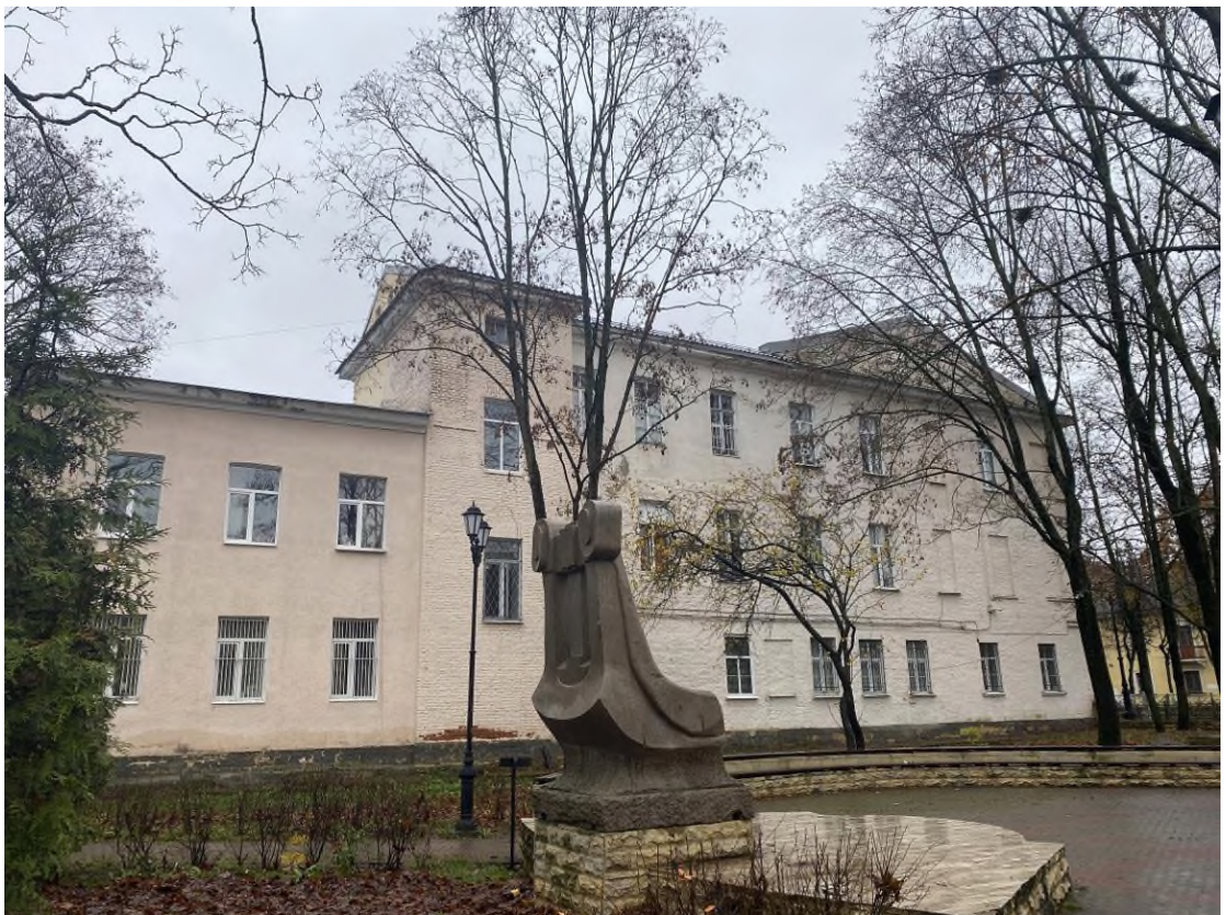
Фото 8. Общий вид с юга (г. Гатчина, пр. 25 Октября, д. 18)
