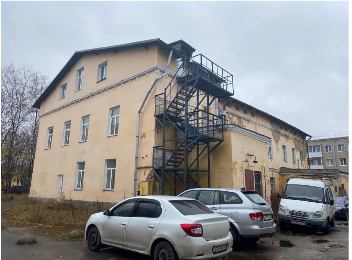
Фото 13. Общий вид реконструируемого ОКС с севера
