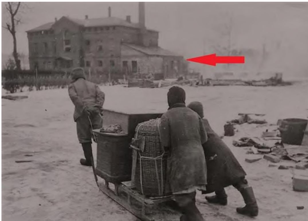
Рисунок 2. Общий вид здания в 1944 году
