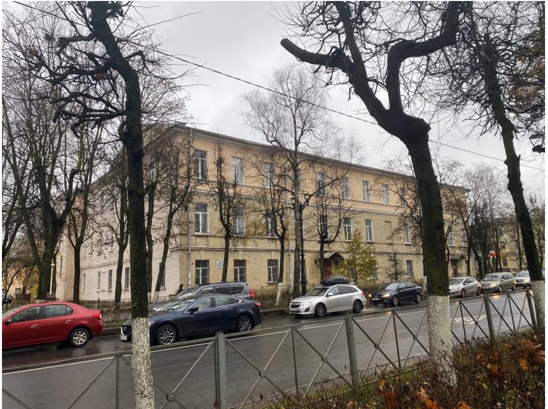
Фото 7. Общий вид с востока (г. Гатчина, пр. 25 Октября, д. 18)
