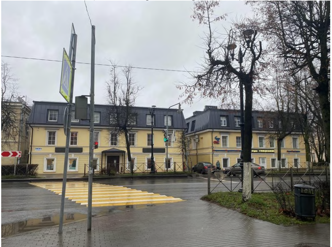
Фото 6. Общий вид с востока (г. Гатчина, пр. 25 Октября, д. 14, 16)
