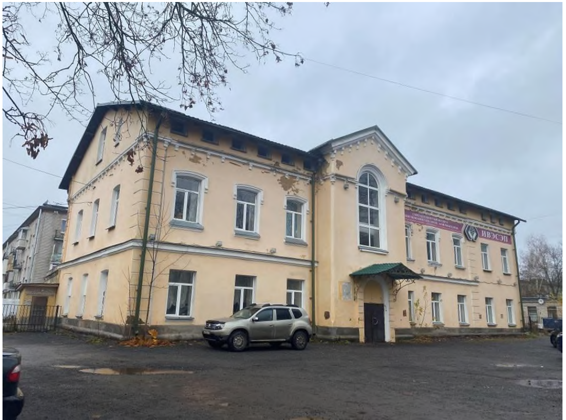
Фото 10. Общий вид реконструируемого ОКС с юго-востока
