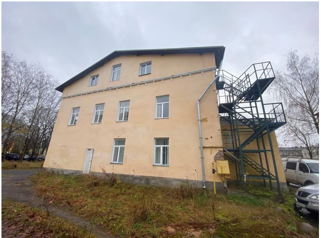
Фото 14. Общий вид реконструируемого ОКС с севера
