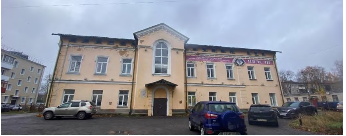
Фото 15. Общий вид реконструируемого ОКС с востока
