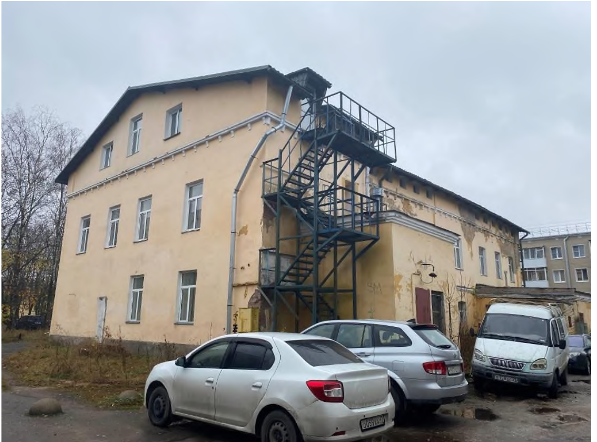
Фото 13. Общий вид реконструируемого ОКС с севера
