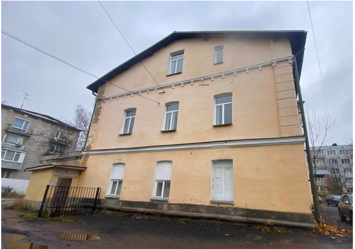
Фото 11. Общий вид реконструируемого ОКС с юго-востока
