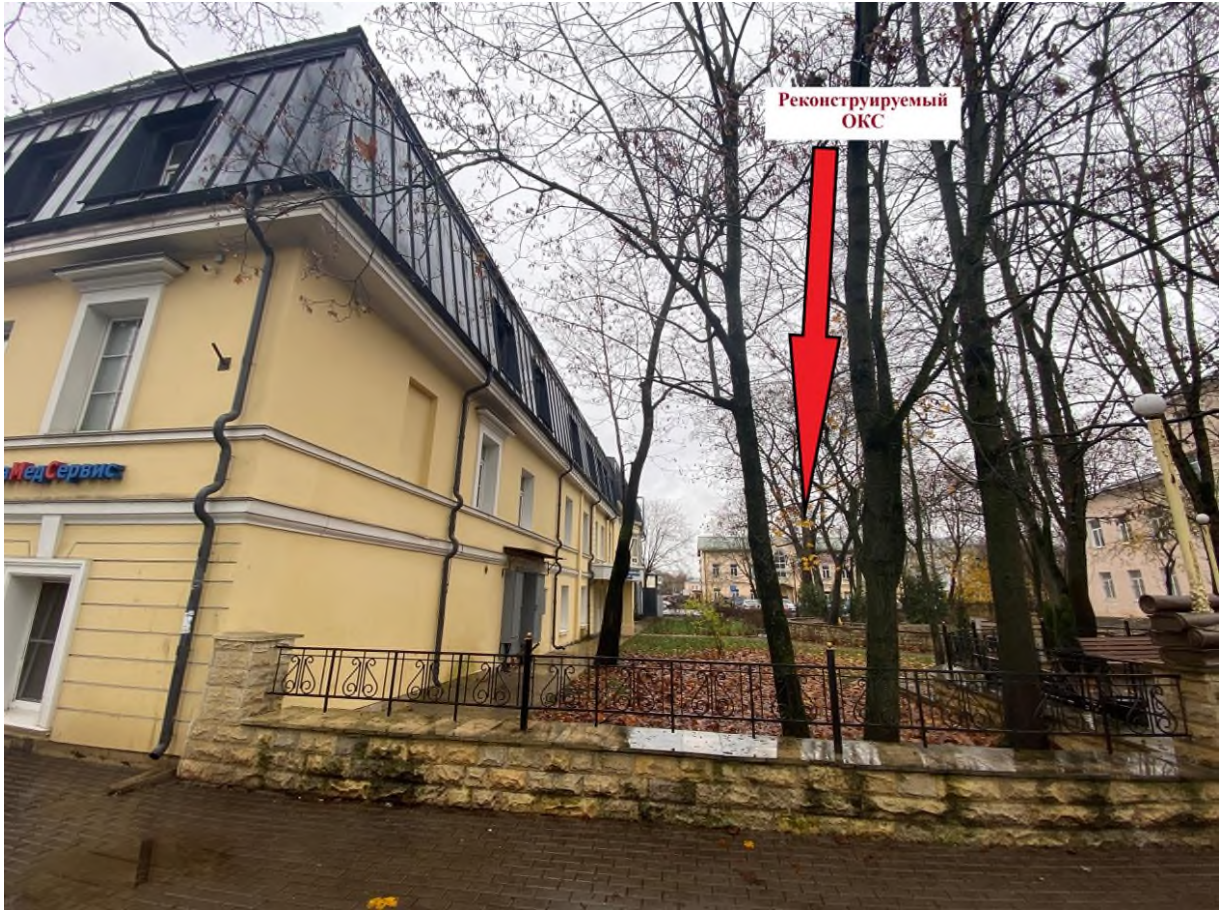
Фото 2. Фасад объекта с востока (г. Гатчина, пр. 25 Октября, д. 16)
