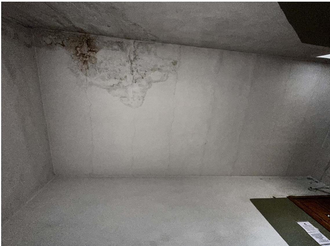
Фото 24. 3-ий этаж. Лестничная клетка в западной части здания. Протечки по стенам и потолку.
