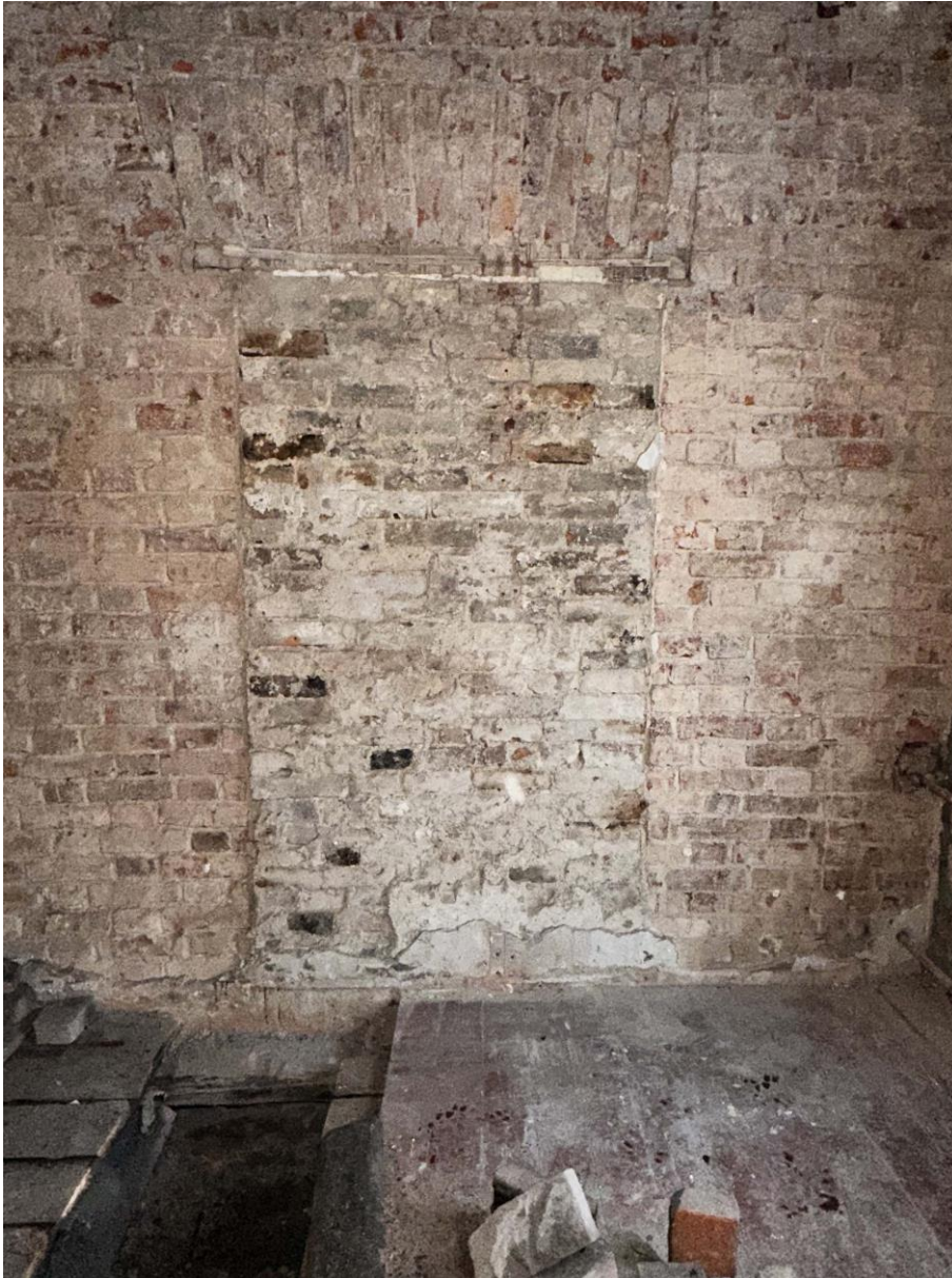
Фото 18. Заложенный исторический проем в несущей стене между исследуемым и соседним помещениями. Дата съемки 14.06.2023 г. Автор съемки: Глинская Н.Б.
