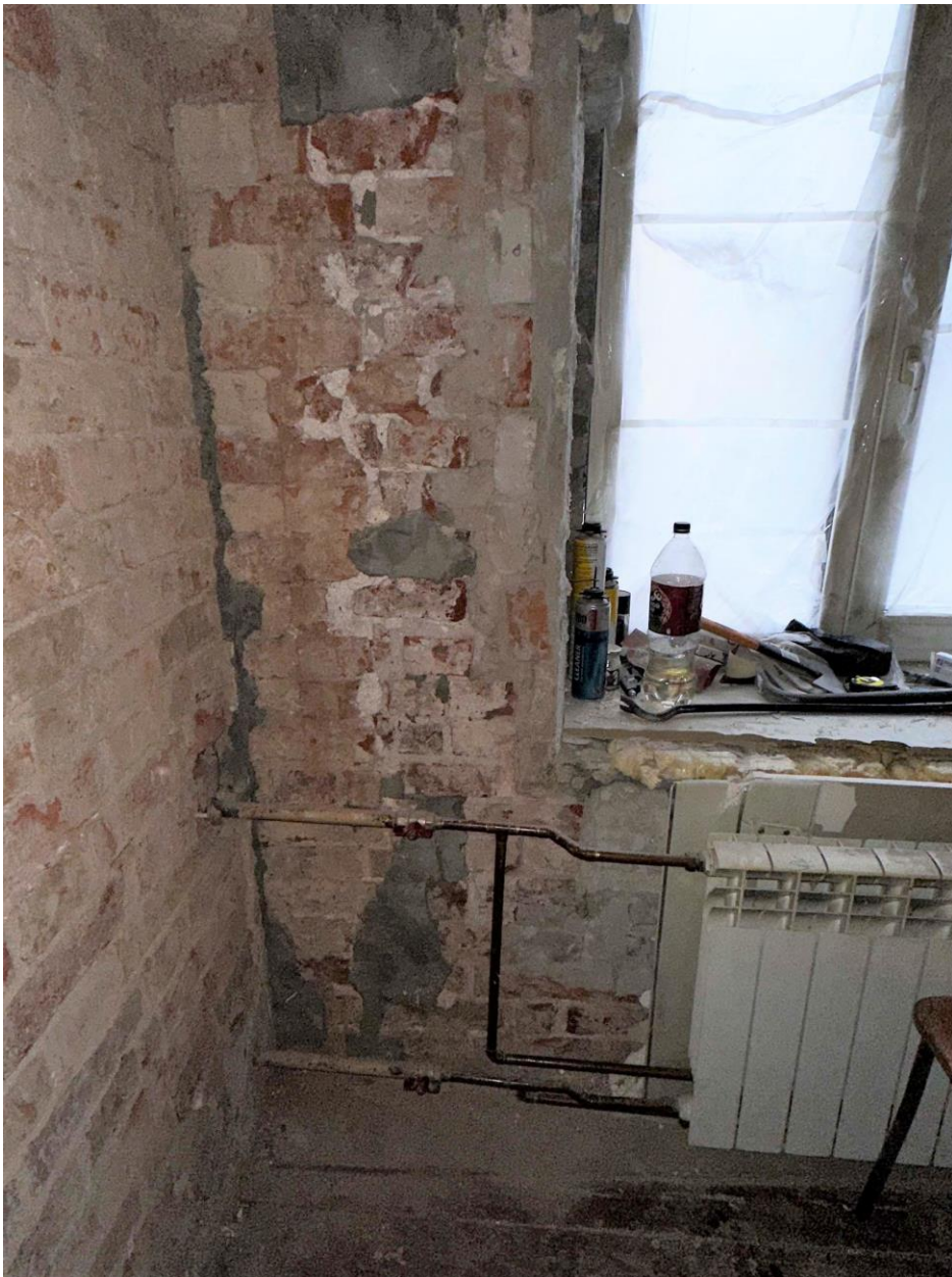
Фото 17. Перекладка откоса и закладка нижней части оконного проема в наружной уличной стене. Дата съемки 14.06.2023 г. Автор съемки: Глинская Н.Б.
