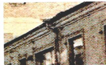
Фрагмент лицевого фасада. Венчающий карниз. Фото (копия) 1954 г.
