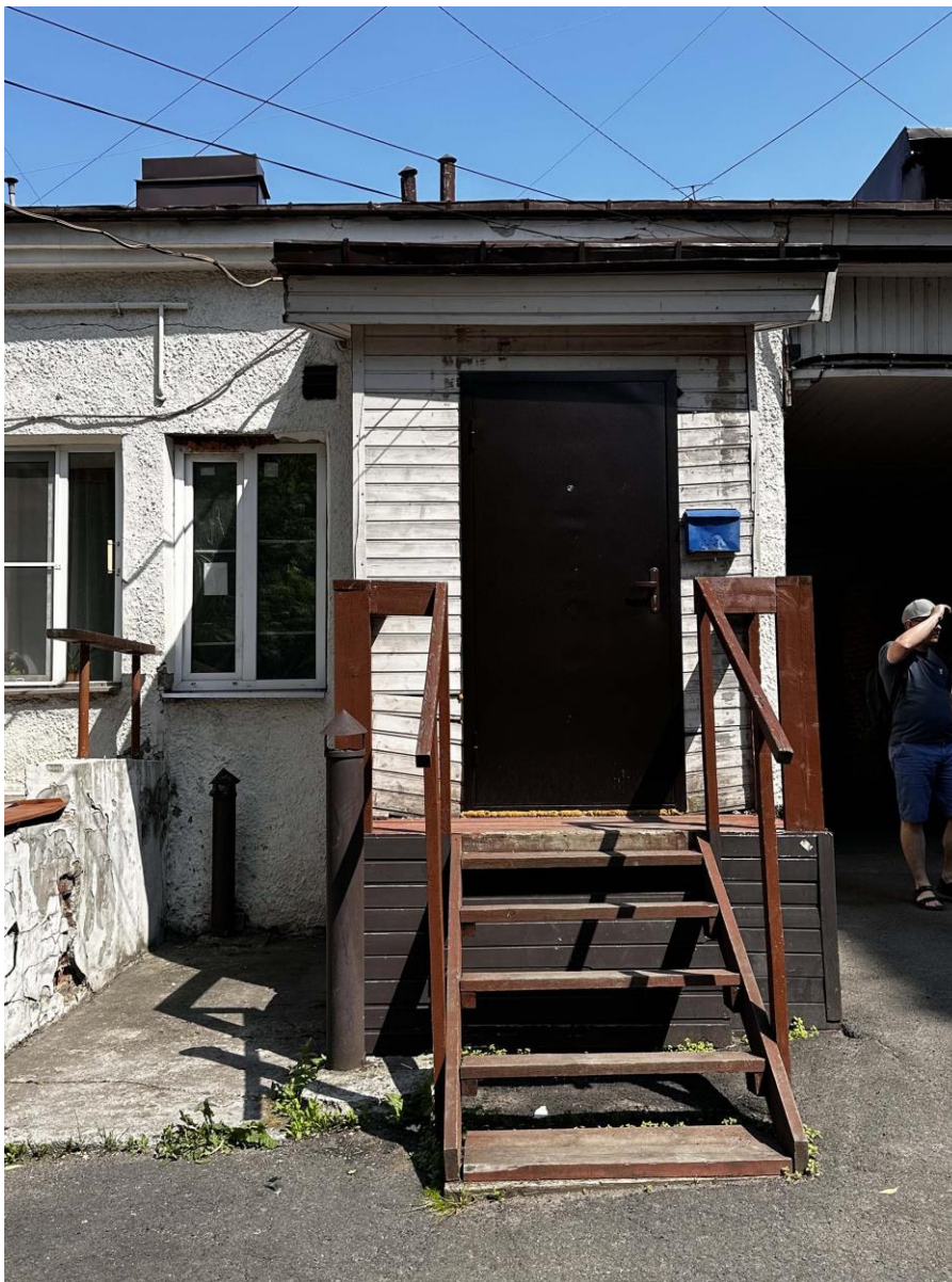
Фото 5. Фрагмент дворового юго-западного фасада здания. Входной тамбур в исследуемые помещения. Дата съемки 14.06.2023 г. Автор съемки: Глинская Н.Б.
