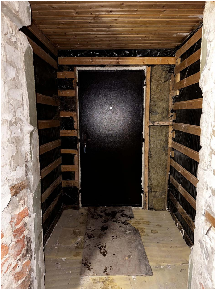
Фото 7. Общий вид помещения тамбура с северо-востока. Дата съемки 14.06.2023 г. Автор съемки: Глинская Н.Б.
