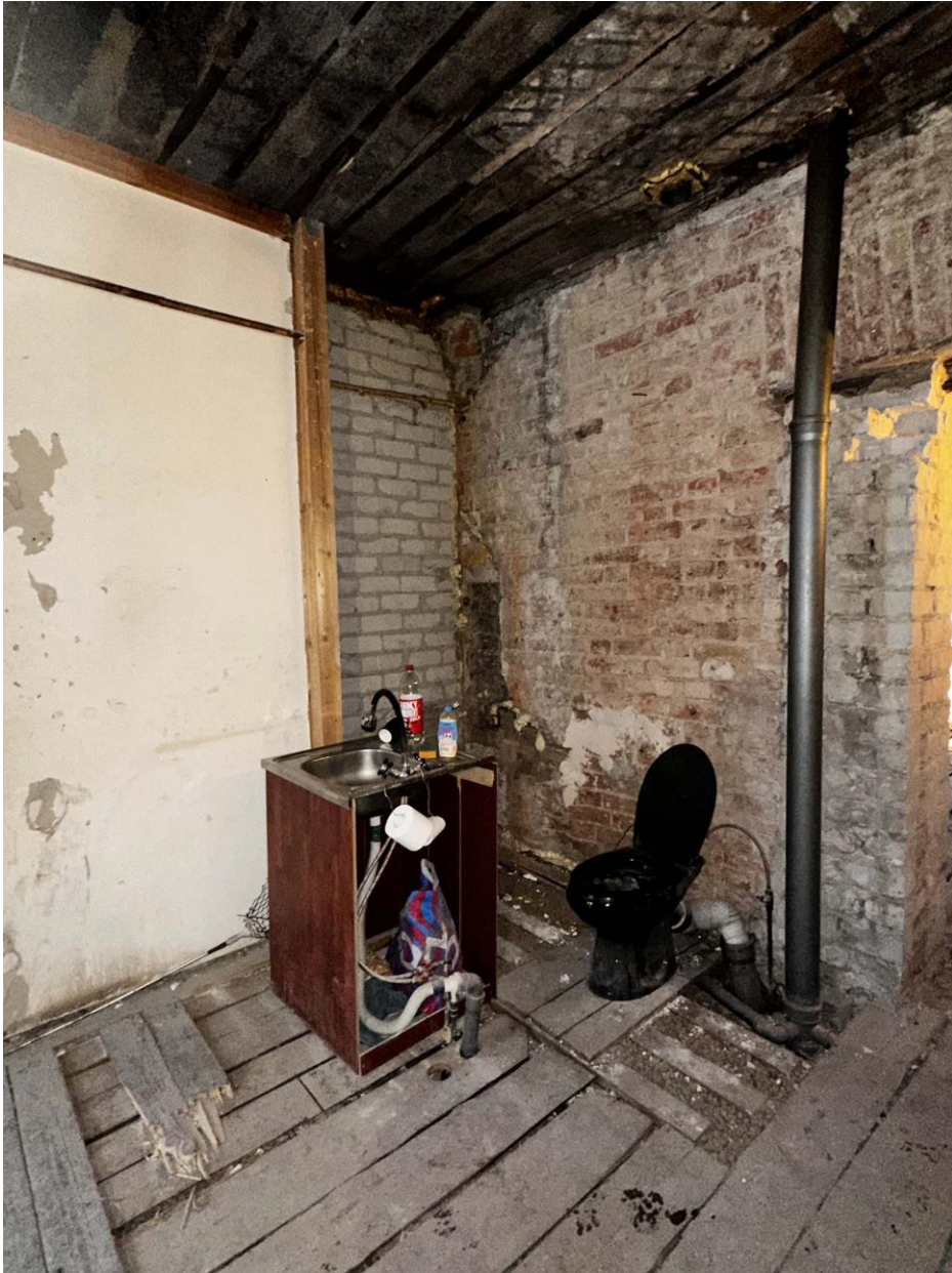
Фото 9. Вид на северный угол помещения в дворовой части здания. Дата съемки 14.06.2023 г. Автор съемки: Глинская Н.Б.
