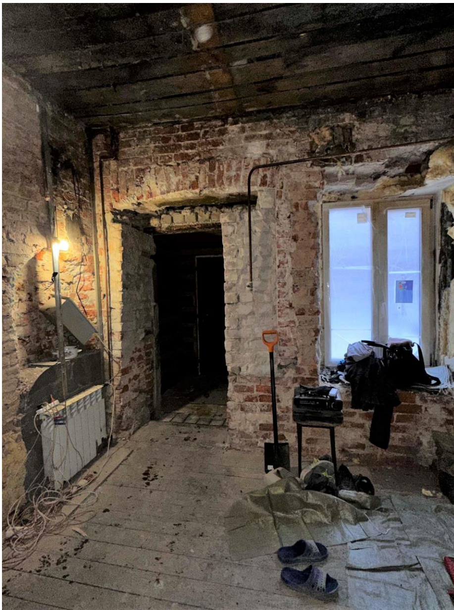
Фото 8. Общий вид помещения в дворовой части здания с севера. Дата съемки 14.06.2023 г. Автор съемки: Глинская Н.Б.
