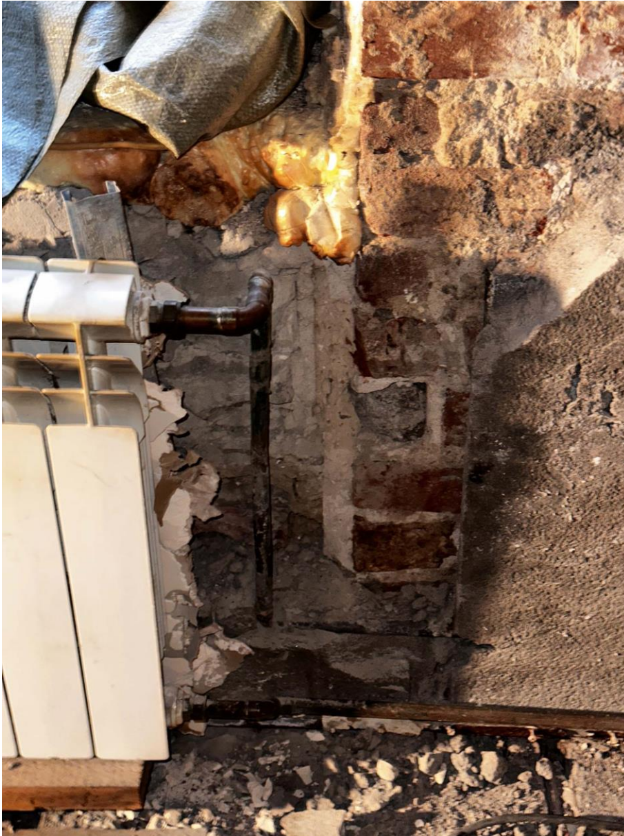
Фото 14. Закладка в правой части исторического витринного проема в наружной уличной стене. Дата съемки 14.06.2023 г. Автор съемки: Глинская Н.Б.
