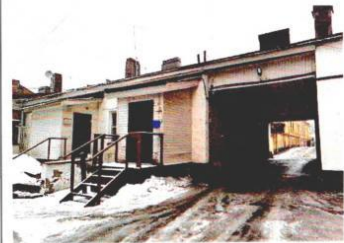
Левая часть дворового Ю-В фасада
