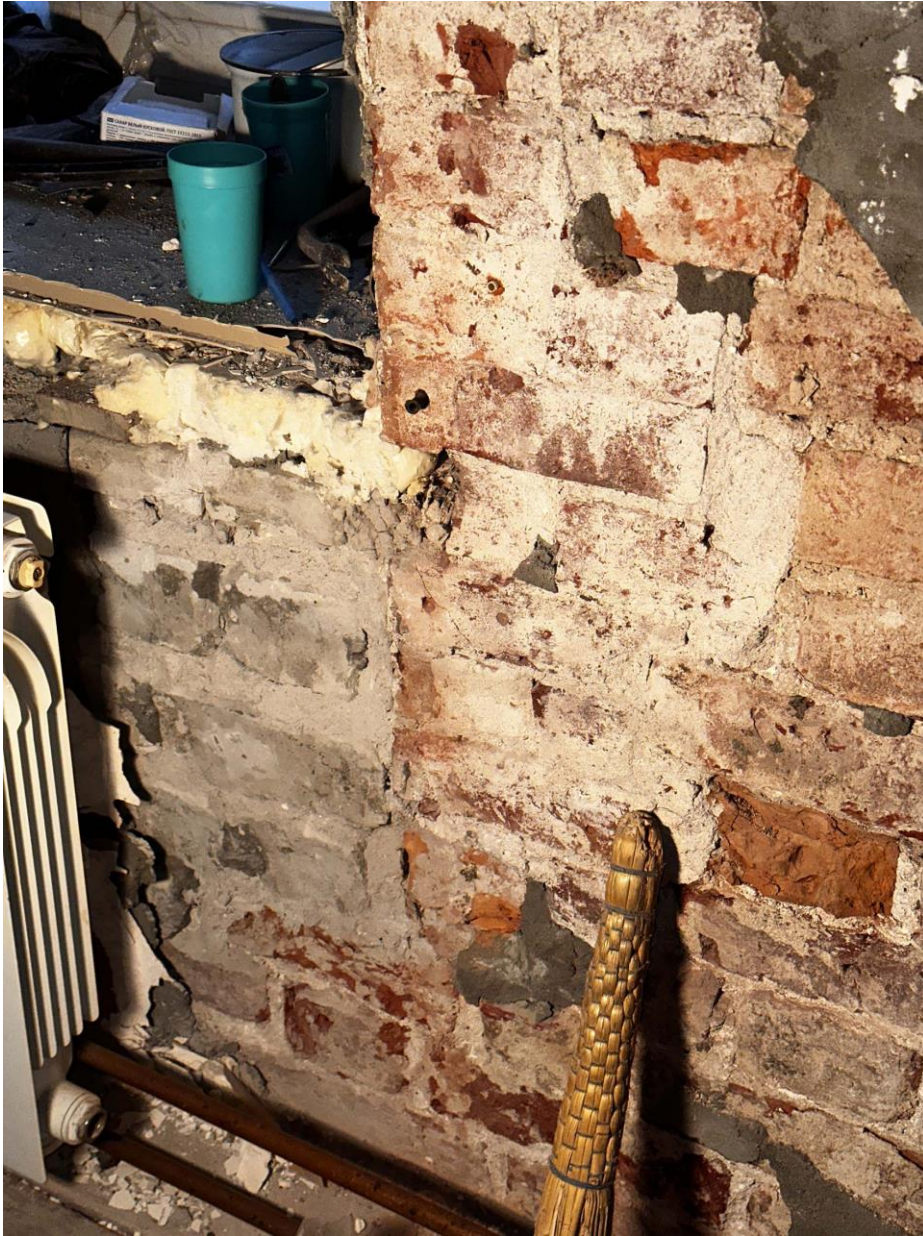
Фото 16. Перекладка и закладка нижней части оконного проема в наружной уличной стене. Дата съемки 14.06.2023 г. Автор съемки: Глинская Н.Б.
