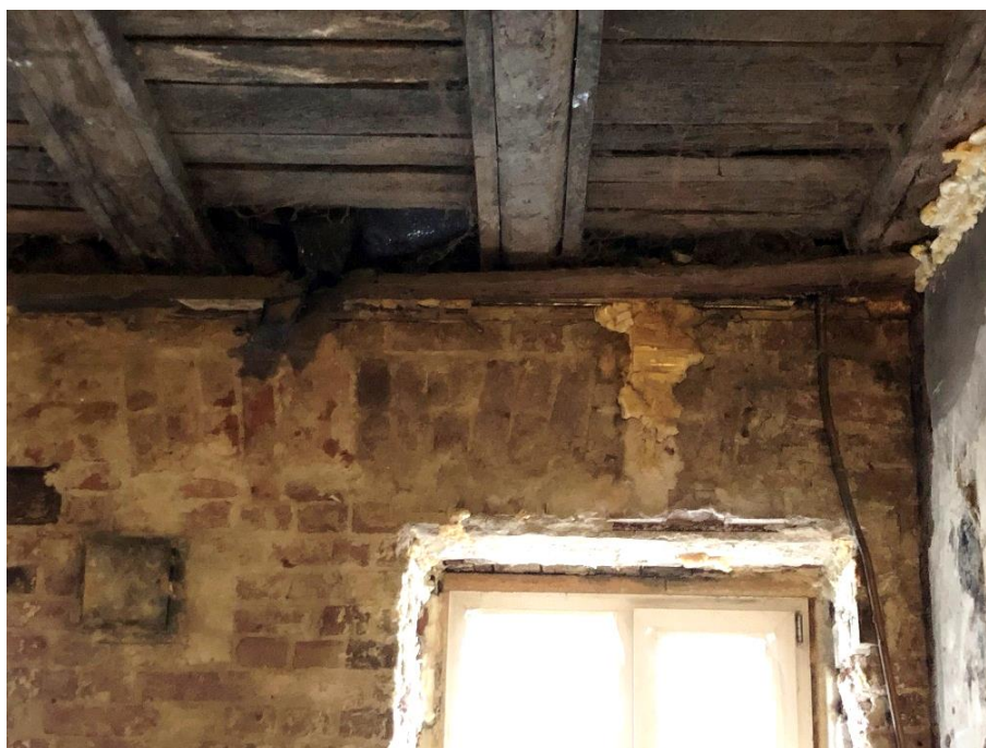
Фото 16. Помещение 1.1. Вид на перемычку частично заложеного дверного проема в стене по оси А. Зондаж 1.
