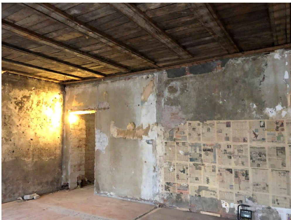
Фото 9. Помещение 1.1. Общий вид с северо-запада.
