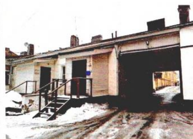
Левая часть дворового Ю-В фасада
