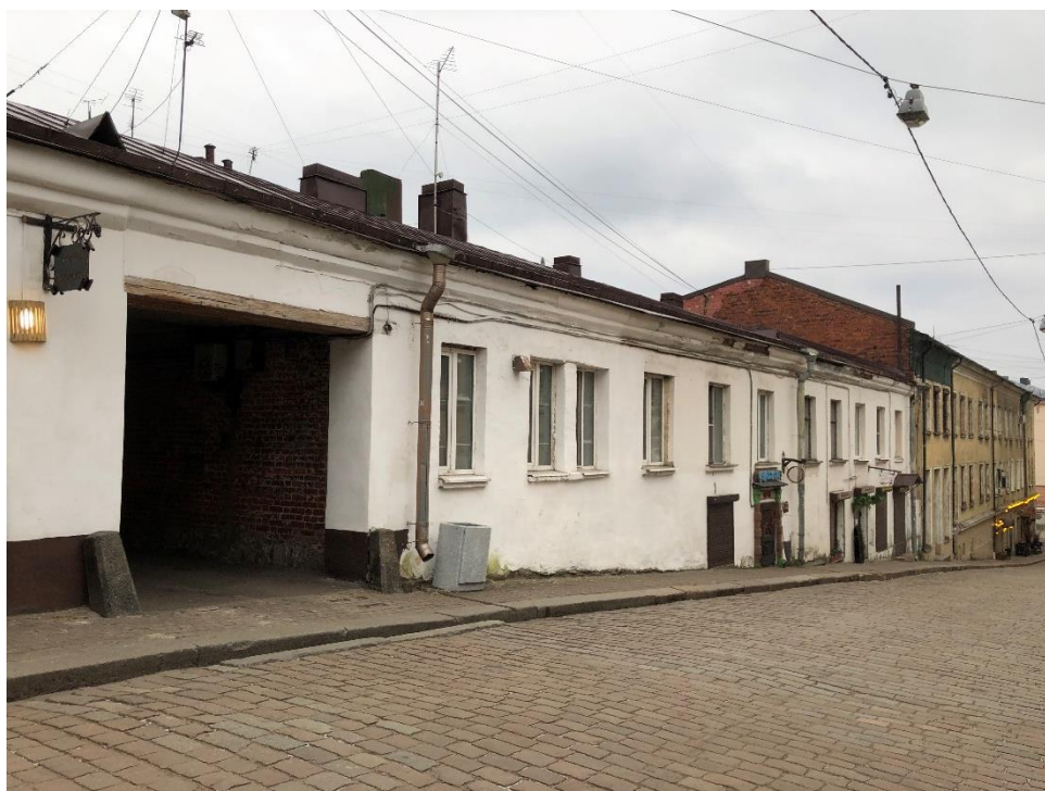
Фото 2. Фрагмент правой части лицевого фасада по ул. Крепостной. Вид с востока.
