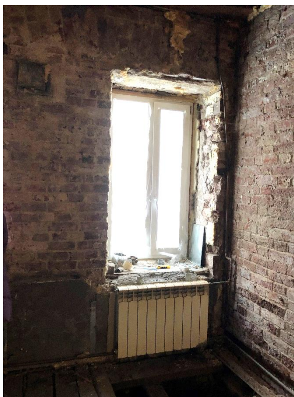
Фото 12. Помещение 1.1. Вид на частично заложённый дверной проем в стене по оси А.
