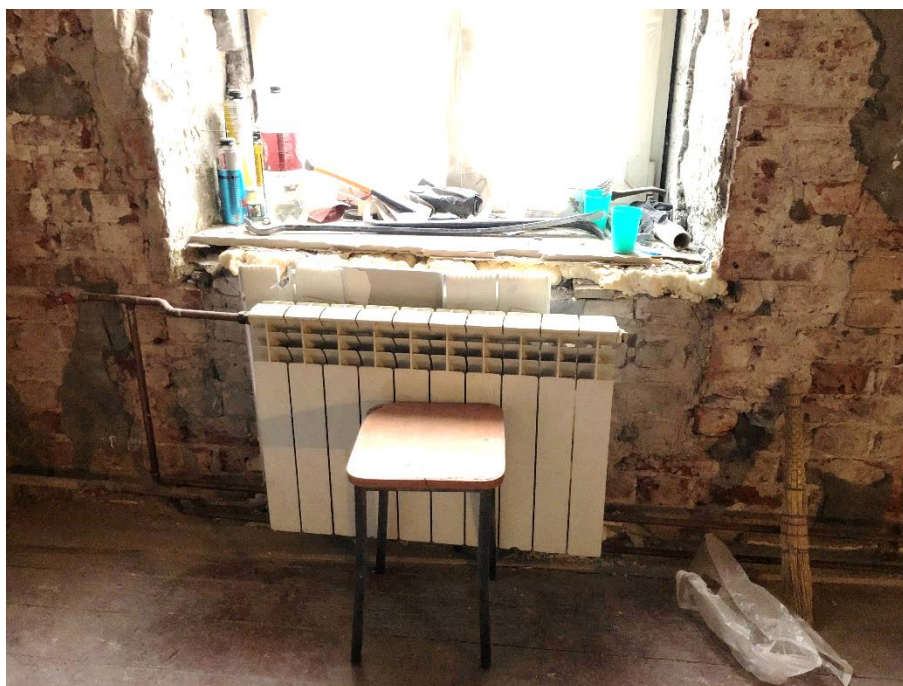
Фото 14. Помещение 1.1. Откосы выявленного малого витринного проема. Зондаж 3.
