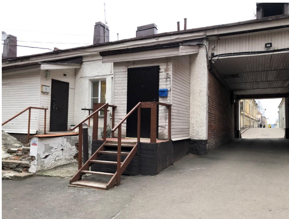
Фото 6. Фрагмент центральной части дворового фасада, соответствующий помещениям Заказчика.
