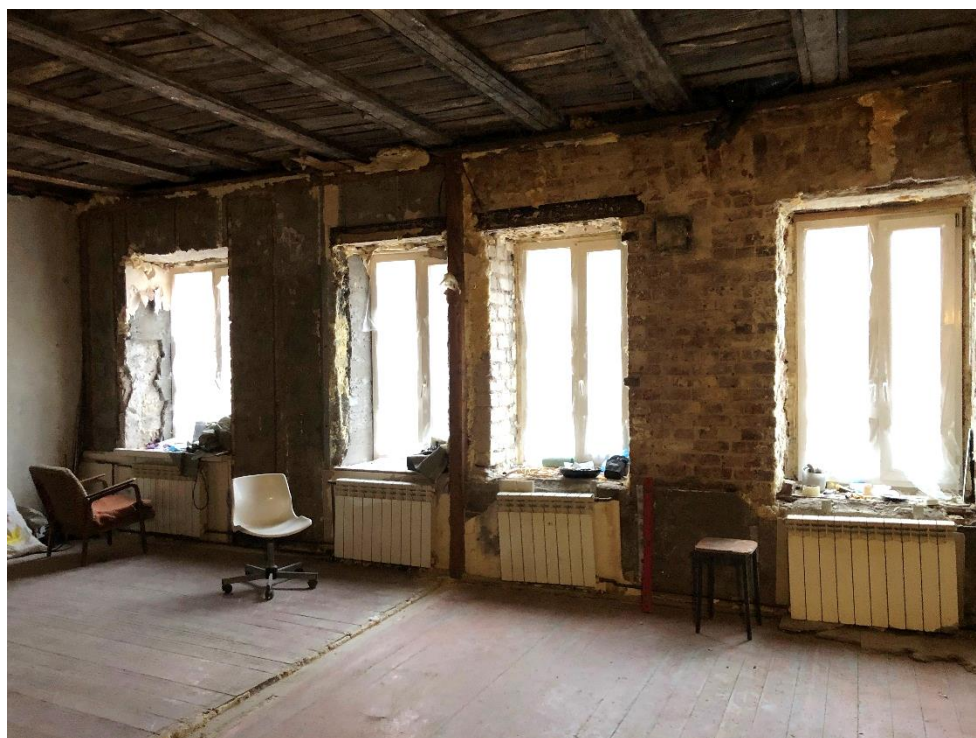
Фото 7. Помещение 1.1. Общий вид с юго-востока.
