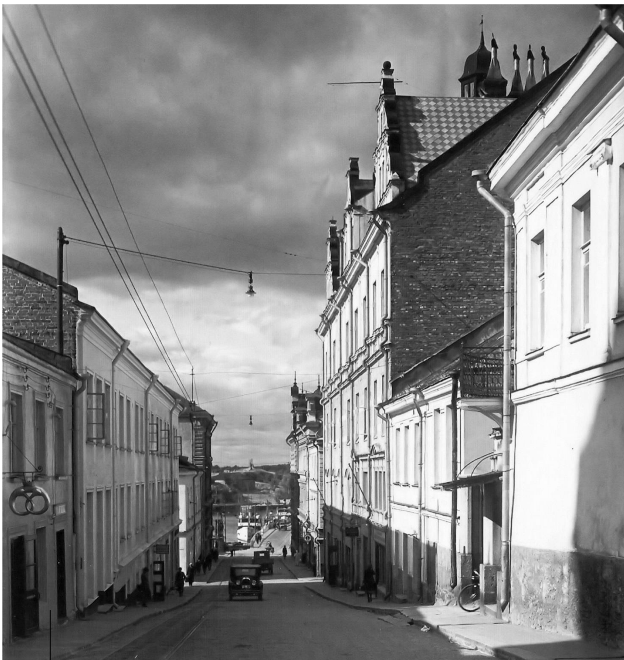
Жилой дом по ул. Линнанкату, 5
