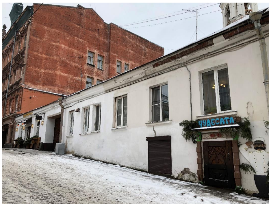
Фото 3. Фрагмент центральной части лицевого фасада по ул. Крепостной. Вид с севера.
