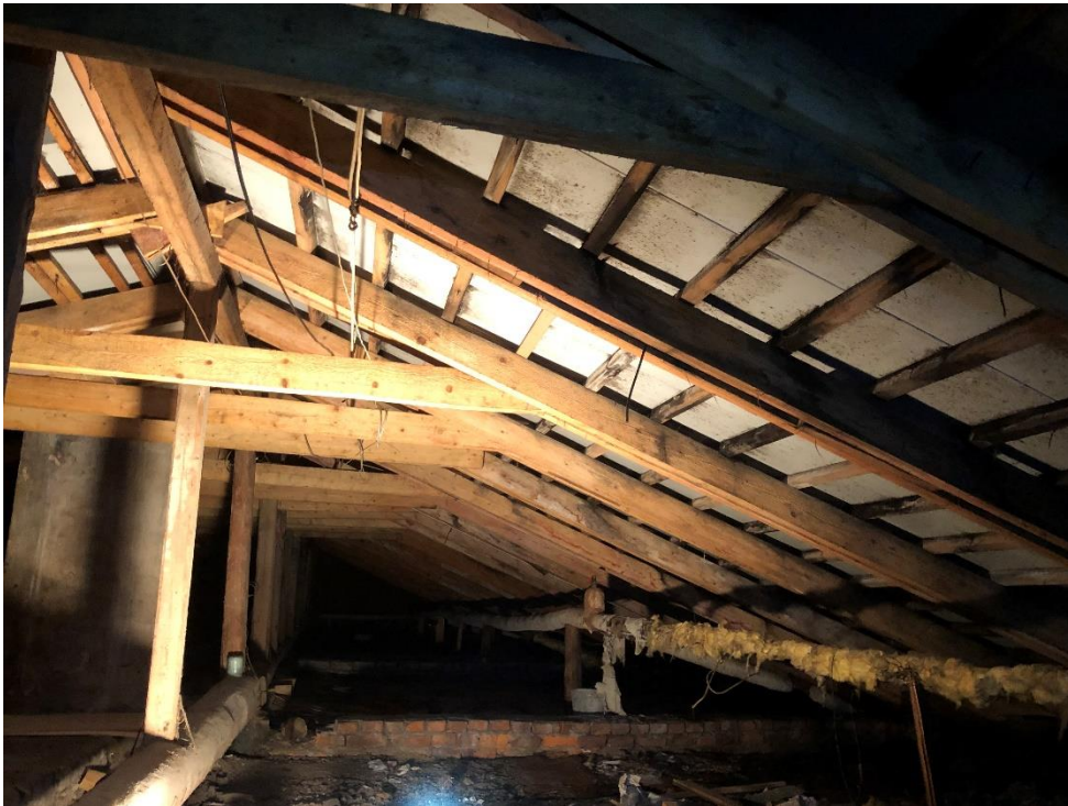
Фото 26. Общий вид чердака, над помещением 1.1.
