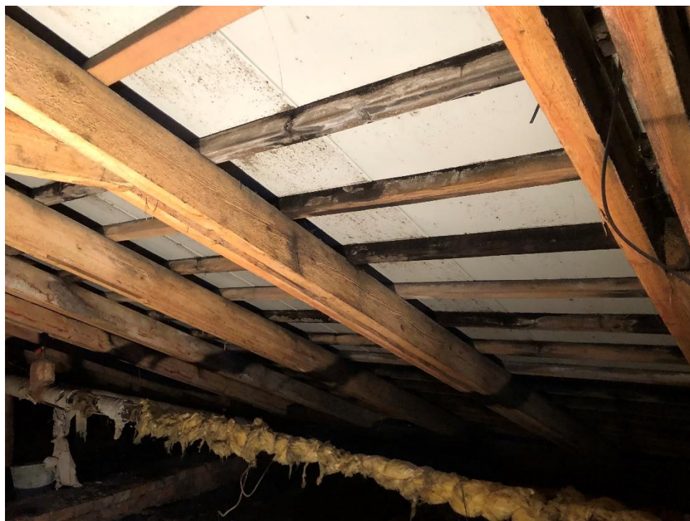
Фото 27. Помещение чердака над помещением 1.1. у оси А.
