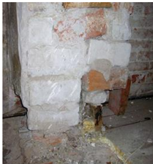
Фото 13, 14. Пробита кладка несущего пилона в опорной части.
