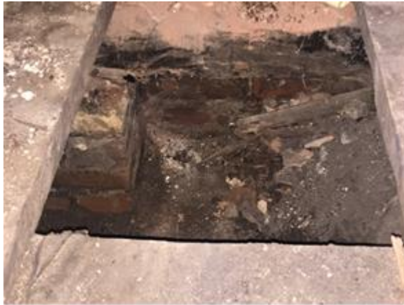
Фото 17. Вскрытие дощатого пола по кирпичным столбикам.
