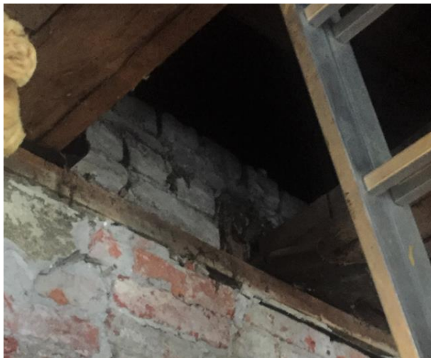
Фото 18. Вскрытие перекрытия над 1-м этажом.
