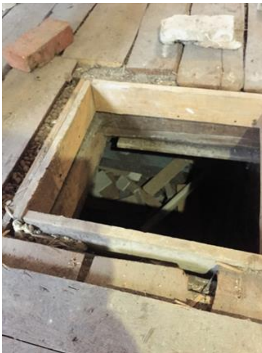
Фото 19. Вскрытие перекрытия над подпольем.
