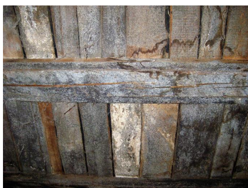
Фото 2, 3. Продольные трещины в несущих балках перекрытия, деформация балок
