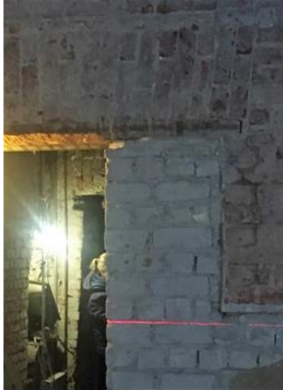
Фото 8. Поздняя частичная закладка дверного проема кладкой из силикатного кирпича – уменьшена ширина проема
