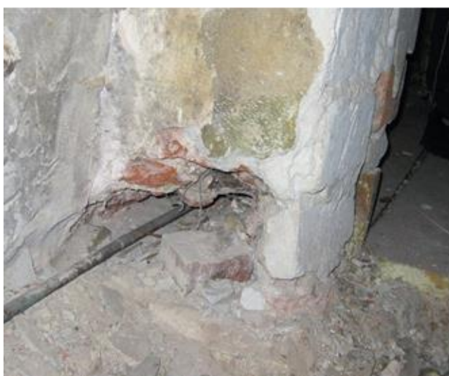
Фото 13, 14. Пробита кладка несущего пилона в опорной части.
