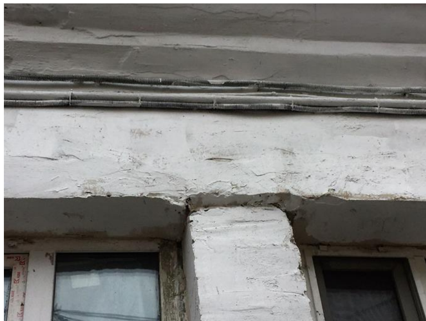
Фото 28. Грубая обмазка шпаклевочной смесью перемычки над оконными проемами на главном фасаде.
