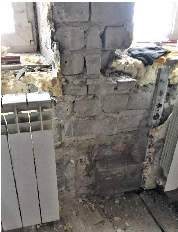
Фото 5. Разрушение кладки из силикатного кирпича межоконного простенка, растворных швов в поясе кладки под окнами.
