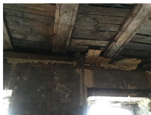
Фото 2, 3. Продольные трещины в несущих балках перекрытия, деформация балок
