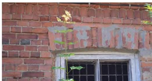
кирпичные лучковые перемычки оконных и дверных проемов;
