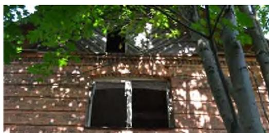
отделка юго-западного фасада с историческим входным проемом: кладка из гранитных камней в уровне 1-го этажа, небольшие вставки гранитной кладки, фланкирующие входной проем;
