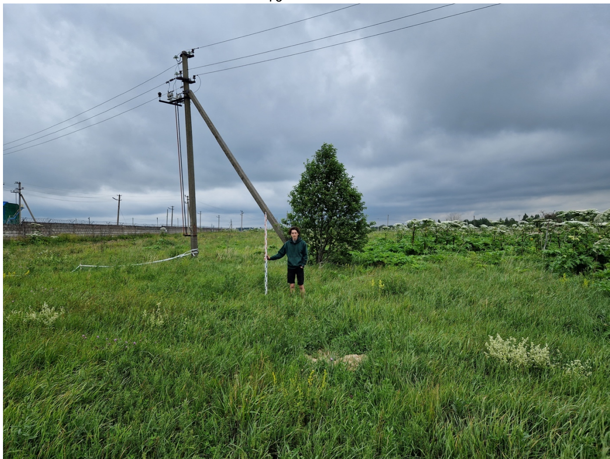
Рис.18. Ленинградская область, Гатчинский район, д. Лядино. Точка съёмки №2. Вид на север.
