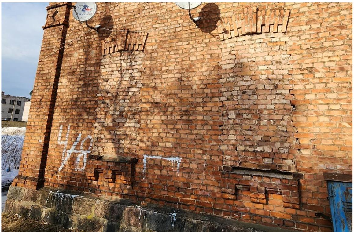
Фото 12. Торцевой фасад. Заложенные оконные проемы в уровне 1-го этажа.
