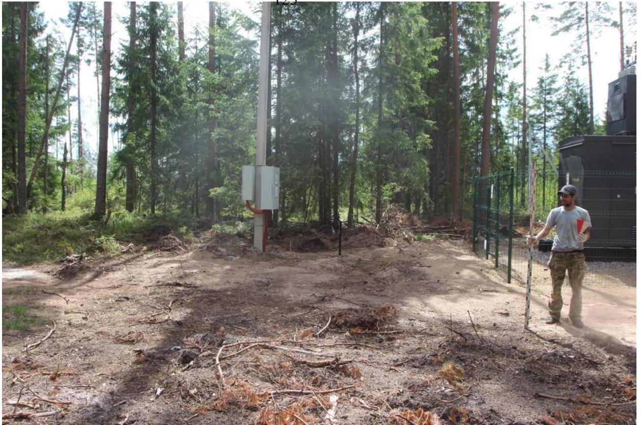
Рис. 25. ЛО_2023. Рахъя КН 867-870, 1293. Точка фотофиксации 3, вид на юго-восток.
