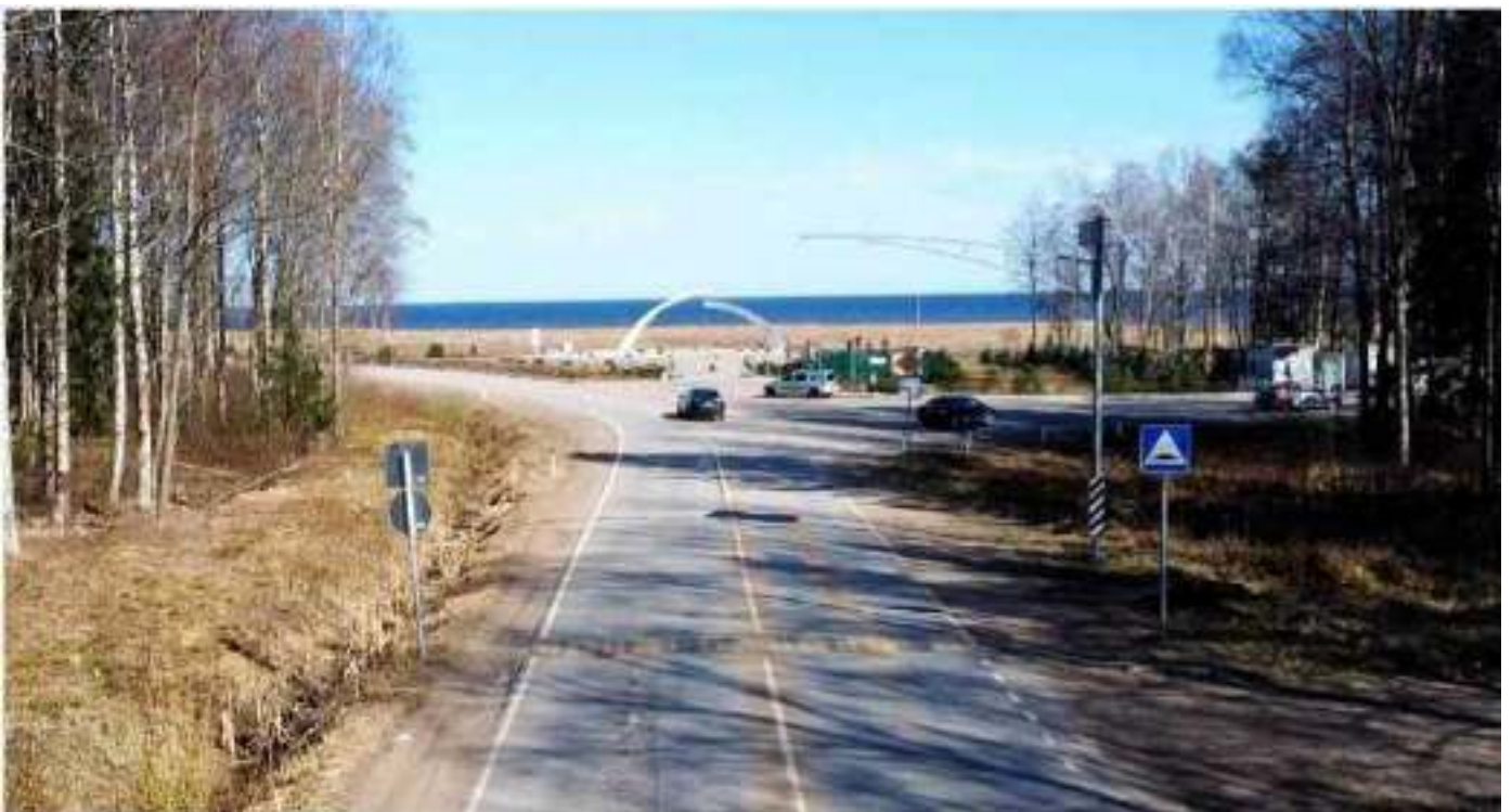
78. Деревня Коккорево, трасса автомобильной дороги 41К-064 («Дорога жизни»). Вид с запада.
