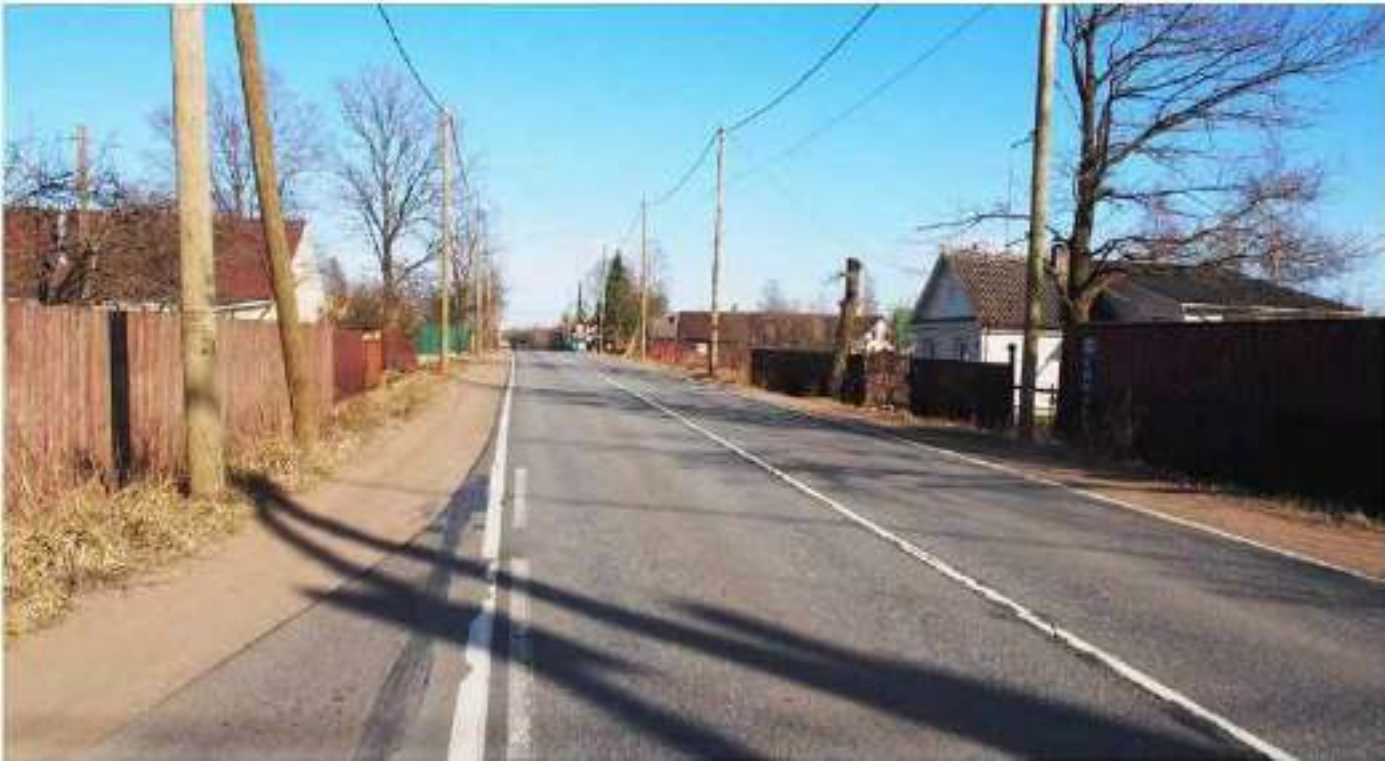
61. Деревня Ириновка. Застройка вдоль трассы автодороги 41К-064 («Дорога жизни»).
