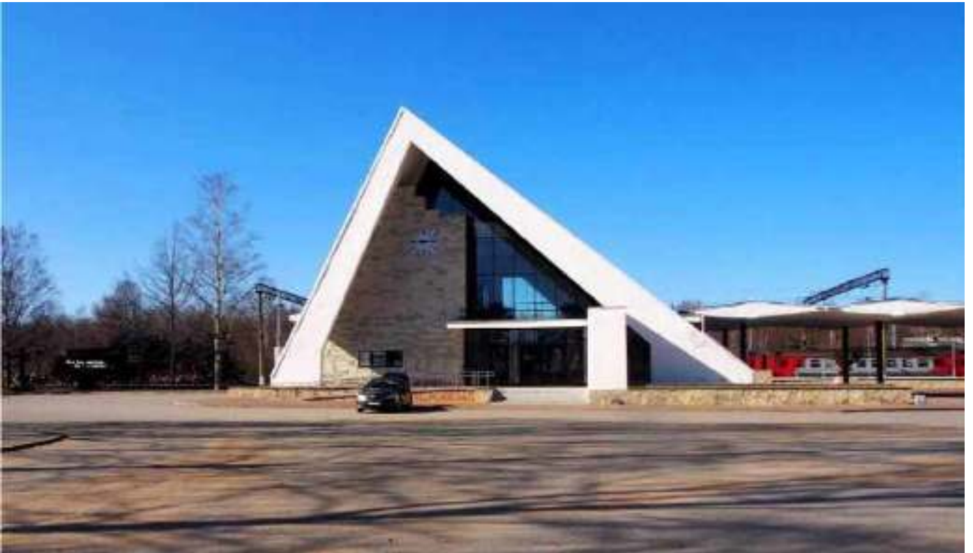
111. Мемориальный вокзал станции Ладожское Озеро. Вид с северо-востока.
