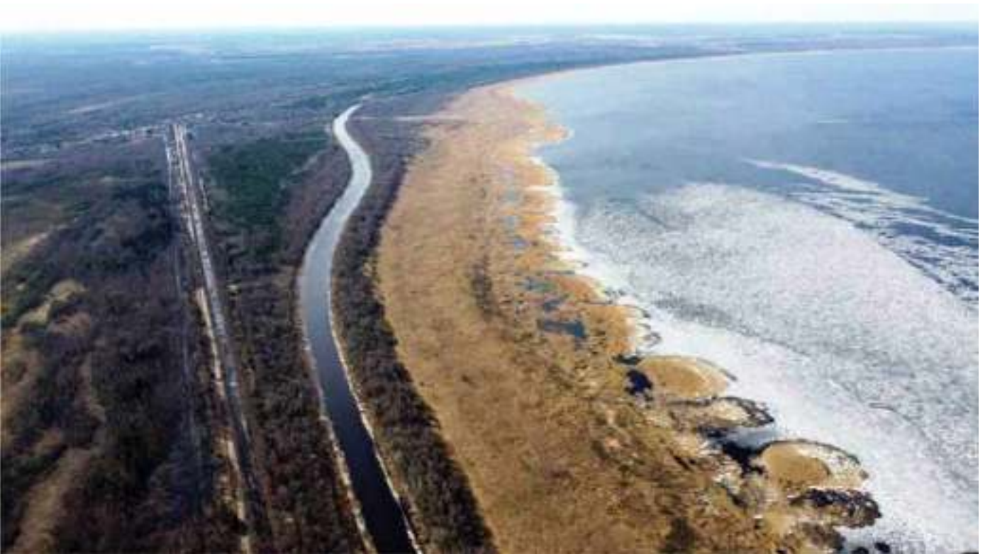
40. Рельеф восточного берега Ладожского озера. Новолодожский и Старолодожский каналы. Вид с севера, на дальнем плане деревня Лаврово.
