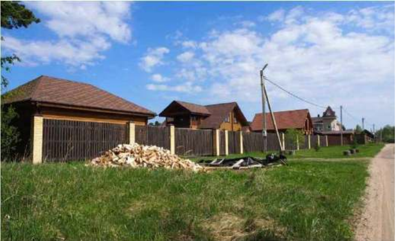
130. Современная застройка деревни Морье. Вид с юго-запада.
