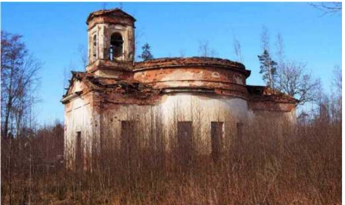
76. Никольская церковь в погосте Верола. Вид с юга.
