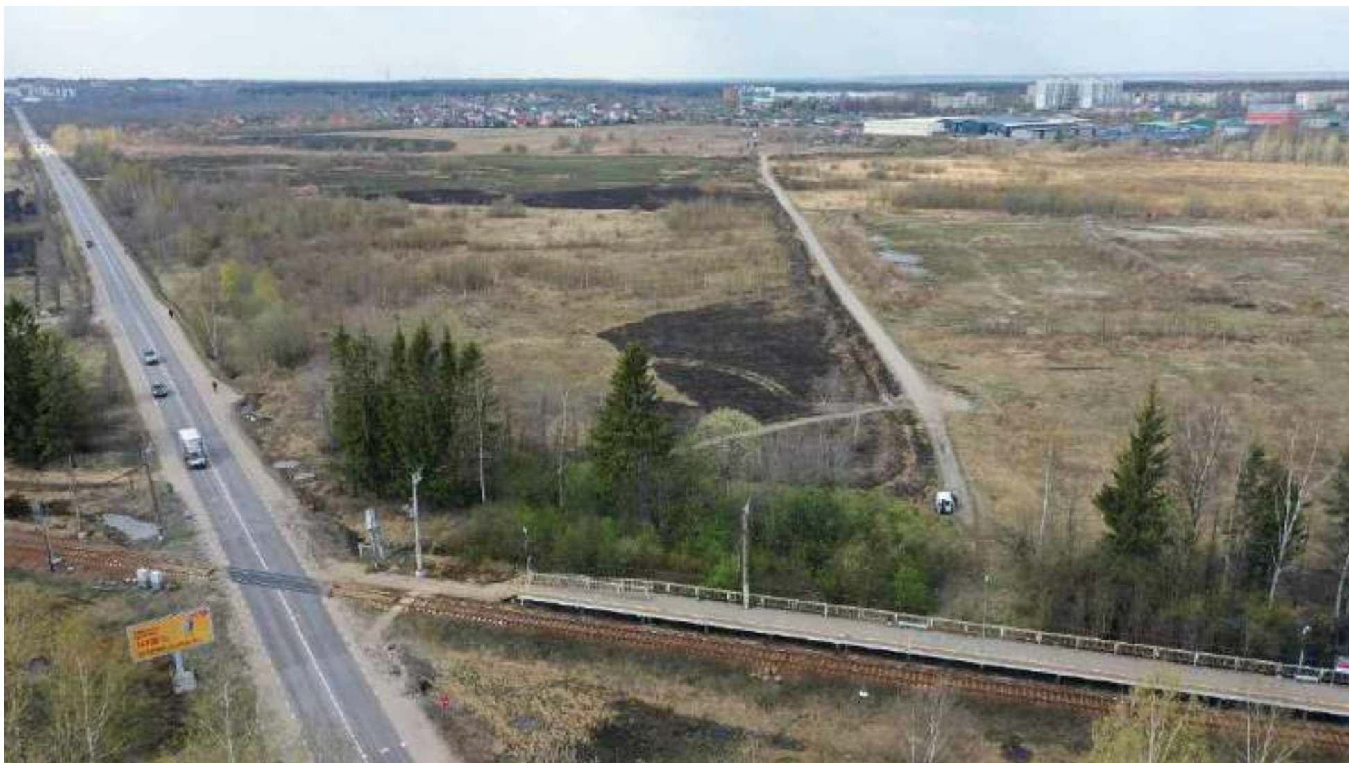
1.3. Участок автомобильной дороги 41К-70 Станция Магнитная – пос. им. Морозова и Жд станция Романовка.
