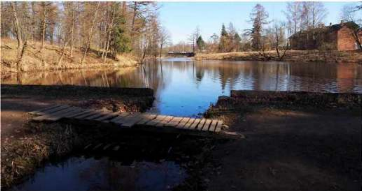
12. г. Всеволожск, шоссе Дорога Жизни, 5-й км. Вид с водослива на запруде на шоссе Дорога Жизни.
