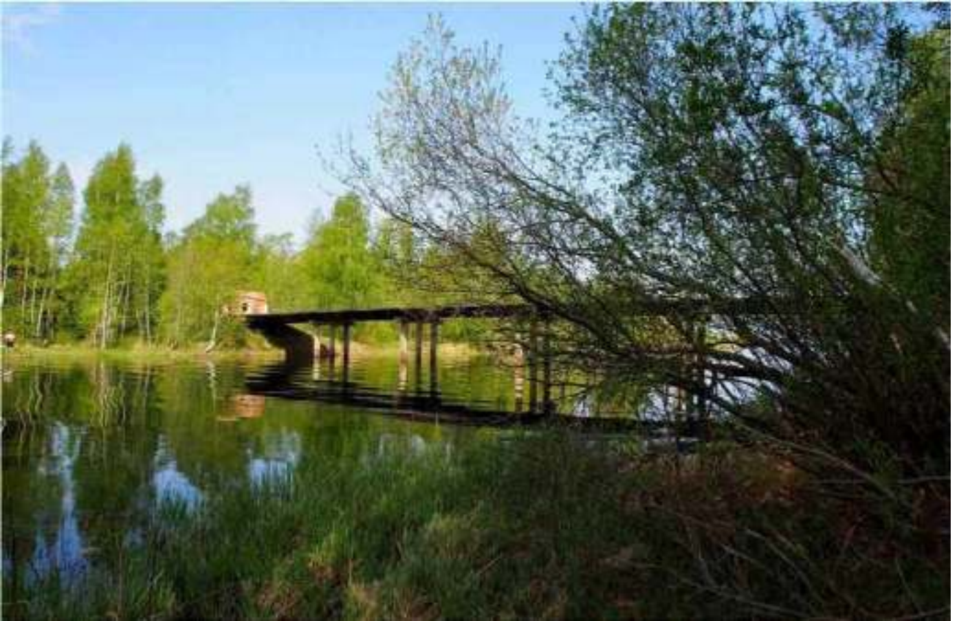
126. Деревня Морье. Мост через реку Морье. Вид с юго-востока, от объекта культурного наследия регионального значения «Братское захоронение советских воинов и работников ленинградского завода им. К.Е. Ворошилова, погибших при эвакуации во время Великой Отечественной войны».
