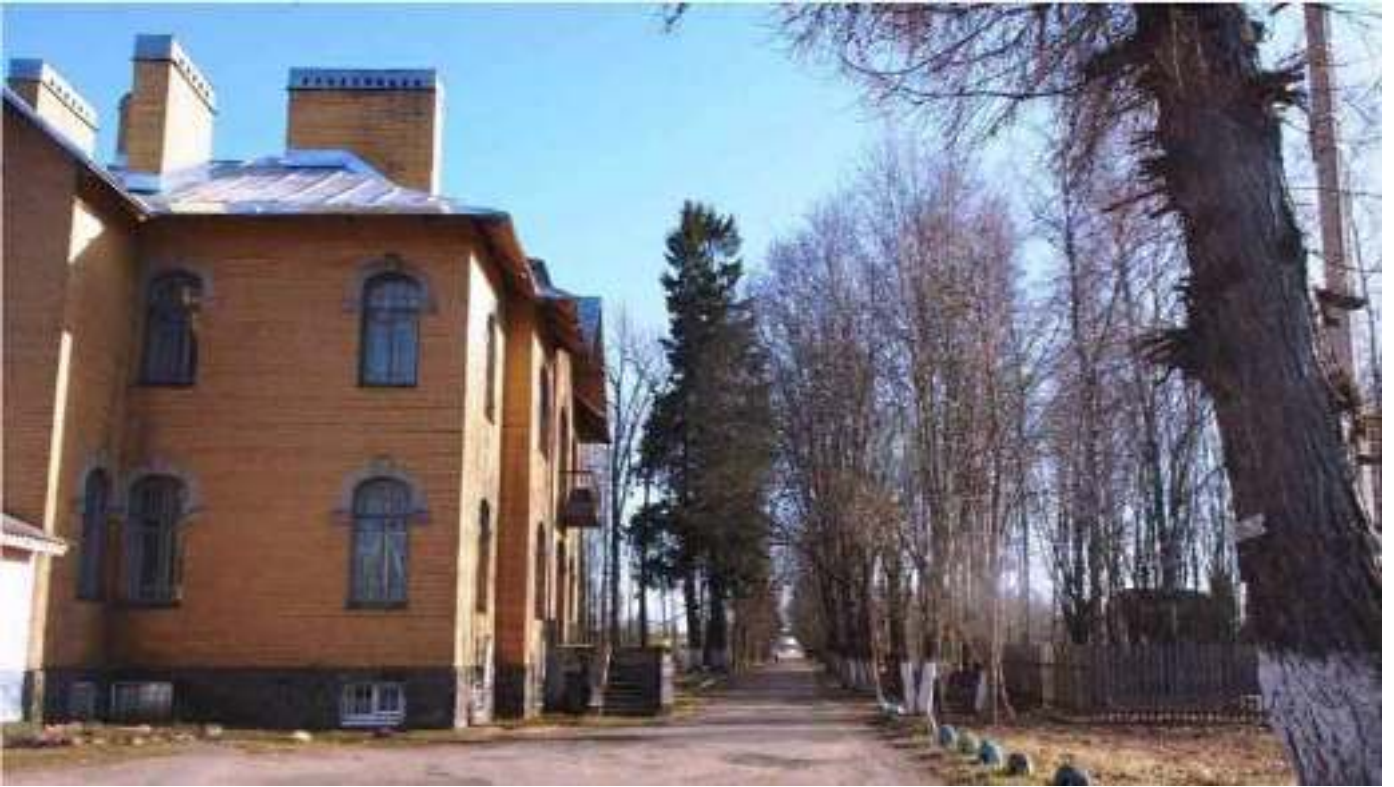
58. Деревня Ириновка. Усадьба баронов Корфов «Ириновка», кон. XVIII в. - кон. XIX в. Подъездная аллея к усадебному дому. Вид от усадебного дома на Ленинградское шоссе («Дорога жизни»).
