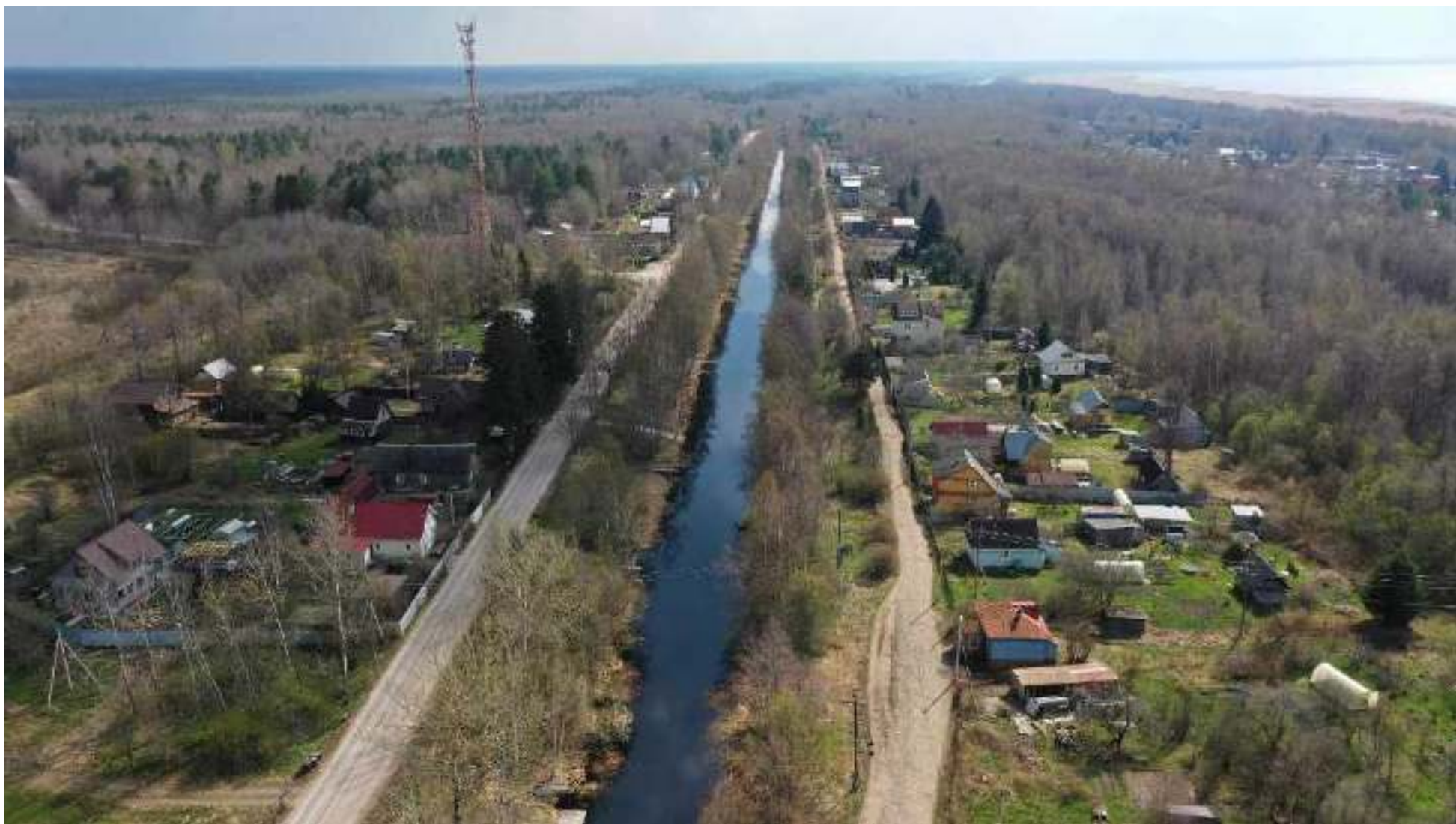
2.10. Автомобильная дорога Лаврово – Кобона – Сухое (41К - 123) в д. Кобона – слева. Ул. Староладожский канал, 1-я линия.
