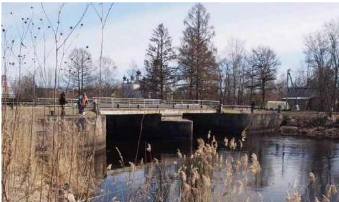
25. Деревня Кобона. Улица Набережная реки Кобона. Выявленный объект культурного наследия «Мост гранитный щитовой северный водоспуск».
