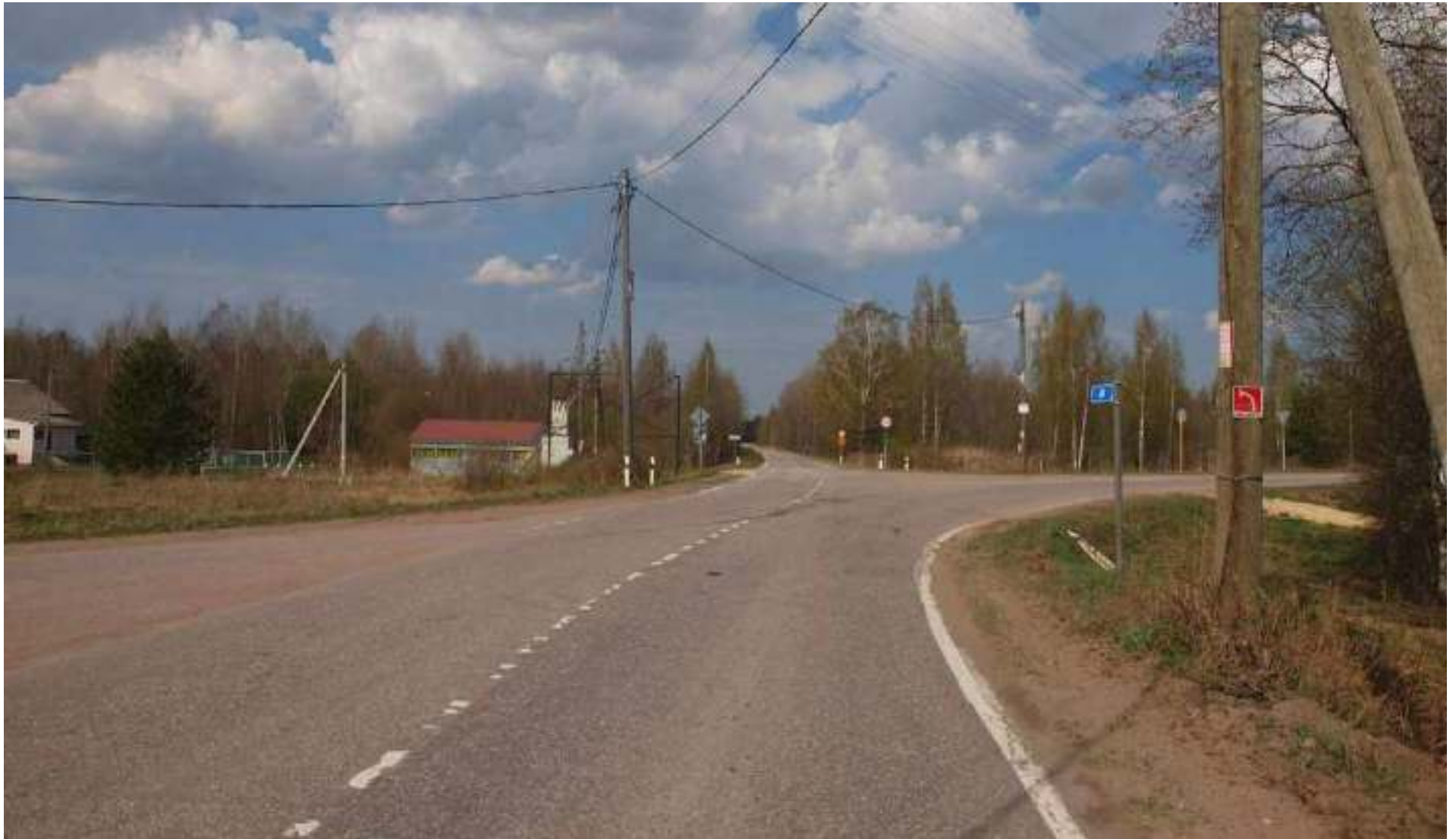
2.7. Автомобильная дорога 41К-119 в д. Сухое.
