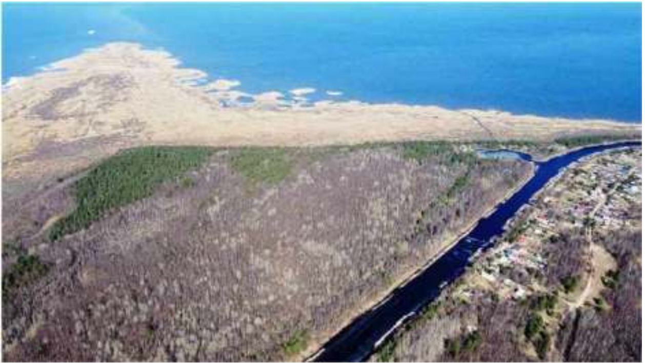
3. Кареджская коса, Новолодожский канал, деревня Леднево. Вид с востока.
