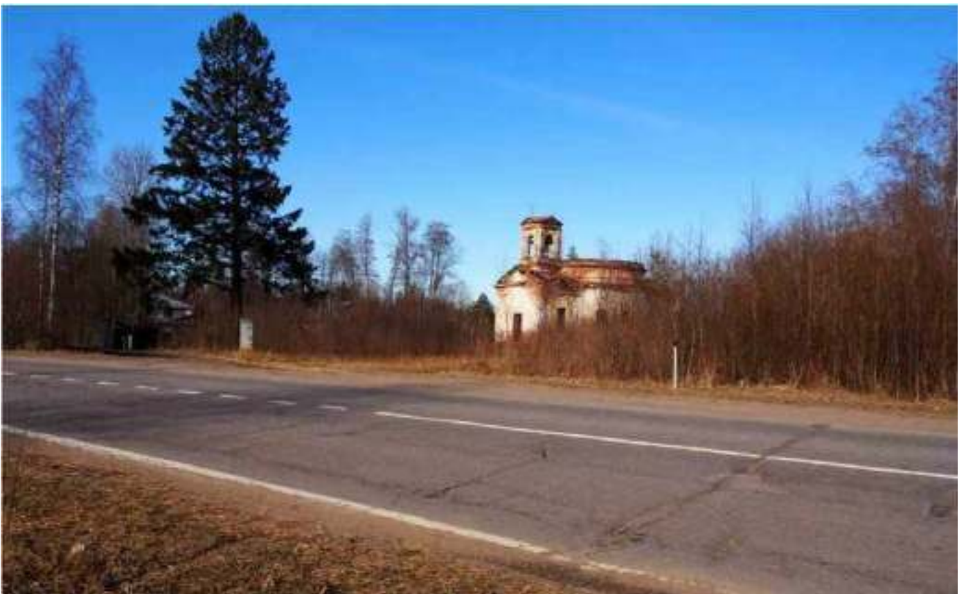
72. Никольская церковь в погосте Верола. Вид с юго-запада, от автодороги 41К-123
