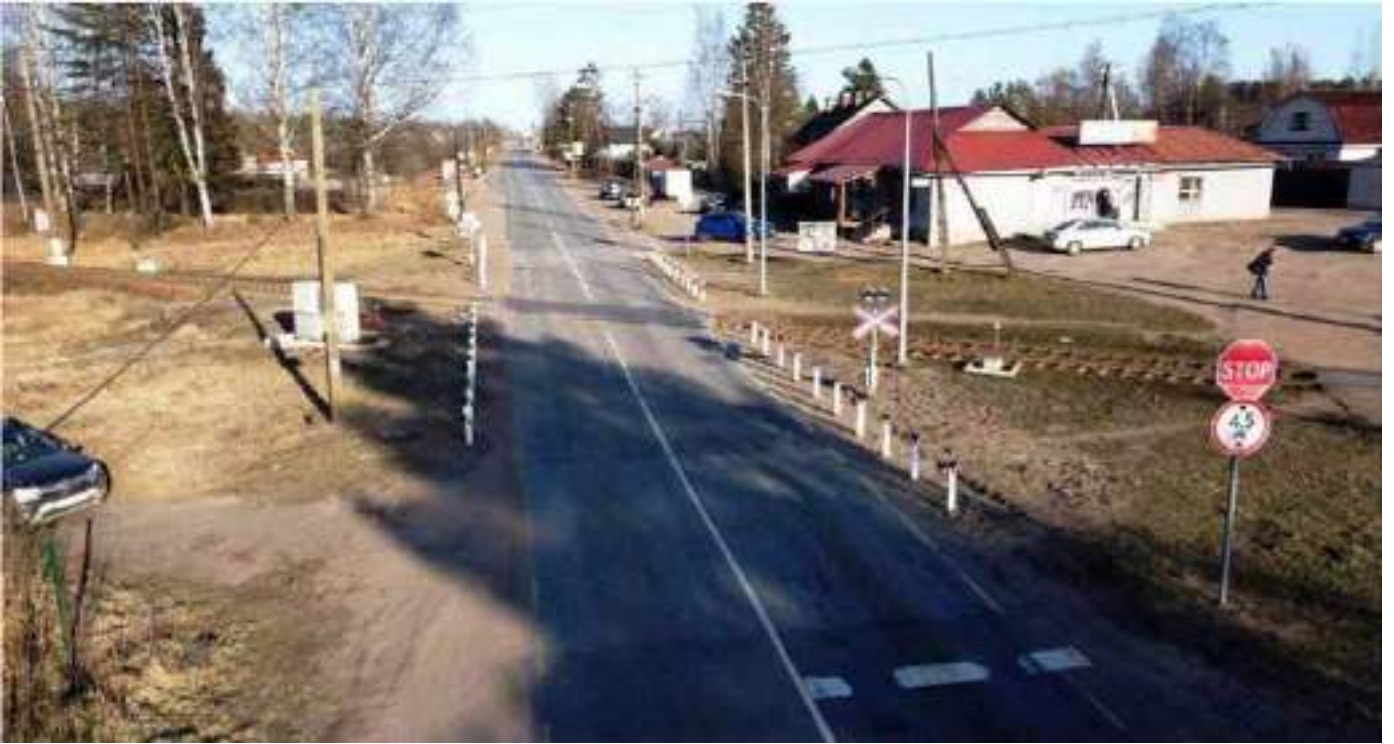
54. Деревня Ириновка. Пересечение трассы железнодорожной линии «Дорога жизни» и автомобильной дороги Ленинградское шоссе («Дорога жизни»).
