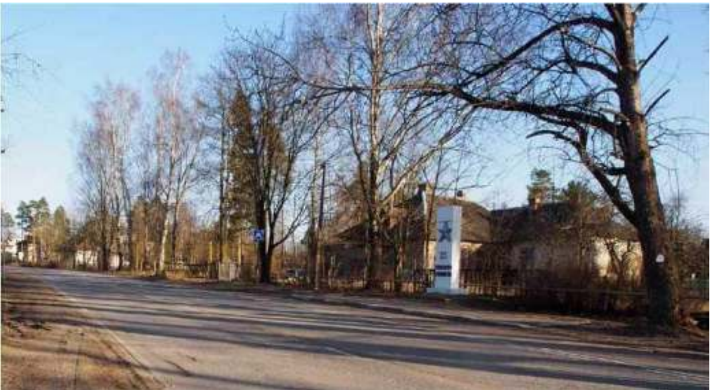
51. Застройка поселка вдоль Ленинградского шоссе («Дорога жизни»). Вид с северо-запада.
