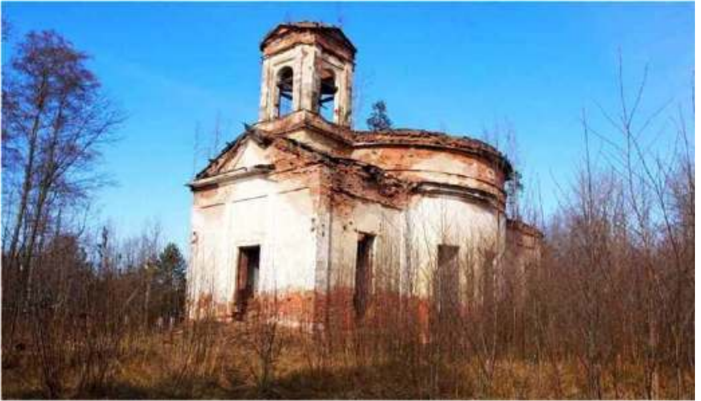
75. Никольская церковь в погосте Верола. Вид с юго-запада.
