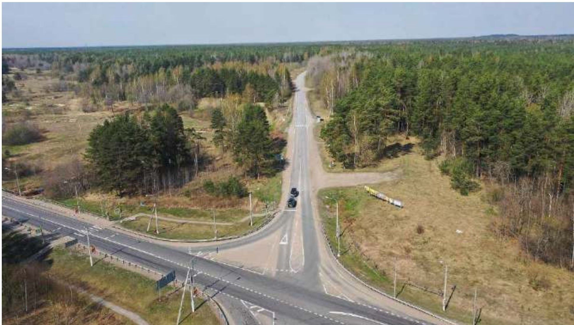
2.4. Автомобильная дорога Лаврово – Шум – Ратница (41К-122). Участок дороги на пересечении с Мурманским шоссе.
