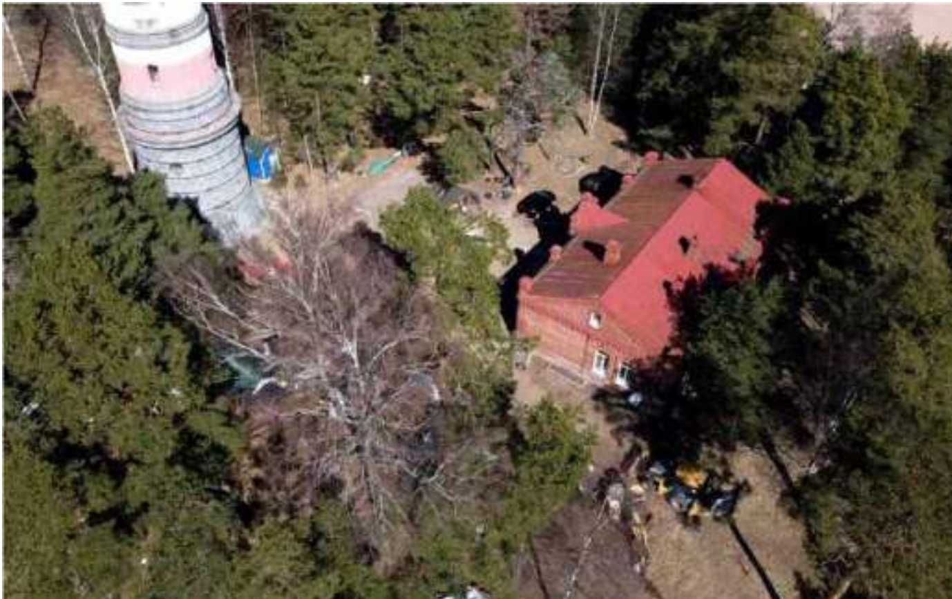
103. Поселок ст. Ладожское озеро. Объект культурного наследия регионального значения «Ансамбль Осиновецкого маяка на Дороге жизни». Вид с юго-запада.
