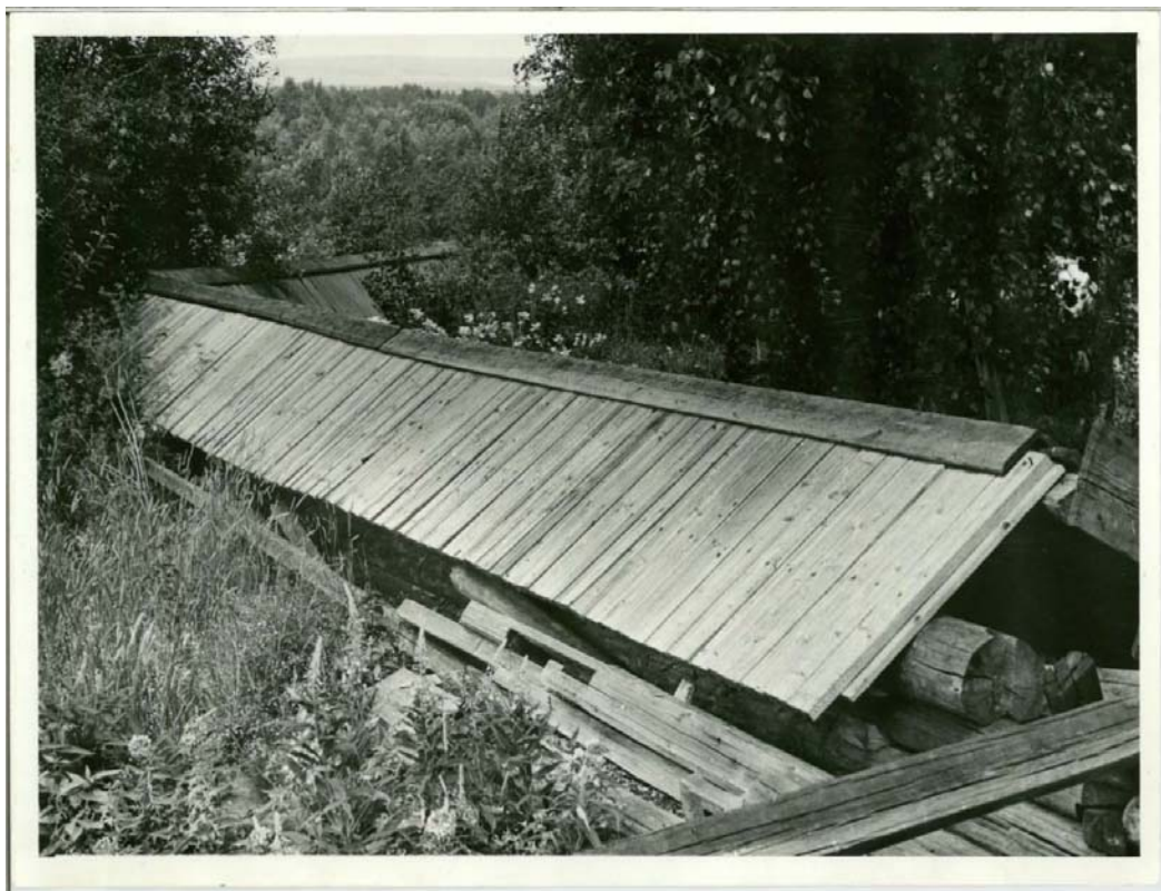
Илл. 20. Процесс проведения реставрационных работ 70–80е годы XX века. Ограда. Кореньков В.1981г. [10].
