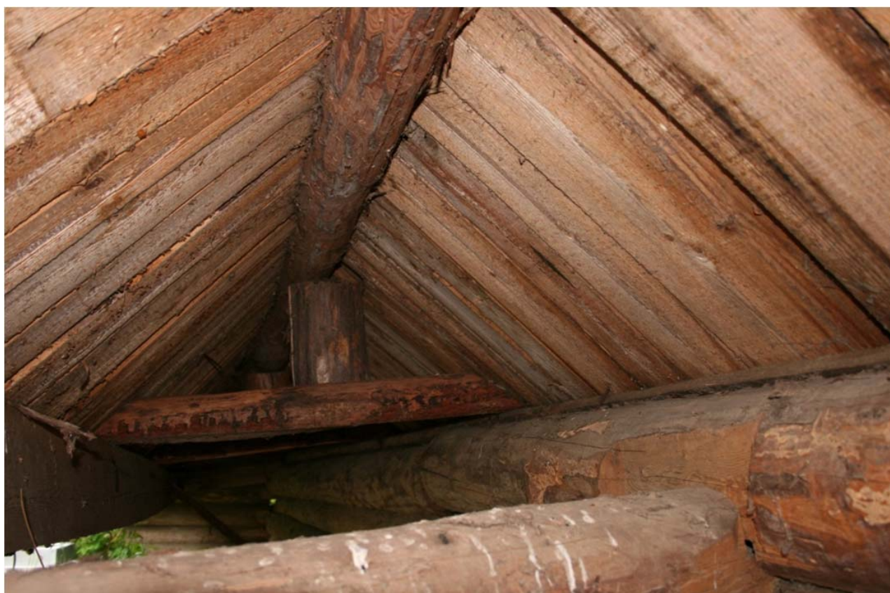
Илл. 65. Церковь Рождества Богородицы (деревянная). Тесовое покрытие ограды. Фотофиксация. 30.08.2018. [1].
