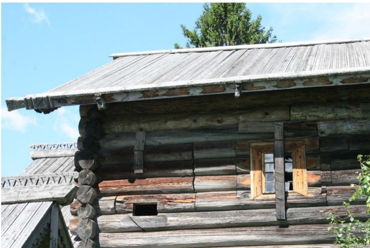
Илл. 39. Церковь Рождества Богородицы (деревянная). Южный фасад. Фотофиксация. 30.08.2018. [1].
