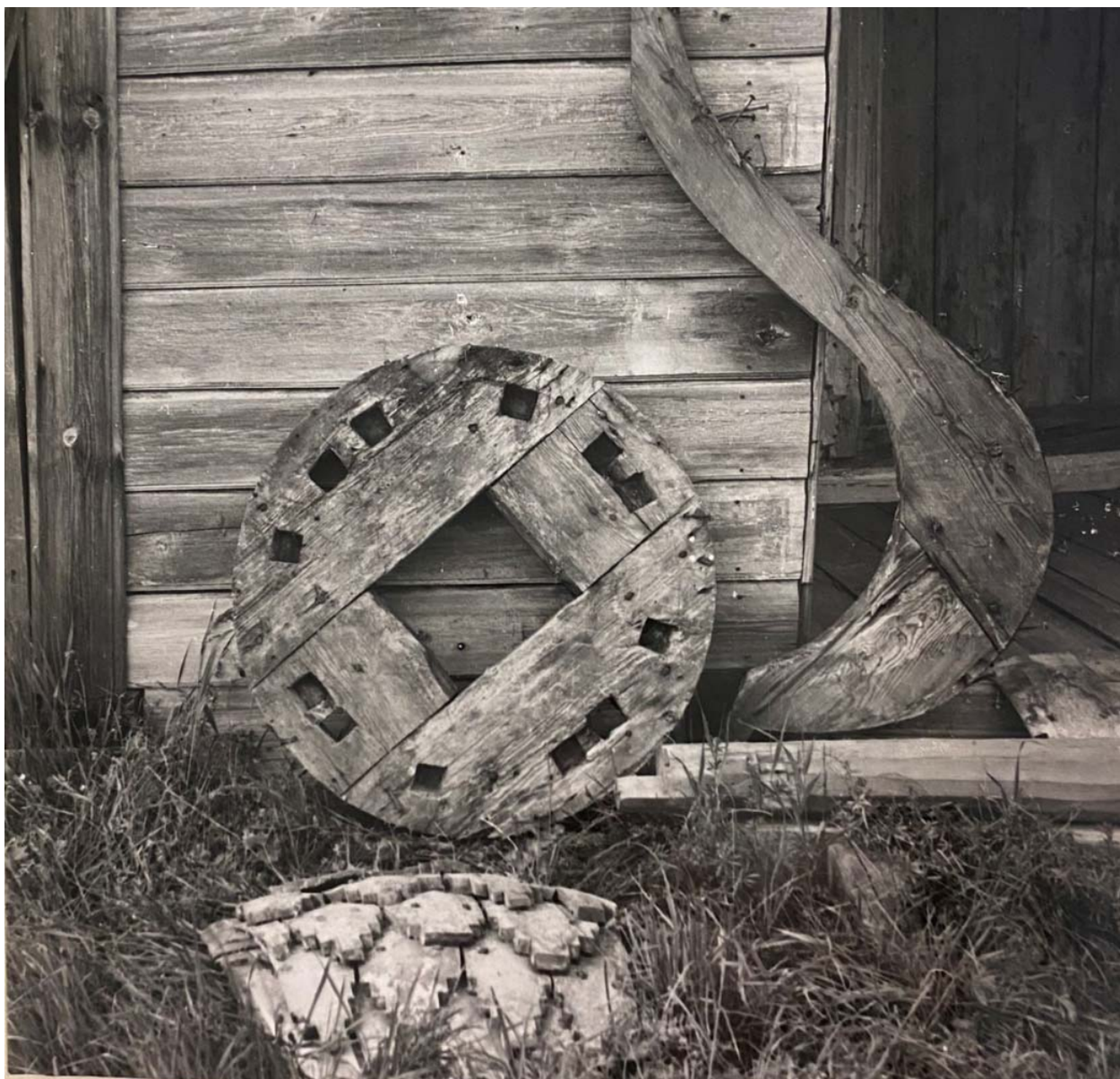
Илл. 18. Кружало, журавец, стойка шейки, фрагмент обрешетки с лемехом главки алтаря [10].
