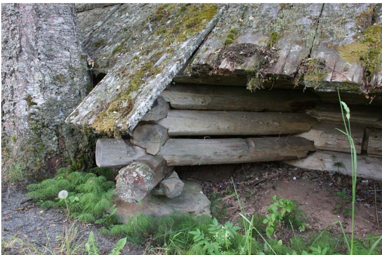
Илл. 63. Церковь Рождества Богородицы (деревянная). Фундамент ограждения. Фотофиксация. 30.08.2018. [1].
