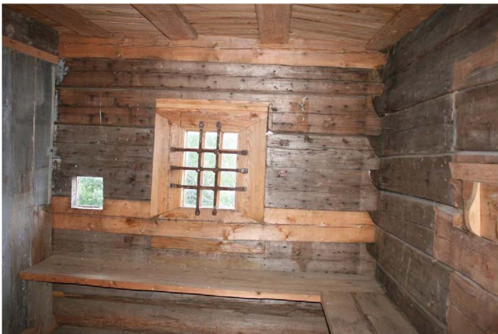
Илл. 52. Церковь Рождества Богородицы (деревянная). Помещение алтарного прируба. Фотофиксация. 30.08.2018. [1].
