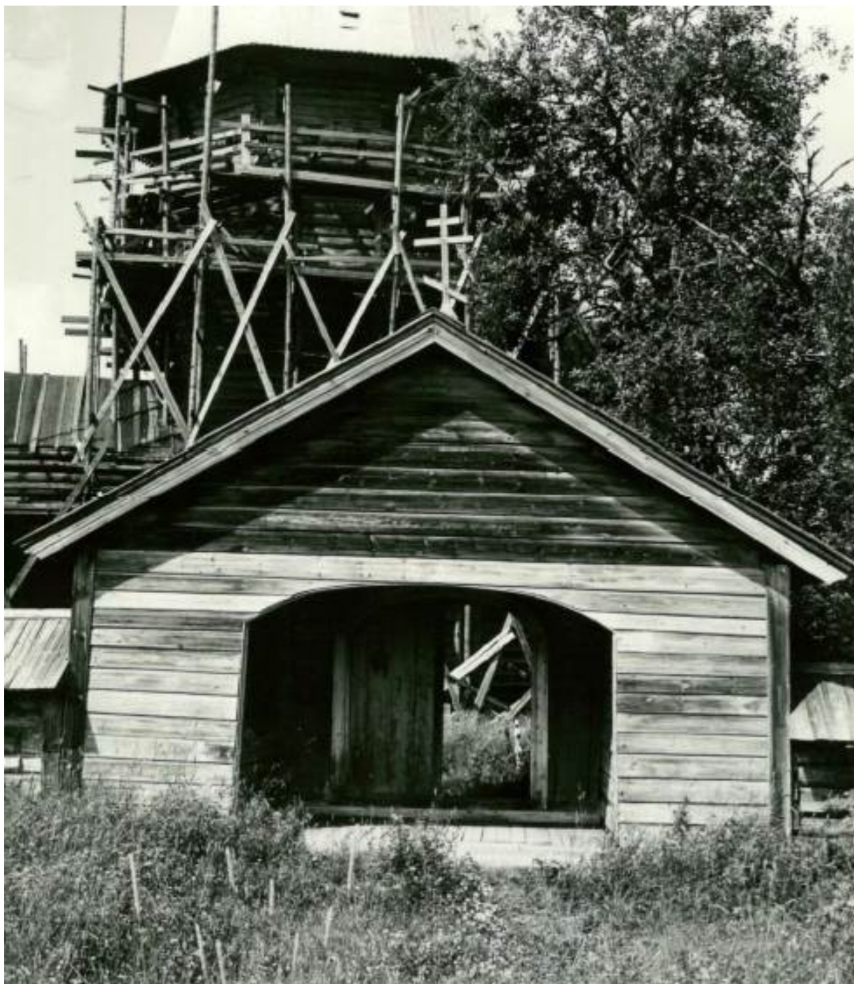
Илл. 19. Процесс проведения реставрационных работ 70-80е годы XX века. Ворота. Кореньков В. 1981г. [10].
