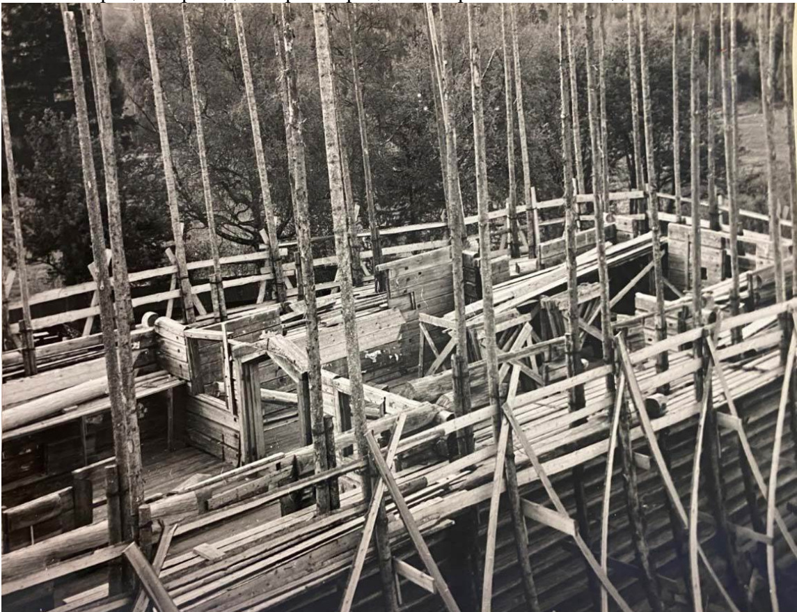
Илл. 14. В процессе реставрационных работ церковь была полностью разобрана и возведена вновь. Фрагмент фотофиксации Ленинградского филиала проектного института по реставрации памятников истории и культуры «Спецпроектреставрация» Том 2 «фотофиксация» Часть 2 «В процессе производства работ» и часть 3 «После завершения реставрационных работ» 1984г. Папка 120-45.
