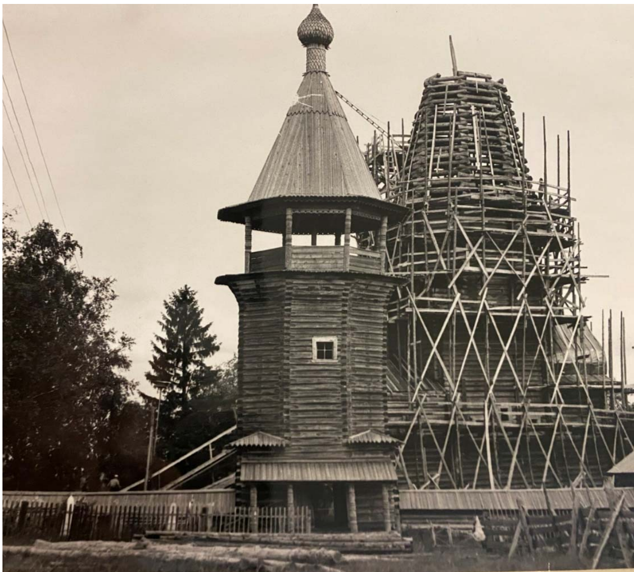
Илл. 15. Сборка ряжевого шатра. Колокольня также была полностью разобрана и возведена вновь. [10].
