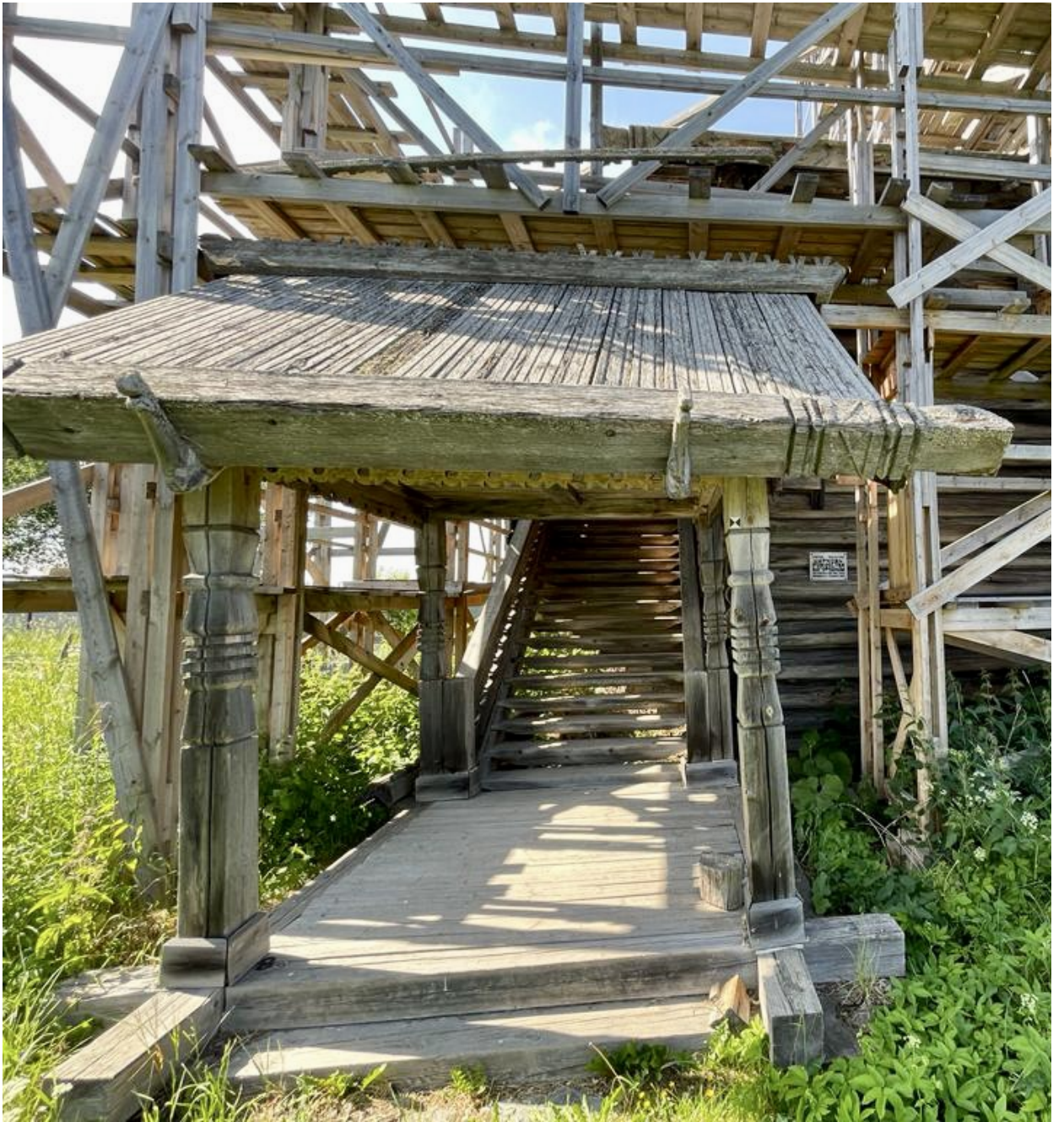
23. Церковь Рождества Богородицы (деревянная). Крыльцо церкви. Штиглиц М.С. 19.07.2023.
