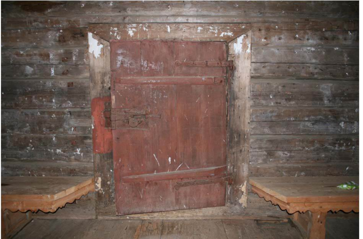
Илл. 42. Церковь Рождества Богородицы (деревянная). Внутренняя входная дверь. Фотофиксация. 30.08.2018. [1].
