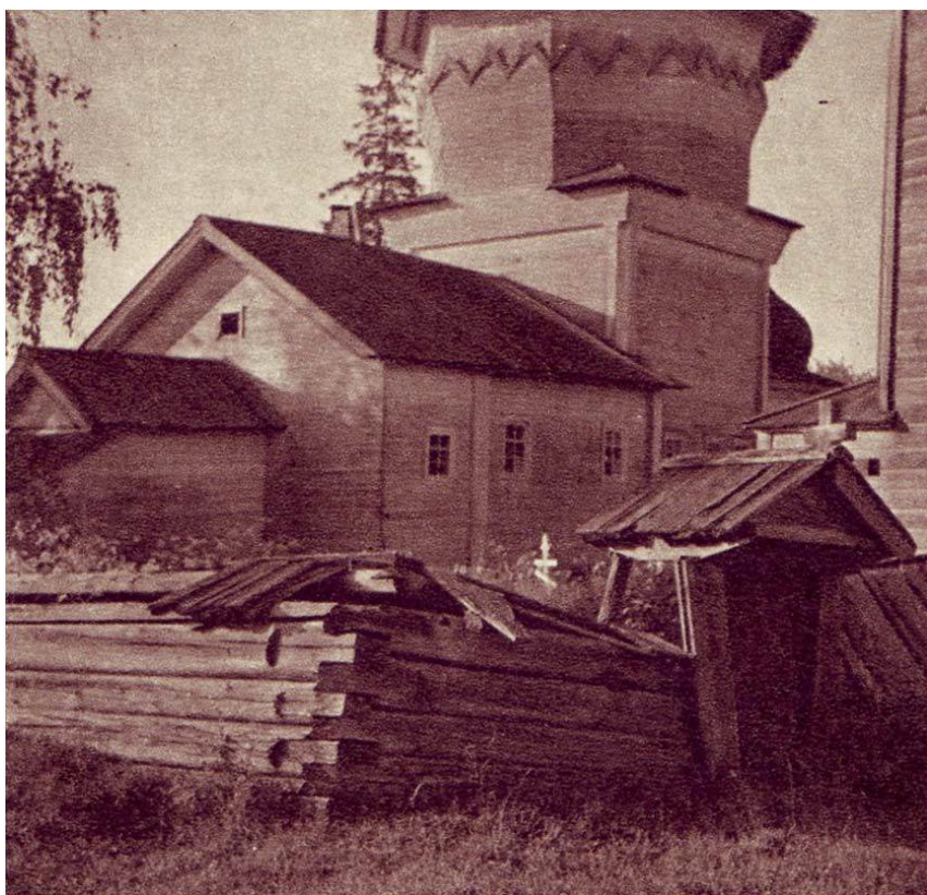
Илл. 11-12. Частные фотографии, датируемые второй половиной XX века до проведения реставрационных работ.
