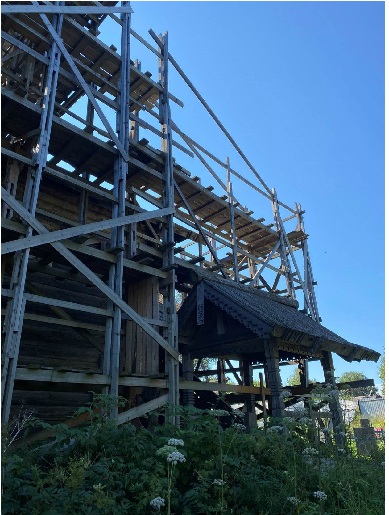
14. Церковь Рождества Богородицы (деревянная). Церковь. Фрагмент фасада в лесах. Штиглиц М.С. 19.07.2023
