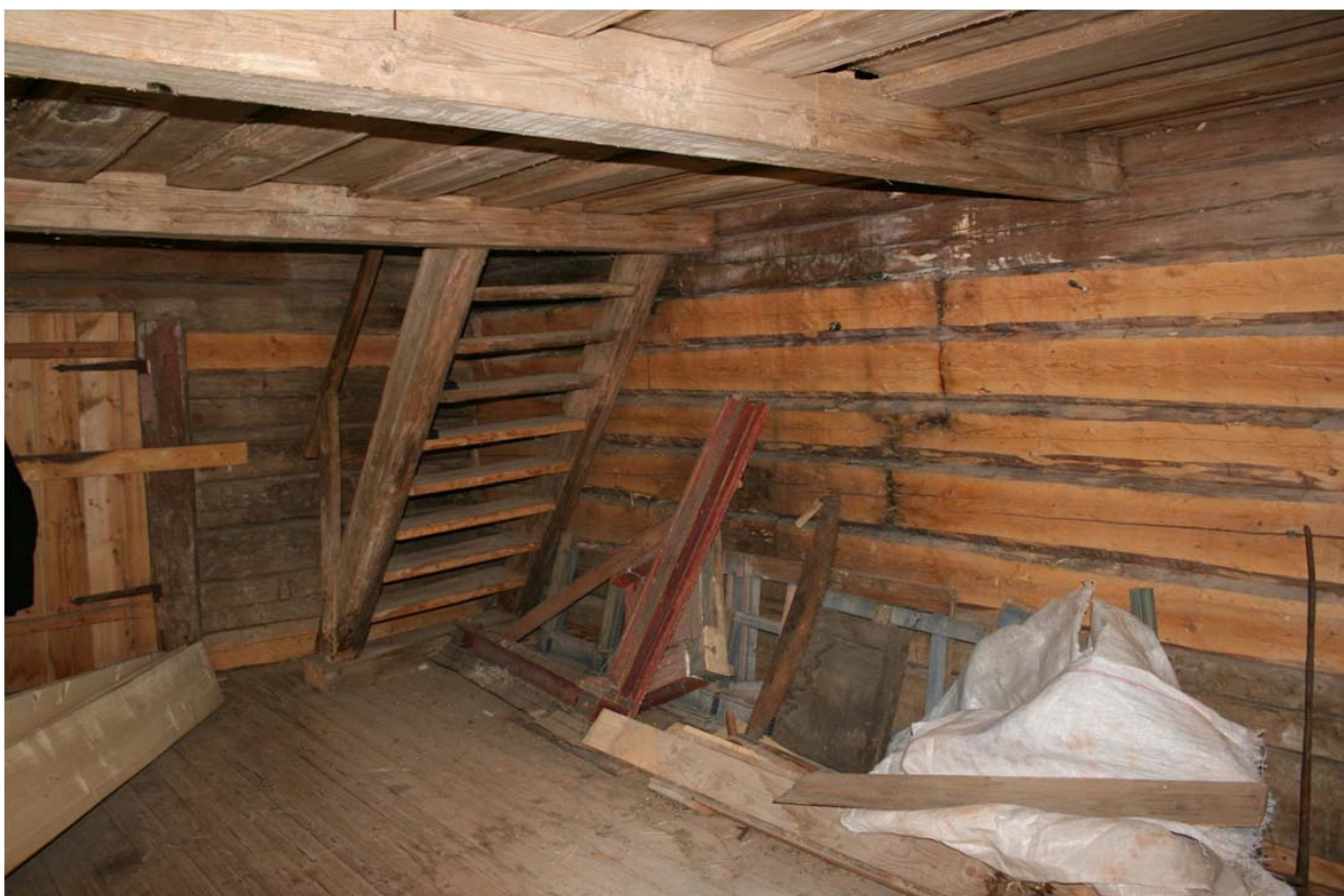
Илл. 57. Церковь Рождества Богородицы (деревянная). Помещение нижней части колокольни – четверик. Фотофиксация. 30.08.2018. [1].
