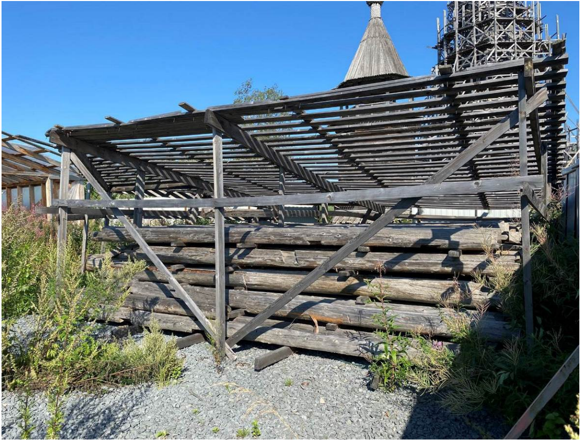
86. Церковь Рождества Богородицы (деревянная). Деревянные элементы ограды. Штиглиц М.С. 19.07.2023.
