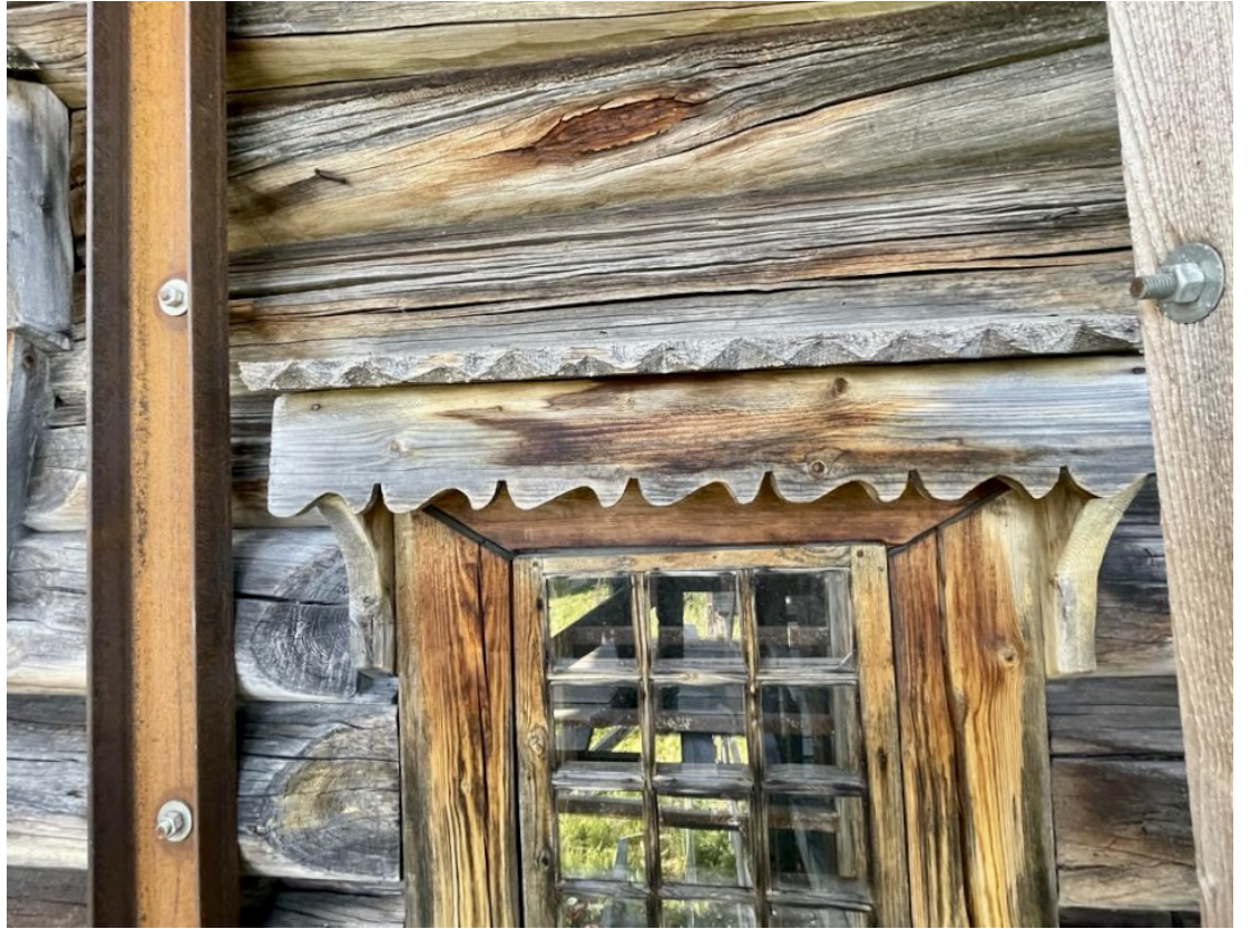
20. Церковь Рождества Богородицы (деревянная). Церковь. Косяк окна и наличник. Штиглиц М.С. 19.07.2023.
