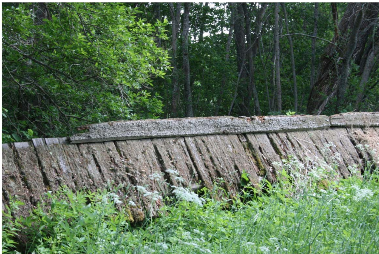
Илл. 66. Церковь Рождества Богородицы (деревянная). Тесовое покрытие ограды. Фотофиксация 30.08.2018. [1].
