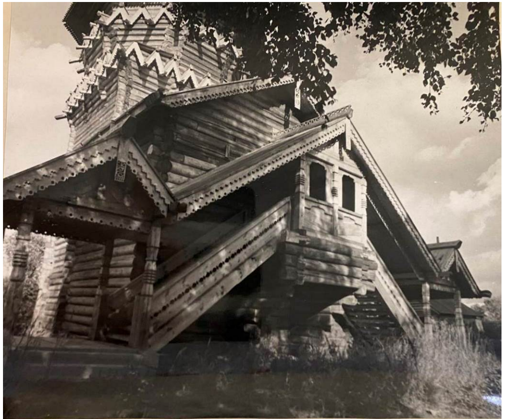
Илл. 24. Вид на западный фасад церкви с восстановленным по историческим следам крыльцом. [10].
