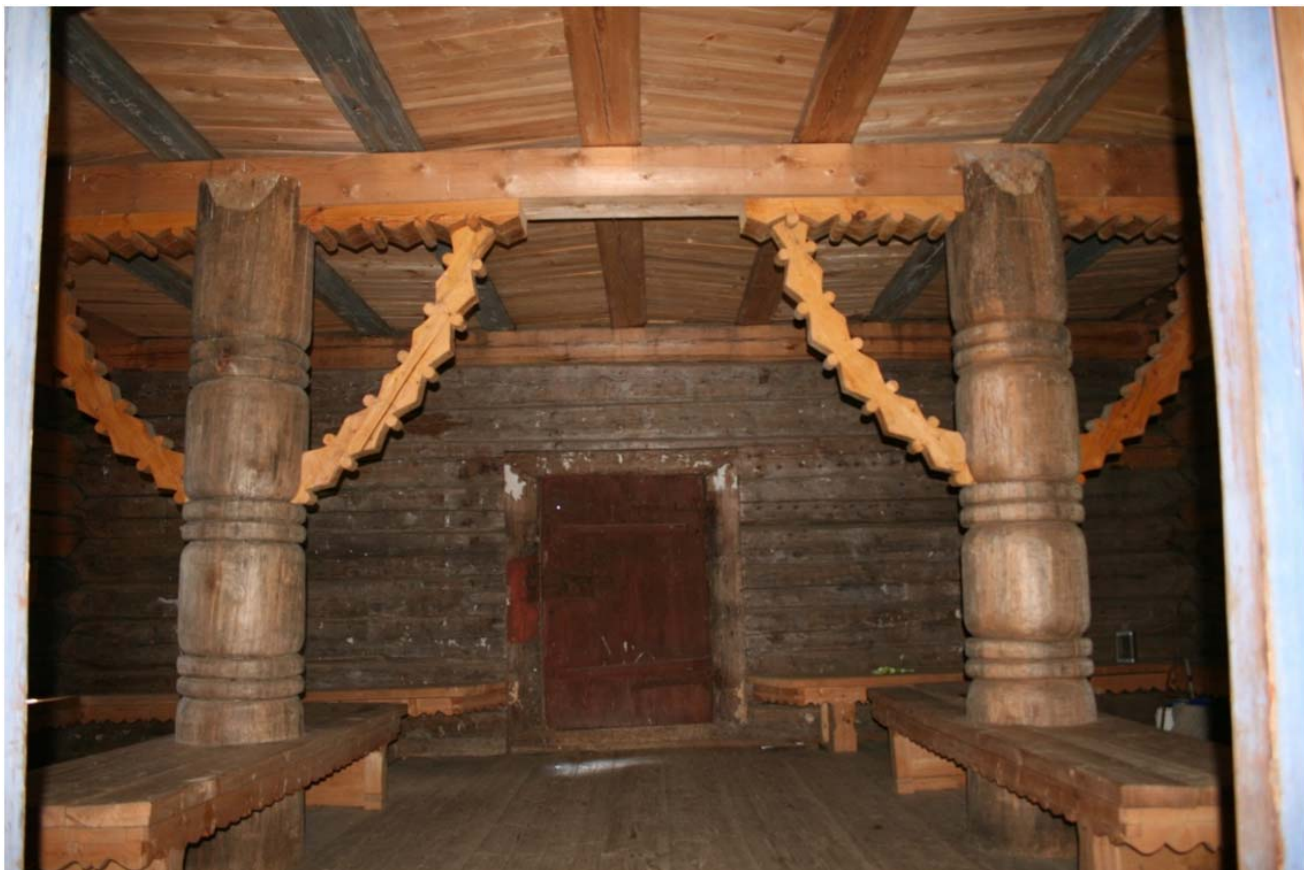
Илл. 44. Церковь Рождества Богородицы (деревянная). Помещение трапезной. Входная дверь. Фотофиксация. 30.08.2018. [1].
