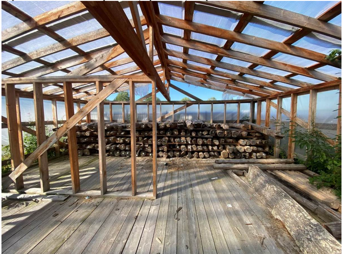
70. Церковь Рождества Богородицы (деревянная). Деревянные элементы ограды. Штиглиц М.С. 19.07.2023.
