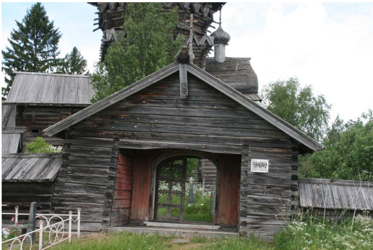
Илл. 30. Церковь Рождества Богородицы (деревянная). Вход на погост (вид снаружи). Фотофиксация. 30.08.2018. [1].
