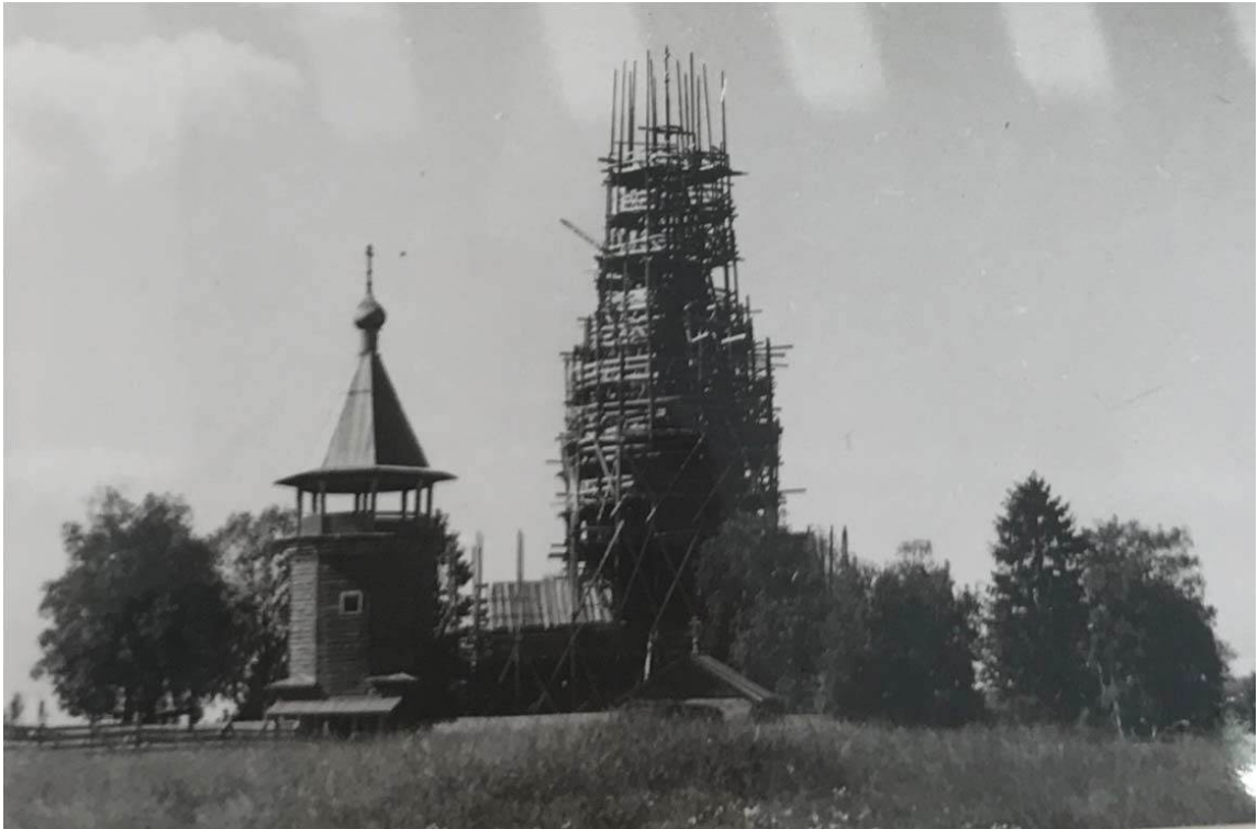
Илл. 13. Процесс проведения реставрационных работ 70-80-е годы XX века.
