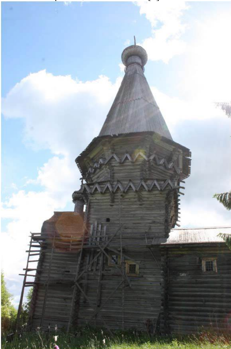
Илл. 35. Церковь Рождества Богородицы (деревянная). Северный фасад. Фотофиксация. 30.08.2018. [1].
