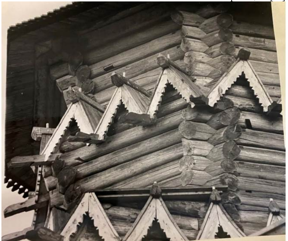
Илл. 25. Юго-восточный угол восьмерика. Оба декоративных фронтовых пояса были полностью восстановлены. [10].
