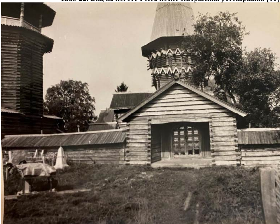
Илл. 23. Фрагмент ограды погоста и рубленные ворота после завершения реставрации. [10].
